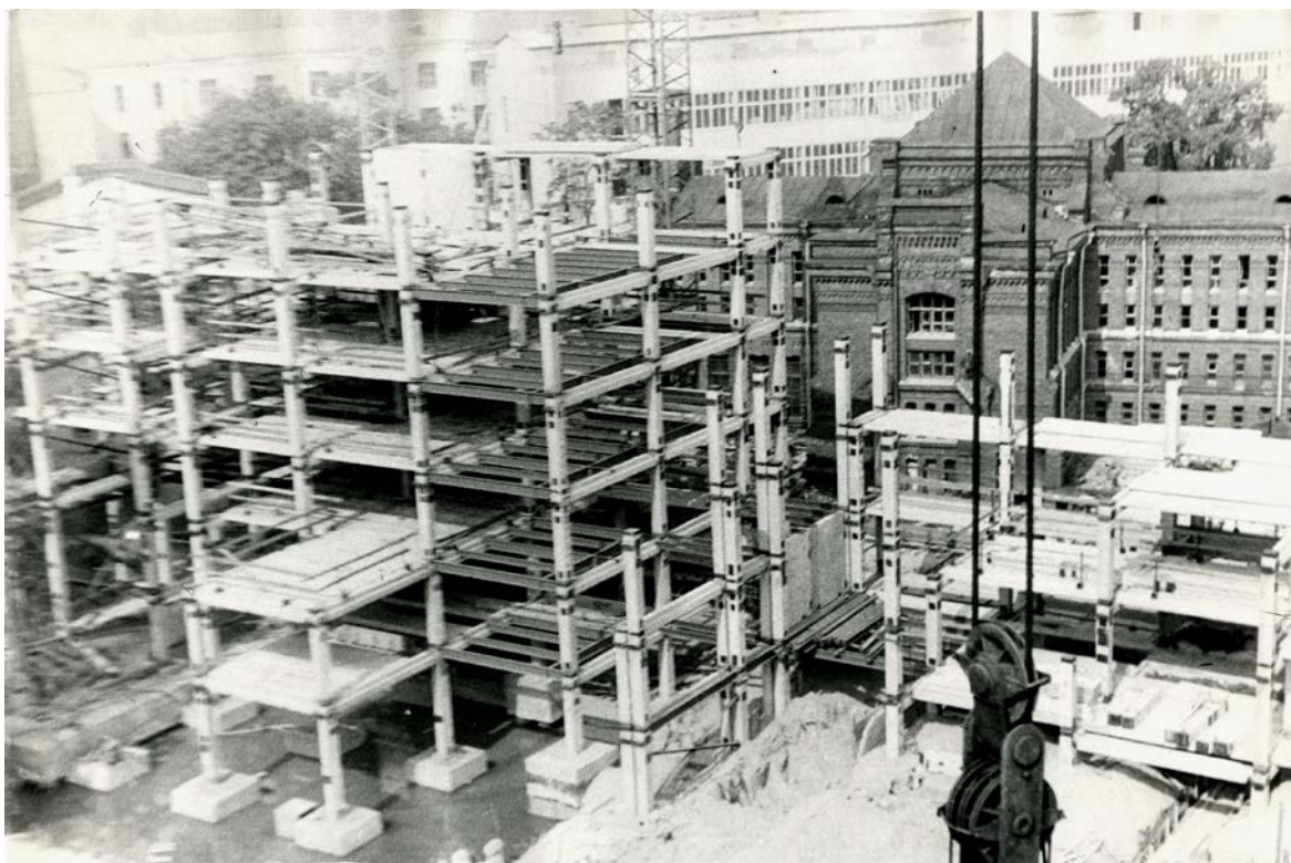
17. Строительство 5-го корпуса ЛЭТИ. 1971 - 1974 г. г. — «PastVu» – ретро-фотографии стран и городов [Электронный ресурс]. URL: https://pastvu.com/p/763600 .
