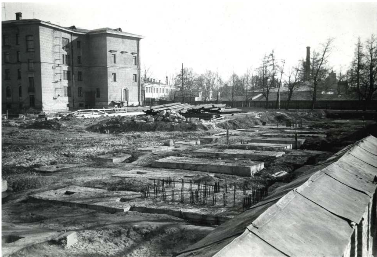
13. Начало строительства 5-го корпуса ЛЭТИ. 1970 г. — «PastVu» – ретро-фотографии стран и городов [Электронный ресурс]. URL: https://pastvu.com/p/764441 .
