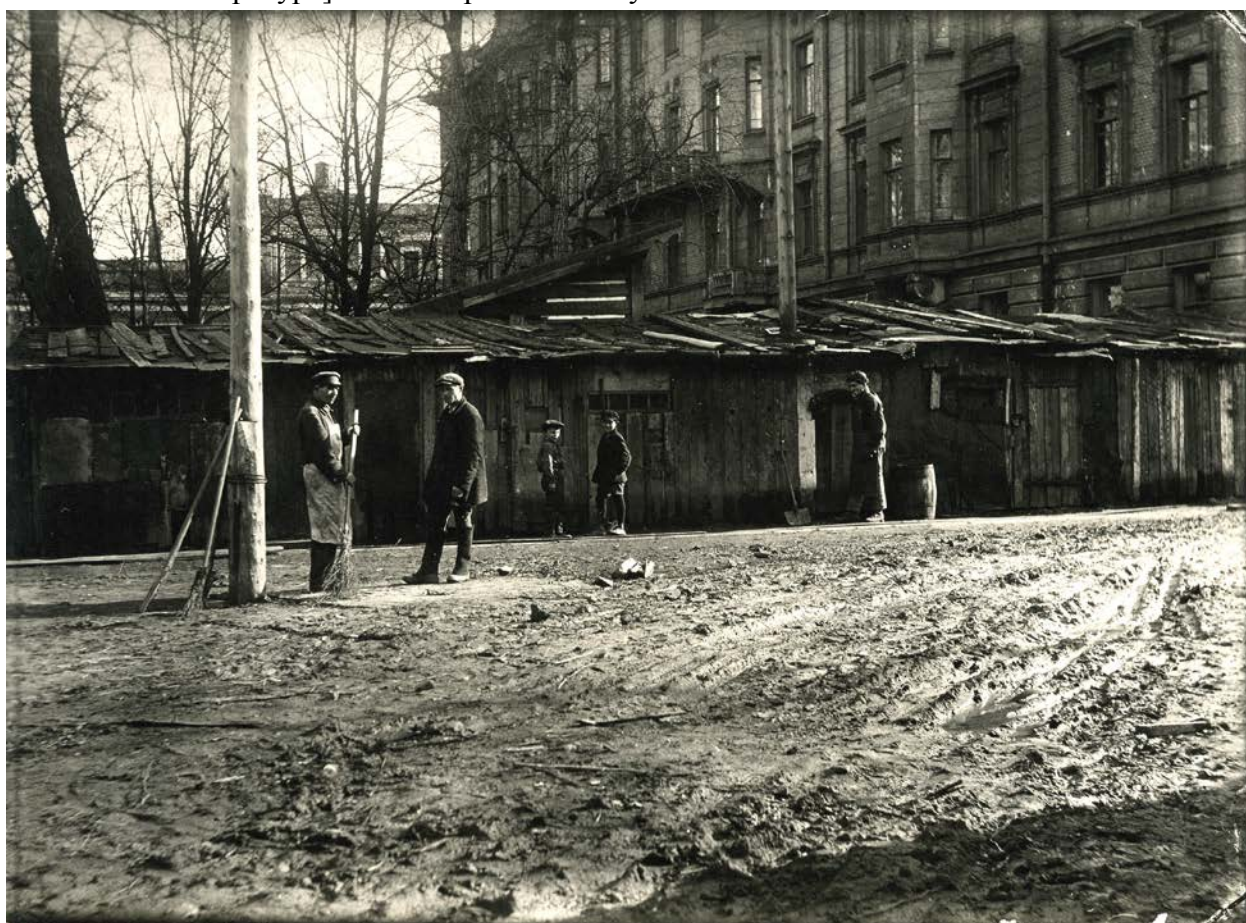
10. Ленинградский электротехнический институт, сараи на территории. 1921 - 1930 г. г. — «PastVu» – ретро-фотографии стран и городов [Электронный ресурс]. URL: https://pastvu.com/p/764001 .
