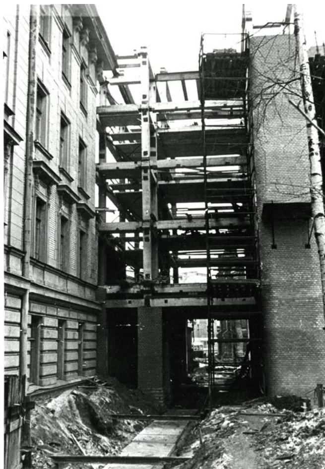
15. Строительство 5-го корпуса ЛЭТИ. 1971 - 1974 г. г. — «PastVu» – ретро-фотографии стран и городов [Электронный ресурс]. URL: https://pastvu.com/p/764504 .
