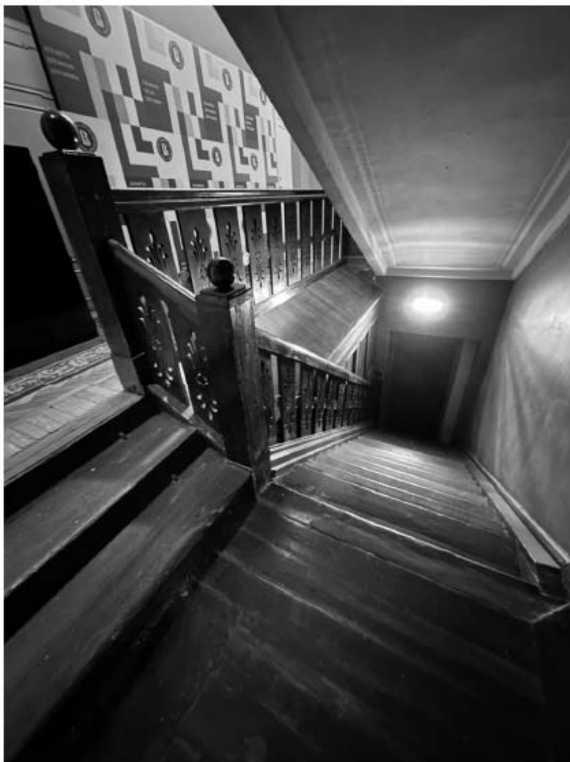
59. "Особняк" входящий в состав ОКН «Особняк Кочубея В.П.». Санкт-Петербург, г. Пушкин, ул. Радищева, дом 4, лит. А. 1-й этаж. Фрагмент интерьера. Фото:28.11.2024.
