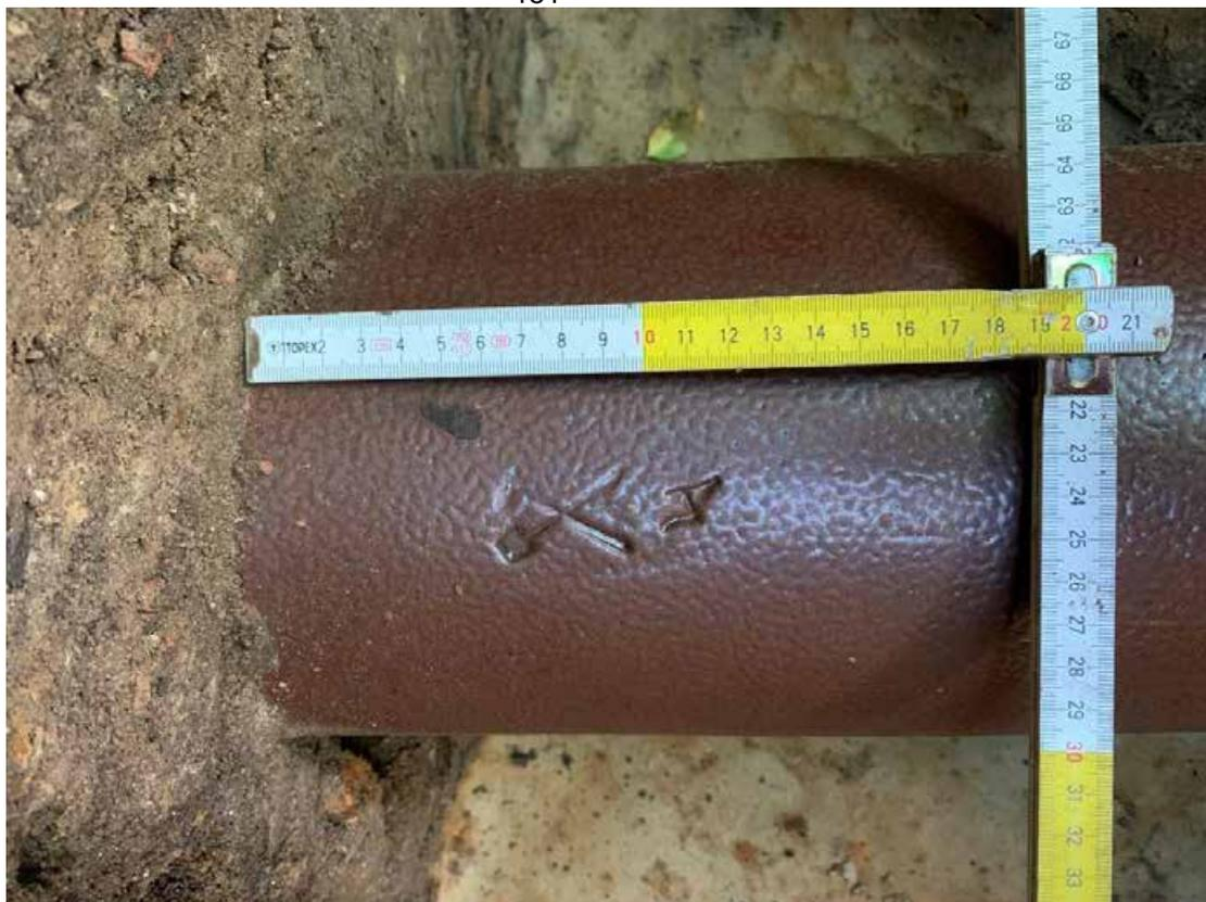
Рис. 117. Санкт-Петербург, Центральный район, Ул. Ломоносова, д. 9. Шурф 2. Объект 4. Секция трубопровода с клеймом.
