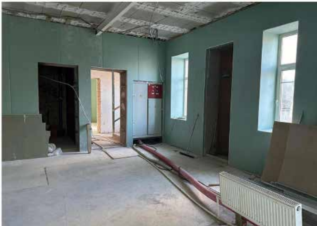
Фото № 5. Общий вид на помещения.
