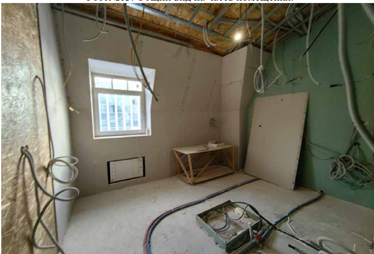
Фото№14. Общий вид на часть помещения.
