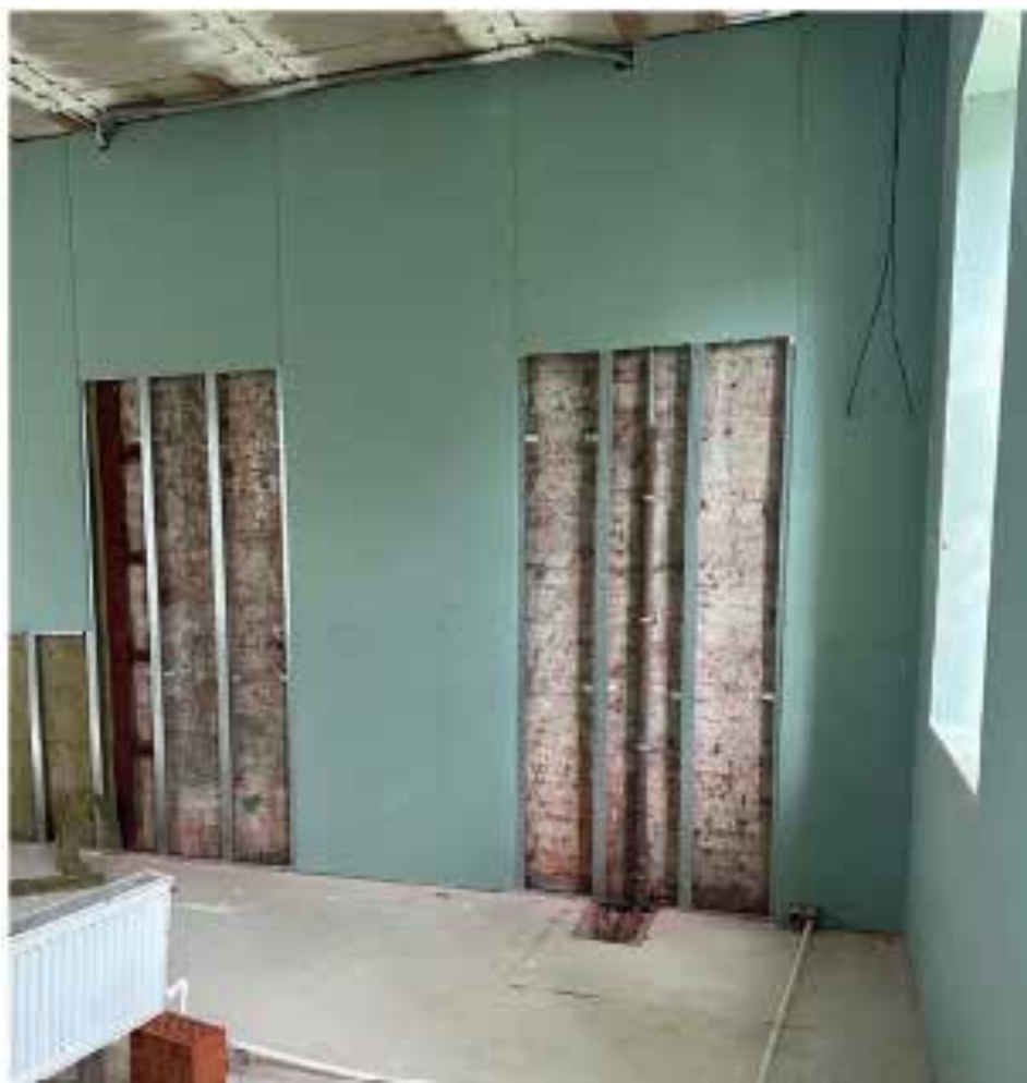
Фото №9. Общий вид на помещения.
