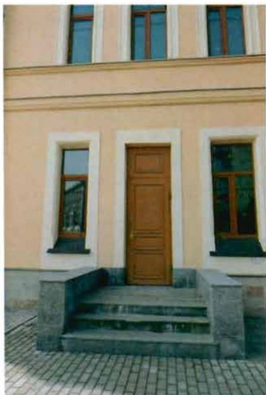
4. Фрагмент северо-восточного фасада.
