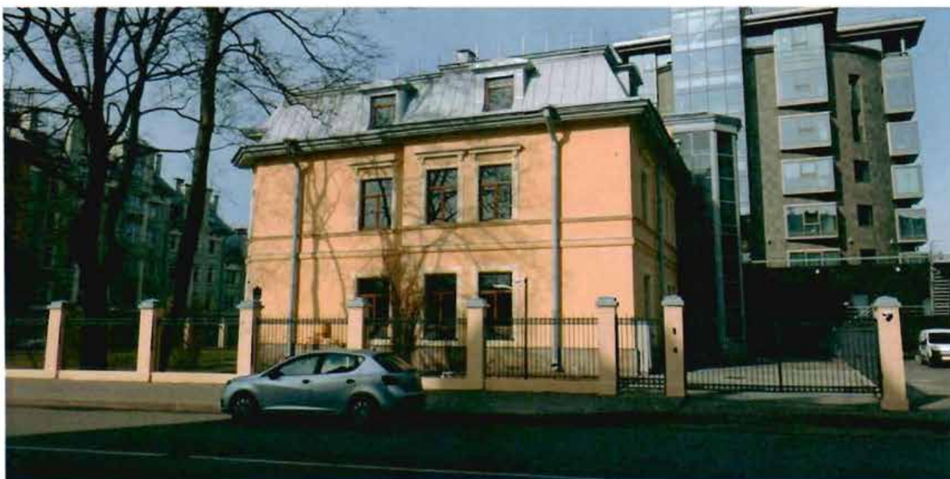
2. «Особняк В.И. Левтеевой». Вид с востока.
