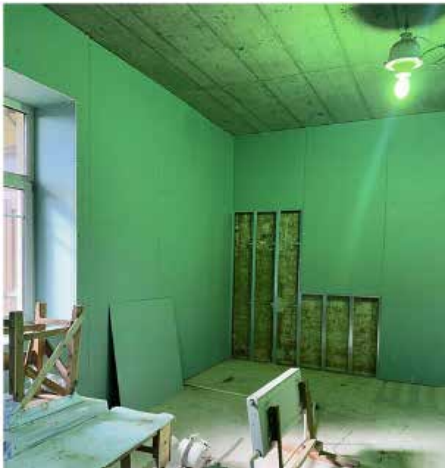
Фото № 7. Общий вид на помещения.
