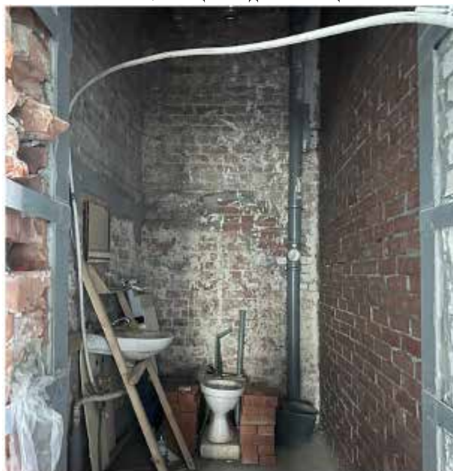
Фото № 8. Общий вид на помещения.
