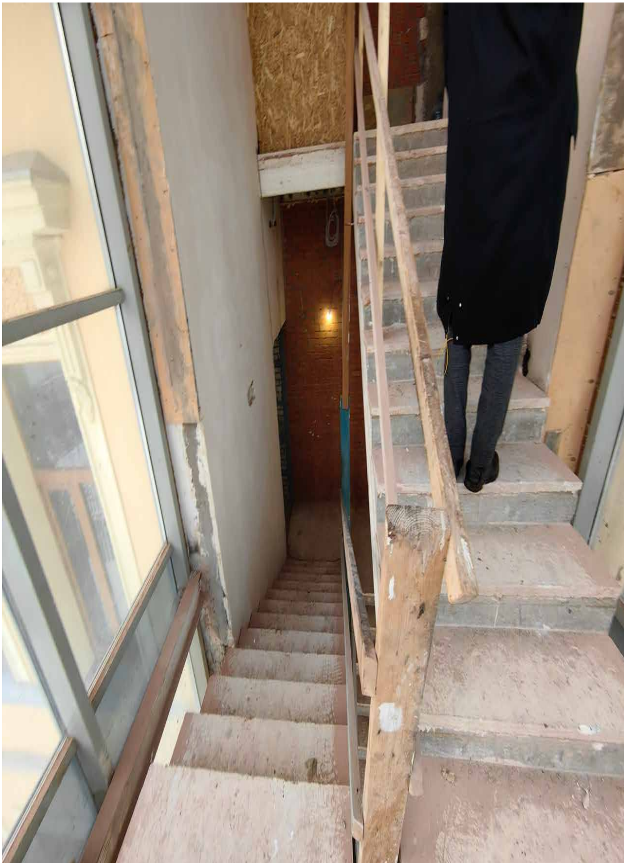
Фото№16. Общий вид на лестницу.
