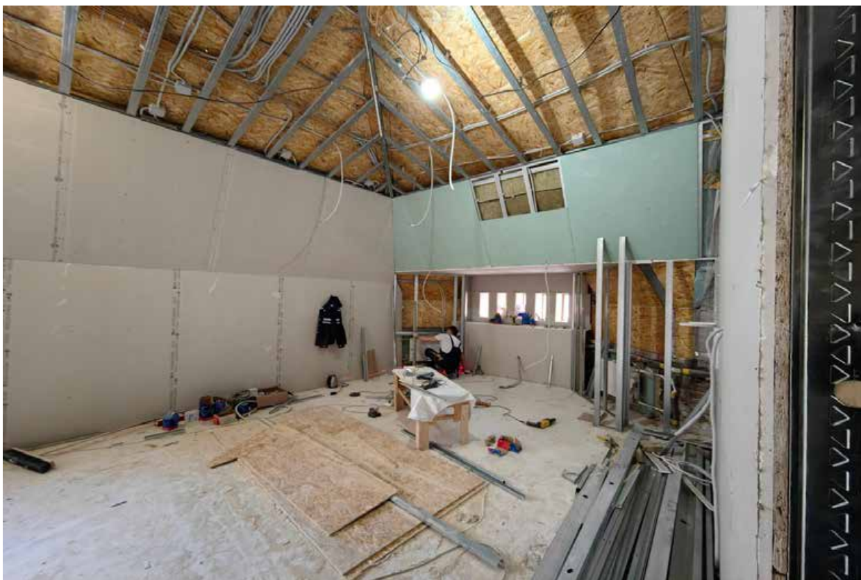
Фото№13. Общий вид на часть помещения.
