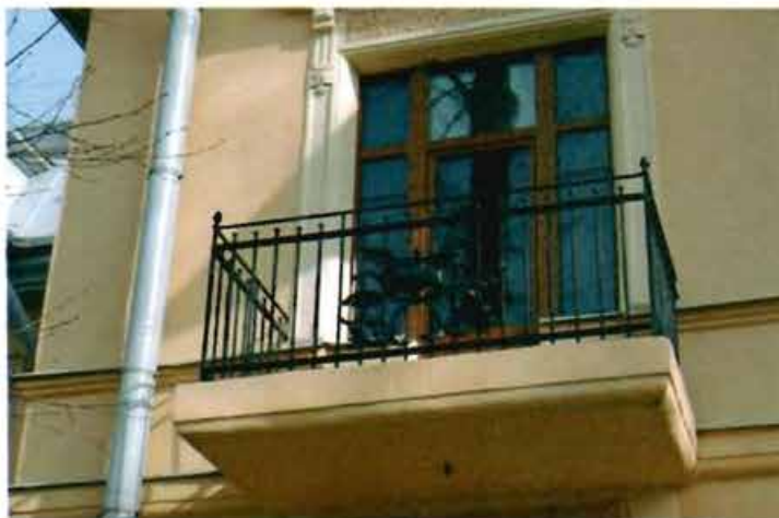
5. Балкон на юго-западном фасаде.
