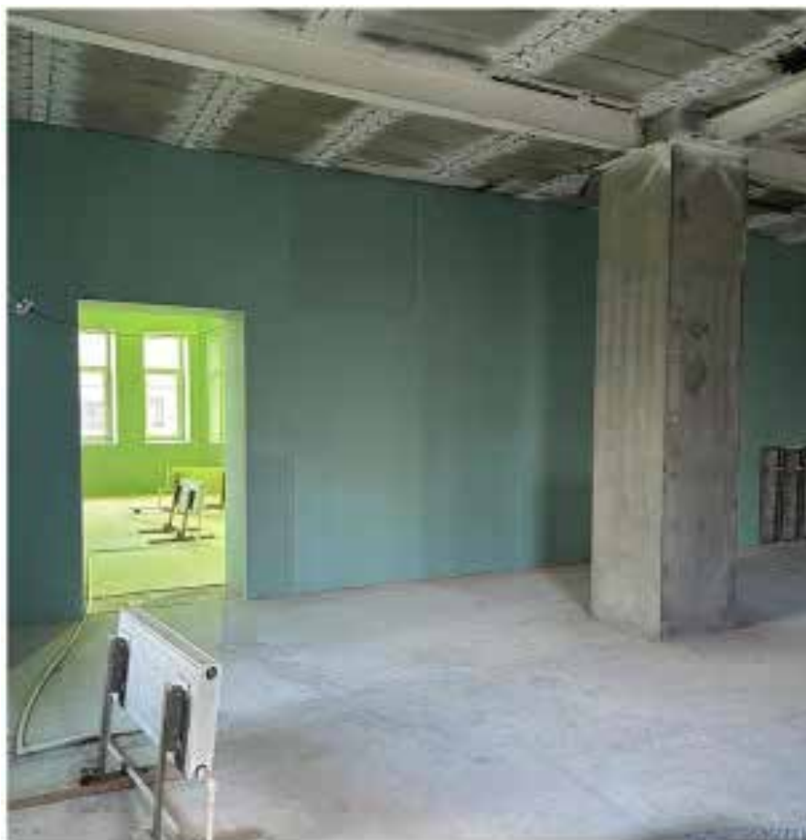
Фото № 6. Общий вид на помещения.
