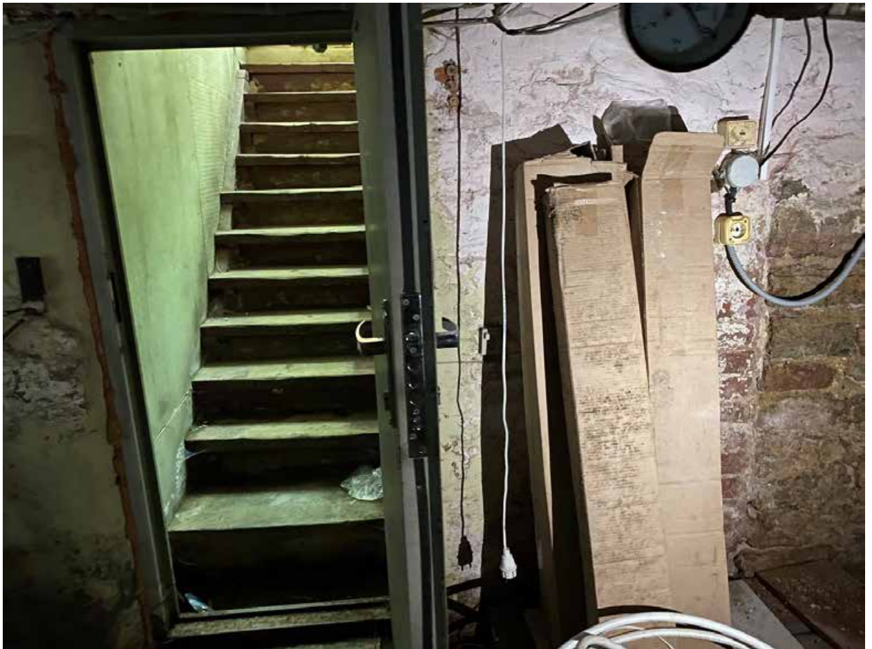
Фото 177. Подвал. Помещение 1-Н(34)
