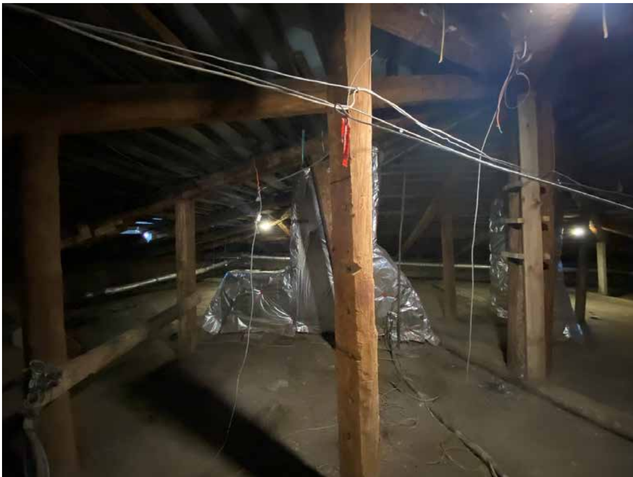
Фото 213. Чердак. Конструкция горизонтальной стропильной подпорки.
