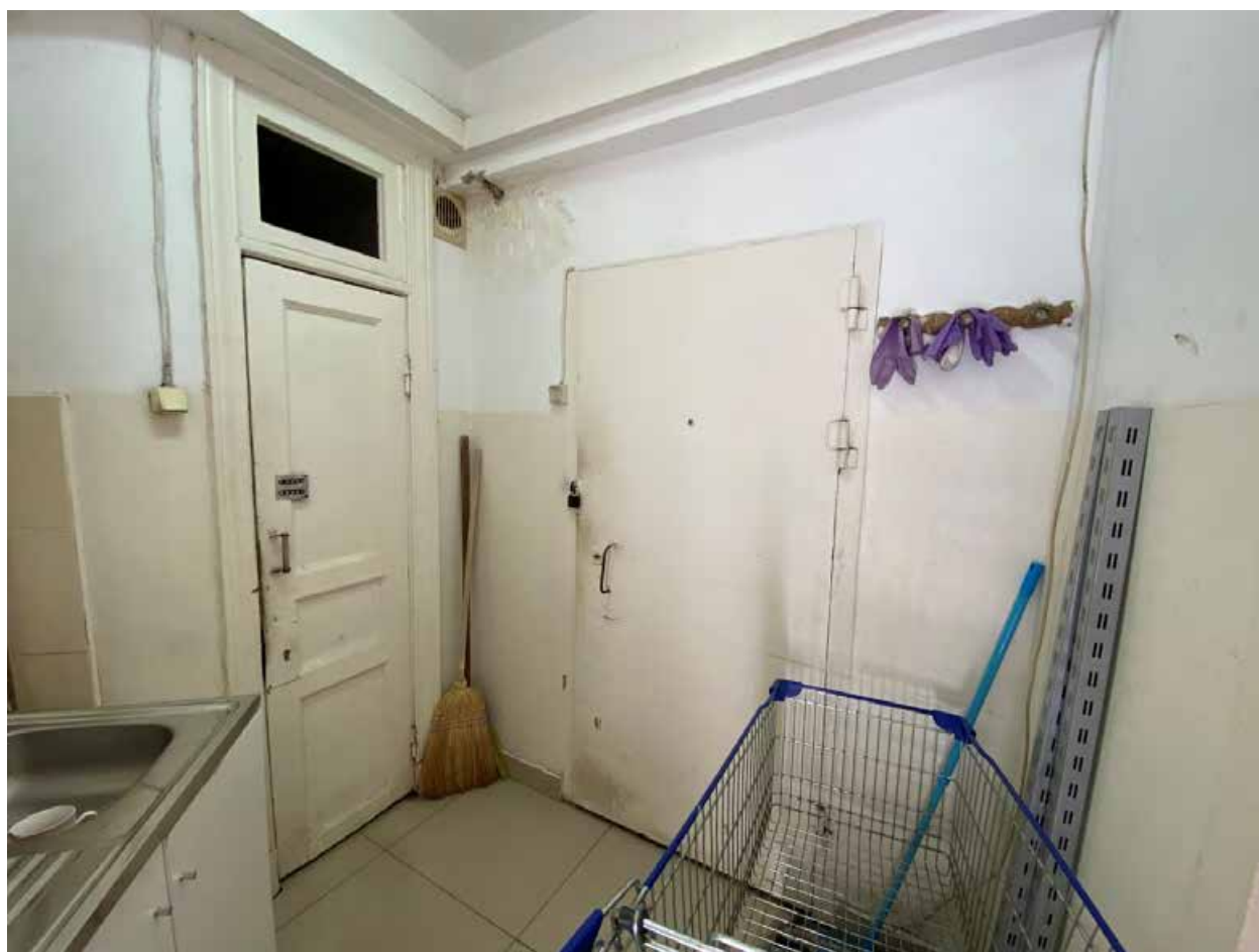
Фото 78. 1этаж. Помещение 1-Н(11)
