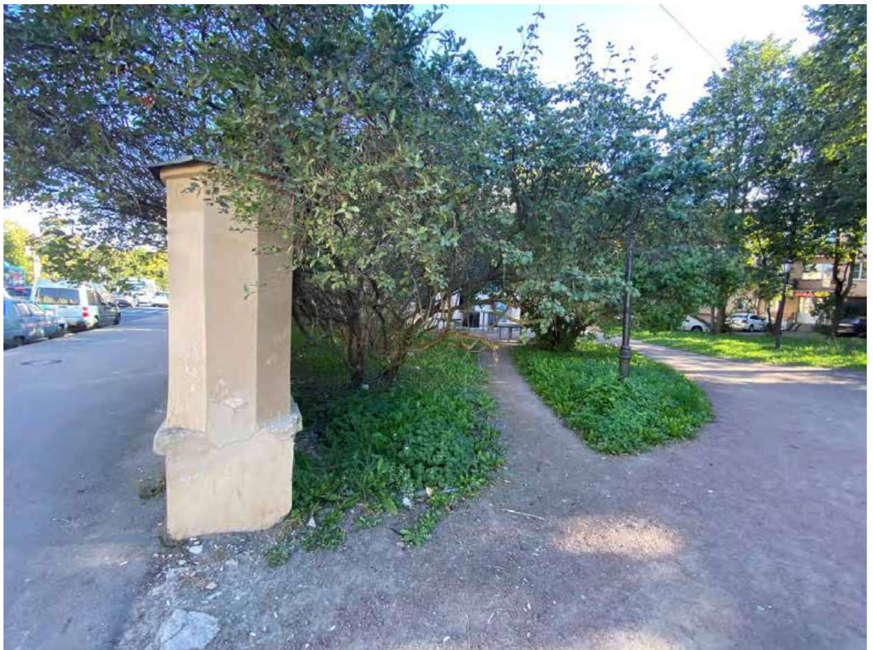
Фото 11. Часть садового ограждения со стороны Оранжерейной улицы
