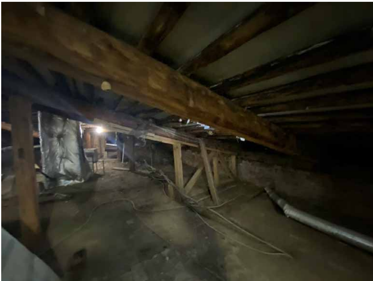
Фото 222. Чердак. Угловая опора чердачного перекрытия.
