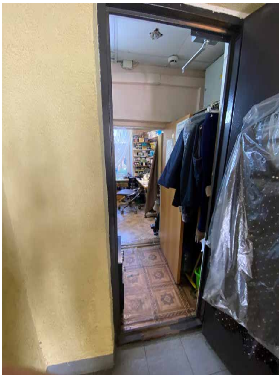
Фото 162. 2 этаж. Помещение 1-Н(33)
