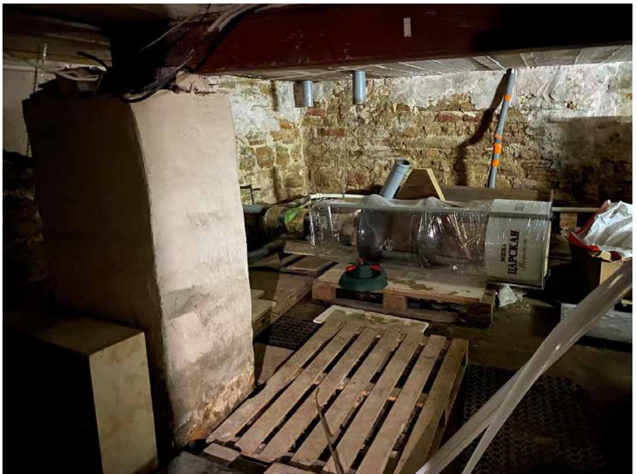
Фото 168. Подвал. Помещение 1-Н(34)
