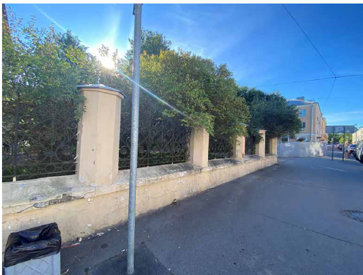
Фото 5. Часть садового ограждения со стороны Оранжерейной улицы
