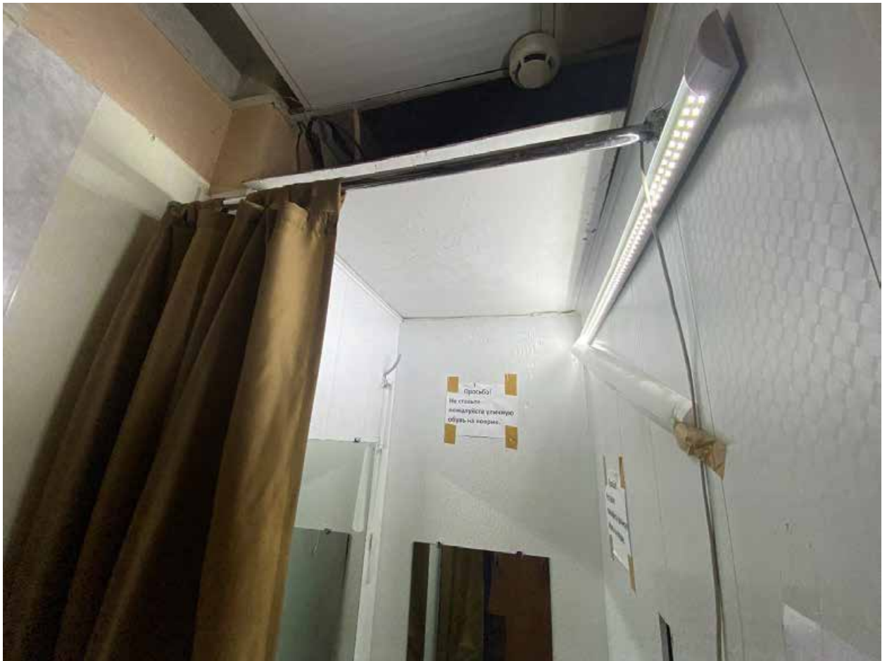
Фото 166. 2 этаж. Помещение 1-Н(33)
