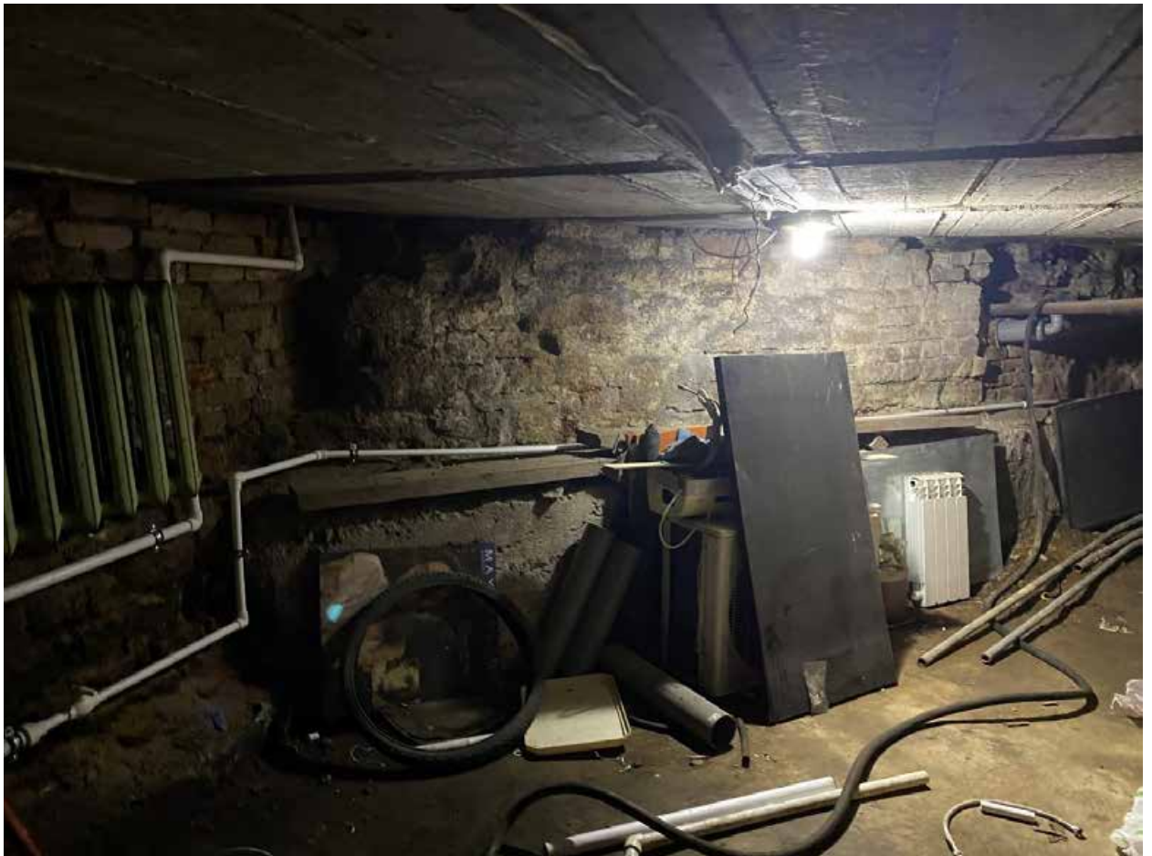
Фото 190. Подвал. Помещение 1-Н(37)
