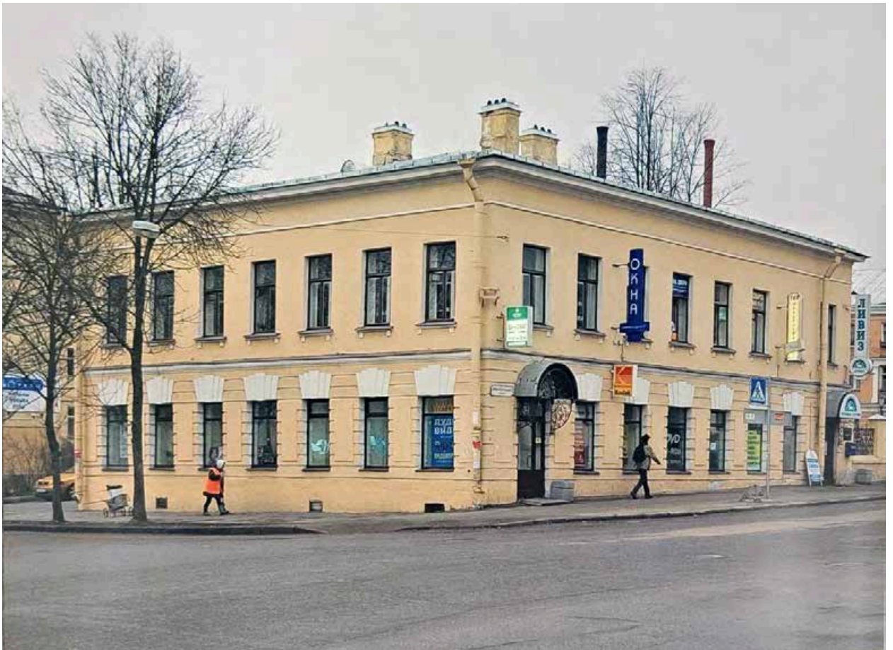
Илл. 27. Дом купца М.В. Васильева. 2009 г. Из кн.: Дворцовый город Царское село. Исторический очерк градостроительного развития (XVIII – начало XX века). СПб., 2009. С. 134.
