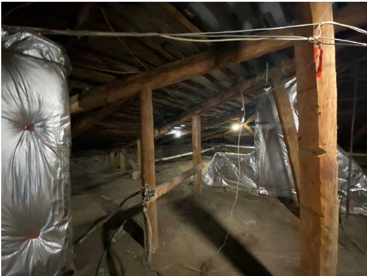
Фото 215. Чердак. Наклонная стропильная конструкция.
