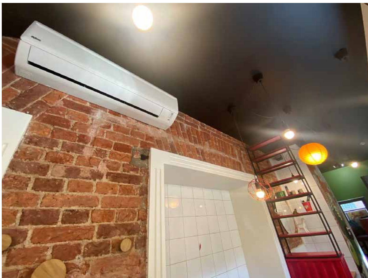
Фото 45. 1этаж. Помещение 1-Н(15).
