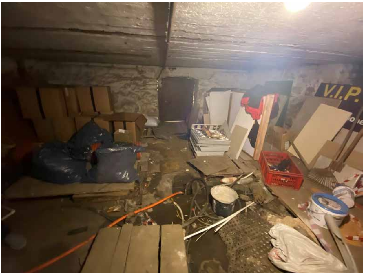
Фото 182. Подвал. Помещение 1-Н(36)
