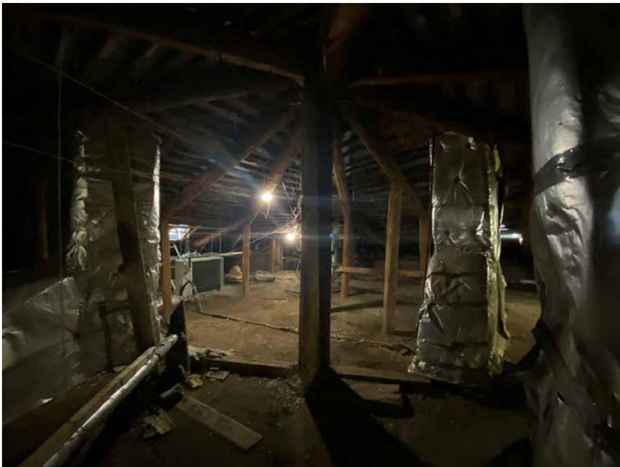
Фото 220. Чердак. Угловая наклонная конструкция деревянных стропил кровли.
