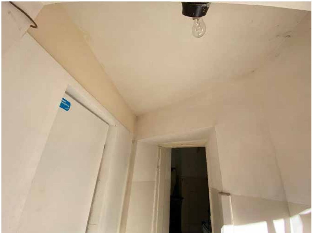
Фото 86. 1этаж. Помещение 1-Н(11)
