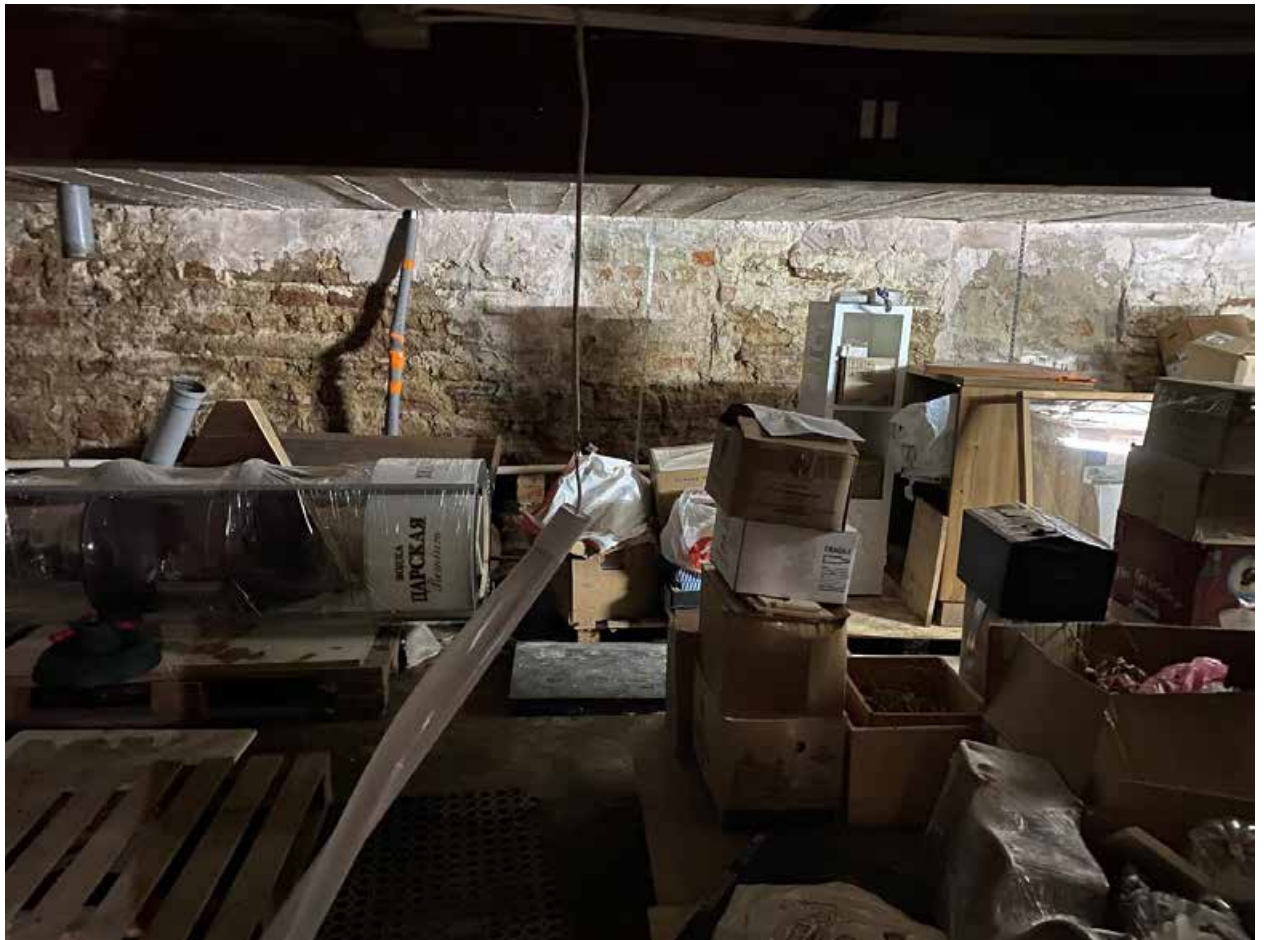
Фото 169. Подвал. Помещение 1-Н(34)
