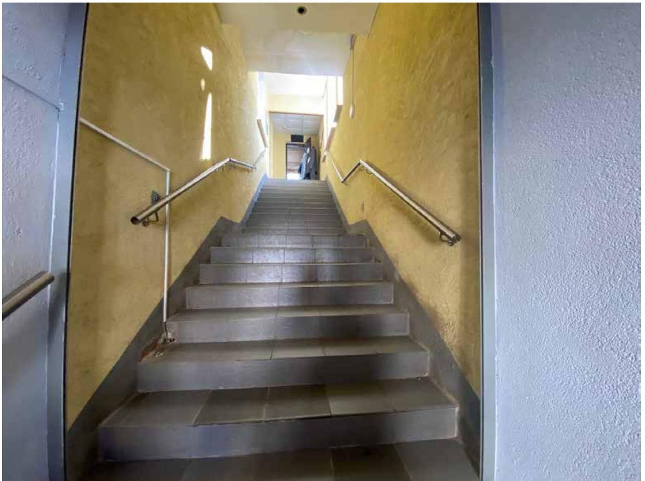
Фото 103. Помещение 1-Н(1). Лестница на 2 этаж
