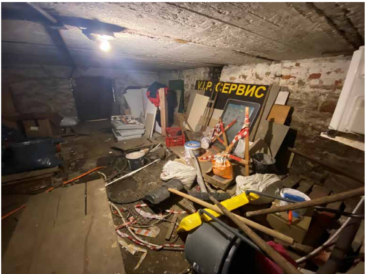
Фото 181. Подвал. Помещение 1-Н(36)
