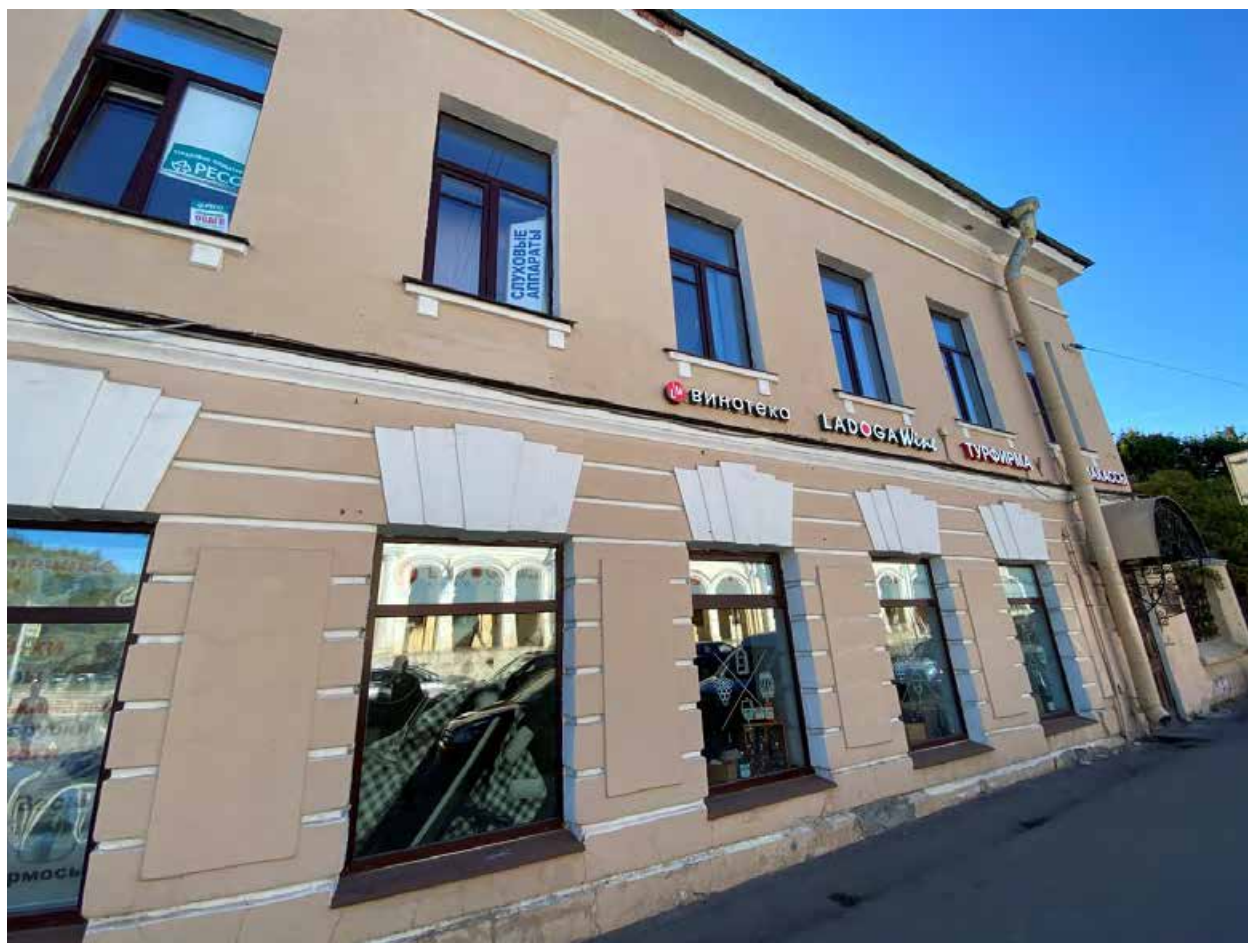
Фото 30. Северо-западный лицевой фасад со стороны Оранжерейной улицы
