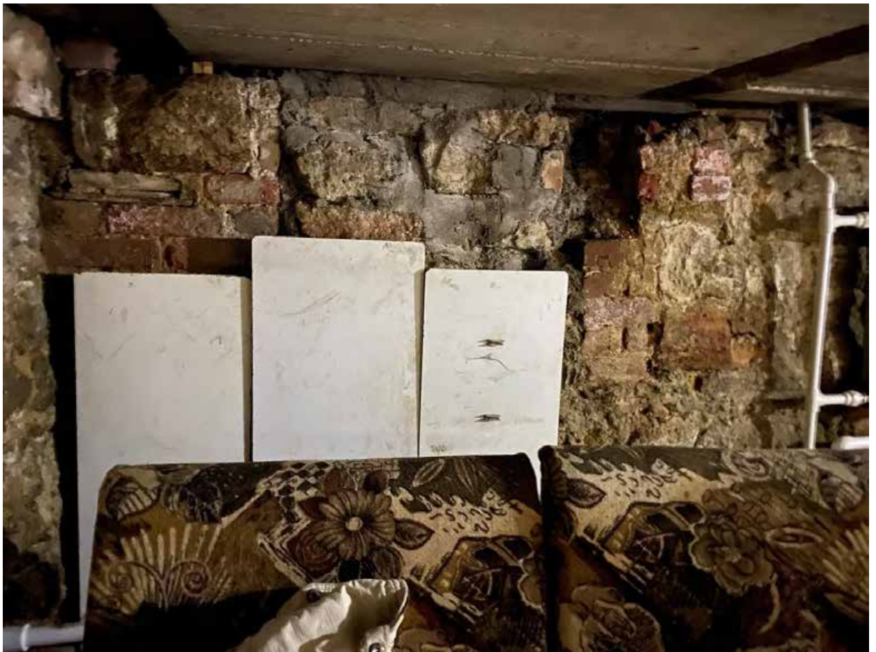
Фото 188. Подвал. Помещение 1-Н(37)
