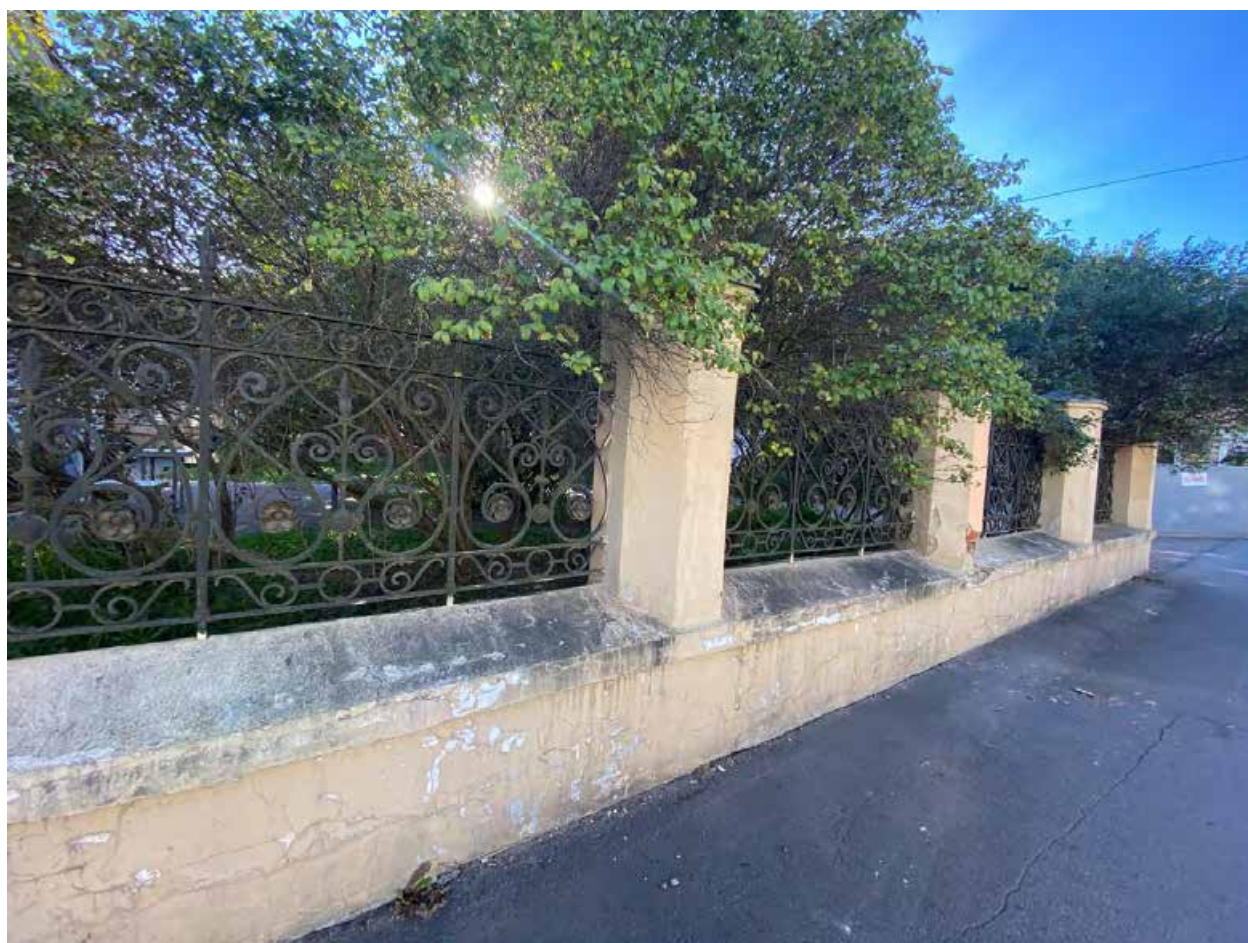
Фото 7. Часть садового ограждения со стороны Оранжерейной улицы
