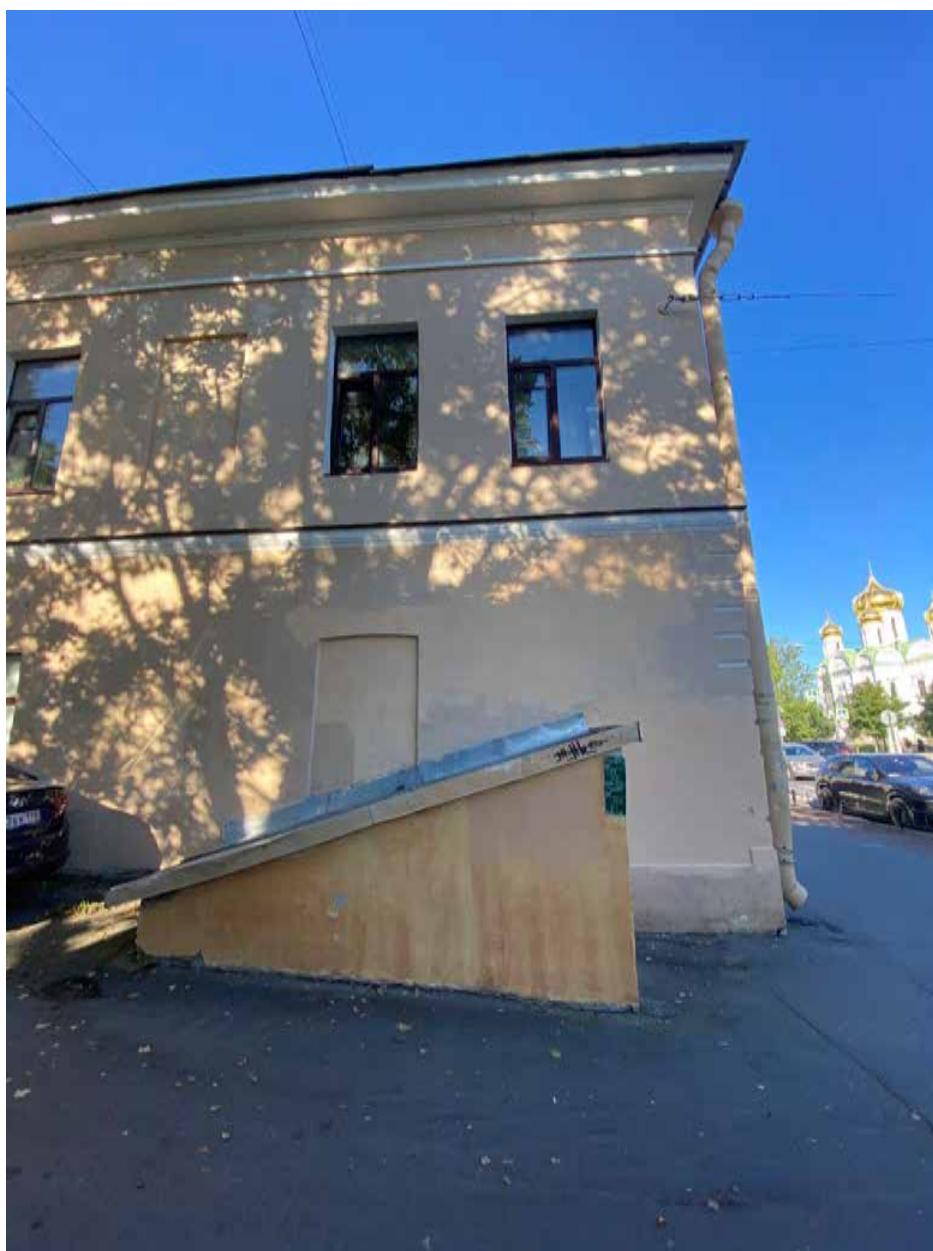
Фото 21. Юго-восточная часть торцевого фасада.
