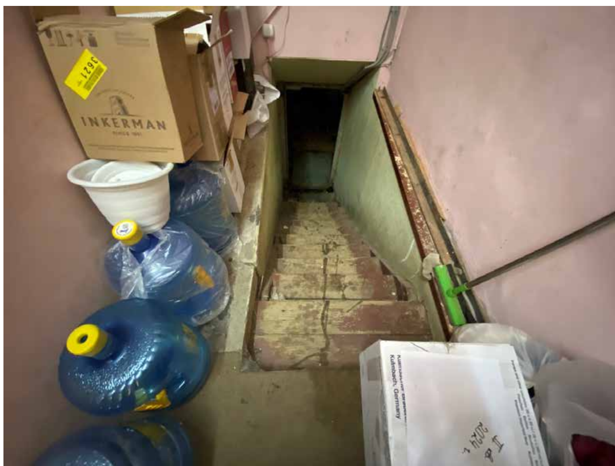
Фото 89. 1этаж. Помещение 1-Н(10)
