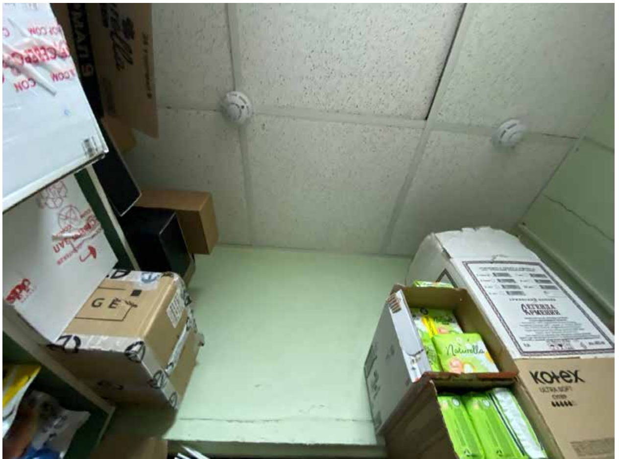
Фото 65. 1этаж. Помещение 1-Н(4)
