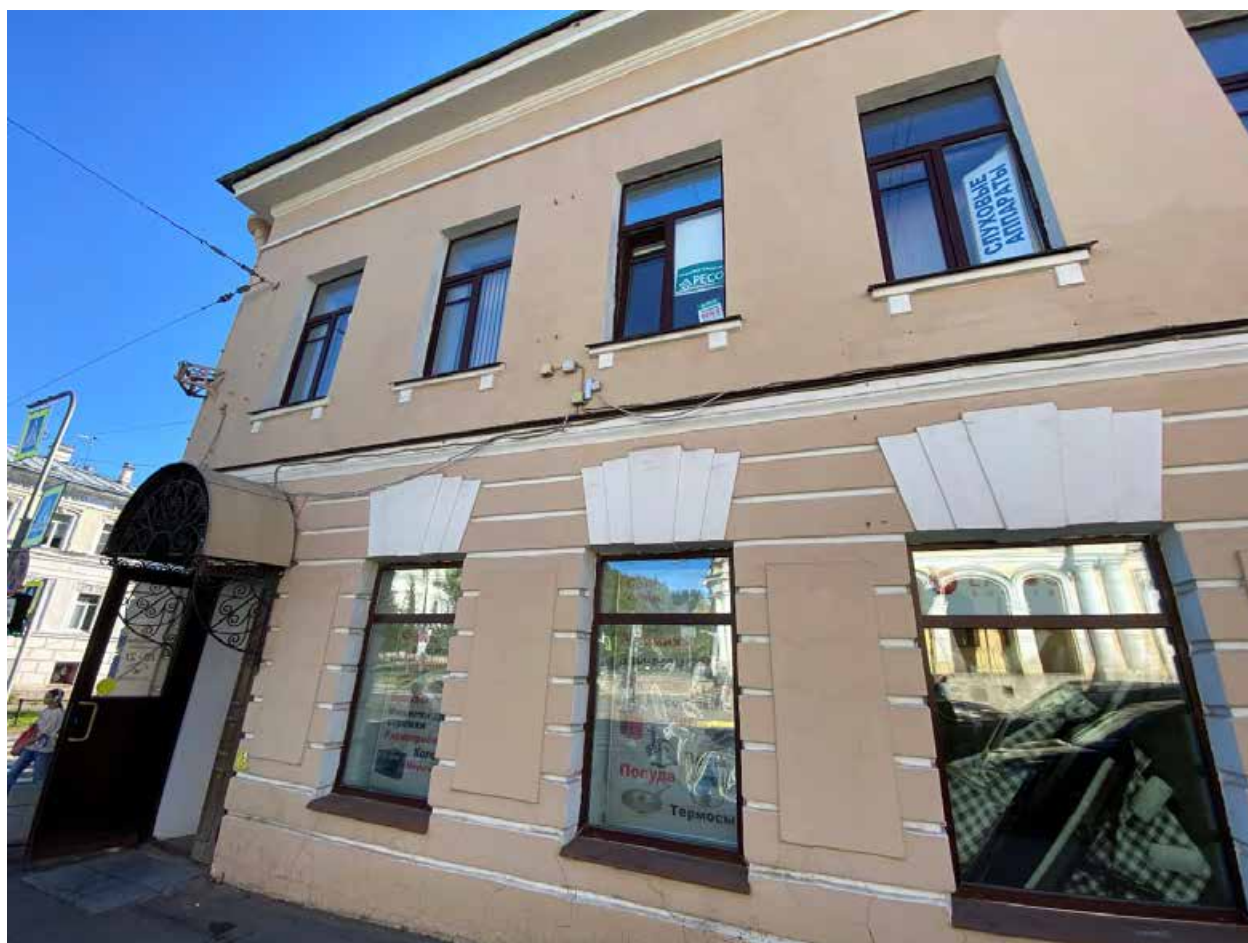
Фото 31. Северо-западный лицевой фасад со стороны Оранжерейной улицы
