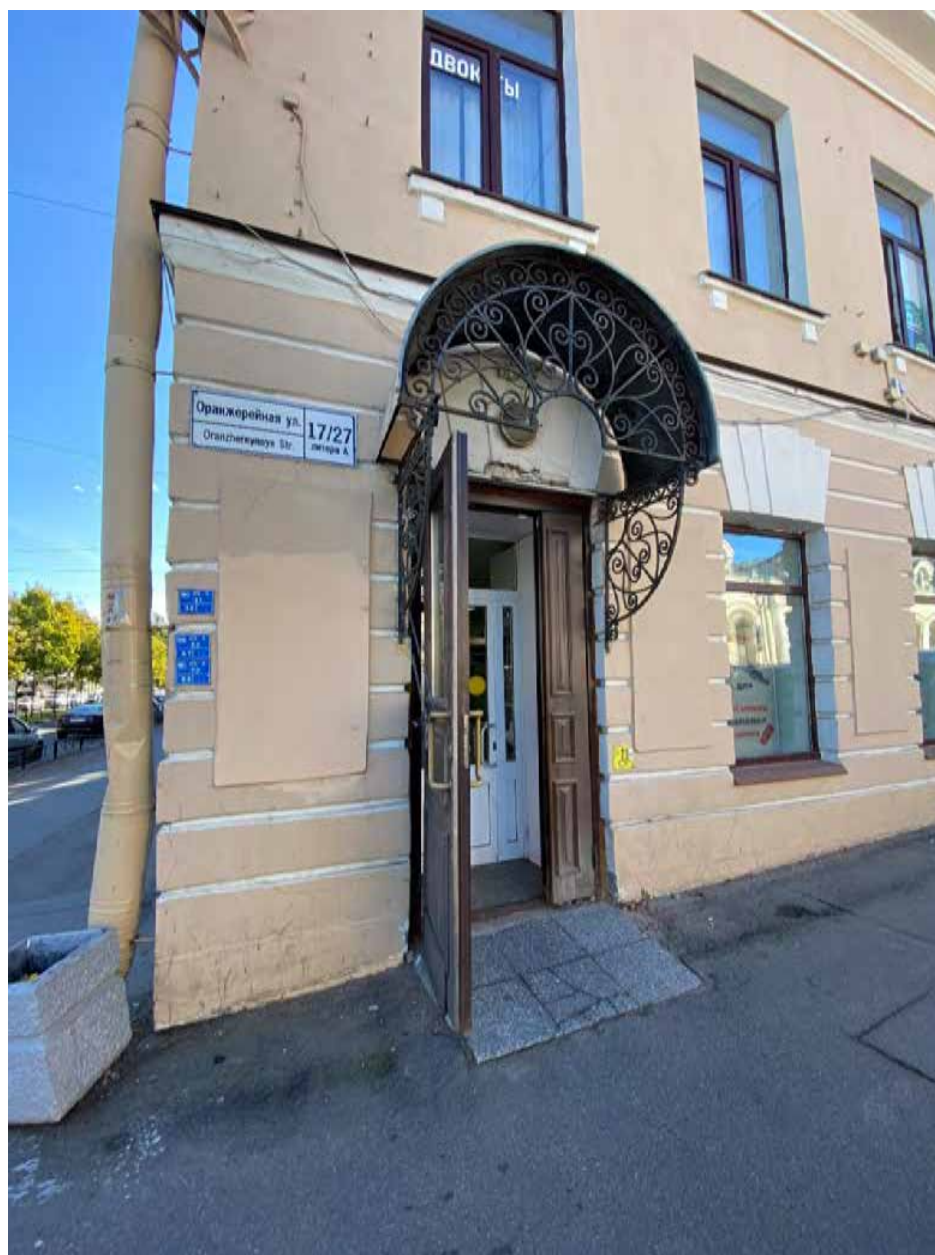
Фото 27. Фрагмент северо-западного лицевого фасада. Вход в здание со стороны Оранжерейной улицы.
