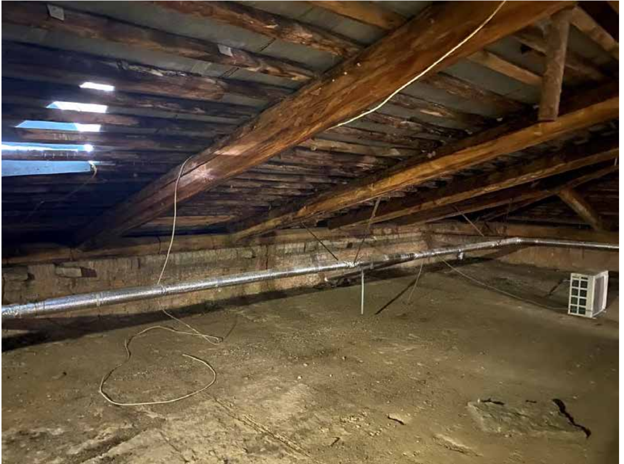
Фото 218. Чердак. Слуховое окно по фасаду кровли.
