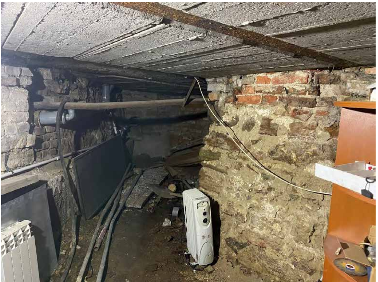
Фото 192. Подвал. Помещение 1-Н(37)
