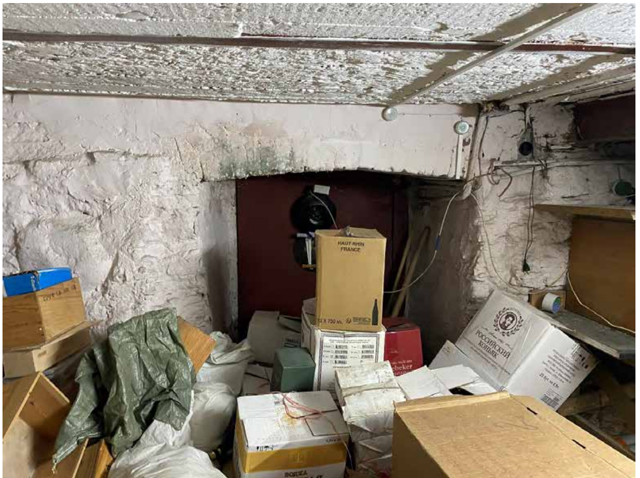
Фото 176. Подвал. Помещение 1-Н(34)
