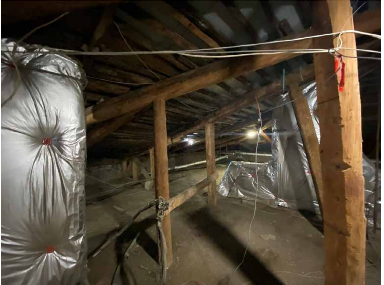
Фото 214. Чердак. Наклонная стропильная конструкция.
