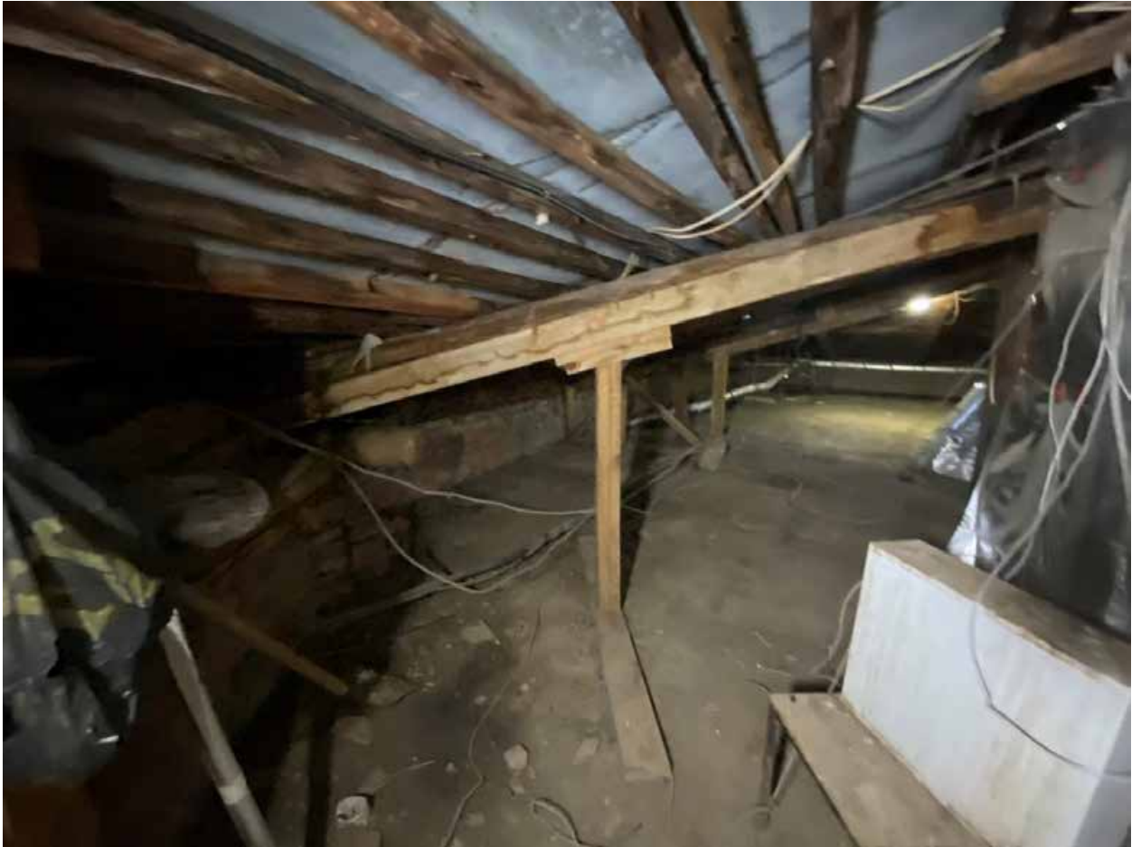
Фото 209. Чердак. Наклонная стропильная подпорка.
