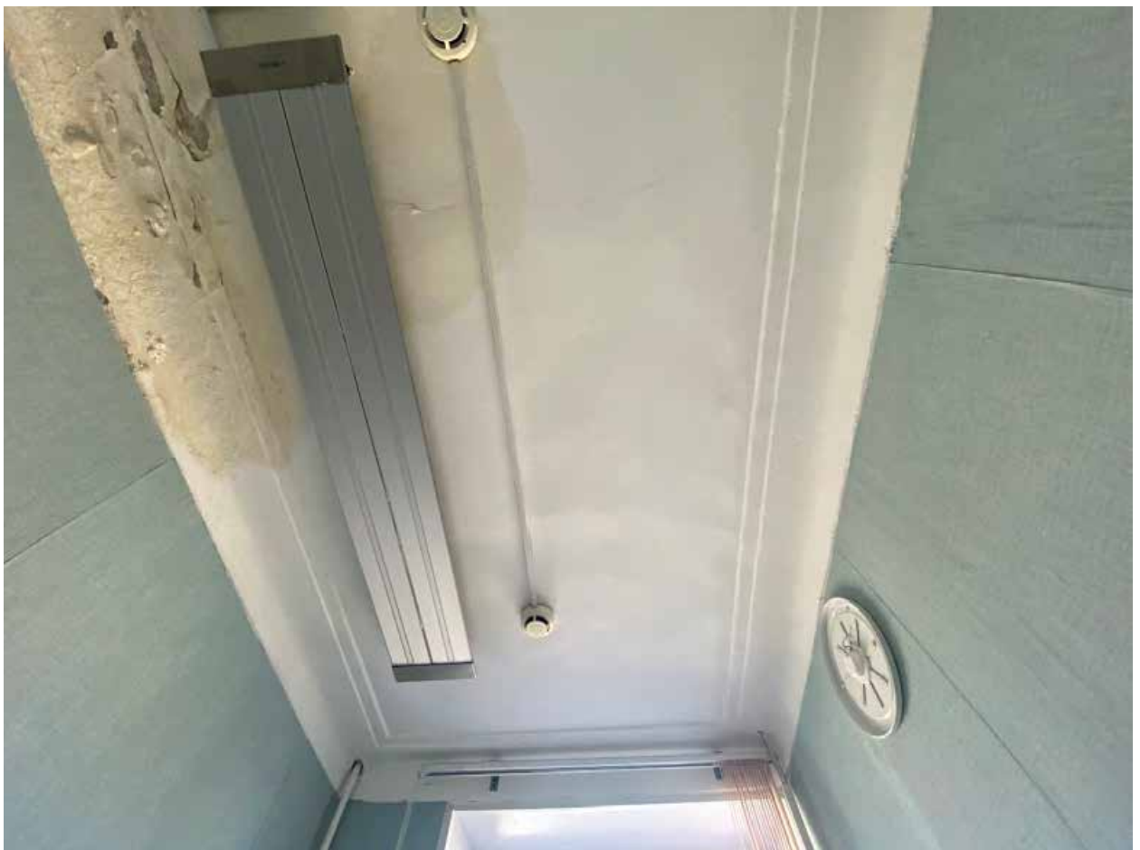
Фото 121. 2 этаж. Помещение 1-Н(17)
