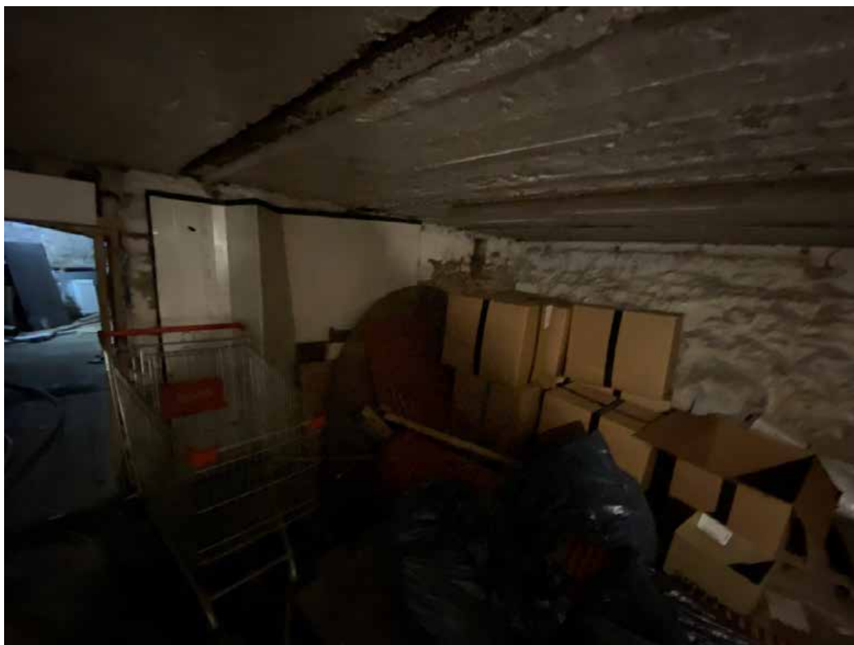
Фото 185. Подвал. Помещение 1-Н(36)
