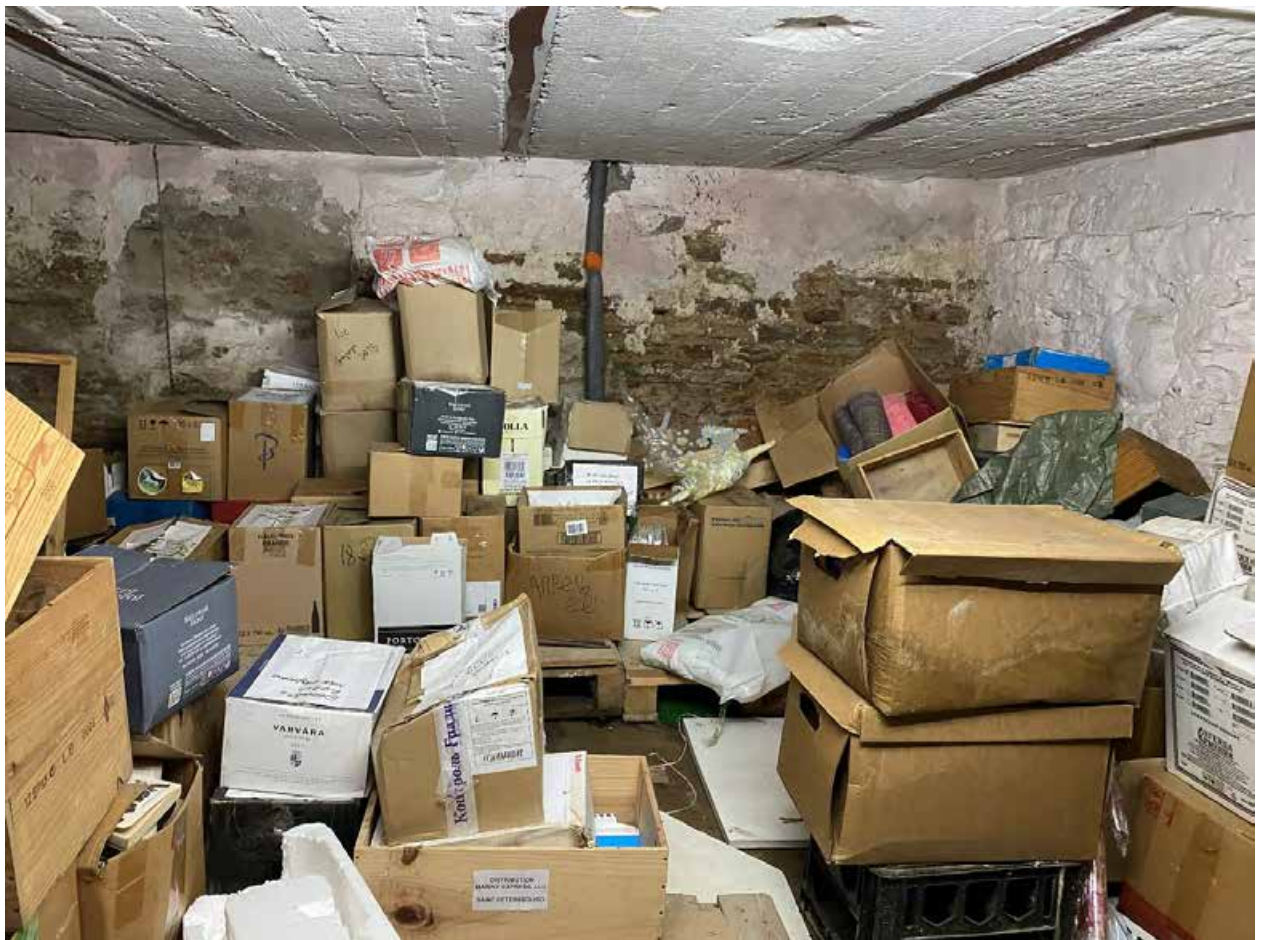
Фото 171. Подвал. Помещение 1-Н(34)
