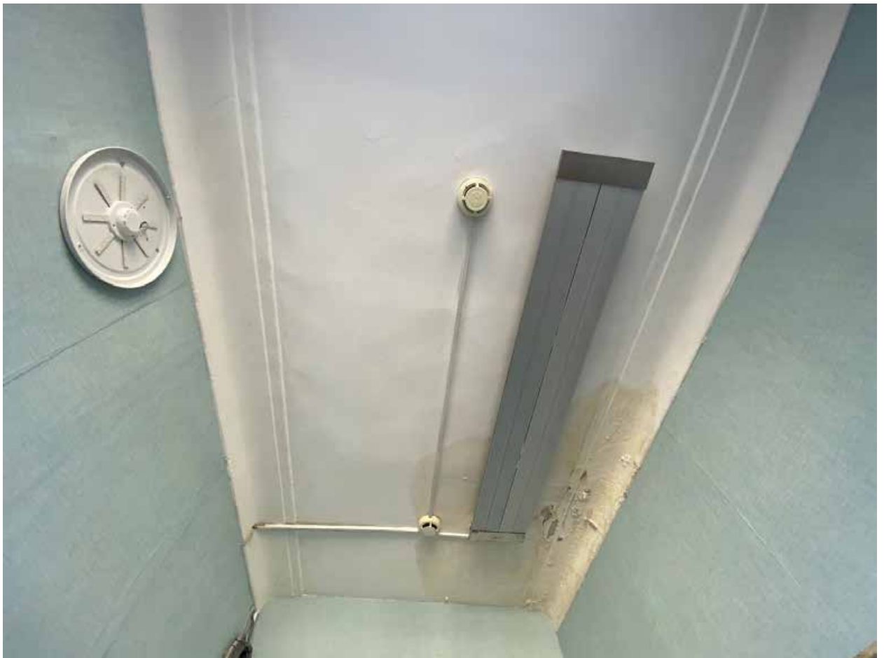
Фото 119. 2 этаж. Помещение 1-Н(17)
