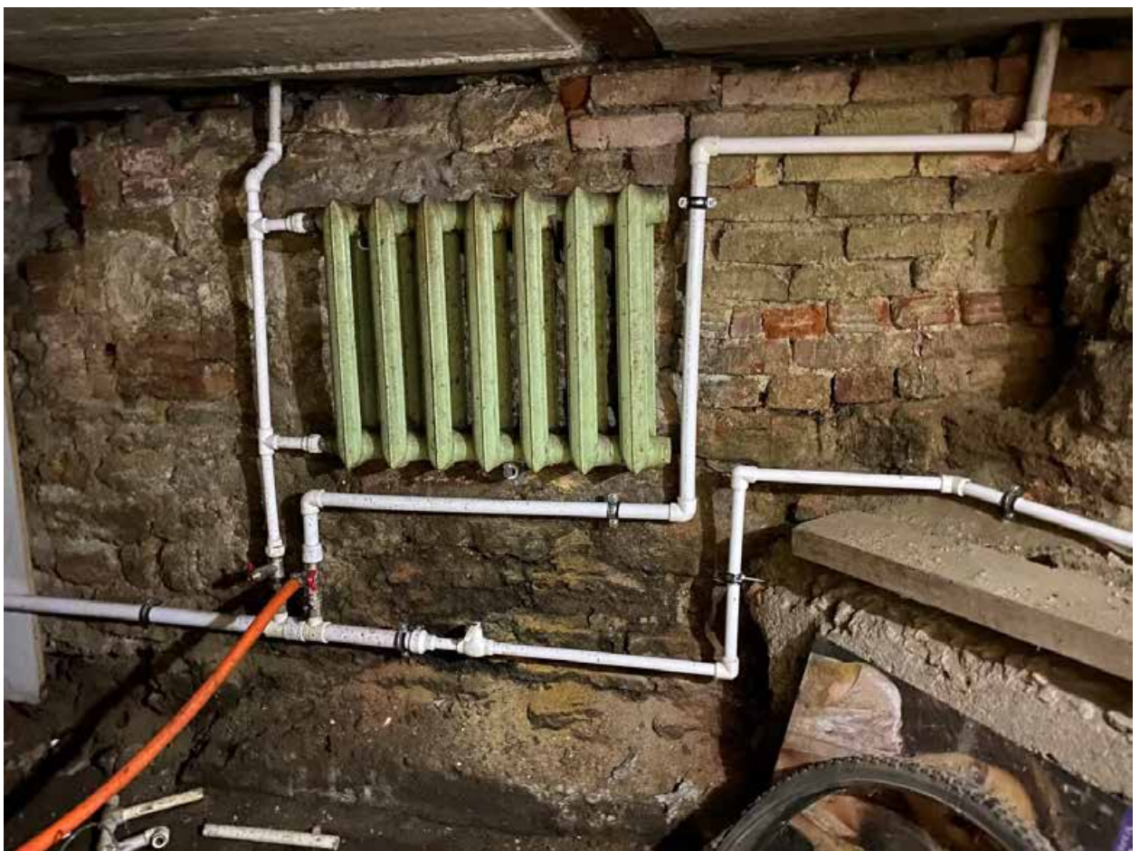
Фото 195. Подвал. Помещение 1-Н(37)
