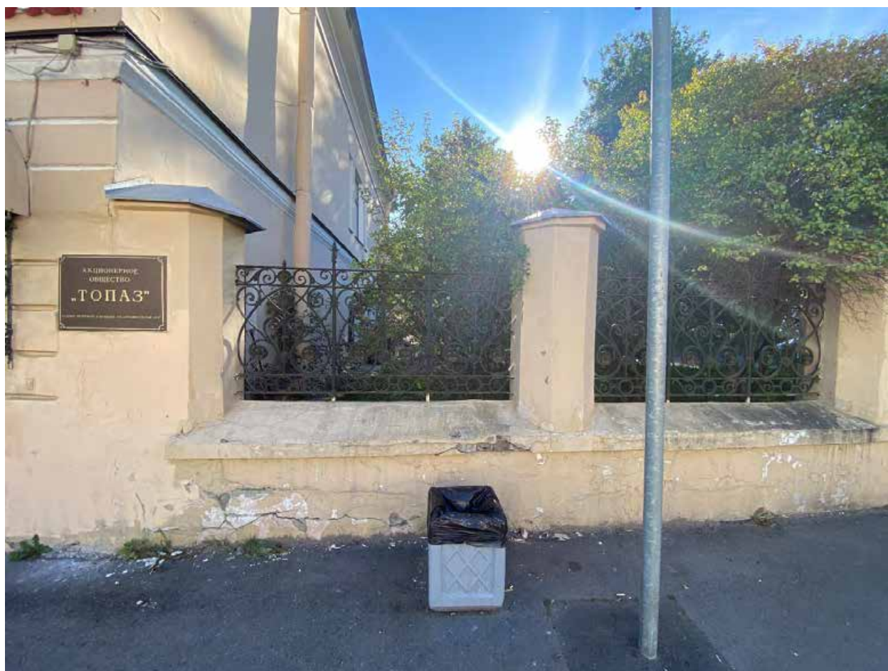
Фото 4. Часть садового ограждения со стороны Оранжерейной улицы
