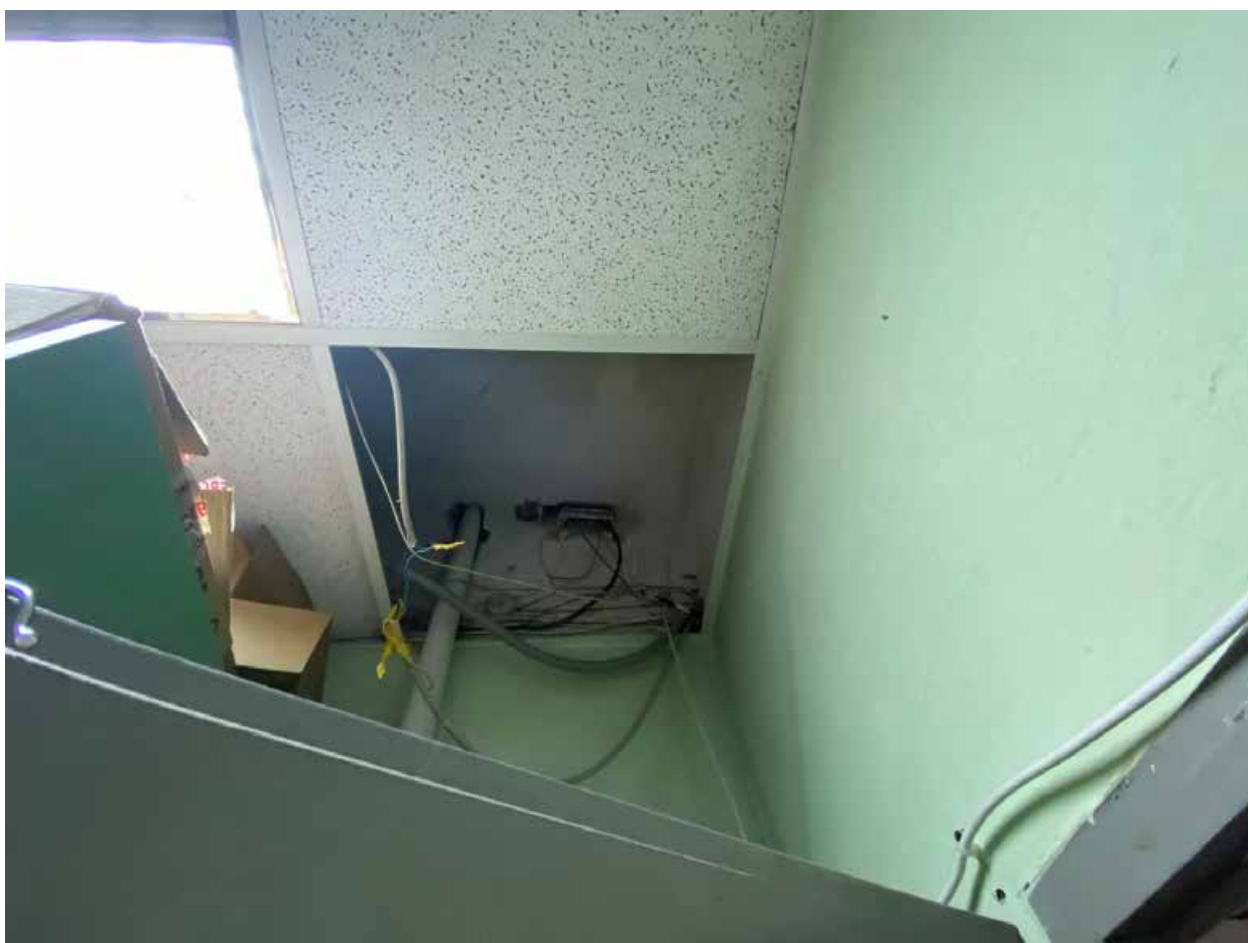
Фото 66. 1этаж. Помещение 1-Н(4)
