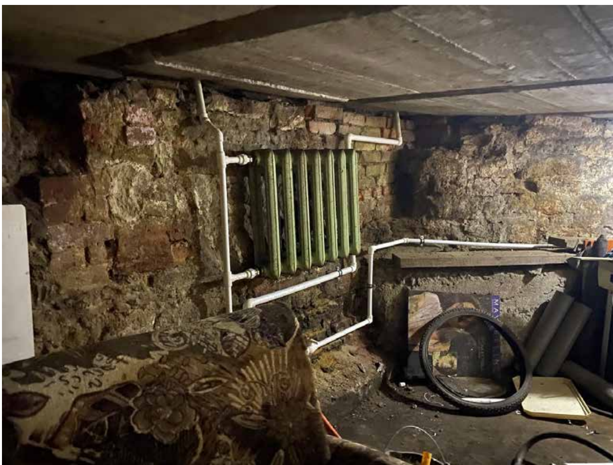
Фото 187. Подвал. Помещение 1-Н(37)
