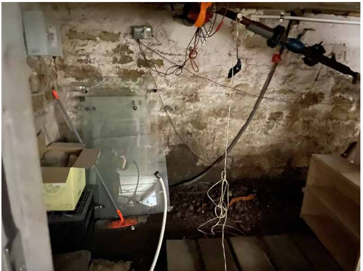
Фото 167. Подвал. Помещение 1-Н(34)
