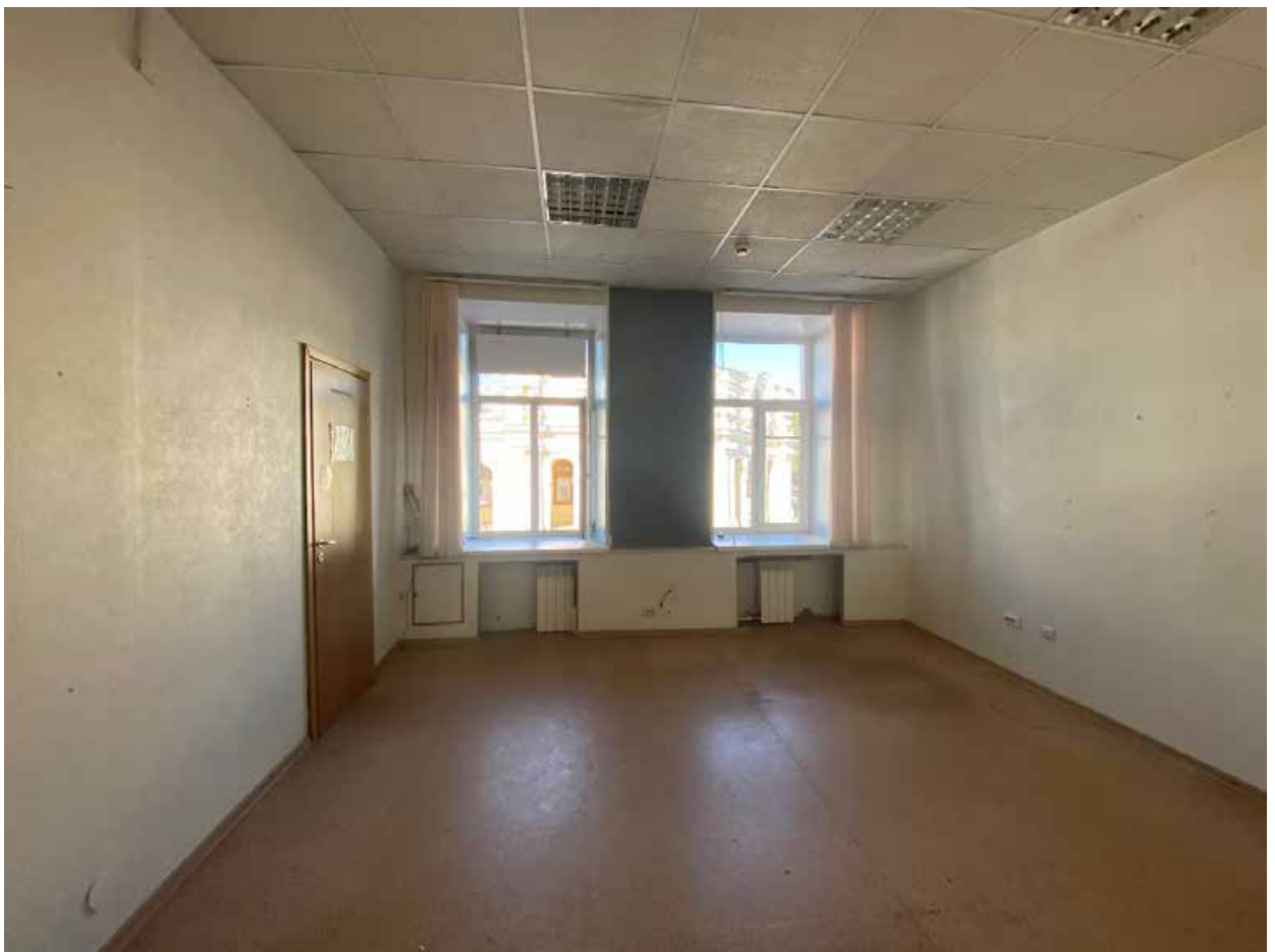
Фото 114. 2 этаж. Помещение 1-Н(18)
