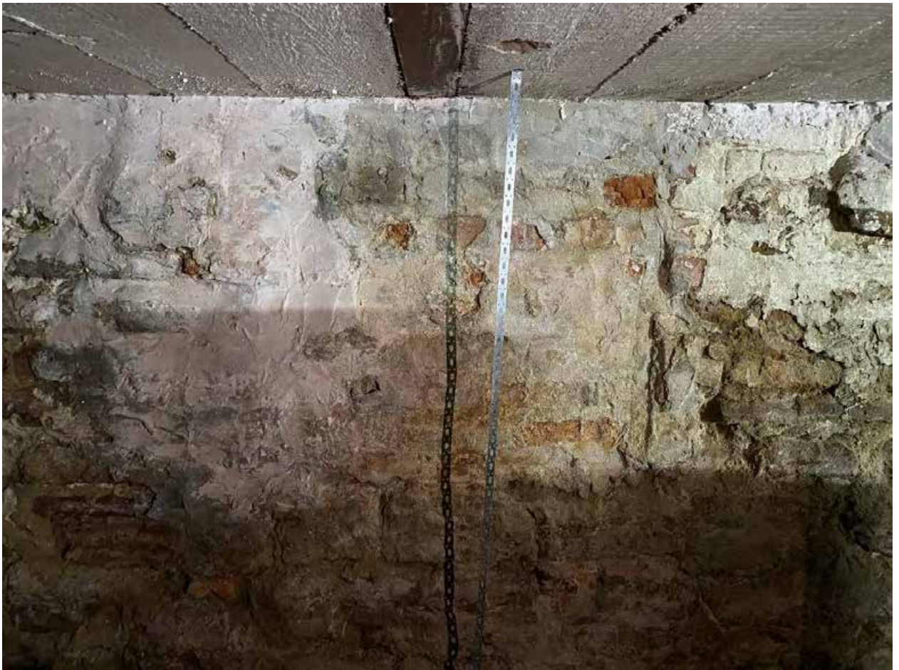
Фото 174. Подвал. Помещение 1-Н(34)
