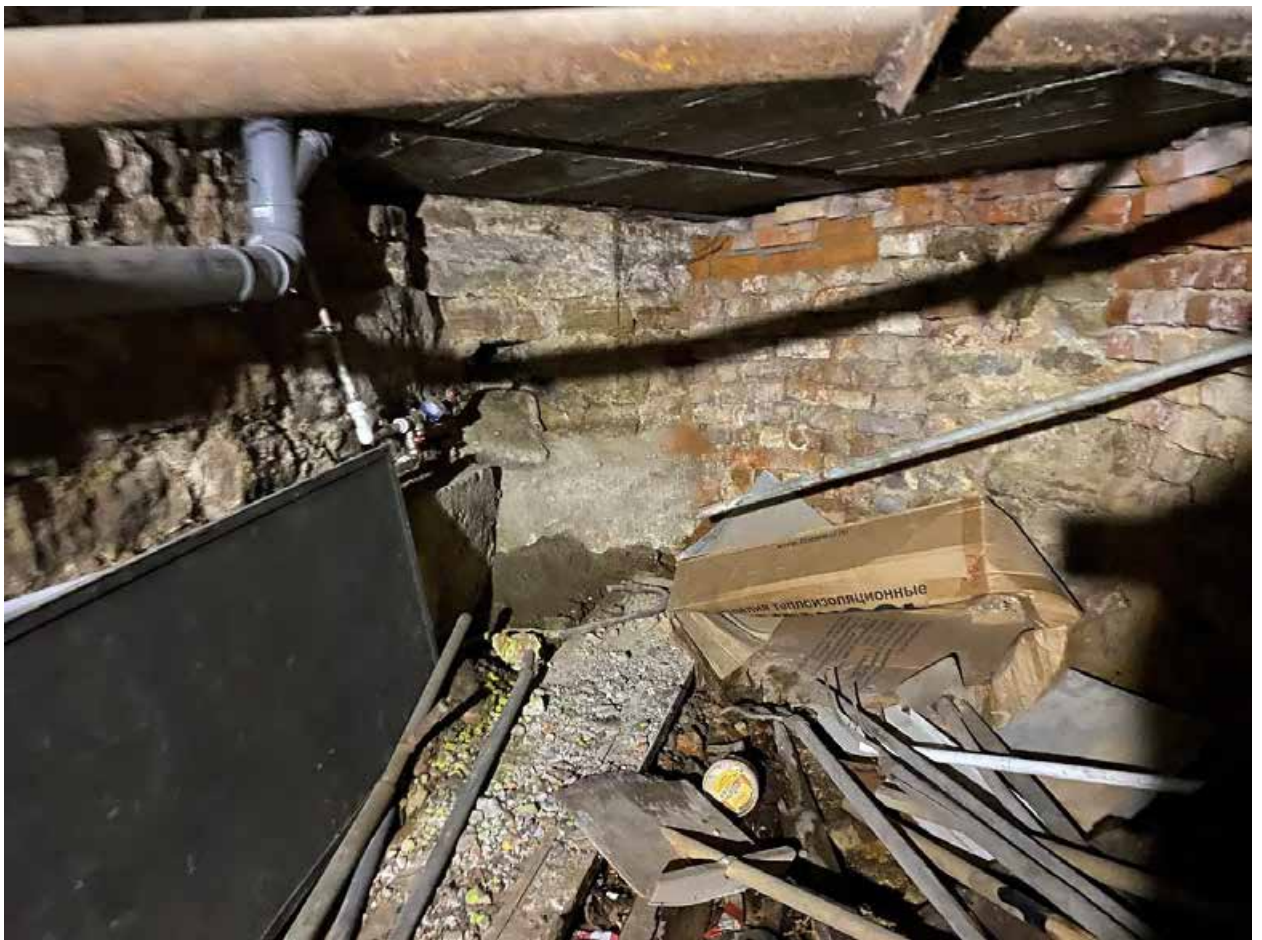
Фото 193. Подвал. Помещение 1-Н(37)
