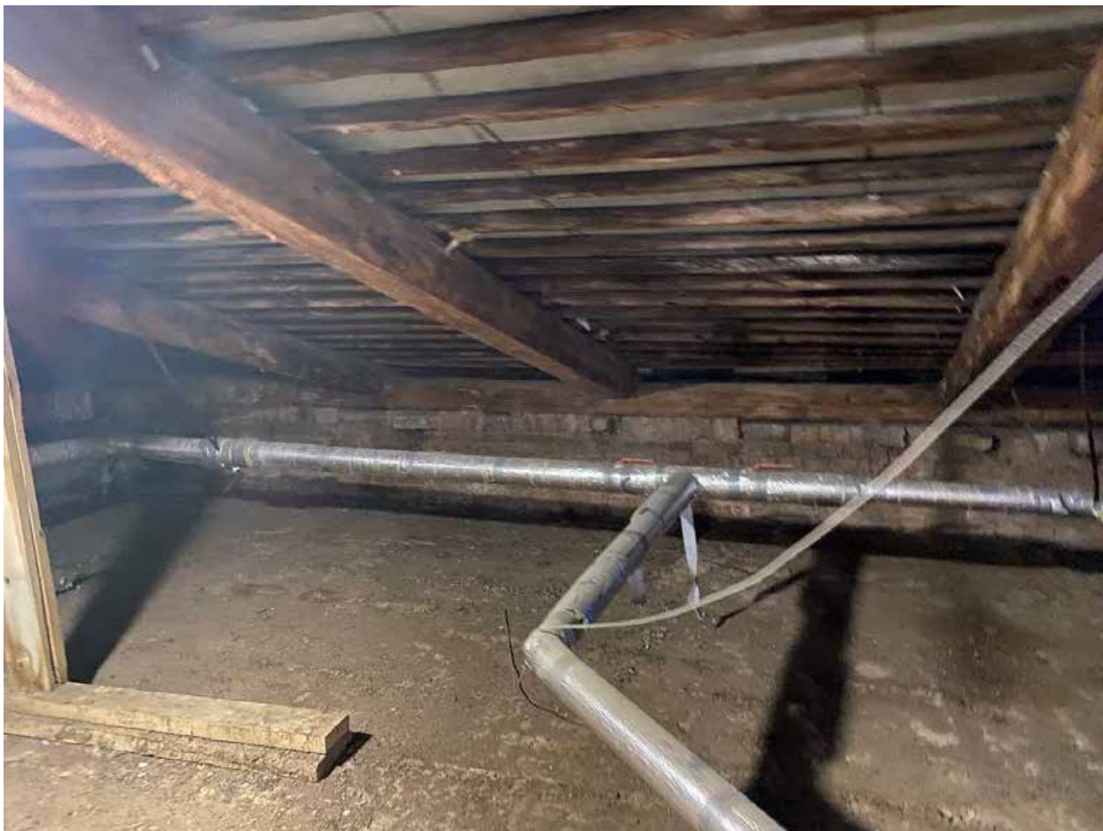
Фото 217. Чердак. Фрагмент конструкции дощатого перекрытия чердака. Водопроводная система. Узел.
