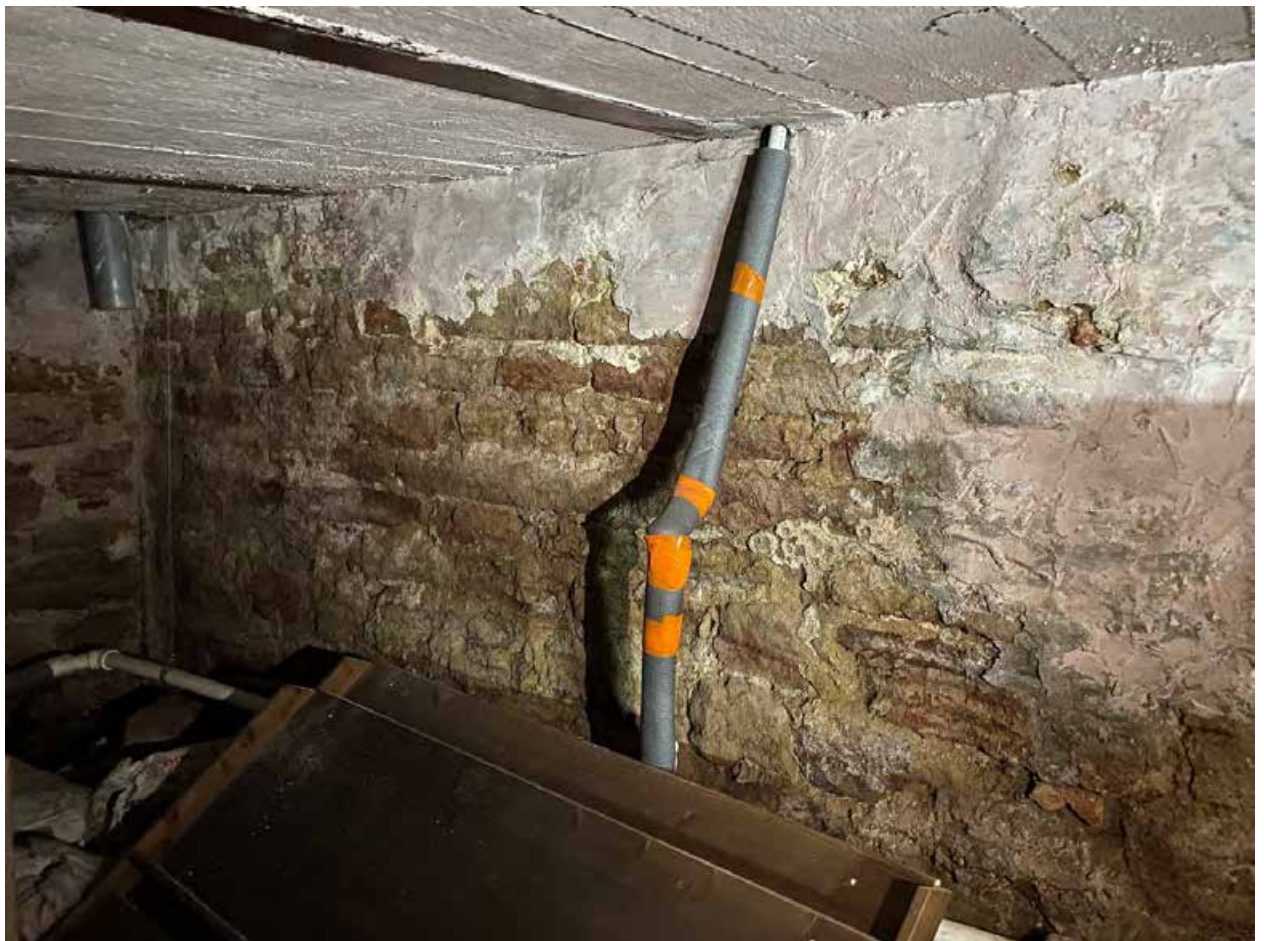
Фото 173. Подвал. Помещение 1-Н(34)
