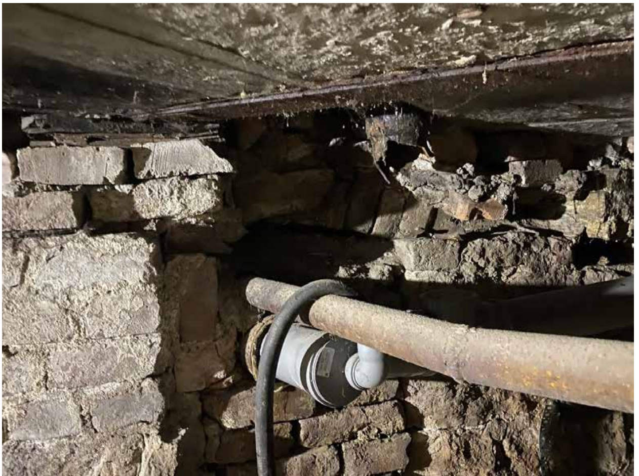
Фото 194. Подвал. Помещение 1-Н(37)
