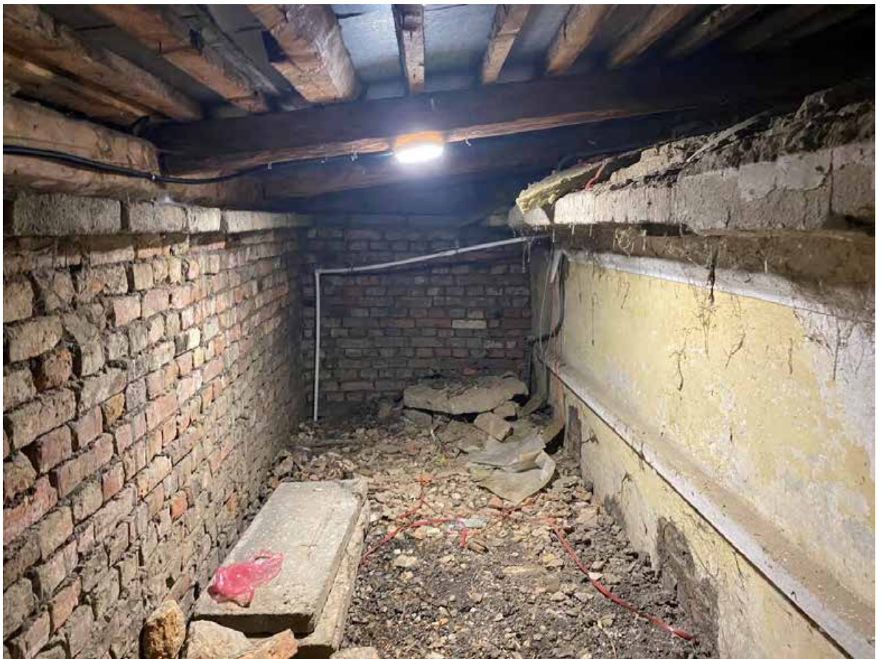
Фото 207. Чердак в объеме пристроенной лестницы. Фрагмент исторического лицевого фасада.
