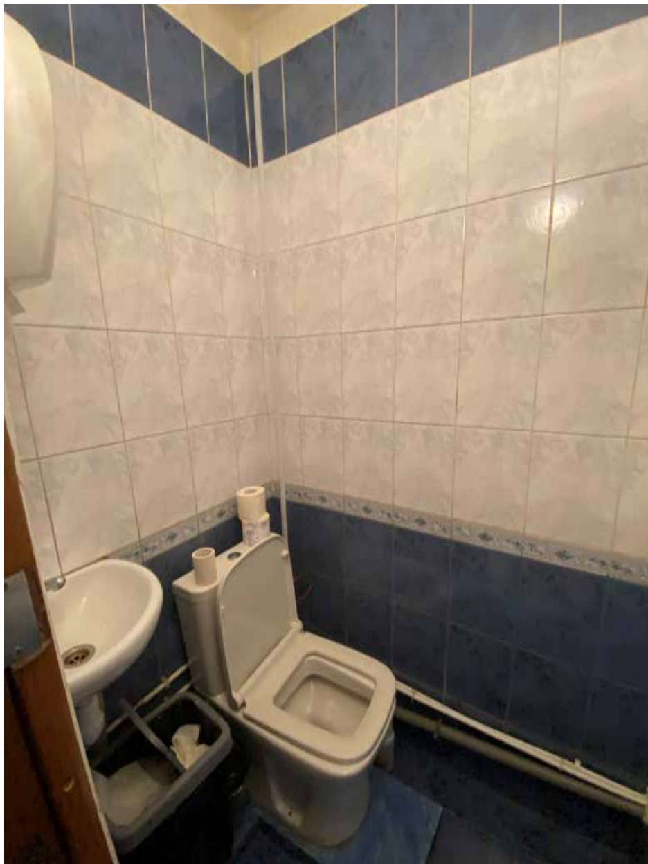
Фото 131. 2 этаж. Помещение 1-Н(30)
