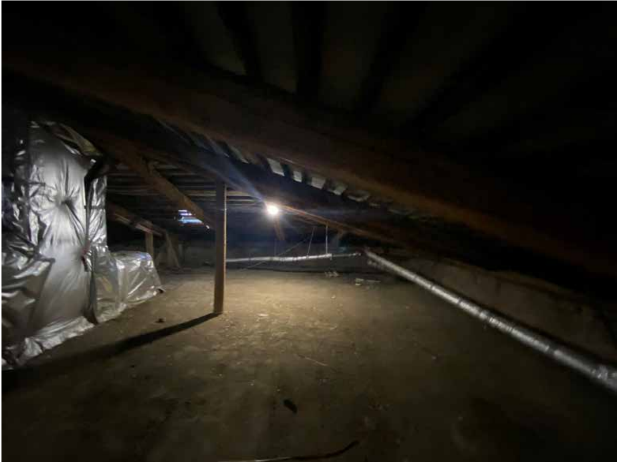
Фото 221. Чердак. Угловой фрагмент.
