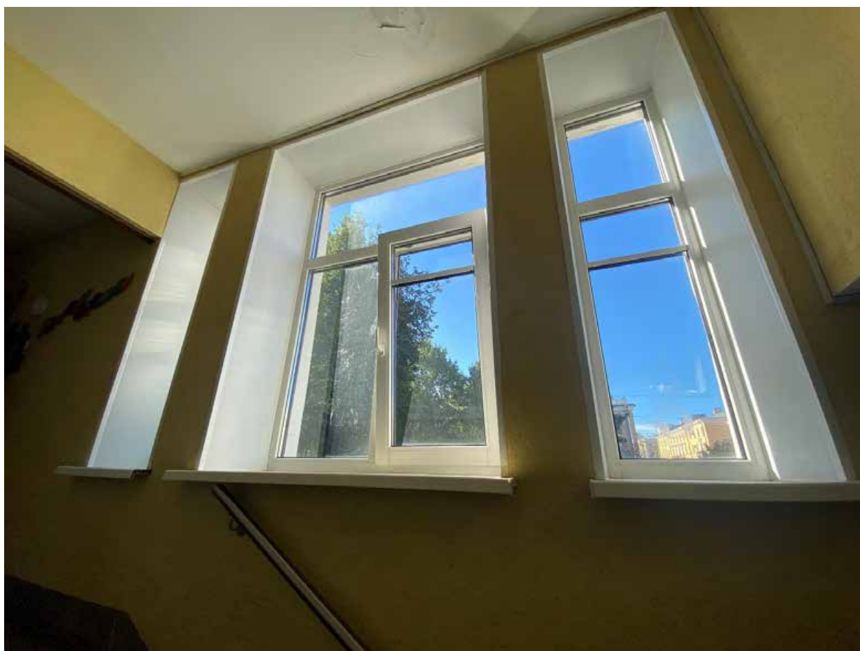
Фото 105. Лестница 2 этаж, окна юго-западной части фасада
