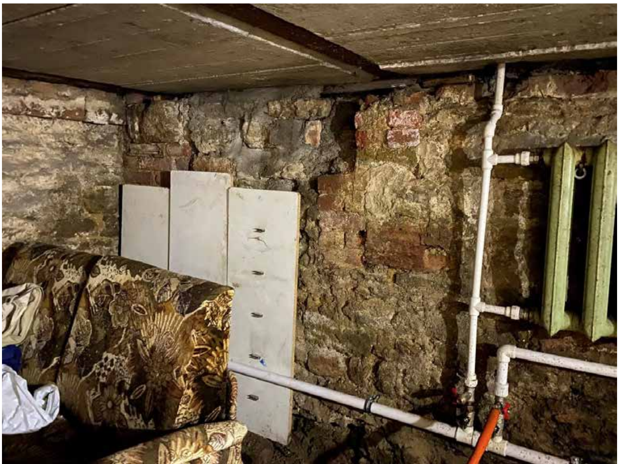
Фото 189. Подвал. Помещение 1-Н(37)
