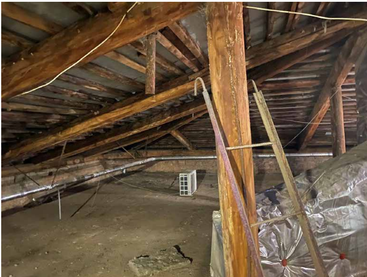
Фото 219. Чердак. Угловая наклонная конструкция деревянных стропил кровли.
