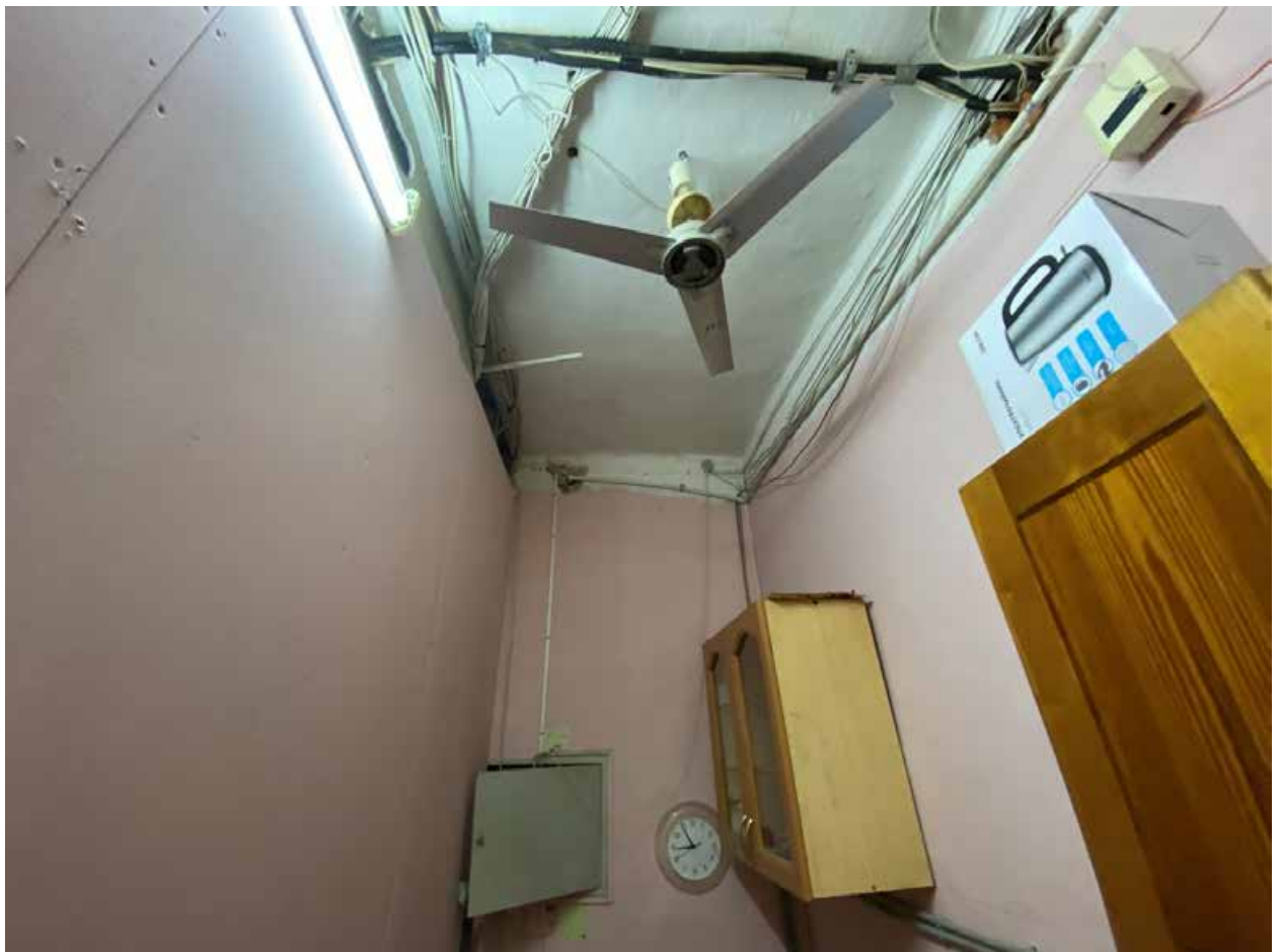
Фото 88. 1этаж. Помещение 1-Н(10)
