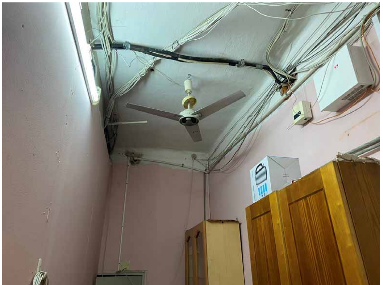
Фото 87. 1этаж. Помещение 1-Н(10)
