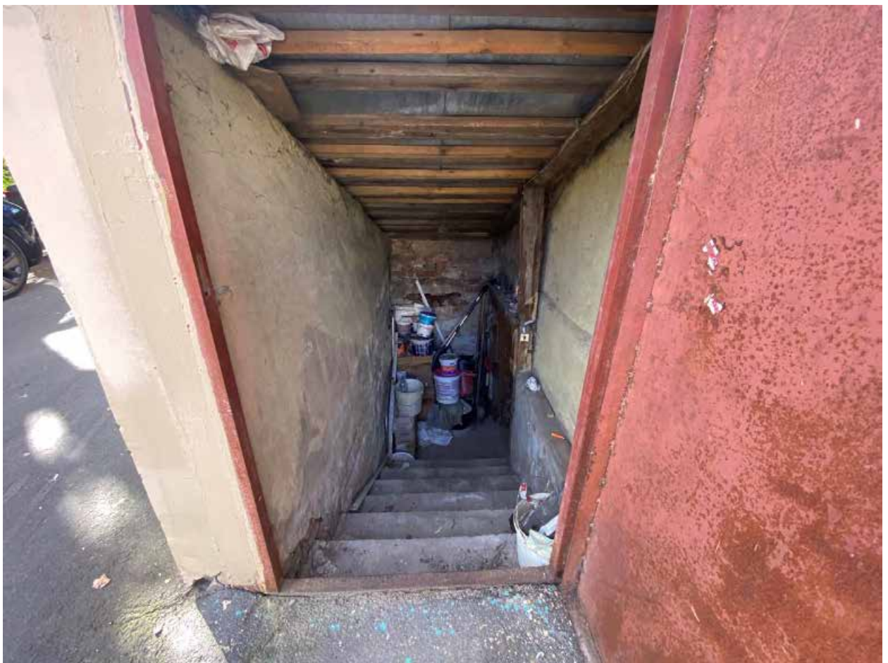
Фото 179. Лестница в подвал со стороны юго-восточного фасада
