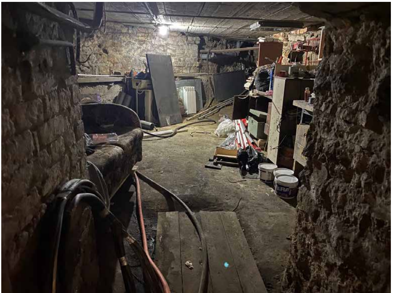
Фото 186. Подвал. Помещение 1-Н(37)
