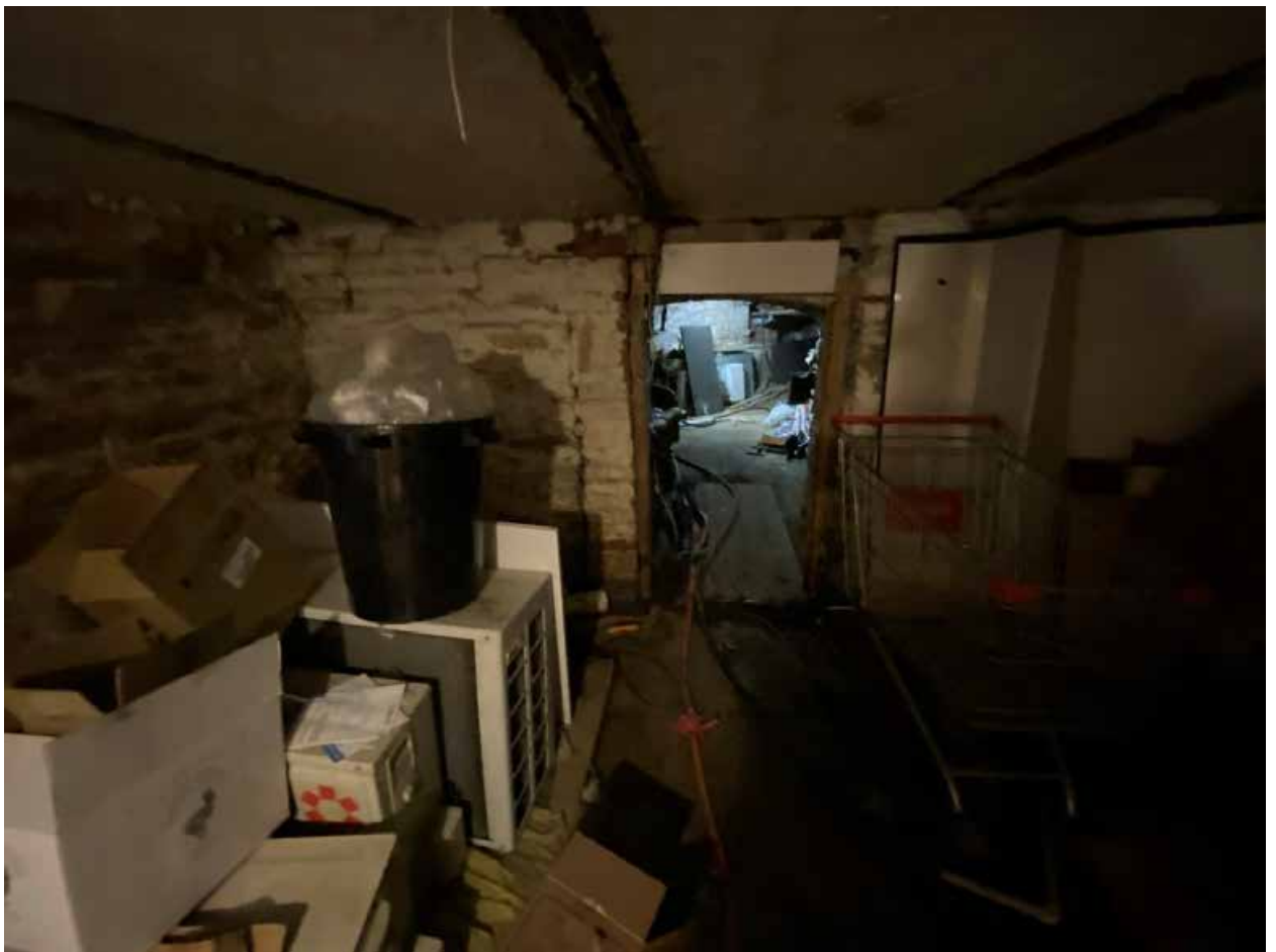
Фото 184. Подвал. Помещение 1-Н(36)
