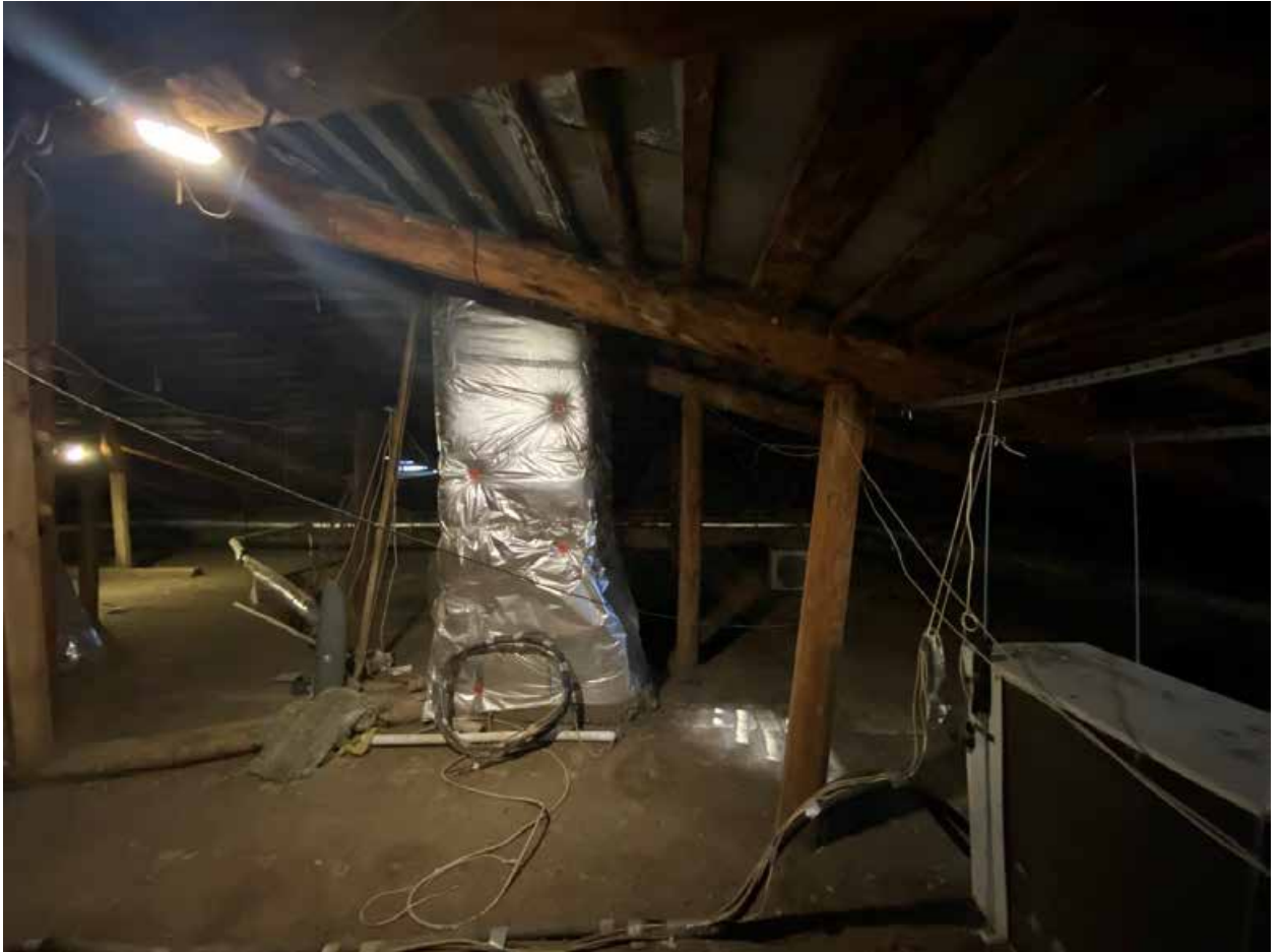
Фото 212. Чердак. Наклонная стропильная подпорка.
