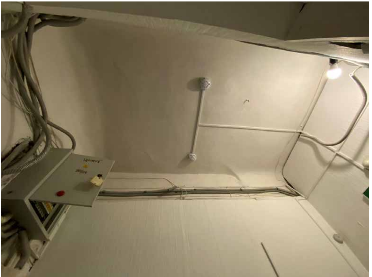
Фото 69. 1этаж. Помещение 1-Н(6)
