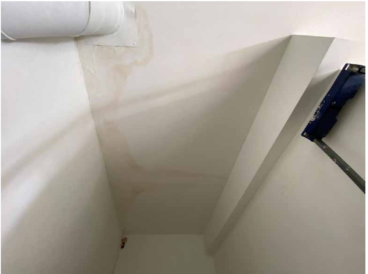
Фото 76. 1этаж. Помещение 1-Н(11)
