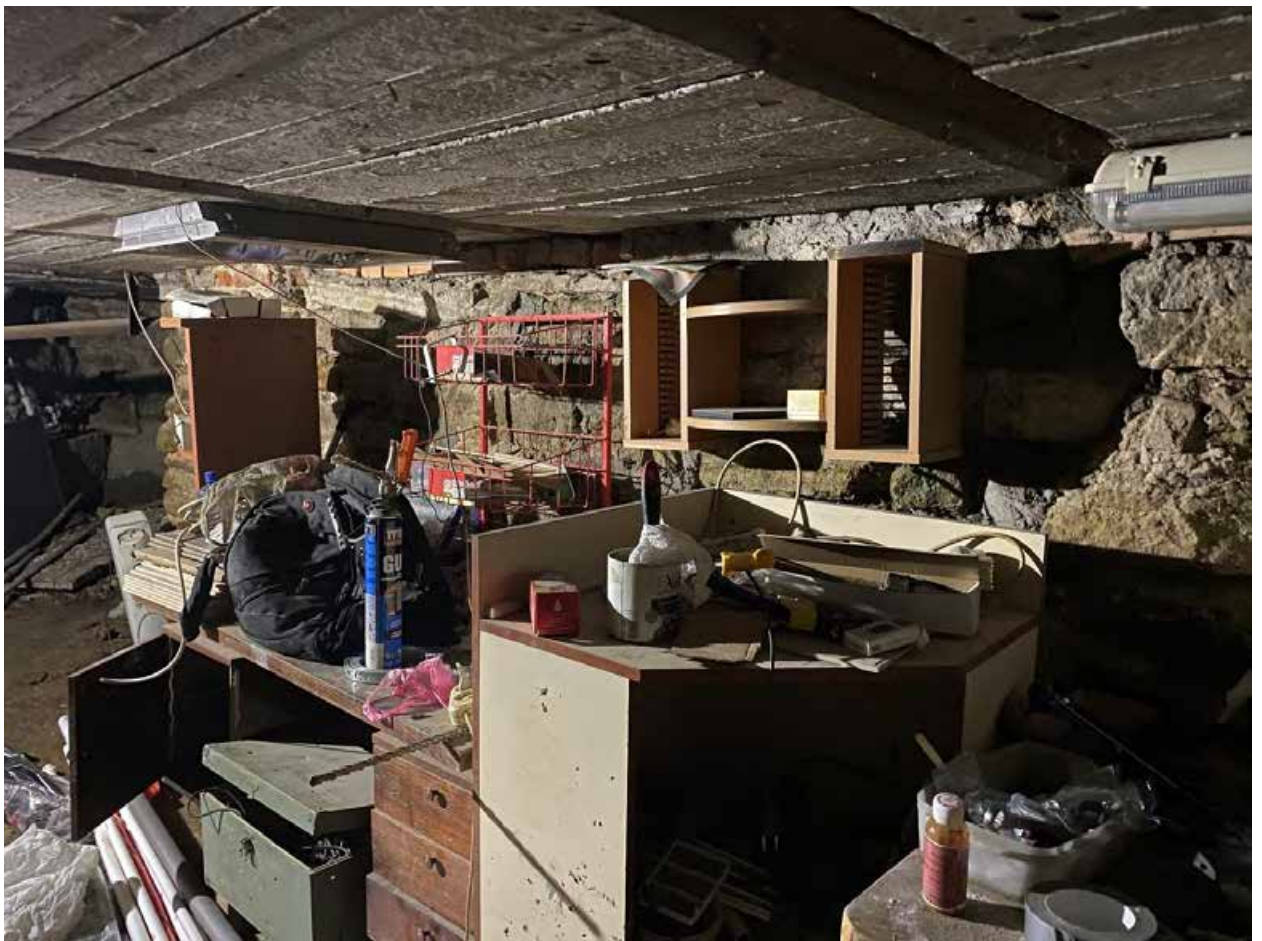
Фото 191. Подвал. Помещение 1-Н(37)
