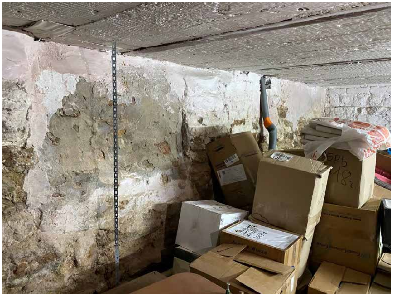
Фото 175. Подвал. Помещение 1-Н(34)
