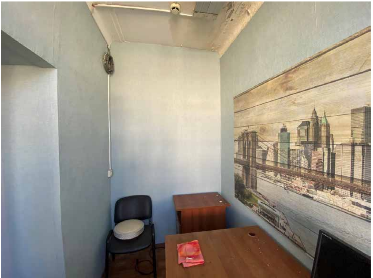
Фото 118. 2 этаж. Помещение 1-Н(17)
