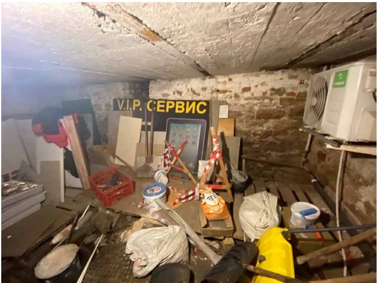
Фото 183. Подвал. Помещение 1-Н(36)
