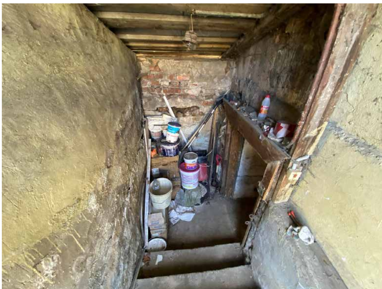
Фото 180. Лестница в подвал со стороны юго-восточного фасада
