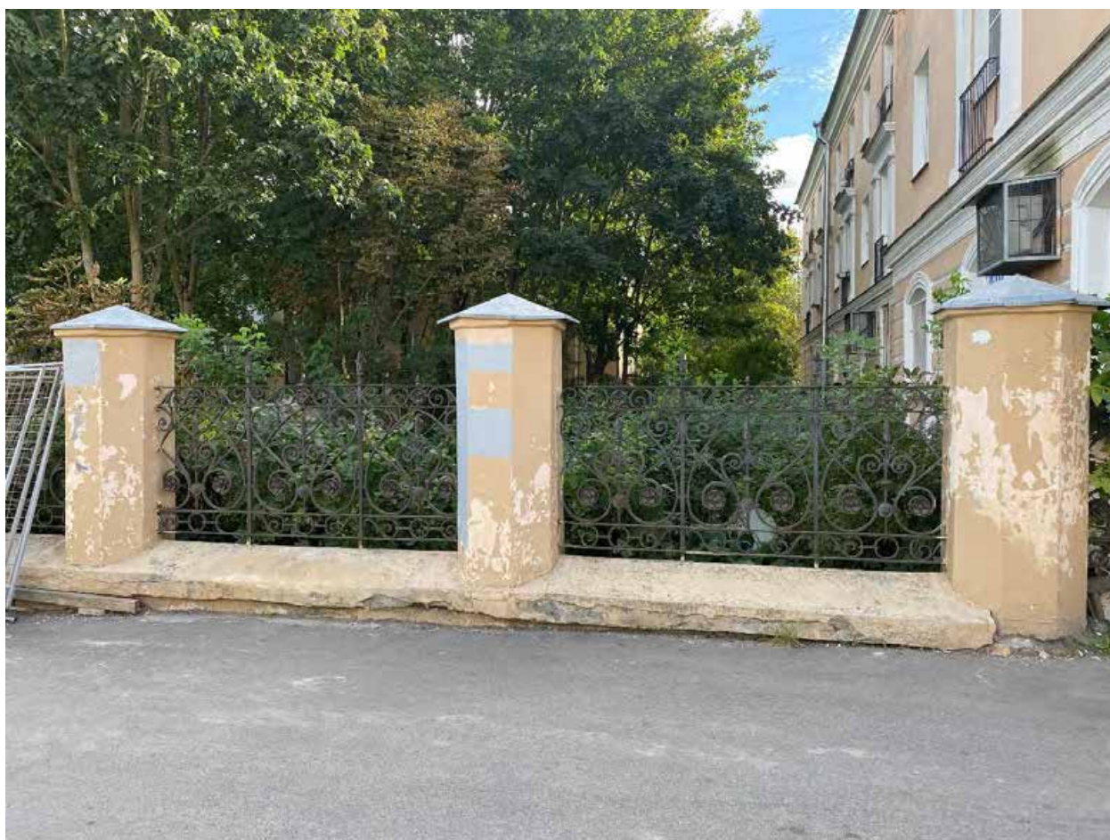
Фото 35. Часть садового ограждения со стороны Оранжерейной улицы
