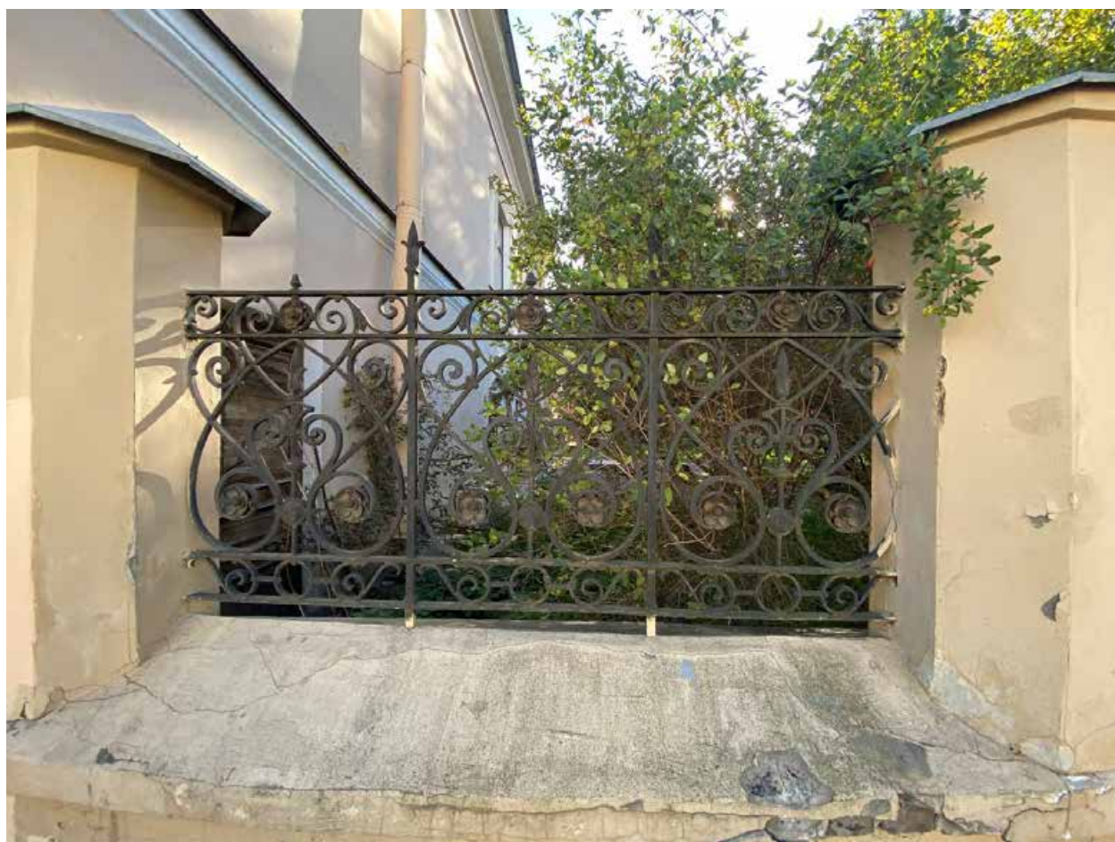
Фото 6. Часть садового ограждения со стороны Оранжерейной улицы
