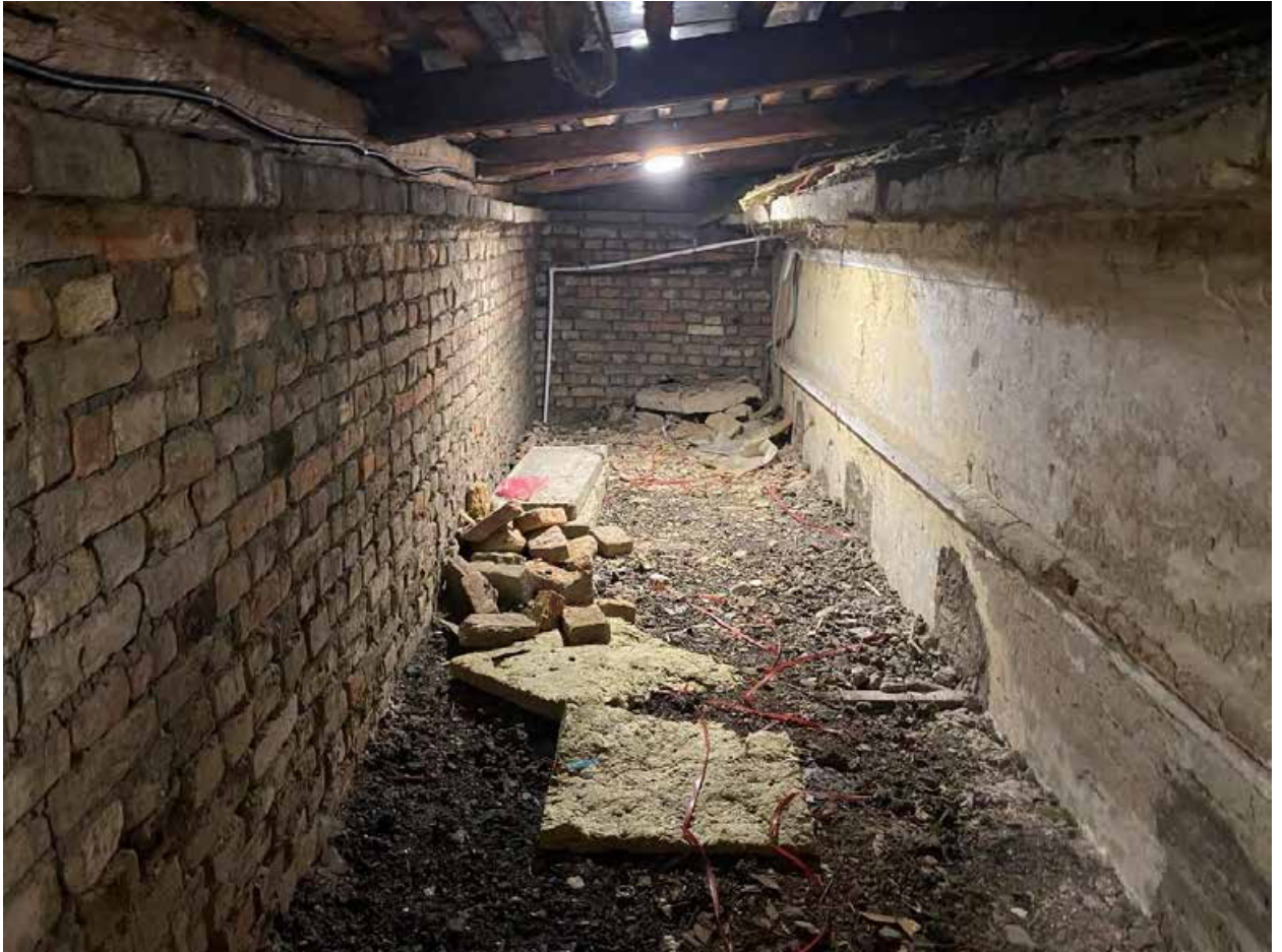
Фото 206. Чердак в объеме пристроенной лестницы. Фрагмент исторического лицевого фасада.
