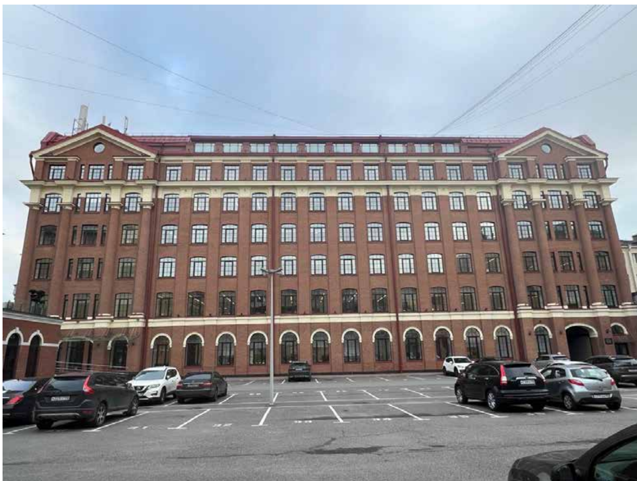
1. Вид на западный фасад выявленного объекта культурного наследия «Здание макаронной фабрики акционерного общества «М. Иванов и Н. Гольдберг»», расположенного по адресу: г. Санкт-Петербург, Московский пр., д. 140, корпус 2, литера А. 15.01.2025
