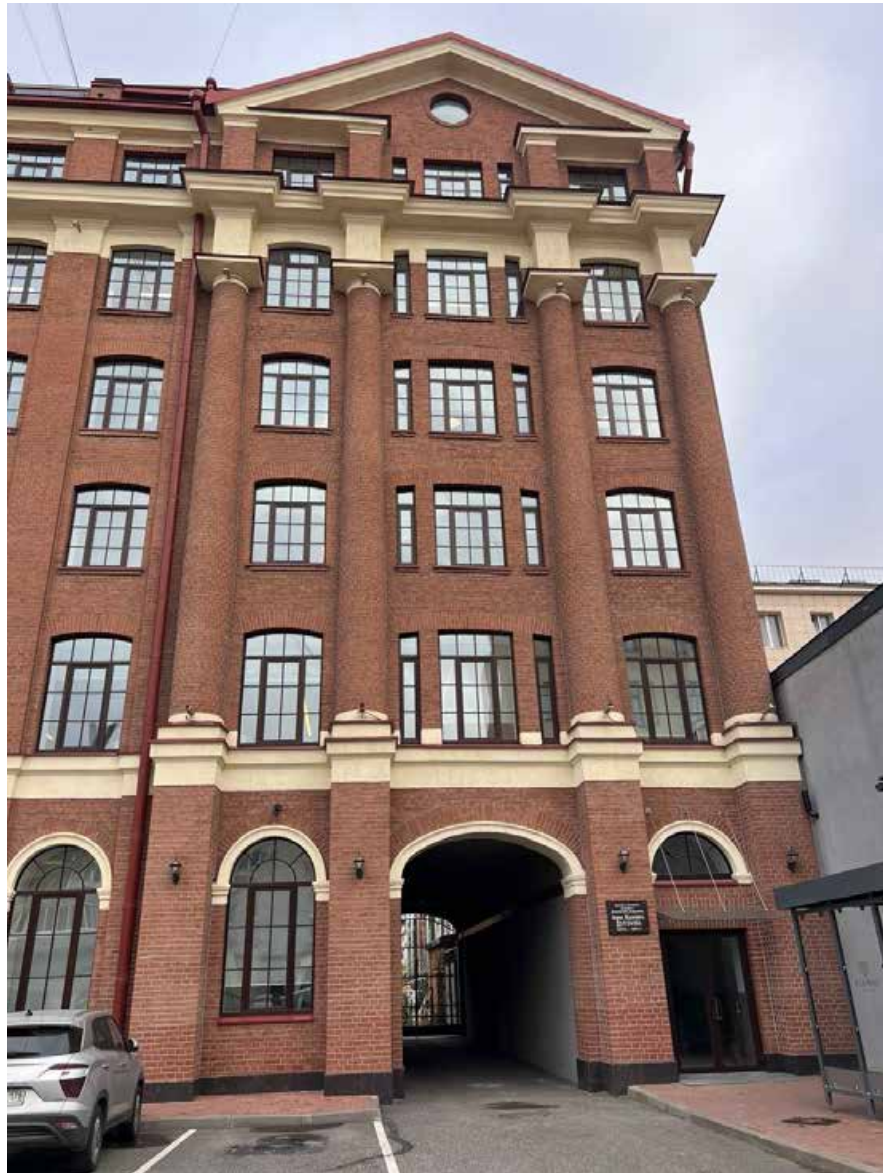
6. Вид на западный фасад выявленного объекта культурного наследия «Здание макаронной фабрики акционерного общества «М. Иванов и Н. Гольдберг»», расположенного по адресу: г. Санкт-Петербург, Московский пр., д. 140, корпус 2, литера А. Фрагмент. 15.01.2025
