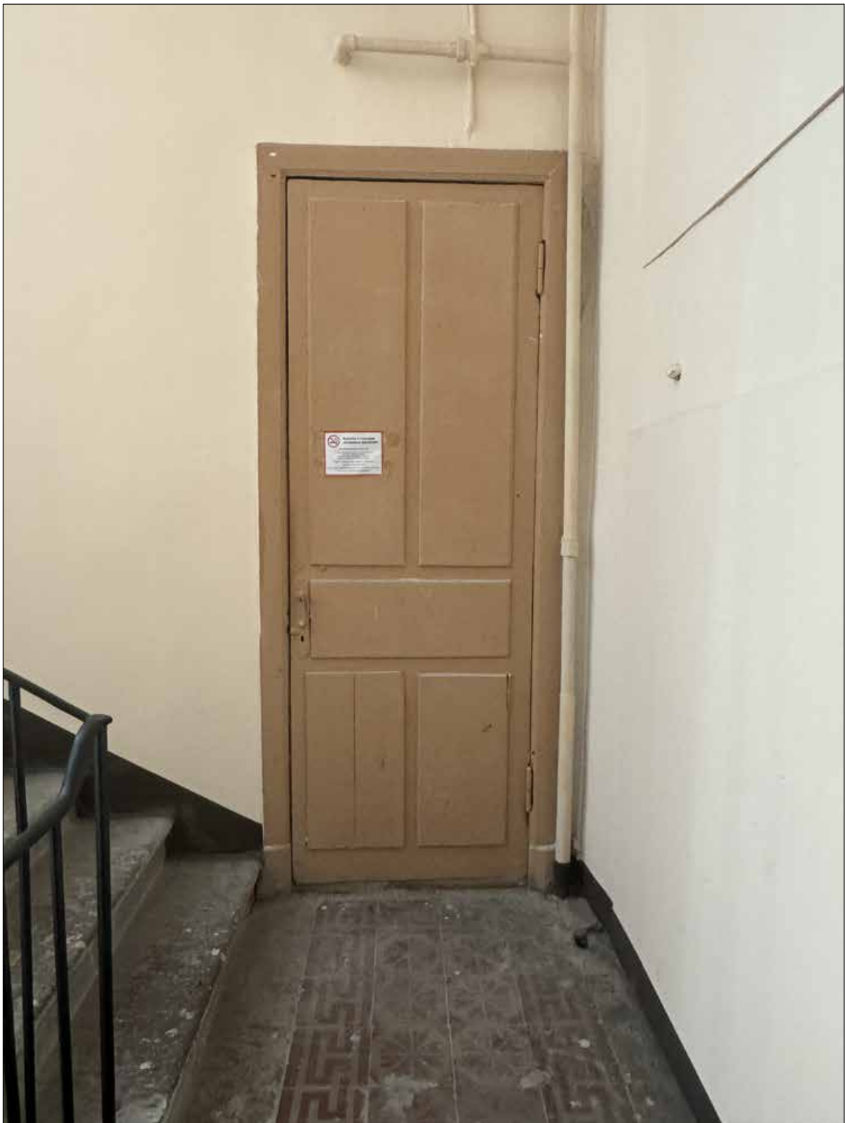
23. «Чёрная» лестница (Л-12). Сохранившаяся историческая входная дверь*.
