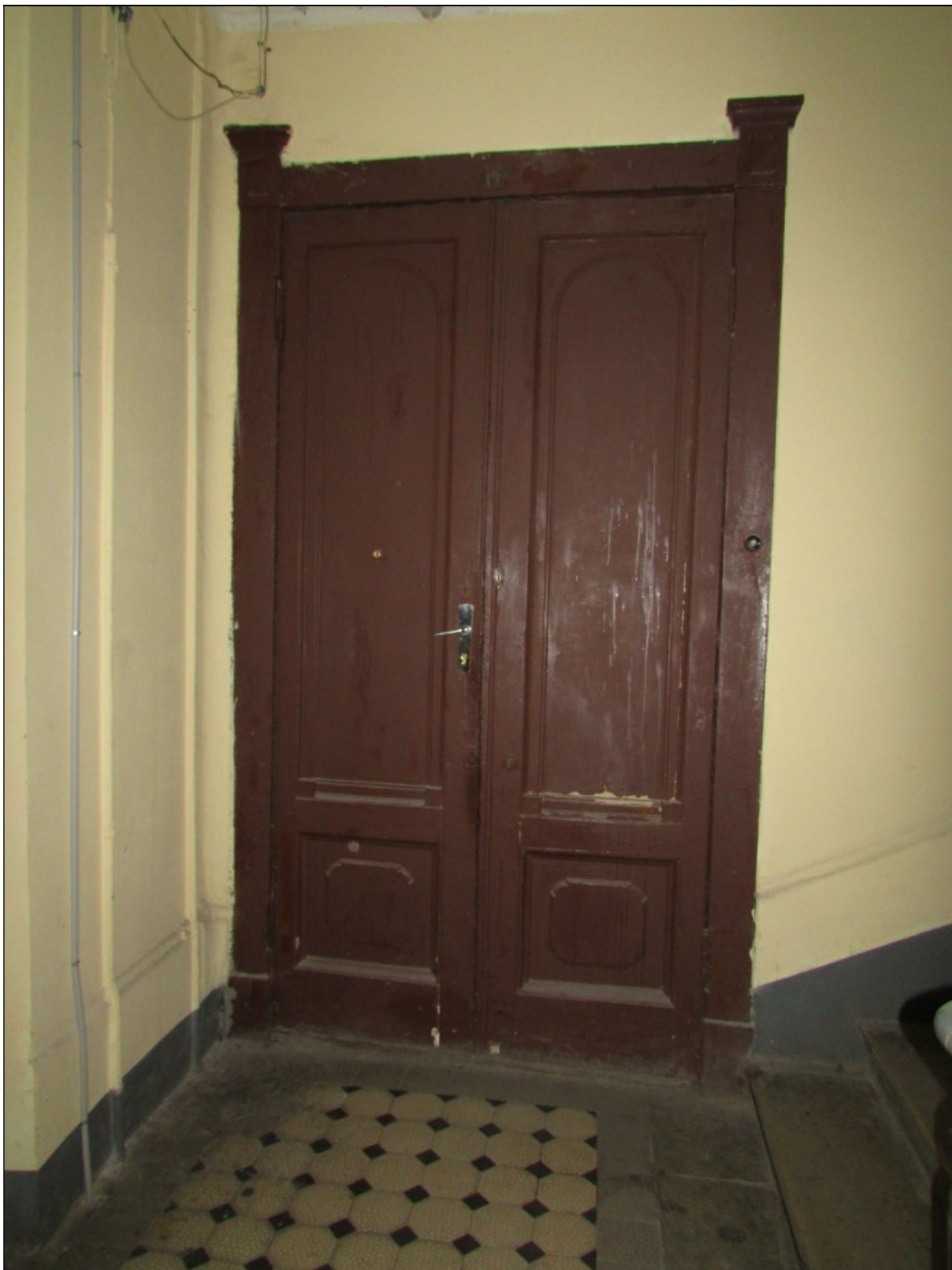
8. Парадная лестница (Л-1). Сохранившаяся историческая входная дверь*.
