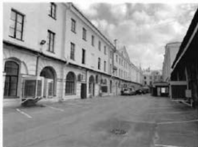
11. Общий вид на дворовый фасад одноэтажного юго-восточного корпуса.
