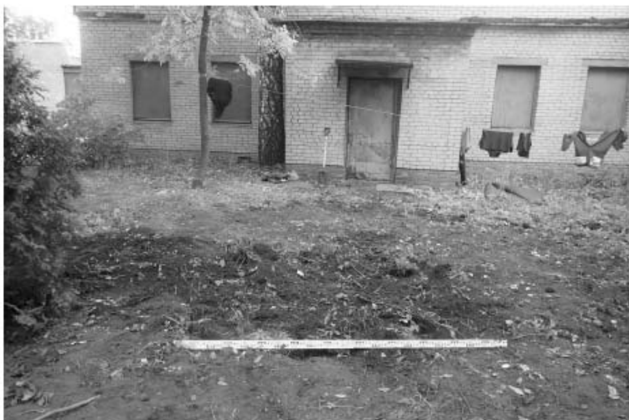
Илл. 40. г. Санкт-Петербург. ул. Коли Томчака, д. 21, литера В, кад. № 78:14:0007532:30. Шурф №1. Рекультивация. Вид с юга.
