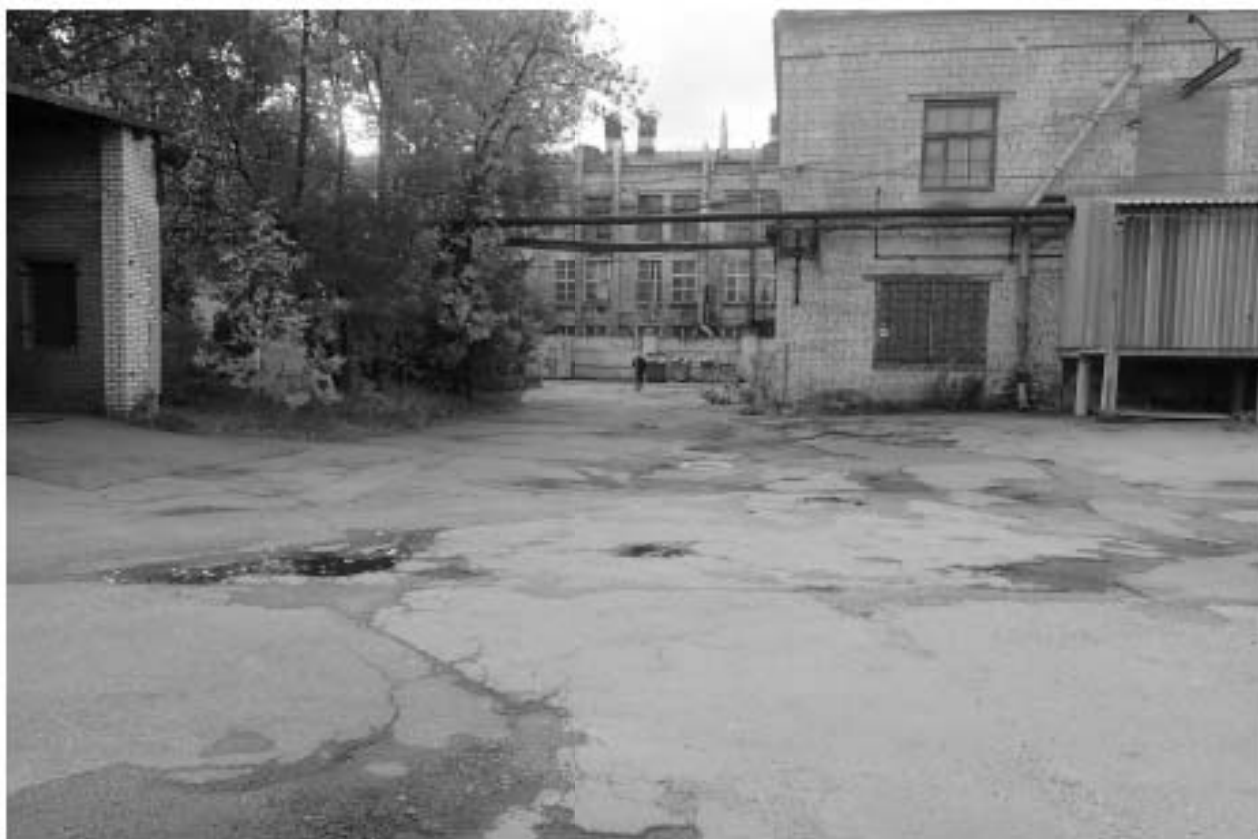
Илл. 20. г. Санкт-Петербург: ул. Коли Томчака, д. 21, литера В, кад. №78:14:0007532:30. Точка фотофиксации №2. Общий вид на южную часть испрашиваемого участка. Вид с севера.
