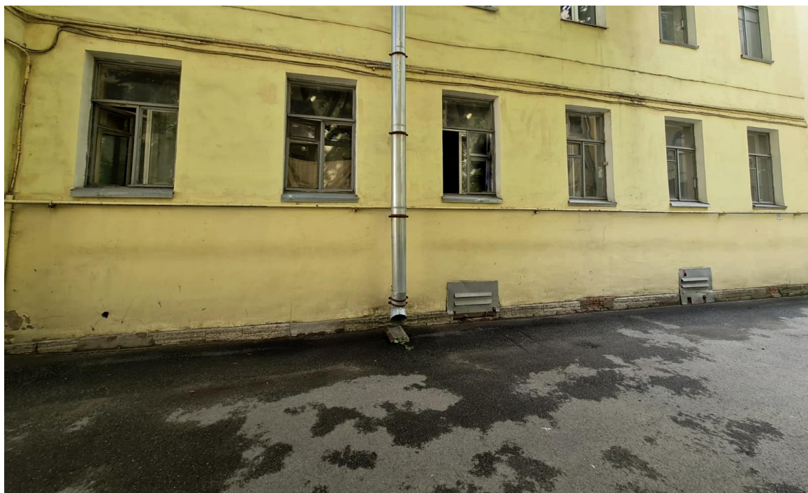
Фото 3.Фрагмент дворового фасада объекта культурного наследия федерального значения «Дом, где жили: в 1855-1858 гг. – композитор Чайковский П.И., в 1861-1914 гг. – географ Семенов-Тян-Шанский П.П., в 1851-1881 гг. – экономист Заблоцкий-Десятовский А.П.»
