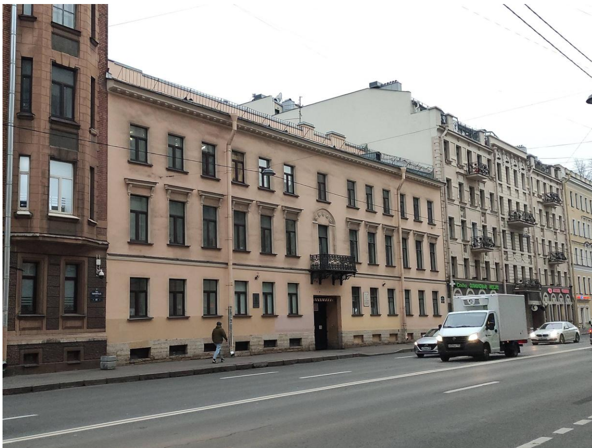
Фото 1. Общий вид объекта культурного наследия федерального значения «Дом, где жили: в 1855-1858 гг. – композитор Чайковский П.И., в 1861-1914 гг. – географ Семенов-Тян-Шанский П.П., в 1851-1881 гг. – экономист Заблоцкий-Десятовский А.П.»
