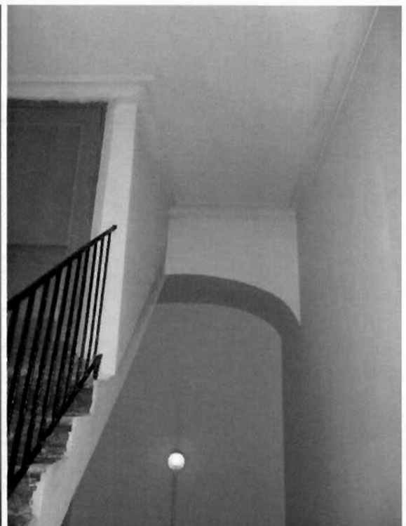
13. Николаевская гимназия (черная лестница и выход на чердак)
