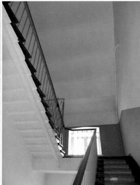
17. Лазарет (лестница 8-ЛК, перекрытия)
