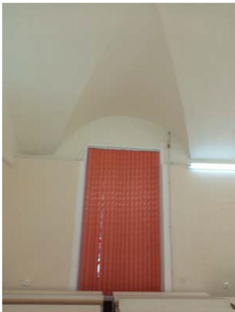
37. Объект культурного наследия федерального значения «Здание Двенадцати Коллегий», расположенный по адресу: г. Санкт-Петербург, Университетская наб., д.7-9-11, литера А, входящий в состав объекта культурного наследия федерального значения «Императорский Санкт-Петербургский университет» по адресу: г. Санкт-Петербург, Университетская наб., д.7-9, Менделеевская линия, д. 2. Помещение №32. Фрагмент интерьера.
