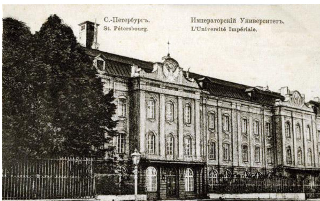
18. Здание Двенадцати Коллегий. Императорский Санкт-Петербургский Университет. Главный фасад. Фрагмент. Начало XX в. Фотооткрытка.
