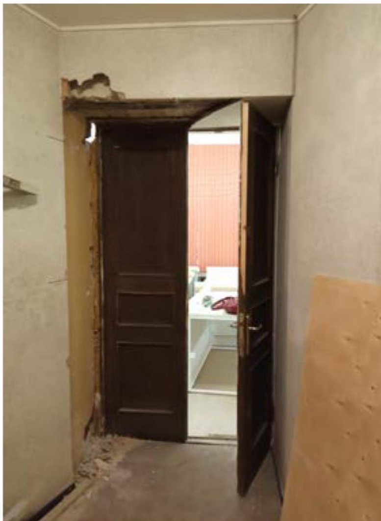
4. Объект культурного наследия федерального значения «Здание Двенадцати Коллегий», расположенный по адресу: г. Санкт-Петербург, Университетская наб., д.7-9-11, литера А, входящий в состав объекта культурного наследия федерального значения «Императорский Санкт-Петербургский университет» по адресу: г. Санкт-Петербург, Университетская наб., д.7-9, Менделеевская линия, д. 2. Помещение №22. Фрагмент интерьера. Дверной проем. Заполнение.
