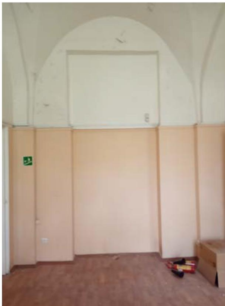
7. Объект культурного наследия федерального значения «Здание Двенадцати Коллегий», расположенный по адресу: г. Санкт-Петербург, Университетская наб., д.7-9-11, литера А, входящий в состав объекта культурного наследия федерального значения «Императорский Санкт-Петербургский университет» по адресу: г. Санкт-Петербург, Университетская наб., д.7-9, Менделеевская линия, д. 2. Помещение №23.2. Фрагмент интерьера. Зашитый проем.
