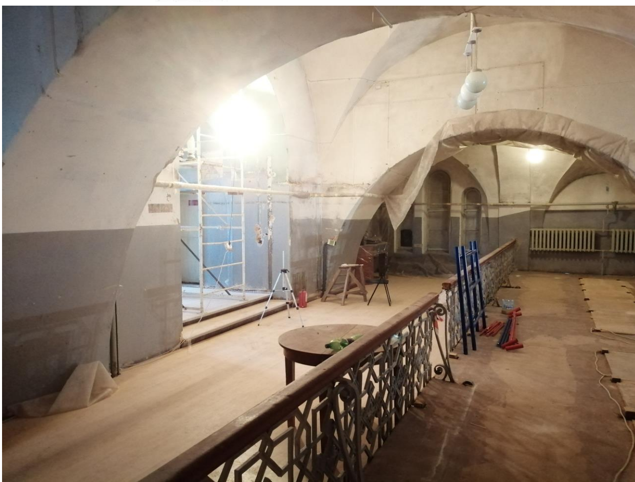
Фото 21. Объект культурного наследия регионального значения «Подворье Старо-Афонского Свято-Андреевского мужского скита» по адресу: Санкт-Петербург, 5-я Советская ул., д. 31-33, лит. А — церковь Благовещения Пресвятой Богородицы. Фрагмент интерьера 2 этажа антресоли, пом. № 1-Н(26).
