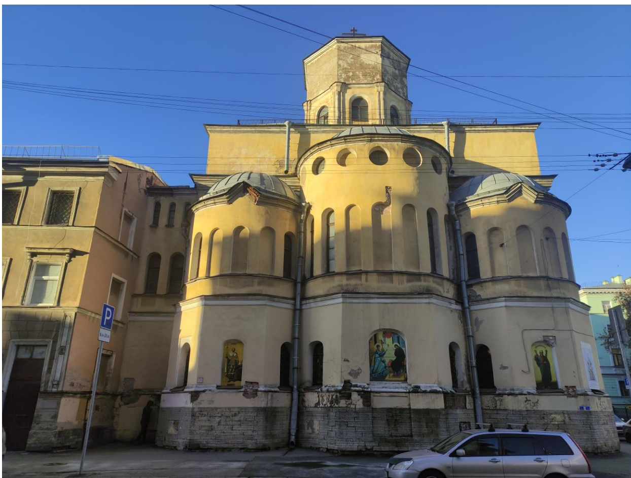
Фото 3. Объект культурного наследия регионального значения «Подворье Старо-Афонского Свято-Андреевского мужского скита» по адресу: Санкт-Петербург, 5-я Советская ул., д. 31-33, лит. А — церковь Благовещения Пресвятой Богородицы. Между зданием церкви и флигелем для монахов имеется переходная галерея с оконными проемами в уровне второго и третьего этажей. Проемы с полуциркульными завершениями идентичными проемам на абсидах.
