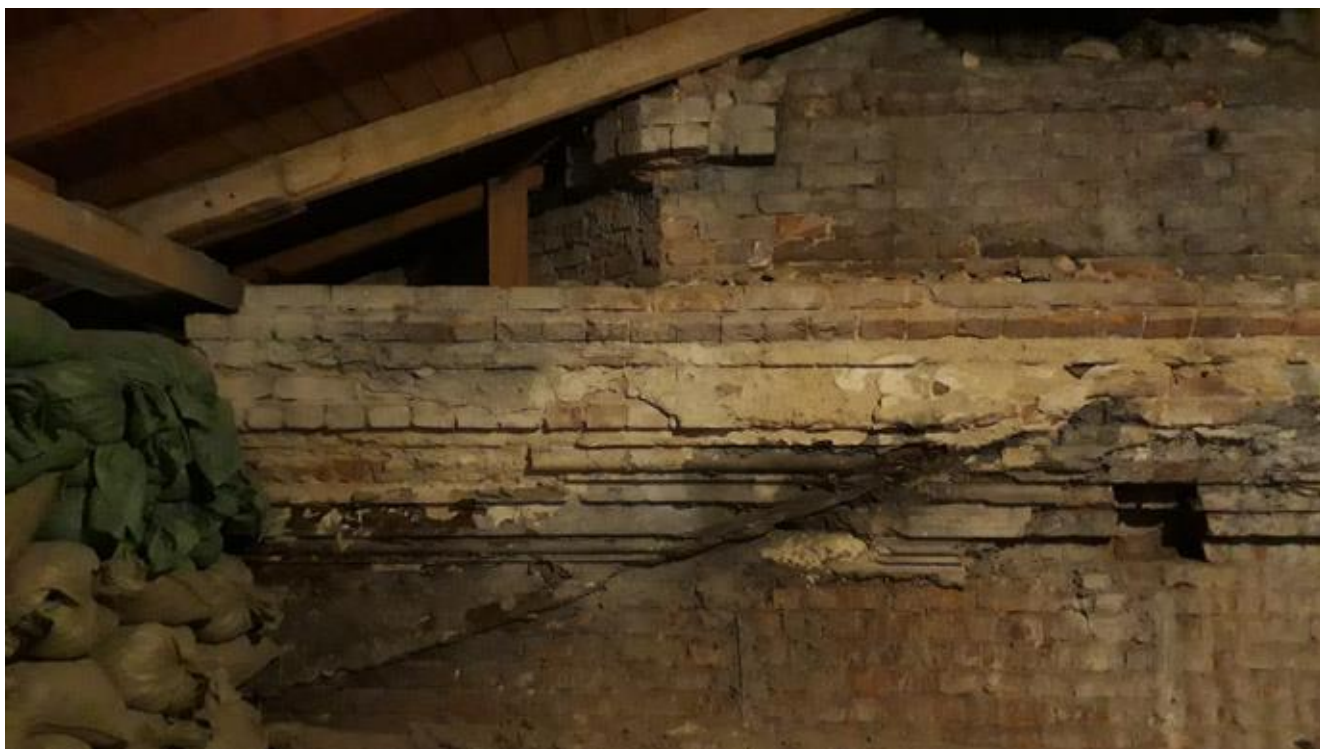
Фото 19. Объект культурного наследия регионального значения «Подворье Старо-Афонского Свято-Андреевского мужского скита» по адресу: Санкт-Петербург, 5-я Советская ул., д. 31-33, лит. А — церковь Благовещения Пресвятой Богородицы. Пространство чердака (надстроенный третий этаж). Вид на центральный восьмигранник с сохранившимися фрагментами венчающего карниза. Сохранилось гнездо коньковой балки и скат кровли.
