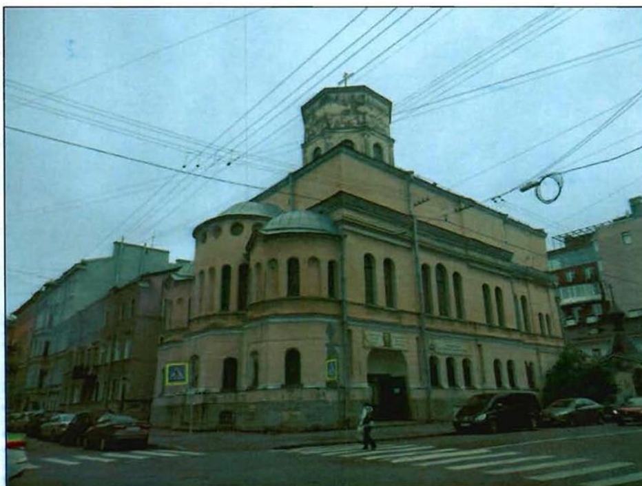
1. Общий вид с северо-востока.
