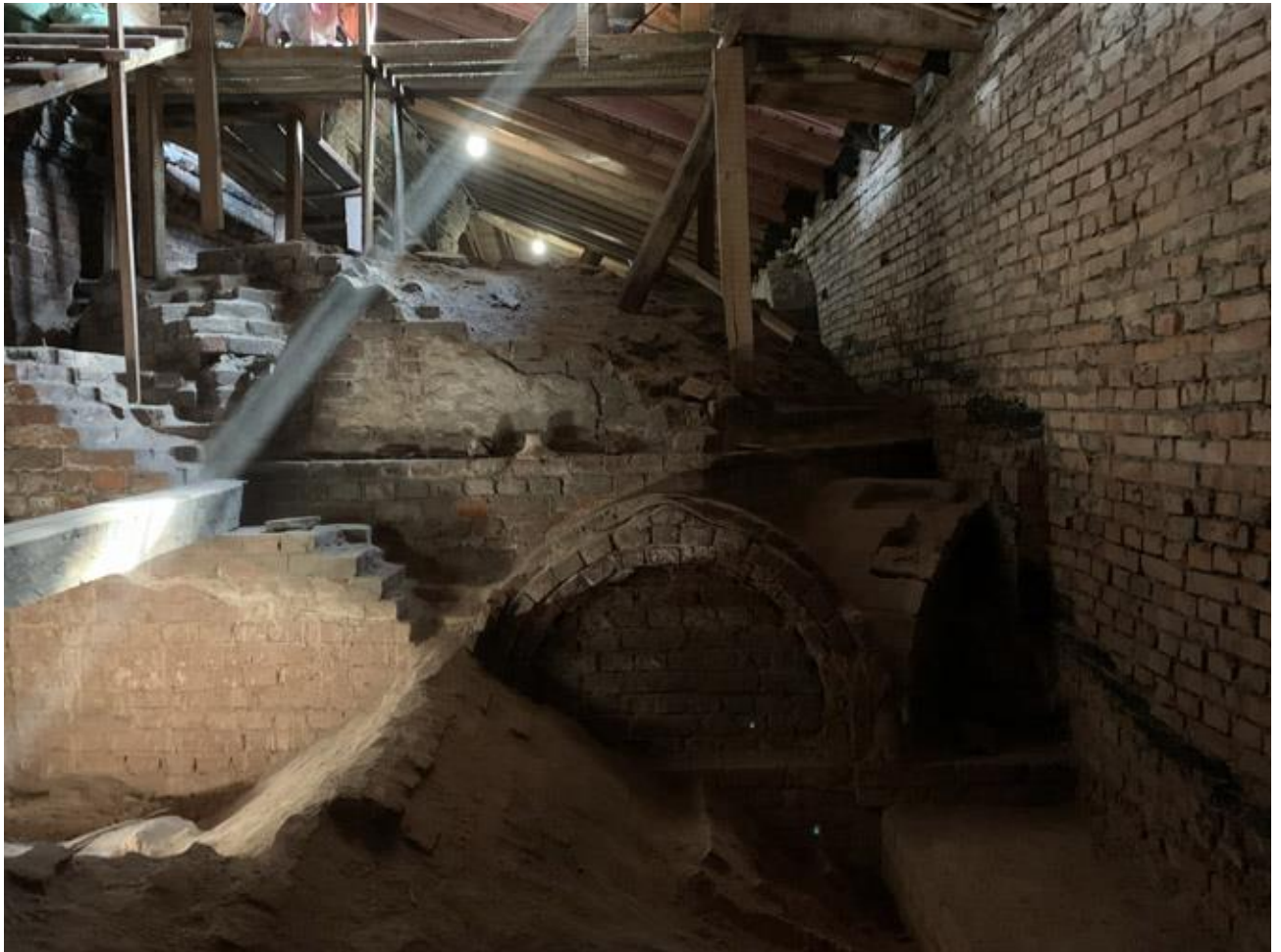
Фото 22. Объект культурного наследия регионального значения «Подворье Старо-Афонского Свято-Андреевского мужского скита» по адресу: Санкт-Петербург, 5-я Советская ул., д. 31-33, лит. А — церковь Благовещения Пресвятой Богородицы. Пространство чердака (надстроенный третий этаж). Вид со стороны юго-западного среднего барабана на центральный восьмерик и закомары. Кирпичная стена возведена в 1960-е гг.
