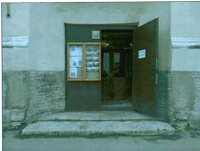
4. Северный фасад. Крыльцо.
