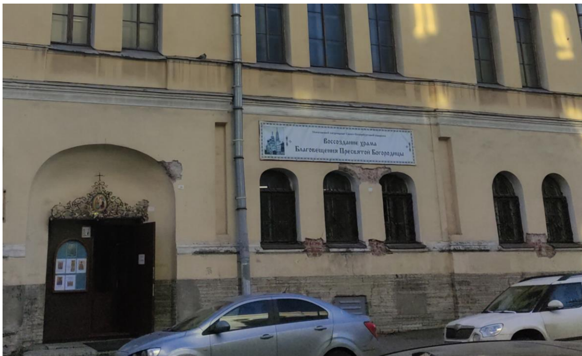
Фото 8. Объект культурного наследия регионального значения «Подворье Старо-Афонского Свято-Андреевского мужского скита» по адресу: Санкт-Петербург, 5-я Советская ул., д. 31-33, лит. А — церковь Благовещения Пресвятой Богородицы. Вход с 5-й Советской улицы. Оконные проемы с полуциркульными завершениями. Выполненные зондажи показывают стесанные полуколонки.
