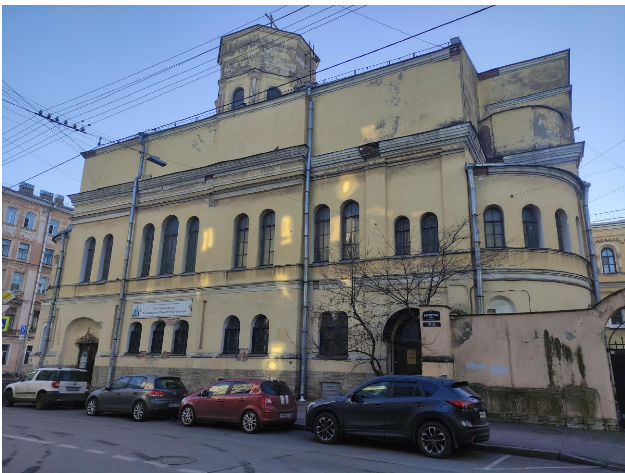
Фото 7. Объект культурного наследия регионального значения «Подворье Старо-Афонского Свято-Андреевского мужского скита» по адресу: Санкт-Петербург, 5-я Советская ул., д. 31-33, лит. А - церковь Благовещения Пресвятой Богородицы. Со стороны 5-й Советской улицы сохранился фрагмент кирпичной стенки утраченного крыльца и ограды.
