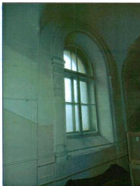
7. Центральный оконный проем парадной лестницы.
