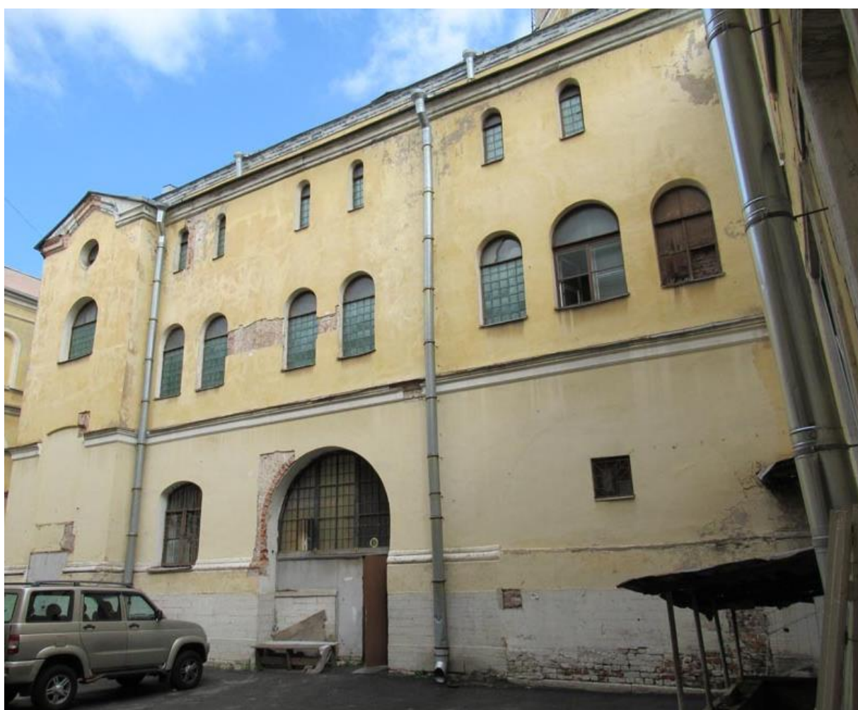
Фото 14. Объект культурного наследия регионального значения «Подворье Старо-Афонского Свято-Андреевского мужского скита» по адресу: Санкт-Петербург, 5-я Советская ул., д. 31-33, лит. А — церковь Благовещения Пресвятой Богородицы. Вид со стороны двора на южный фасад здания. На первом этаже находилась открытая галерея для выхода на Дегтярную улицу (в настоящее время вторая арка заложена).
