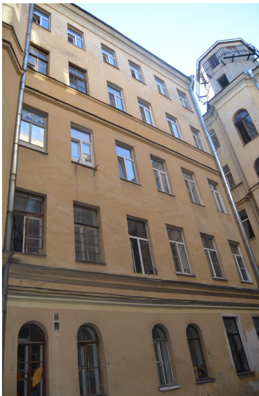
14. Выявленный объект культурного наследия «Дом Сироткиных». Юго-западный дворовый флигель. Вид с востока. Съемка 26.04.2021
