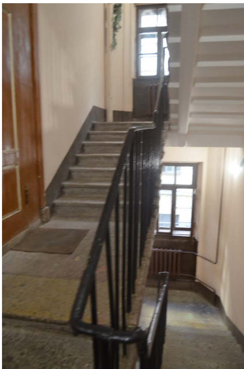
37. Выявленный объект культурного наследия «Дом Сироткиных». Лестница южного дворового флигеля (Л2). Конструкции лестничных маршей в уровне третьего этажа. Вид с северо-востока. Съемка 26.04.2021
