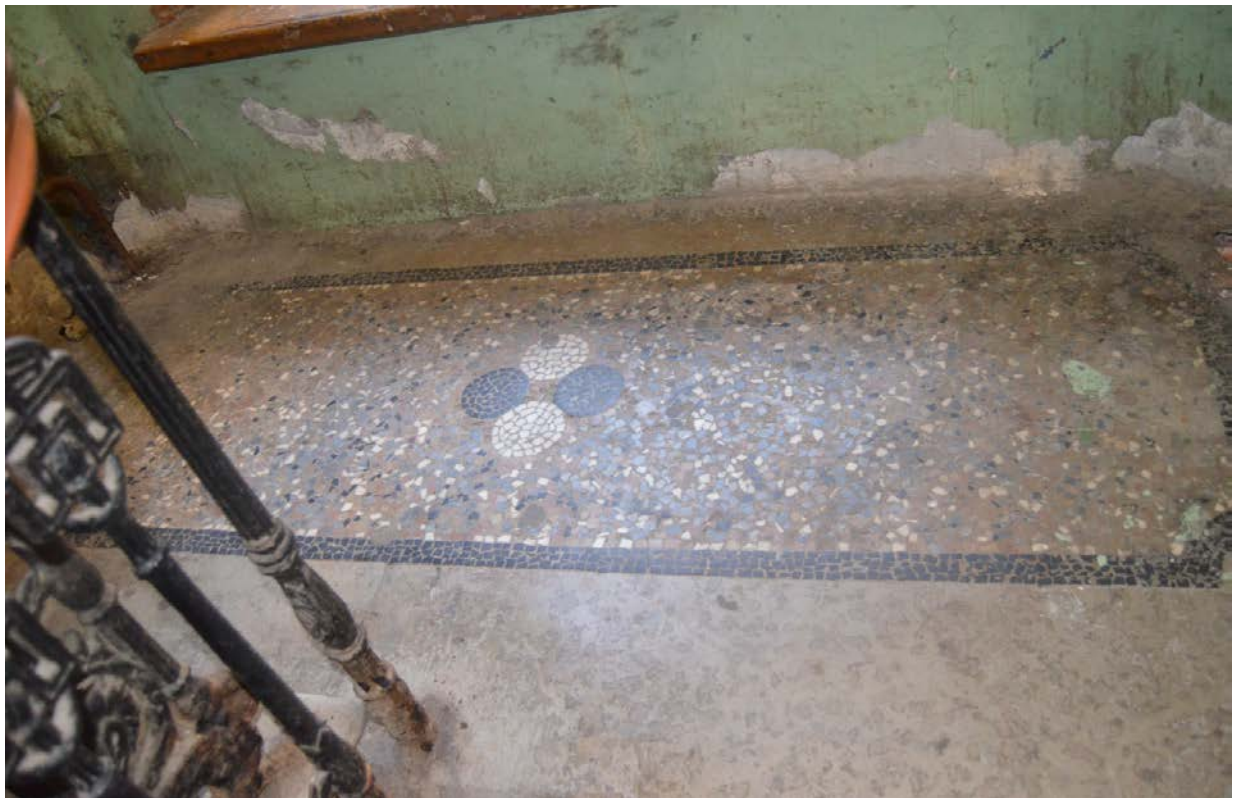
44. Выявленный объект культурного наследия «Дом Сироткиных». Лестница юго-восточного дворового флигеля (ЛЗ). Мозаичное оформление пола межэтажной площадки между первым и вторым этажами. Вид с юго-востока. Съемка 26.04.2021.
