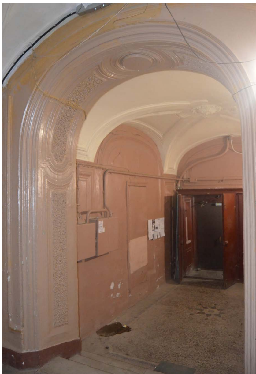
21. Выявленный объект культурного наследия «Дом Сироткиных». Парадная лестница (Л1). Оформление арки между вестибюлем и лестничной клеткой. Вид с юго-востока. Съемка 26.04.2021
