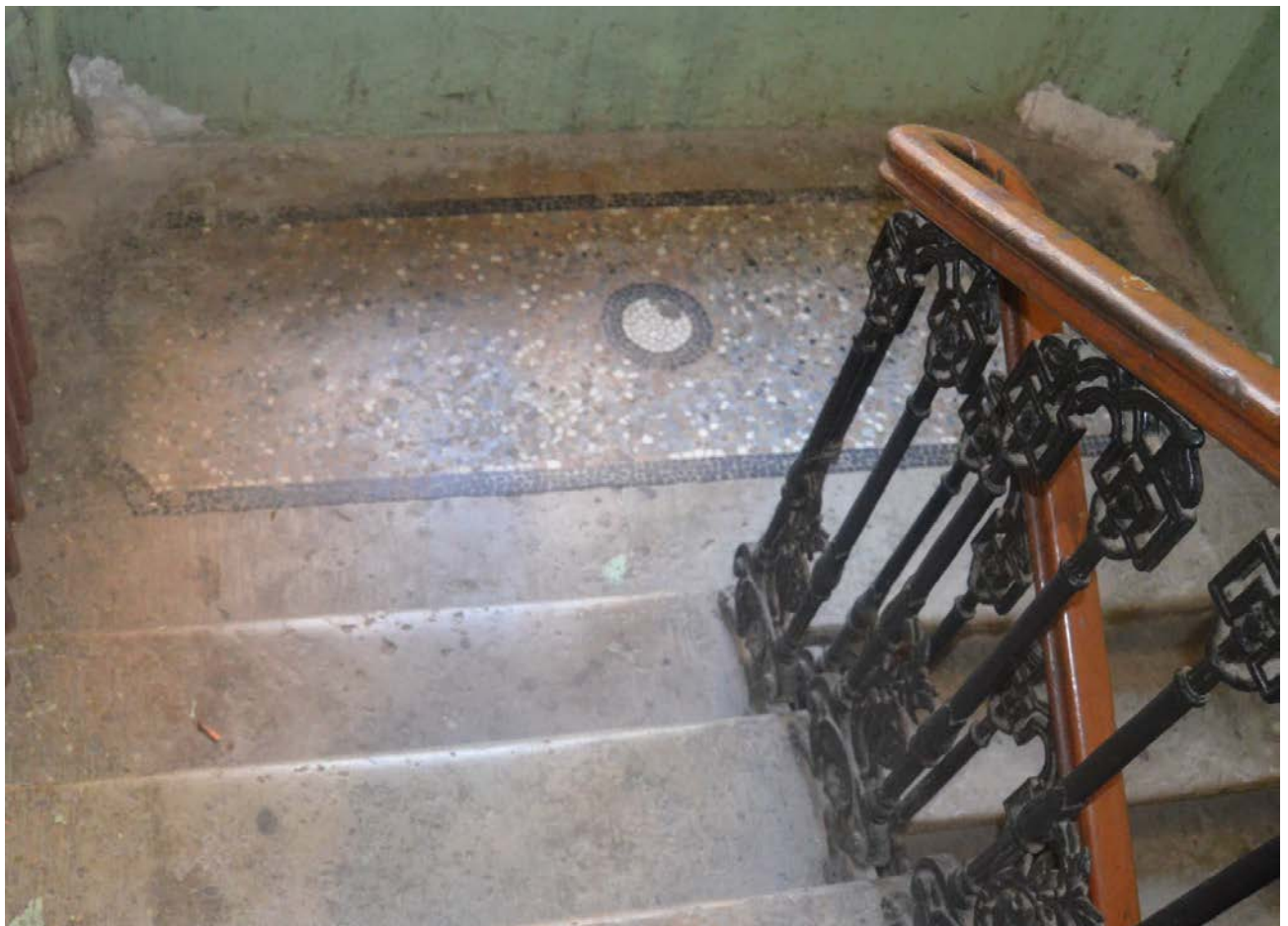
46. Выявленный объект культурного наследия «Дом Сироткиных». Лестница юго-восточного дворового флигеля (ЛЗ). Мозаичное оформление пола межэтажной площадки между вторым и третьим этажами. Вид с юго-востока. Съемка 26.04.2021.
