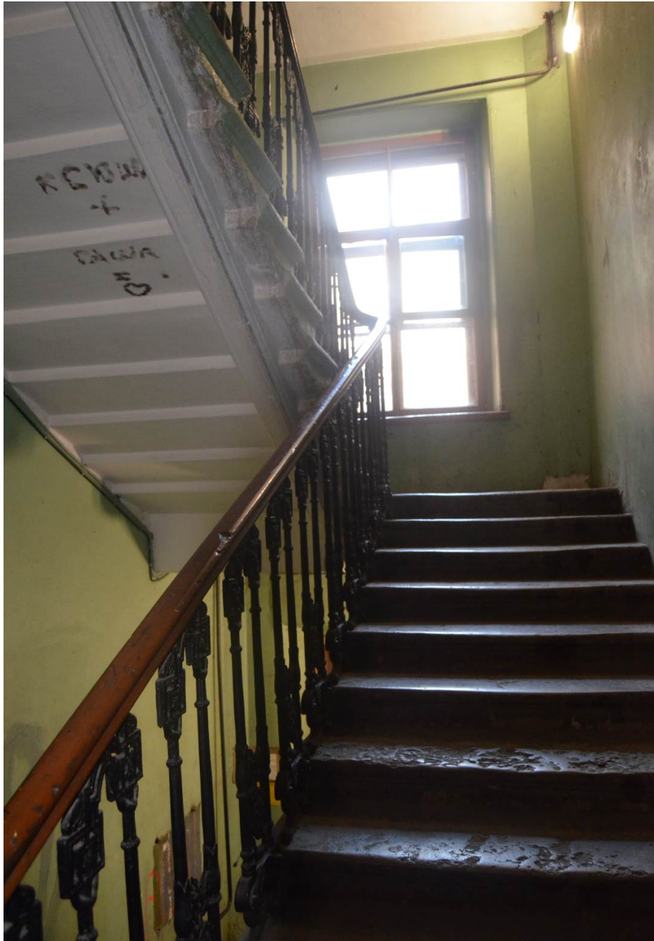
45. Выявленный объект культурного наследия «Дом Сироткиных». Лестница юго-восточного дворового флигеля (ЛЗ). Конструкция лестничных маршей. Вид с юго-востока. Съемка 26.04.2021.
