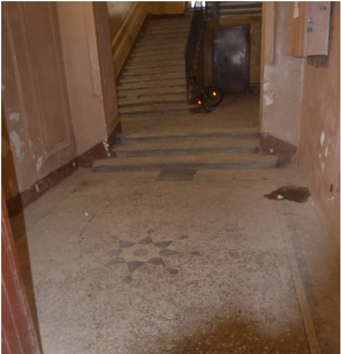
22. Выявленный объект культурного наследия «Дом Сироткиных». Парадная лестница (Л1). Общий вид вестибюля. Вид с северо-запада. Съемка 26.04.2021
