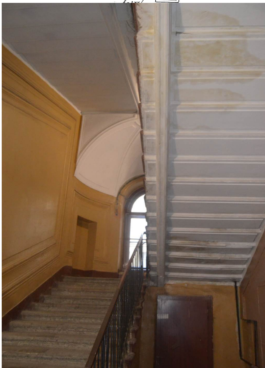
28. Выявленный объект культурного наследия «Дом Сироткиных». Парадная лестница (Л1). Оформление стен объема лестничной клетки. Вид с северо-запада. Съемка 26.04.2021
