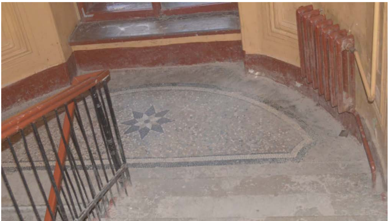
30. Выявленный объект культурного наследия «Дом Сироткиных». Парадная лестница (Л1). Мозаичная отделка пола межэтажной площадки между первым и вторым этажами. Вид с запада. Съемка 26.04.2021
