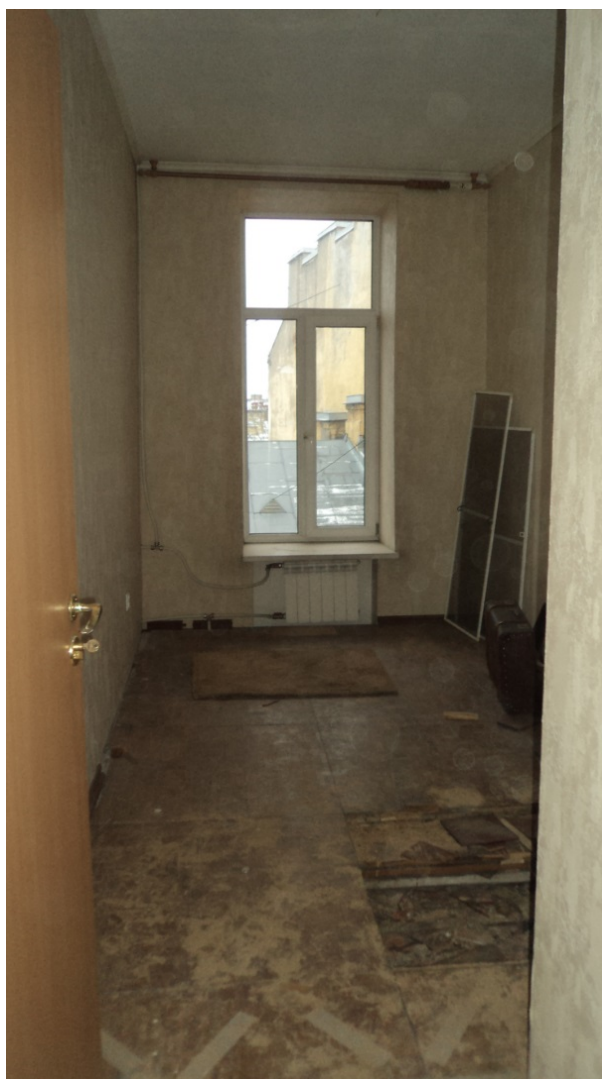
21. Выявленный объект культурного наследия «Дом П.Н. Батуева» (г. Санкт-Петербург, Грибоедова кан.наб., д. 144). Помещение квартиры № 16.
