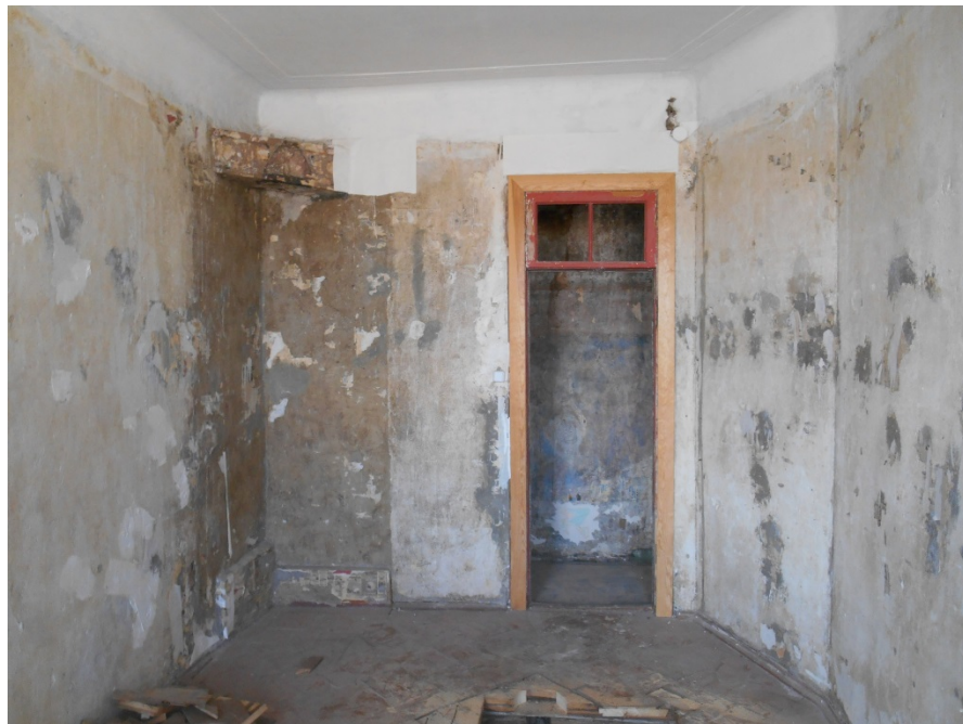
35. Выявленный объект культурного наследия «Дом П.Н. Батуева» (г. Санкт-Петербург, Грибоедова кан.наб., д. 144). Помещение квартиры № 17.
