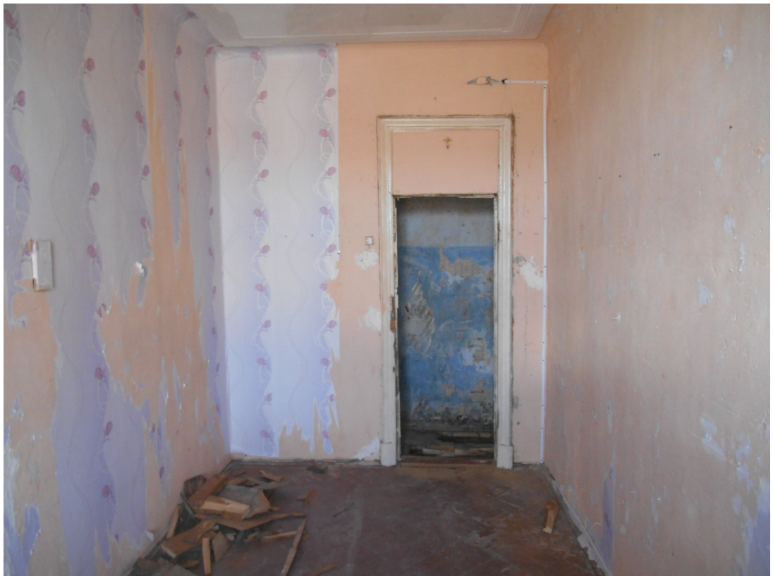
34. Выявленный объект культурного наследия «Дом П.Н. Батуева» (г. Санкт-Петербург, Грибоедова кан.наб., д. 144). Помещение квартиры № 17.
