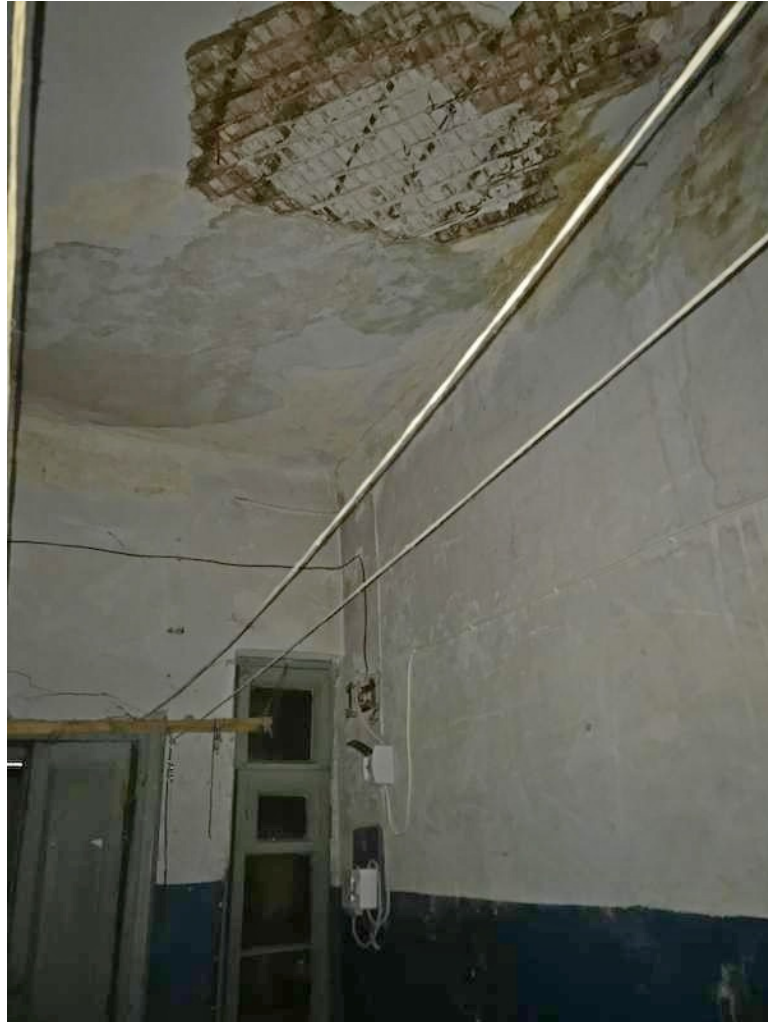
38. Выявленный объект культурного наследия «Дом П.Н. Батуева» (г. Санкт-Петербург, Грибоедова кан.наб., д. 144). Помещение квартиры № 17.
