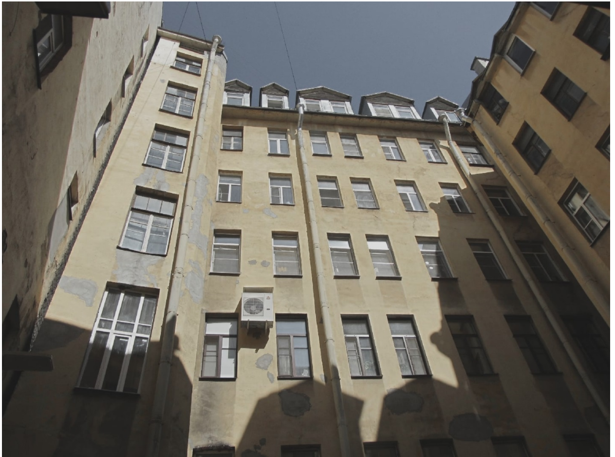
5. Выявленный объект культурного наследия «Дом П.Н. Батуева» (г. Санкт-Петербург, Грибоедова кан.наб., д. 144). Дворовый фасад.
