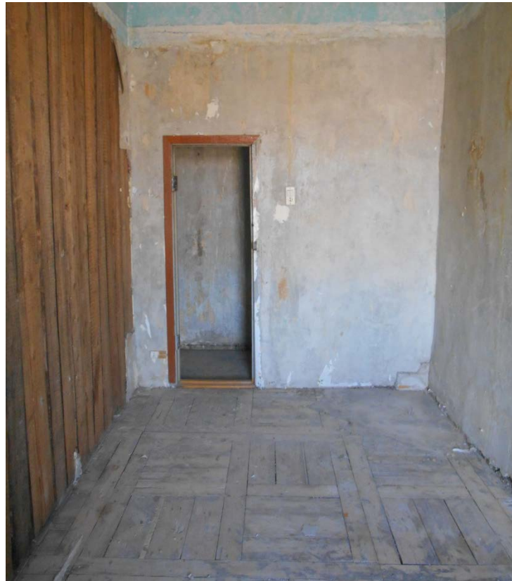
31. Выявленный объект культурного наследия «Дом П.Н. Батуева» (г. Санкт-Петербург, Грибоедова кан.наб., д. 144). Помещение квартиры № 17.
