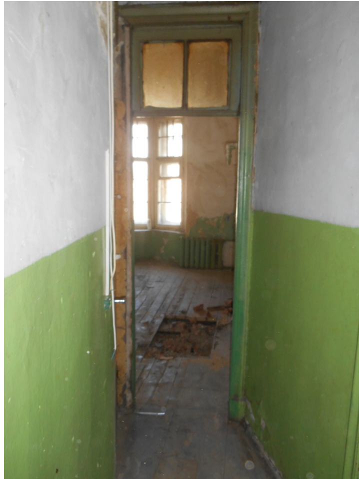
36. Выявленный объект культурного наследия «Дом П.Н. Батуева» (г. Санкт-Петербург, Грибоедова кан.наб., д. 144). Помещение квартиры № 17.
