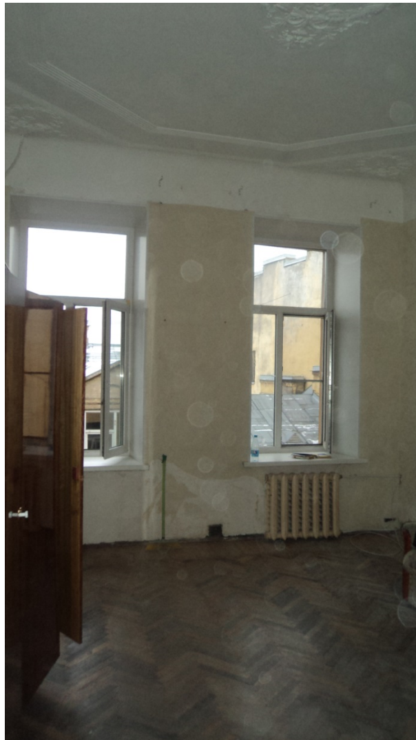
19. Выявленный объект культурного наследия «Дом П.Н. Батуева» (г. Санкт-Петербург, Грибоедова кан.наб., д. 144). Помещение квартиры № 16.
