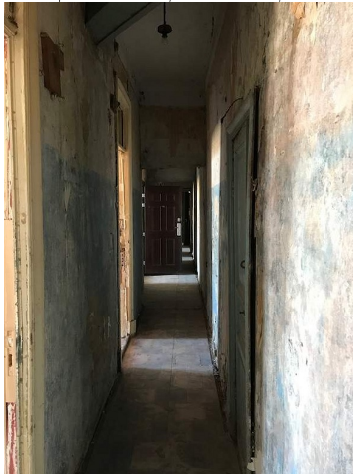
30. Выявленный объект культурного наследия «Дом П.Н. Батуева» (г. Санкт-Петербург, Грибоедова кан.наб., д. 144). Помещение квартиры № 17.
