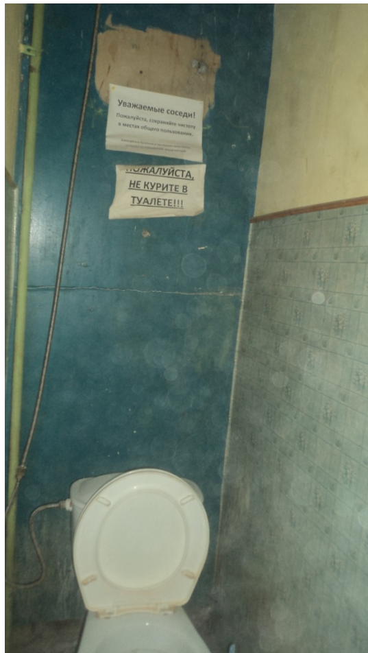
40. Выявленный объект культурного наследия «Дом П.Н. Батуева» (г. Санкт-Петербург, Грибоедова кан.наб., д. 144). Помещение квартиры № 17.
