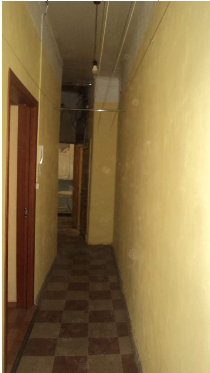
25. Выявленный объект культурного наследия «Дом П.Н. Батуева» (г. Санкт-Петербург, Грибоедова кан.наб., д. 144). Помещение квартиры № 16.
