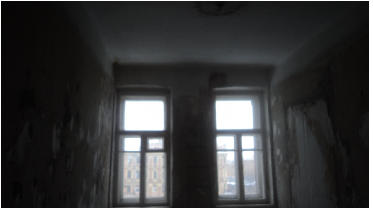
43. Выявленный объект культурного наследия «Дом П.Н. Батуева» (г. Санкт-Петербург, Грибоедова кан.наб., д. 144). Помещение квартиры № 17.
