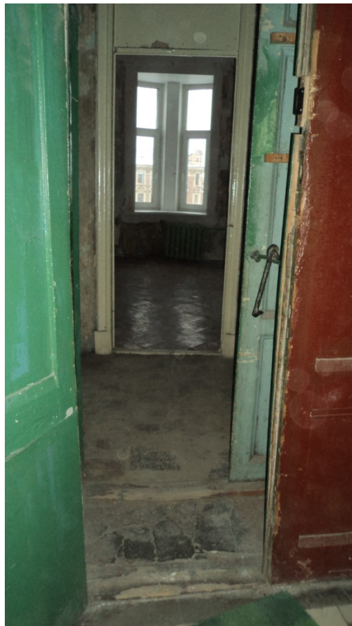
39. Выявленный объект культурного наследия «Дом П.Н. Батуева» (г. Санкт-Петербург, Грибоедова кан.наб., д. 144). Помещение квартиры № 17.
