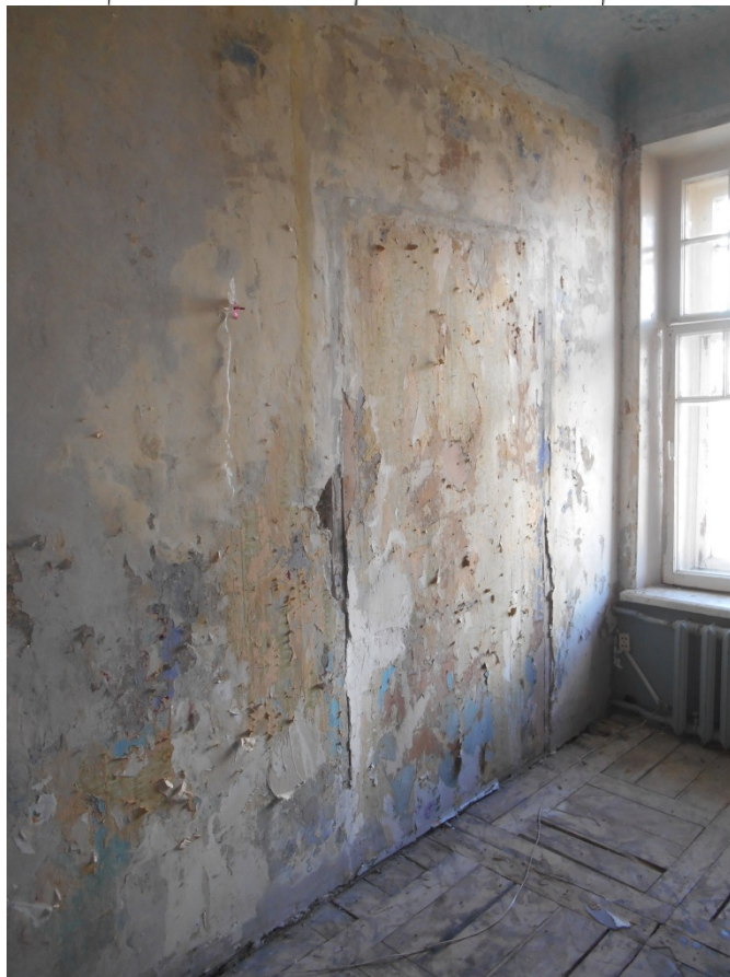
32. Выявленный объект культурного наследия «Дом П.Н. Батуева» (г. Санкт-Петербург, Грибоедова кан.наб., д. 144). Помещение квартиры № 17.
