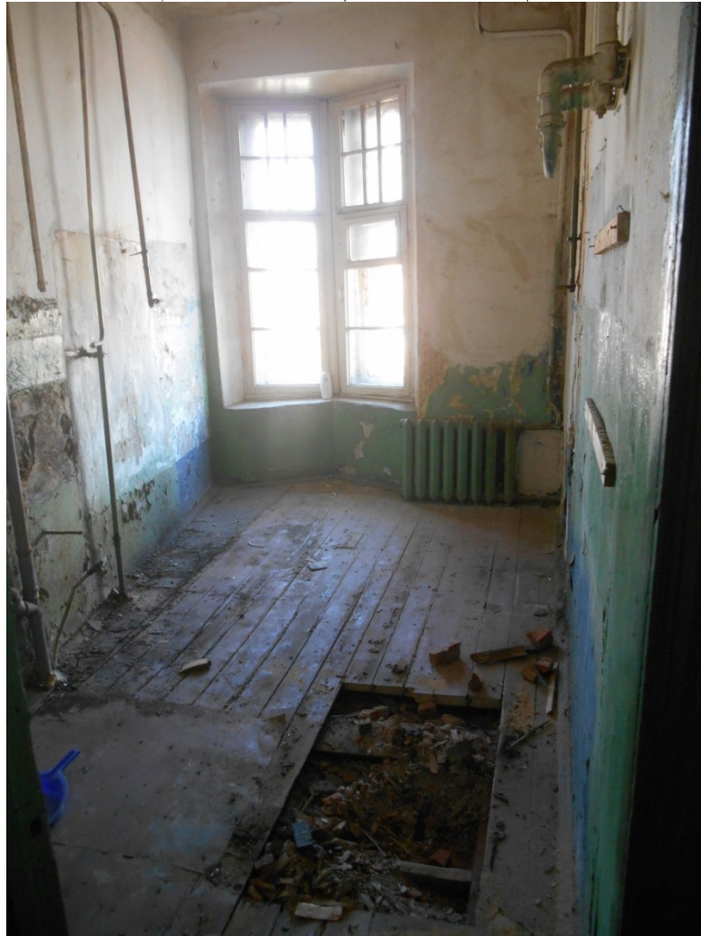
37. Выявленный объект культурного наследия «Дом П.Н. Батуева» (г. Санкт-Петербург, Грибоедова кан.наб., д. 144). Помещение квартиры № 17.
