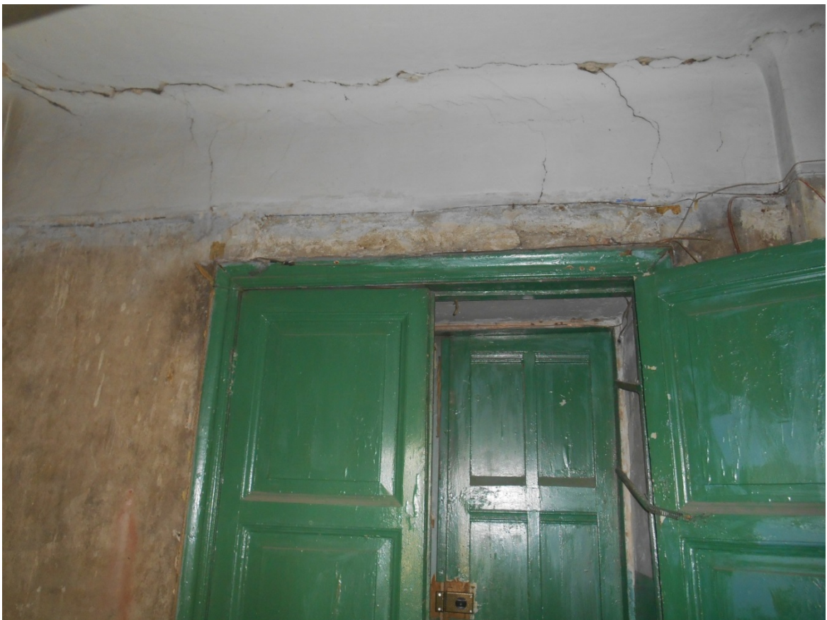
27. Выявленный объект культурного наследия «Дом П.Н. Батуева» (г. Санкт-Петербург, Грибоедова кан.наб., д. 144). Помещение квартиры № 17.
