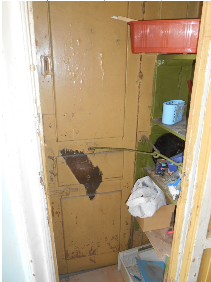
13. Выявленный объект культурного наследия «Дом П.Н. Батуева» (г. Санкт-Петербург, Грибоедова кан.наб., д. 144). Помещение квартиры № 16.
