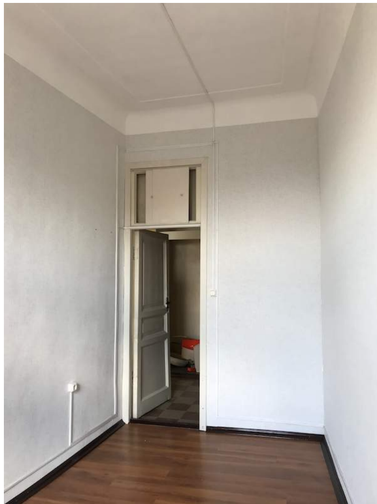
10. Выявленный объект культурного наследия «Дом П.Н. Батуева» (г. Санкт-Петербург, Грибоедова кан.наб., д. 144). Помещение квартиры № 16.
