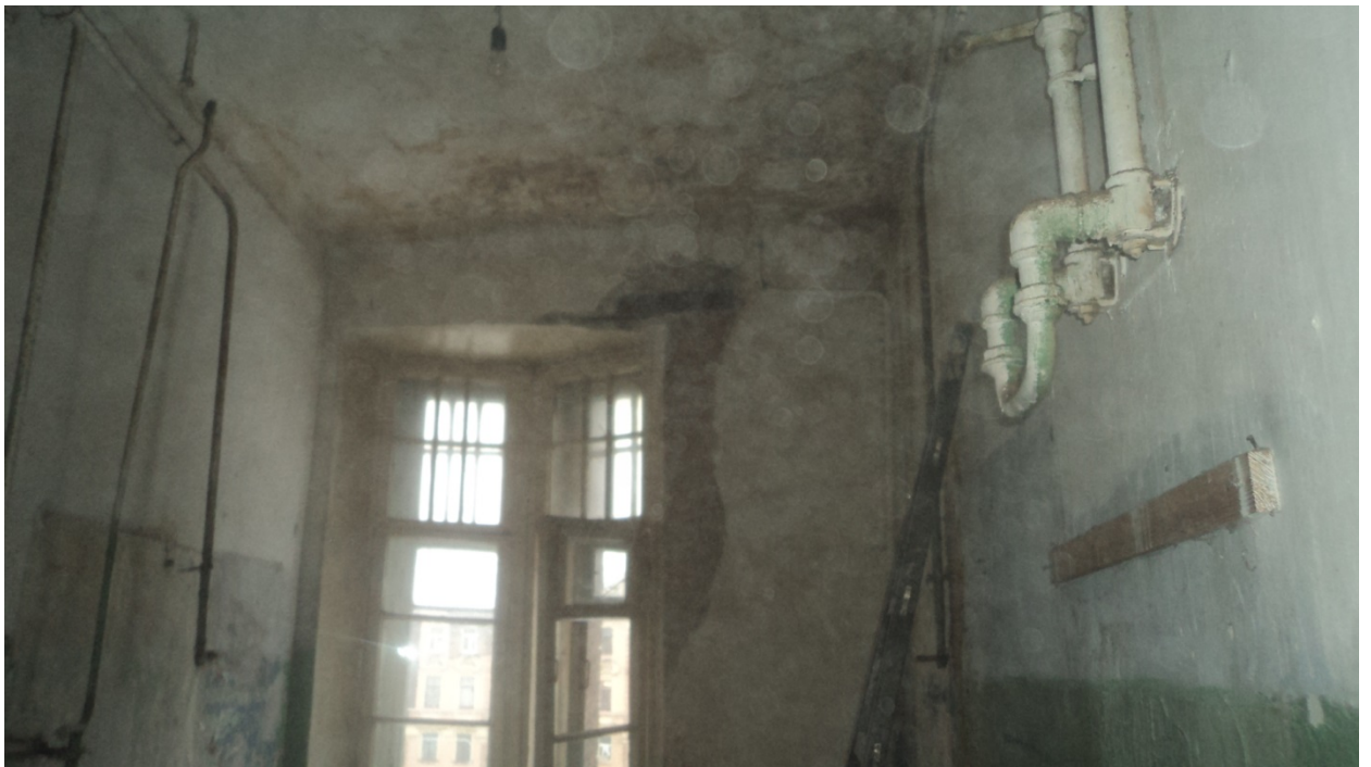
42. Выявленный объект культурного наследия «Дом П.Н. Батуева» (г. Санкт-Петербург, Грибоедова кан.наб., д. 144). Помещение квартиры № 17.
