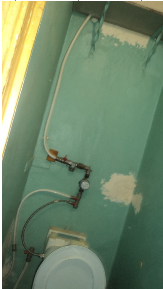
24. Выявленный объект культурного наследия «Дом П.Н. Батуева» (г. Санкт-Петербург, Грибоедова кан.наб., д. 144). Помещение квартиры № 16.
