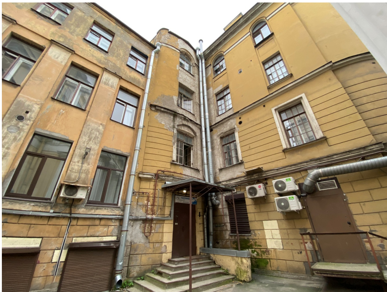
Фото 4. Общий вид дворового фасада.
