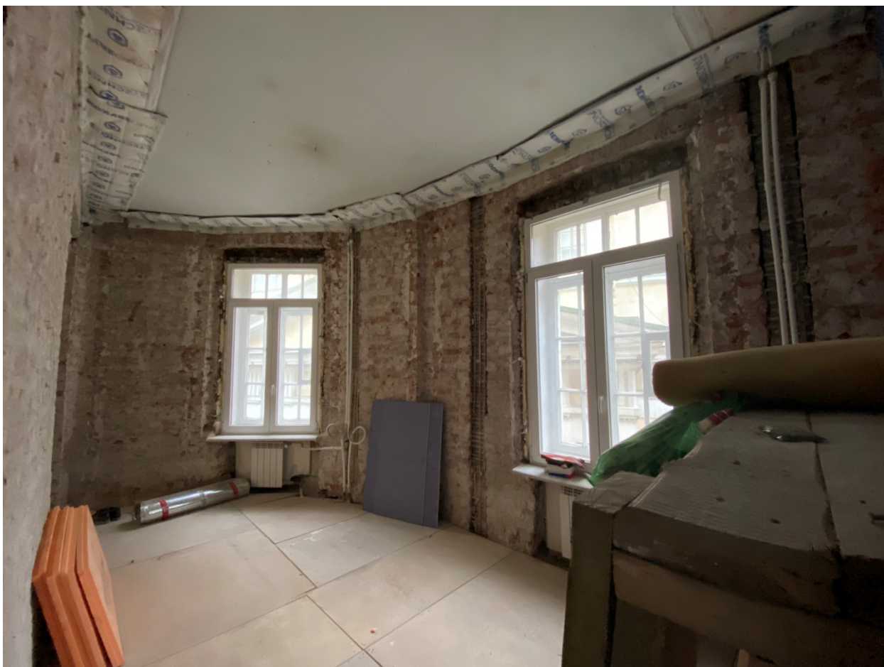
Фото 19. Северо-западное помещение, оконные проемы.
