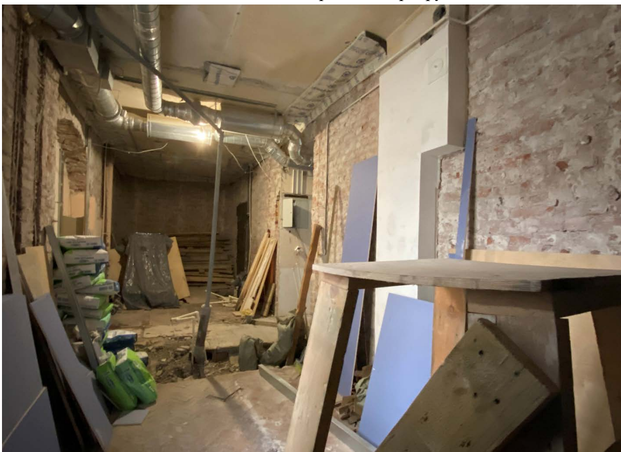
Фото 10. Вид вдоль северной стены.
