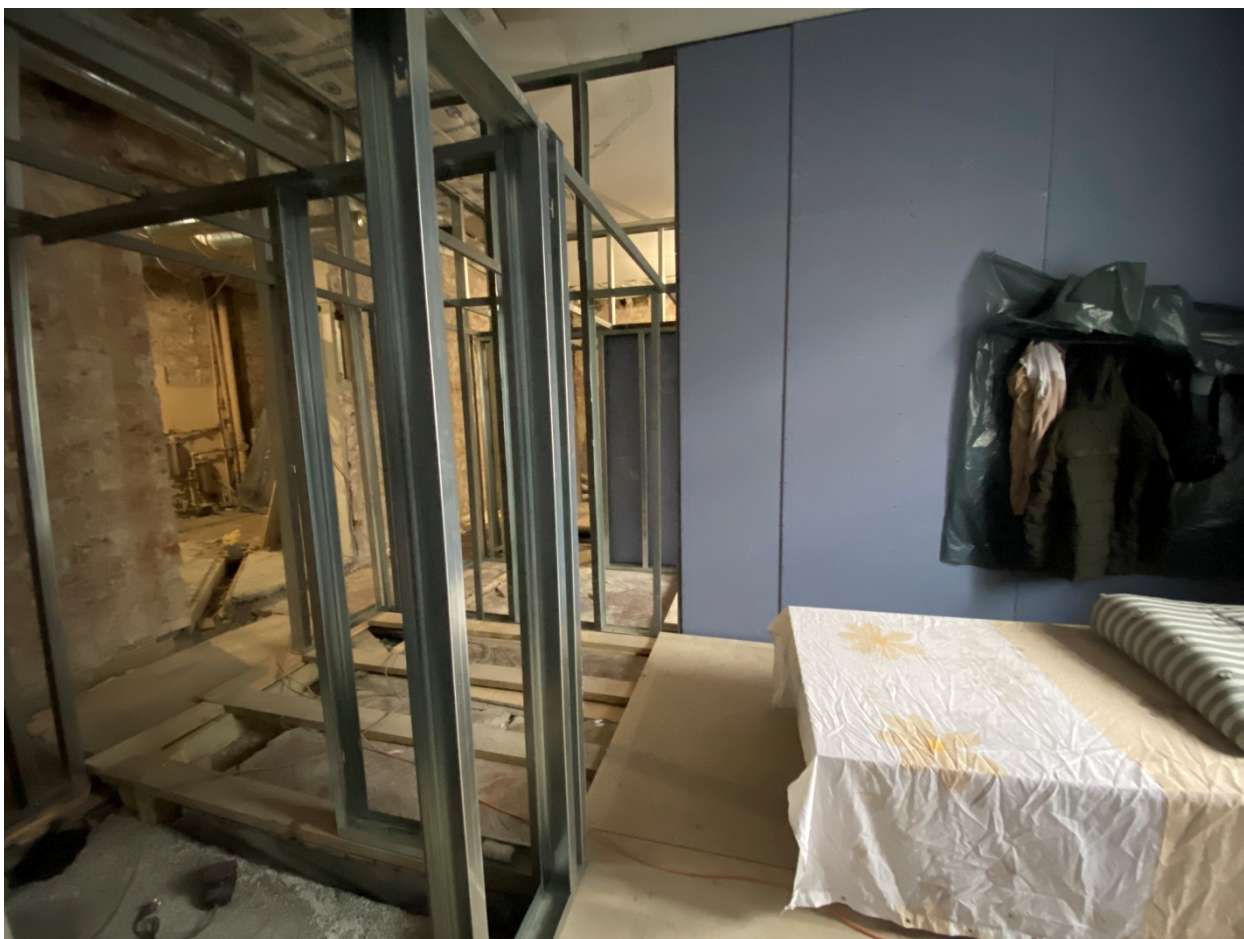
Фото 15. Помещение у южной стены, лицевой фасад.
