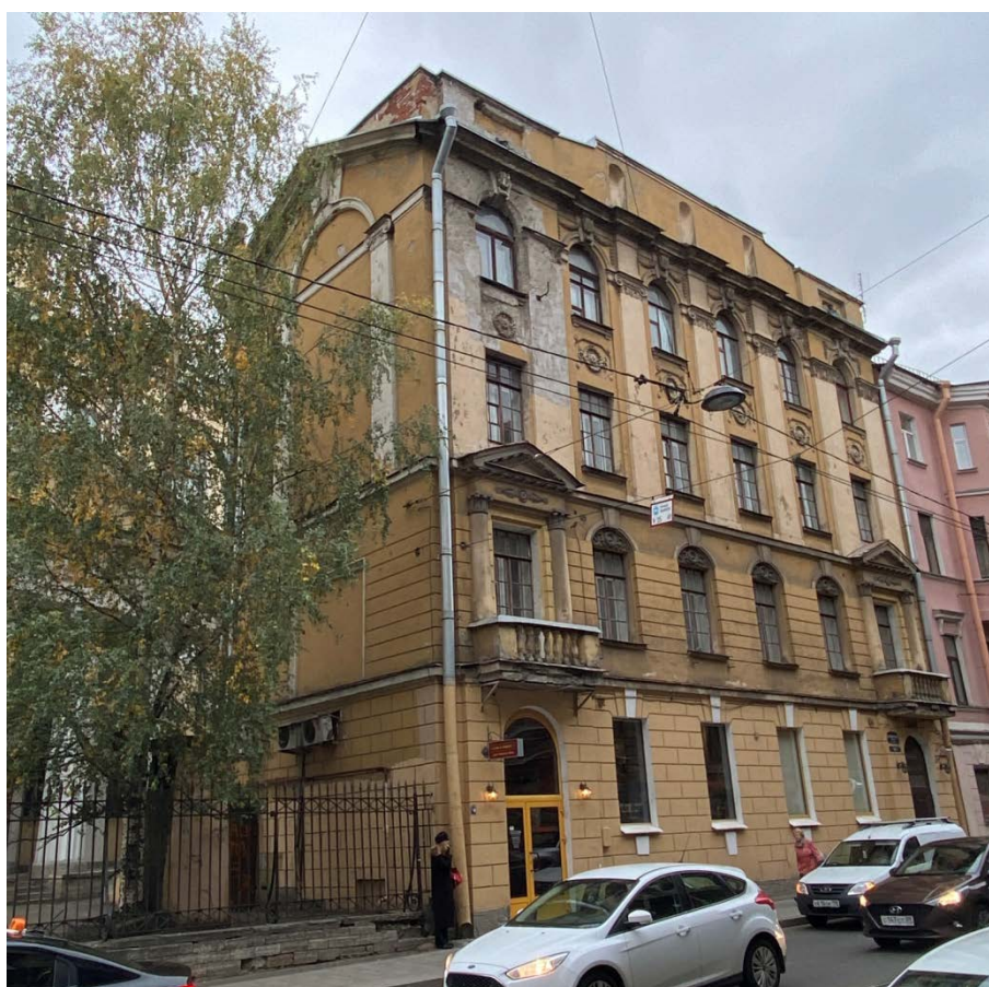
Фото 1. Общий вид с запада.
