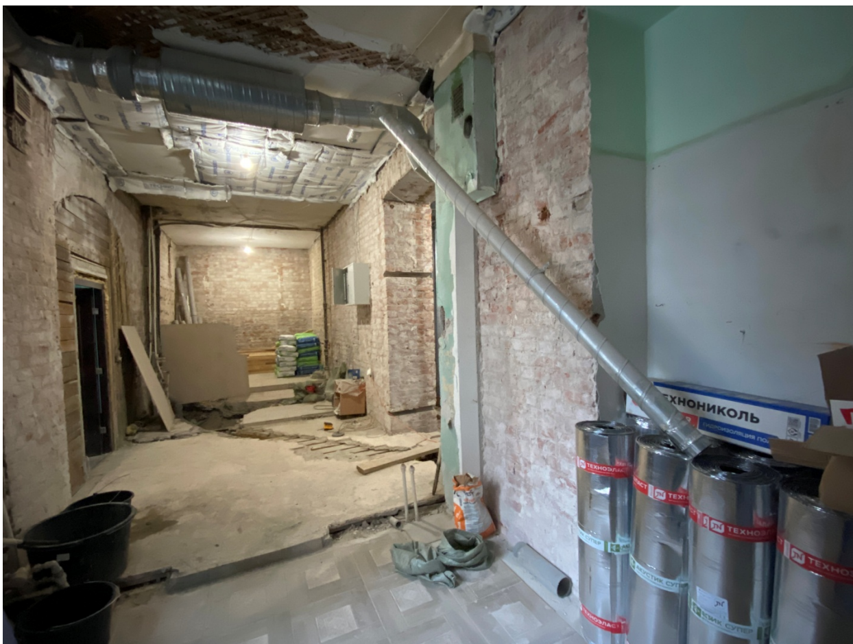
Фото 11. Общий вид на помещения вдоль северной стены.
