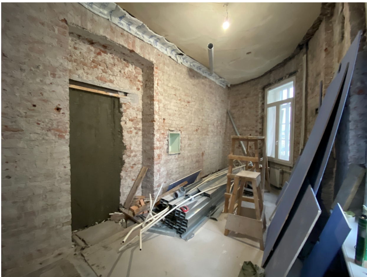
Фото 9. Вид на северо-западное помещение.
