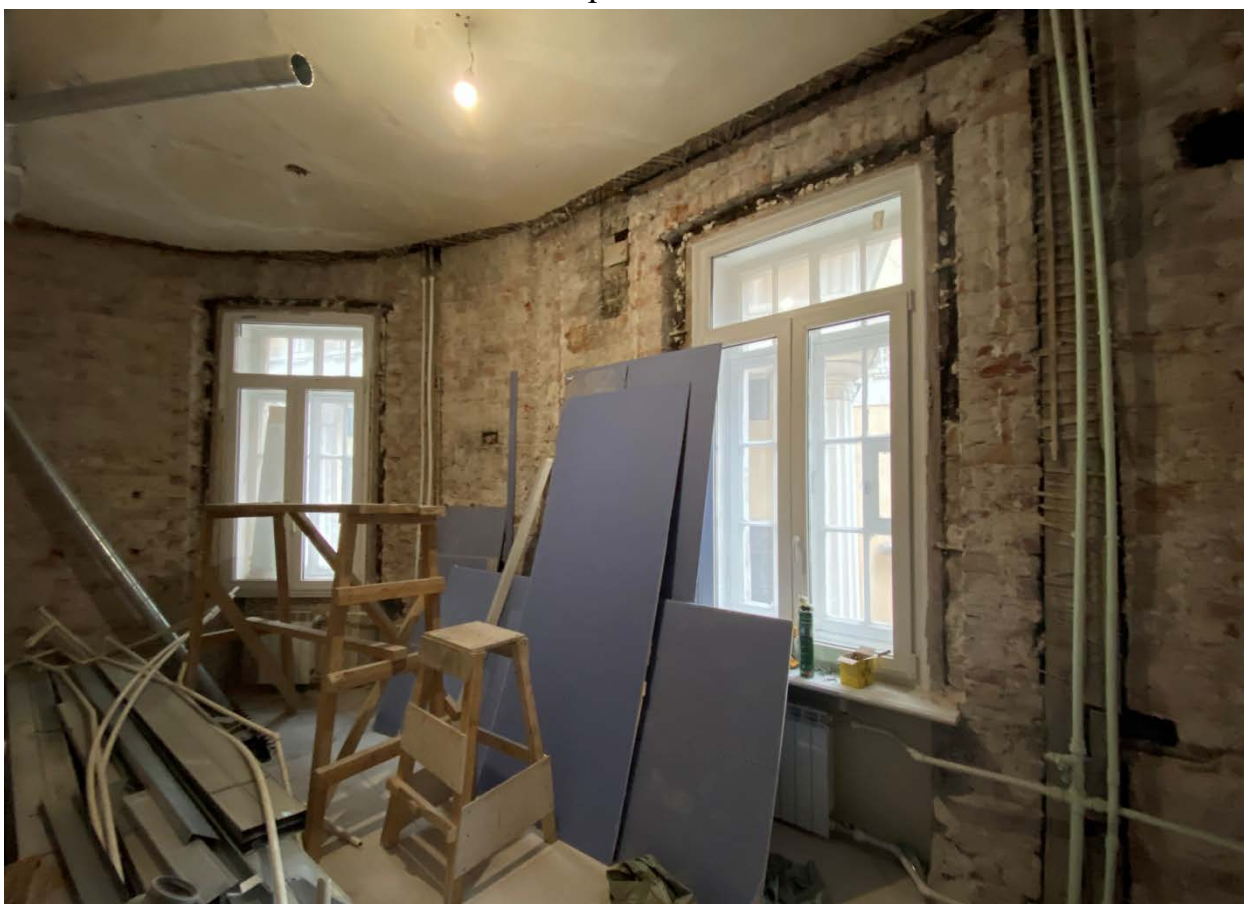
Фото 10. Оконные проемы на севере.
