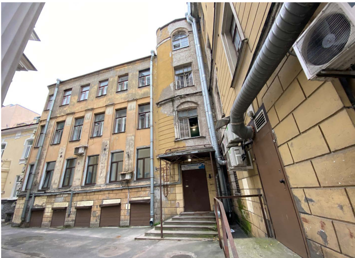
Фото 4. Общий вид дворового фасада.
