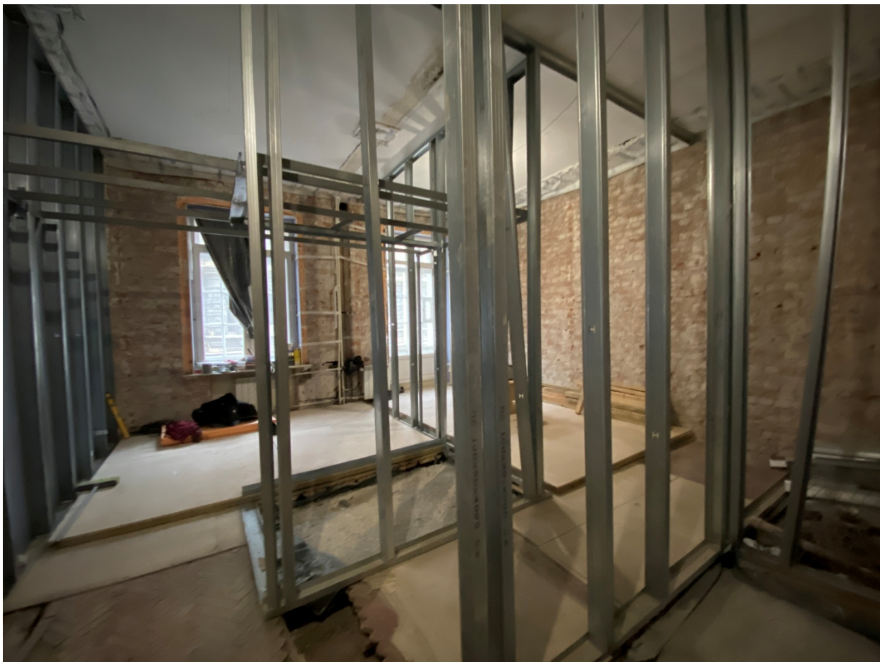
Фото 15. Помещение на юго-западе.
