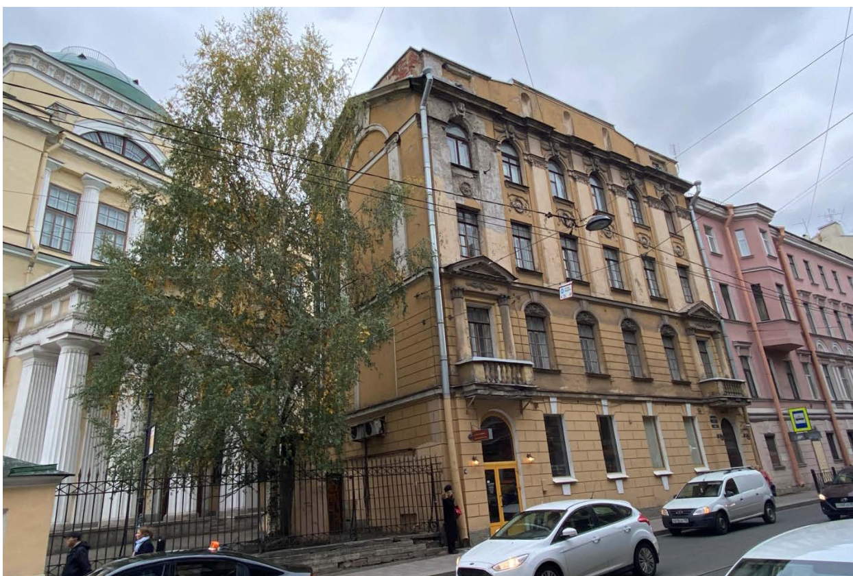
Фото 1. Общий вид с запада.
