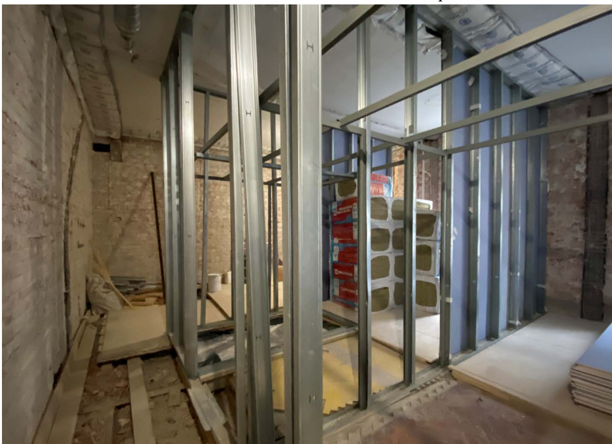
Фото 12. Вид на юго-восток, помещения вдоль южной стены.
