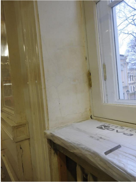
29. «Дворец Шереметевых» (г. Санкт Петербург, наб. р. Фонтанки, д. 34, лит. А). Белый зал. Оконное заполнение. Фрагмент. Оконный откос. Фото 10.11.2021 г.
