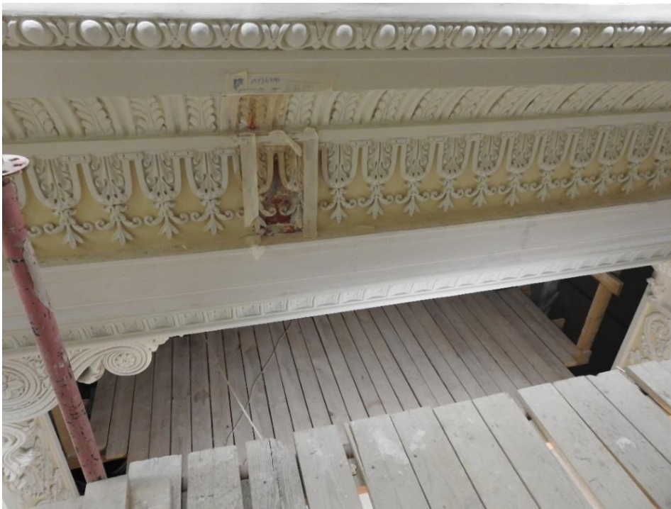
47. «Дворец Шереметевых» (г. Санкт Петербург, наб. р. Фонтанки, д. 34, лит. А). Белый зал. Западная стена. Фрагмент портала. Карниз с участком пробных расчисток, на предмет выявления живописной отделки. Фото 10.11.2021 г.
