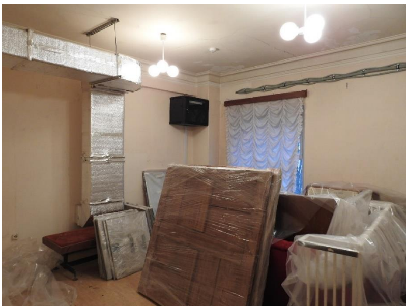
9. «Дворец Шереметевых» (г. Санкт Петербург, наб. р. Фонтанки, д. 34, лит. А). Артистические. Помещение № 2. Общий вид. Вид на северо-западный угол. Фото 10.11.2021 г.
