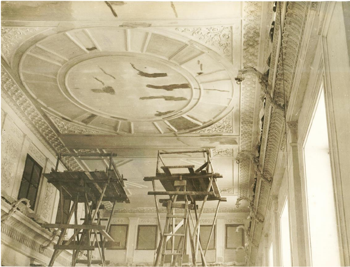
22. Реставрационные работы в Белом зале. 1948 г. Архив КГИОП
