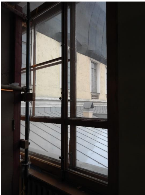
36. «Дворец Шереметевых» (г. Санкт Петербург, наб. р. Фонтанки, д. 34, лит. А). Аванзал. Общий вид оконного заполнения. Фото 10.11.2021 г.
