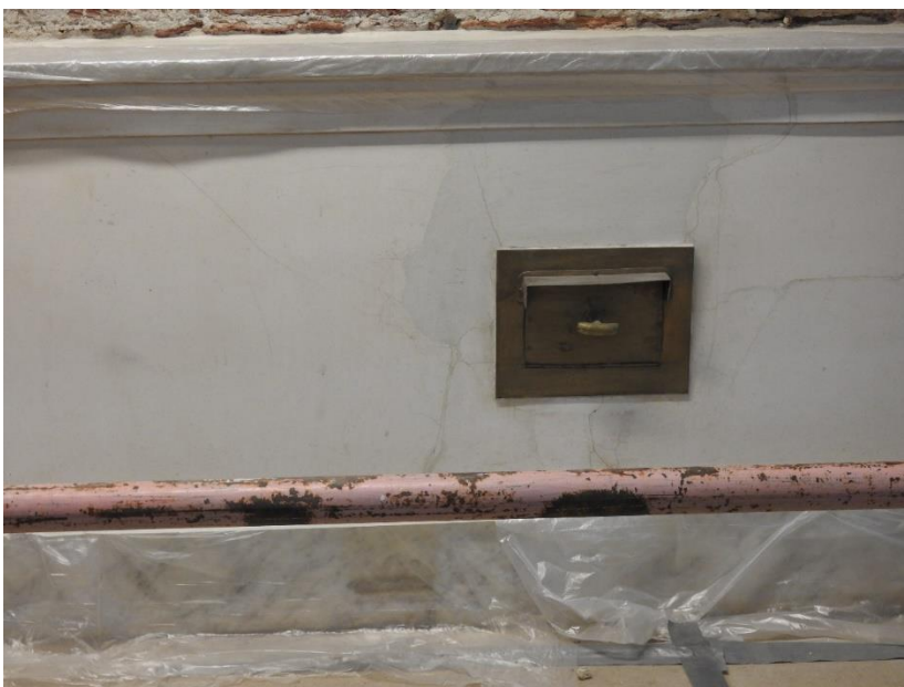
32. «Дворец Шереметевых» (г. Санкт Петербург, наб. р. Фонтанки, д. 34, лит. А). Белый зал. Панель Южной стены. Фрагмент. Вьюшка. Фото 10.11.2021 г.
