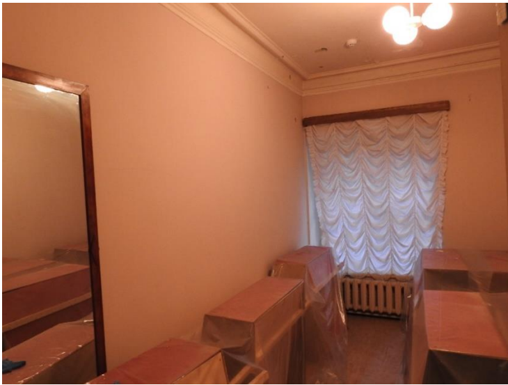
7. «Дворец Шереметевых» (г. Санкт Петербург, наб. р. Фонтанки, д. 34, лит. А). Артистические. Помещение № 2. Общий вид северной стены. Фото 10.11.2021 г.
