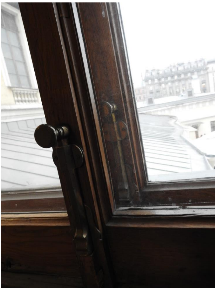
37. «Дворец Шереметевых» (г. Санкт Петербург, наб. р. Фонтанки, д. 34, лит. А). Аванзал. Оконное заполнение. Фрагмент. Нижний шпингалет. Фото 10.11.2021 г.
