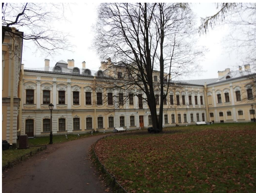
2. «Дворец Шереметевых» (г. Санкт Петербург, наб. р. Фонтанки, д. 34, лит. А). Дворец Шереметьевых. Дворовый фасад. Фото 10.11.2021 г.
