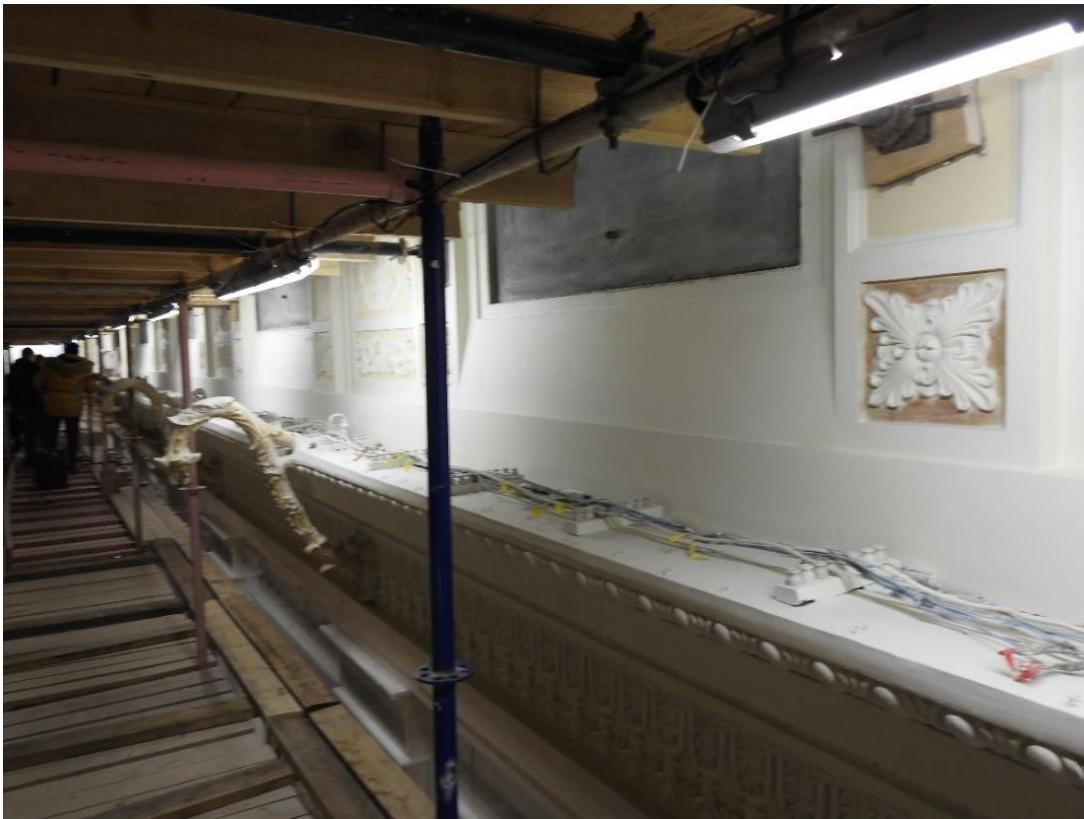
49. «Дворец Шереметевых» (г. Санкт Петербург, наб. р. Фонтанки, д. 34, лит. А). Белый зал. Общий вид южной стены с участком пробных расчисток, на предмет выявления живописной отделки. Фото 10.11.2021 г.
