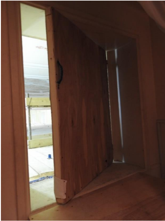
19. «Дворец Шереметевых» (г. Санкт Петербург, наб. р. Фонтанки, д. 34, лит. А). Артистические. Помещение № 4. Западная стена. Общий вид оконного заполнения. Фото 10.11.2021 г.
