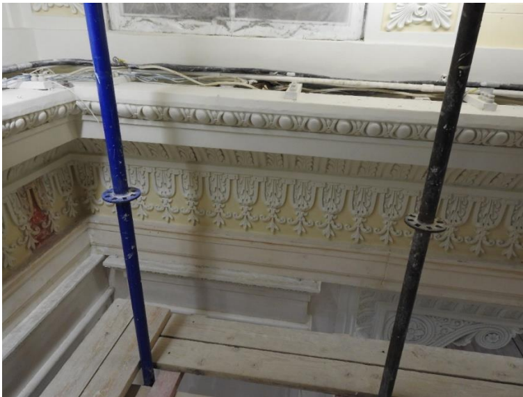
55. «Дворец Шереметевых» (г. Санкт Петербург, наб. р. Фонтанки, д. 34, лит. А). Белый зал. Северо-западный угол. Фрагмент карниза с участком пробных расчисток. Фото 10.11.2021 г.
