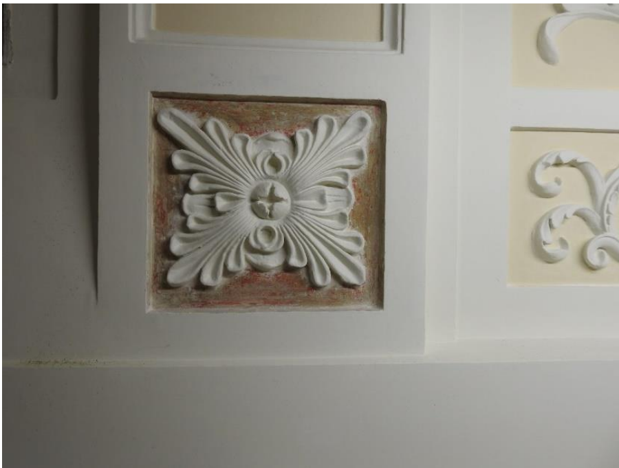
50. «Дворец Шереметевых» (г. Санкт Петербург, наб. р. Фонтанки, д. 34, лит. А). Белый зал. Южная стена. Розетка. После расчисток, на предмет выявления живописной отделки. Фото 10.11.2021 г.
