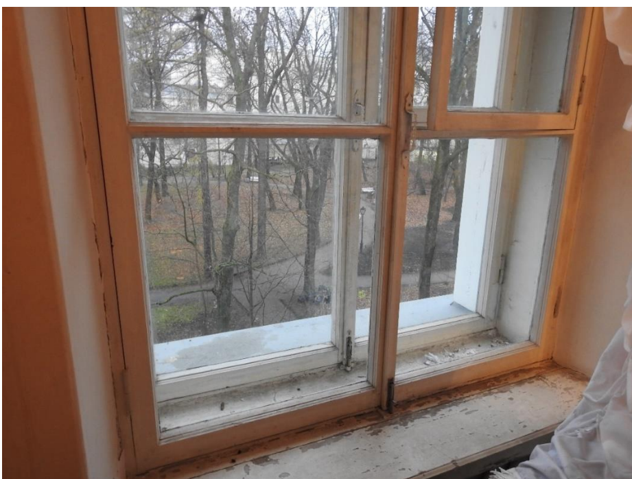
10. «Дворец Шереметевых» (г. Санкт Петербург, наб. р. Фонтанки, д. 34, лит. А). Артистические. Помещение № 2. Фрагмент оконного заполнения. Фото 10.11.2021 г.
