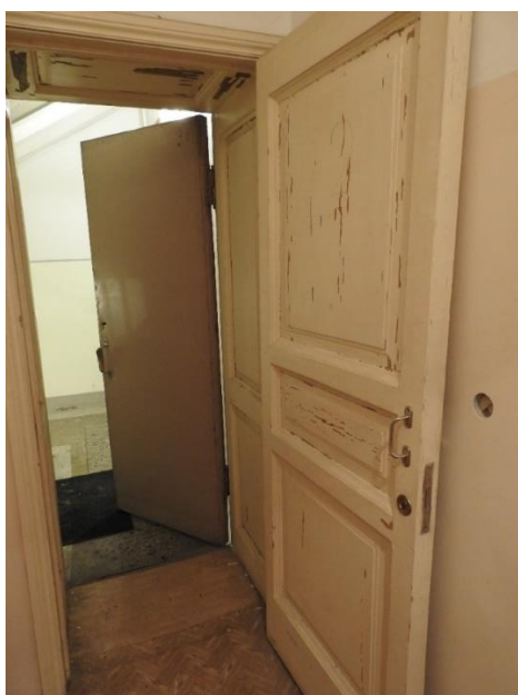
22. «Дворец Шереметевых» (г. Санкт Петербург, наб. р. Фонтанки, д. 34, лит. А). Артистические. Помещение № 1. Общий вид входной группы. Выход на лестничную площадку. Фото 10.11.2021 г.
