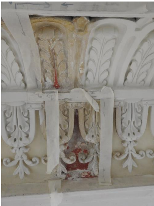
48. «Дворец Шереметевых» (г. Санкт Петербург, наб. р. Фонтанки, д. 34, лит. А). Белый зал. Фрагмент портала. Карниз с участком пробных расчисток, на предмет выявления живописной отделки. Фото 10.11.2021 г.
