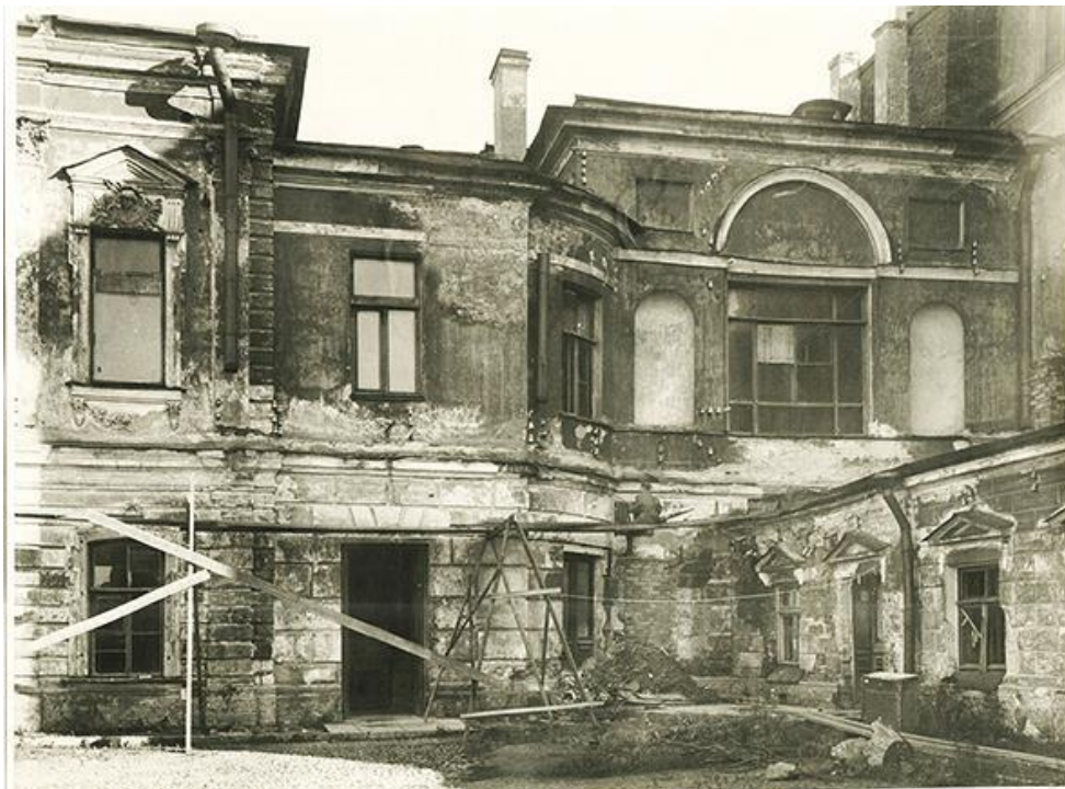
21. Реставрационные работы на фасаде Шереметевского дворца. Ремонт штукатурки и лепного декора на Дуговой комнаты и Галерейного флигеля. 1945 г. Архив КГИОП
