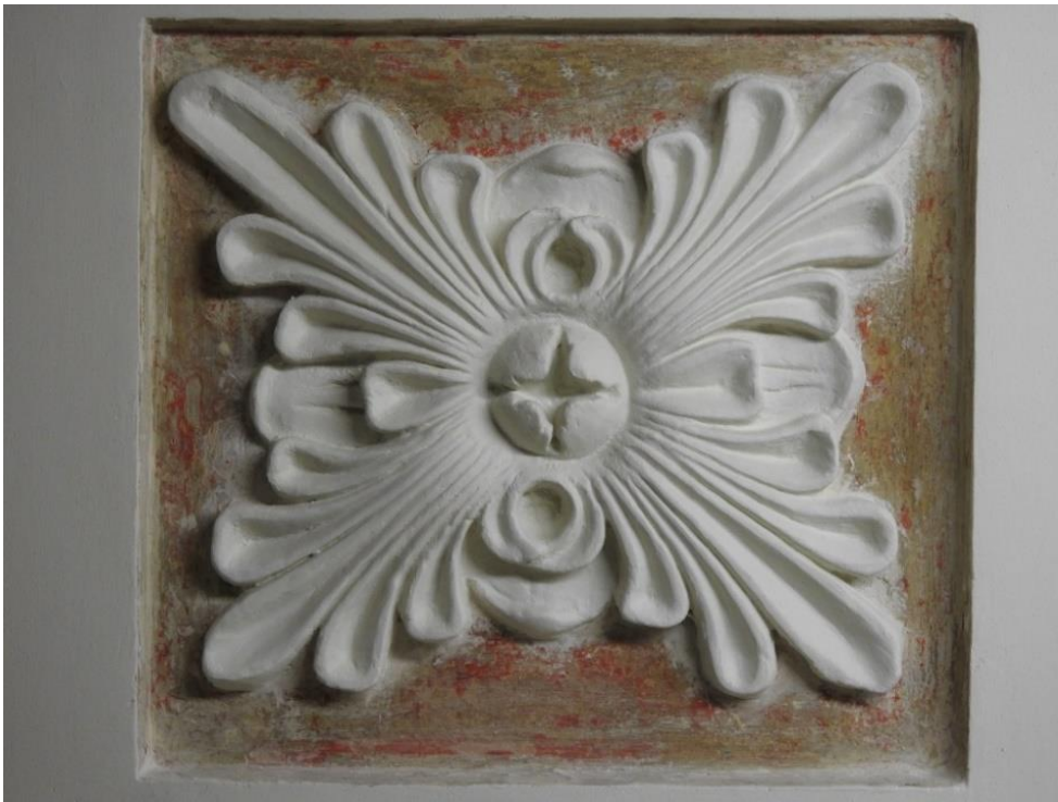
51. «Дворец Шереметевых» (г. Санкт Петербург, наб. р. Фонтанки, д. 34, лит. А). Белый зал. Южная стена. Розетка. После расчисток, на предмет выявления живописной отделки. Фото 10.11.2021 г.
