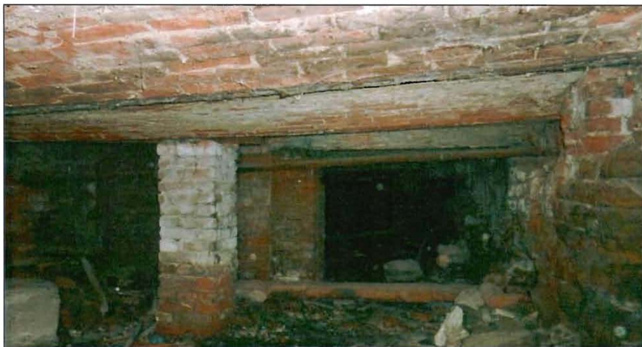
11. Подвал. Сводчатые перекрытия.
