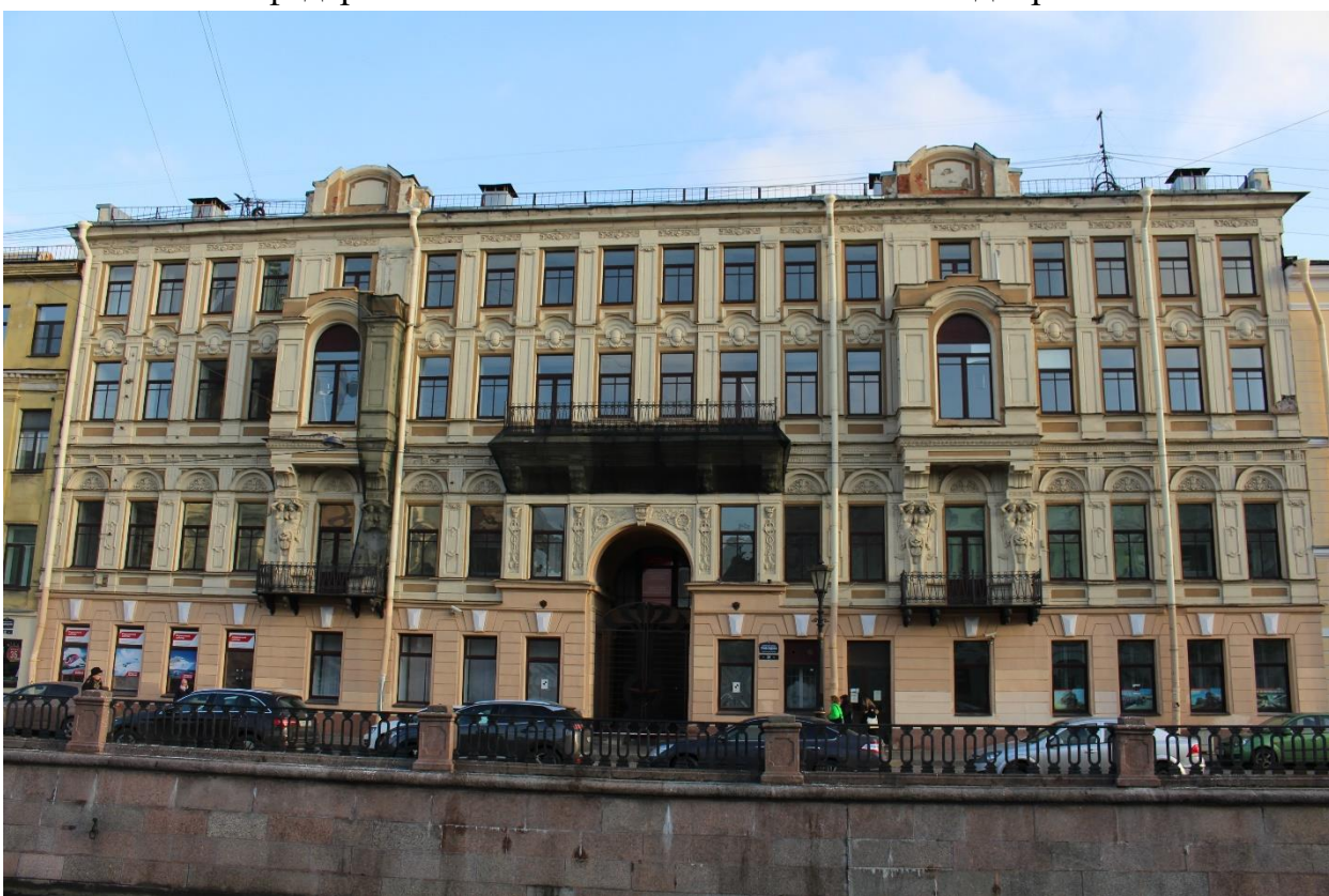
Фото 17. Вид на западный фасад нежилого здания по адресу: набережная канала Грибоедова, дом 24, литера А.
