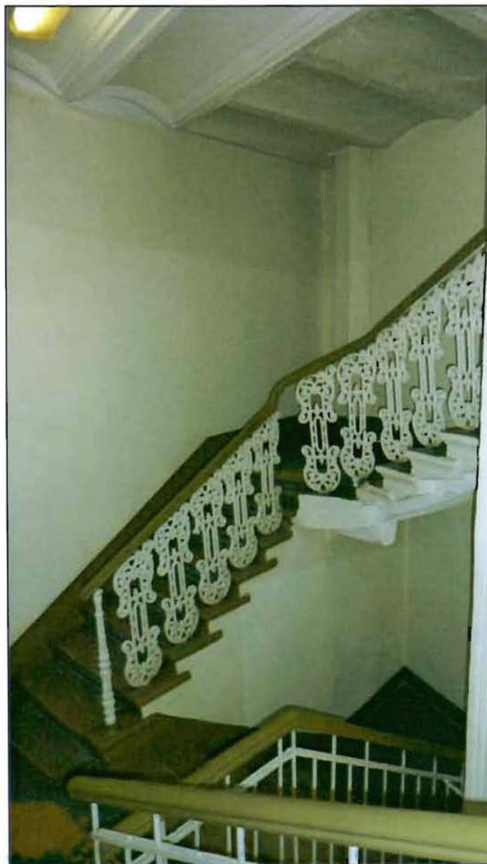
14. Лестница (пом. 24-Н).
