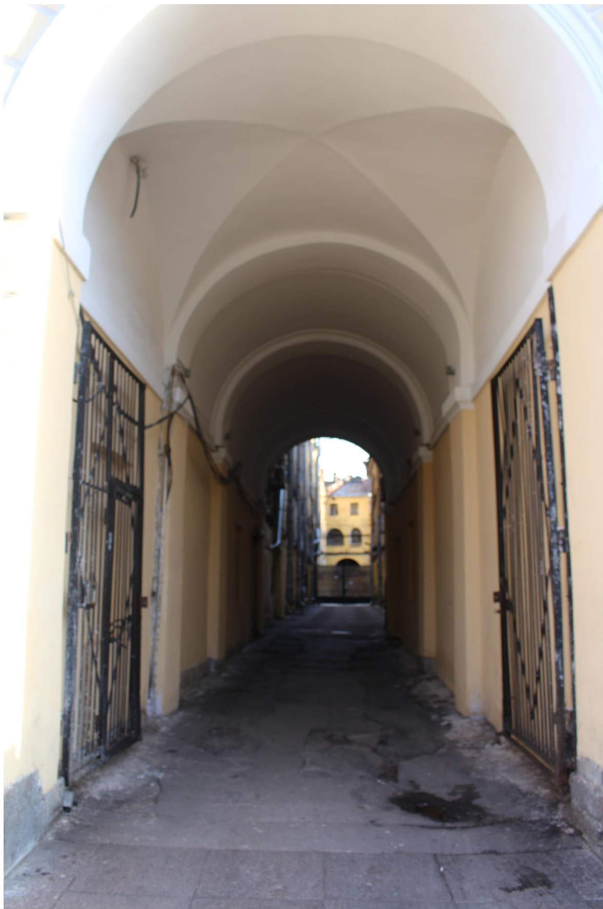
Фото 13. Вид на арку воротного проезда со стороны набережной канала Грибоедова.
