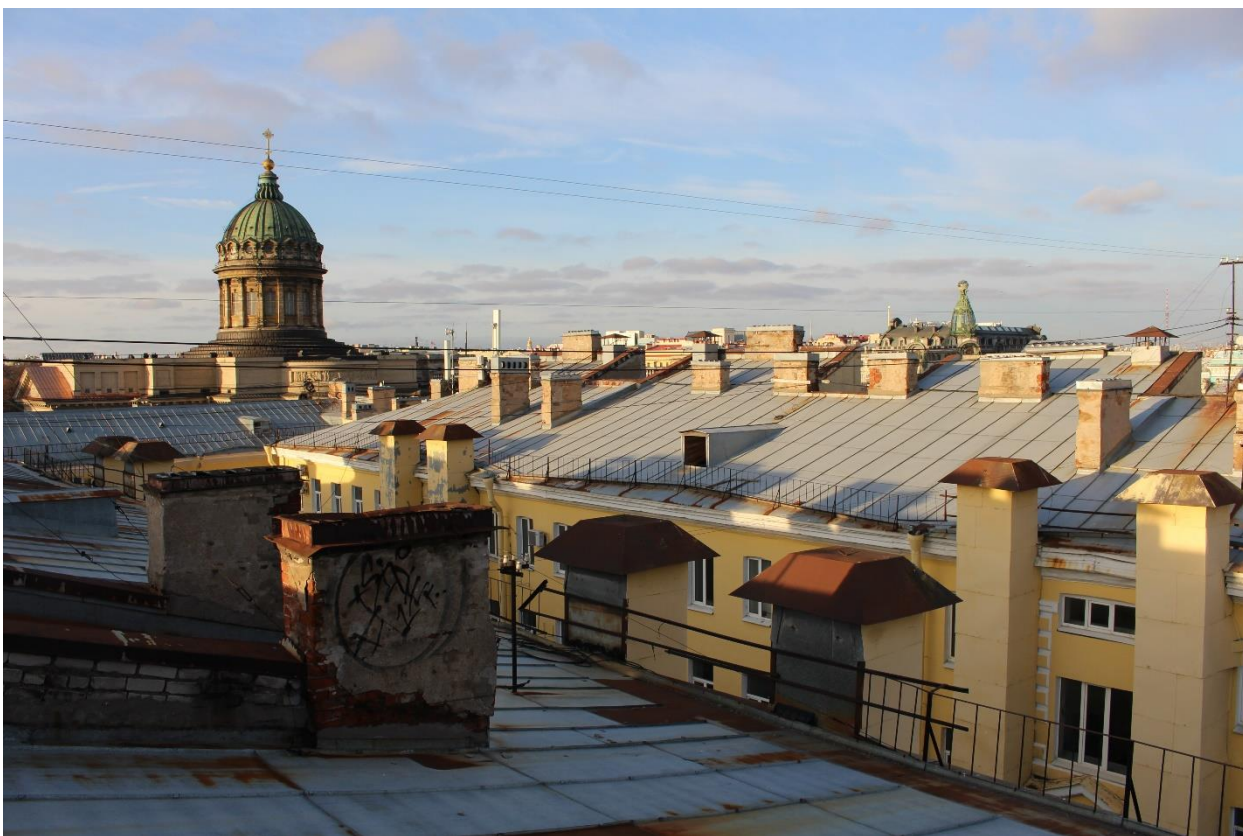
Фото 18. Вид на крышу нежилого здания по адресу: набережная канала Грибоедова, дом 24, литера А.
