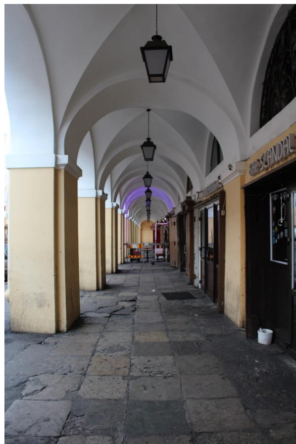
Фото 11. Вид на южную галерею с востока.
