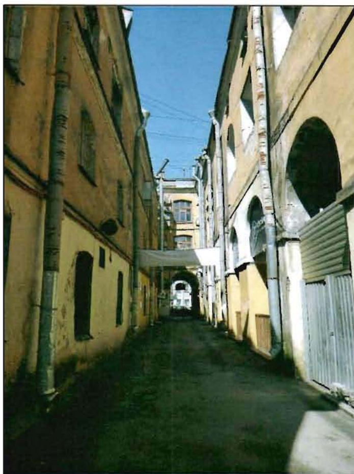
5. Дворовые фасады. Вид с востока.
