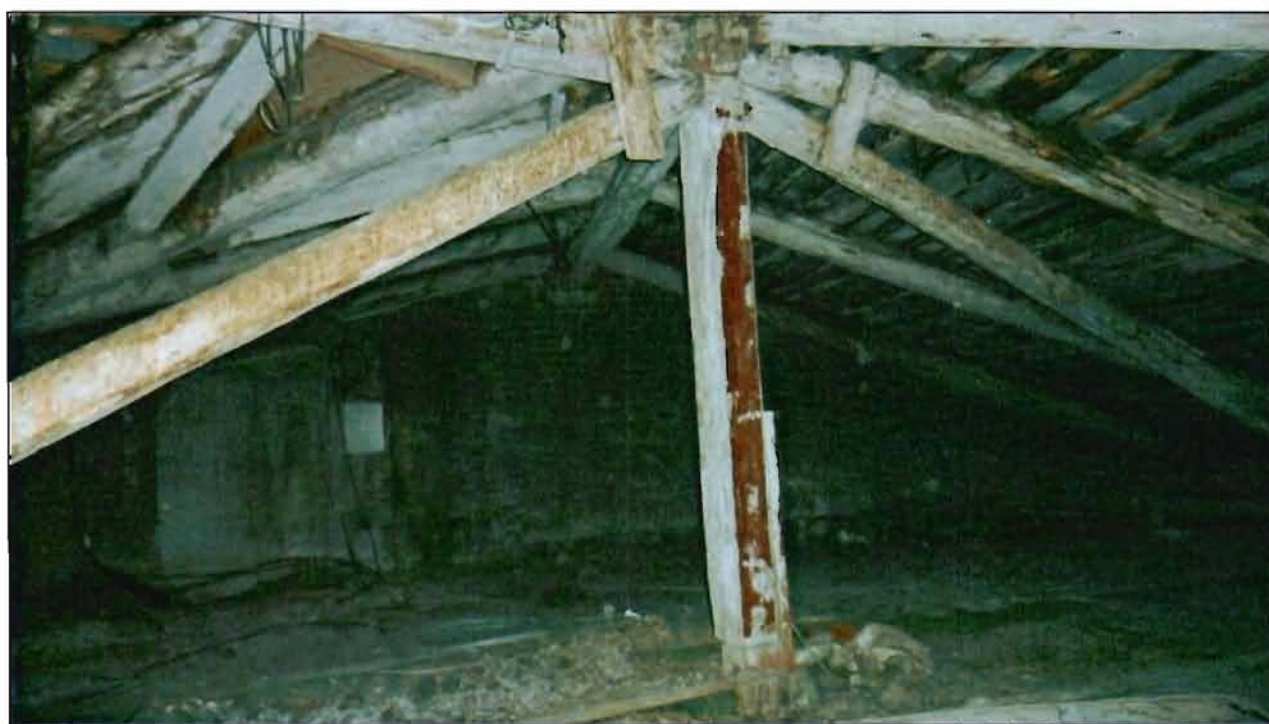
12. Чердак. Стропильная система.
