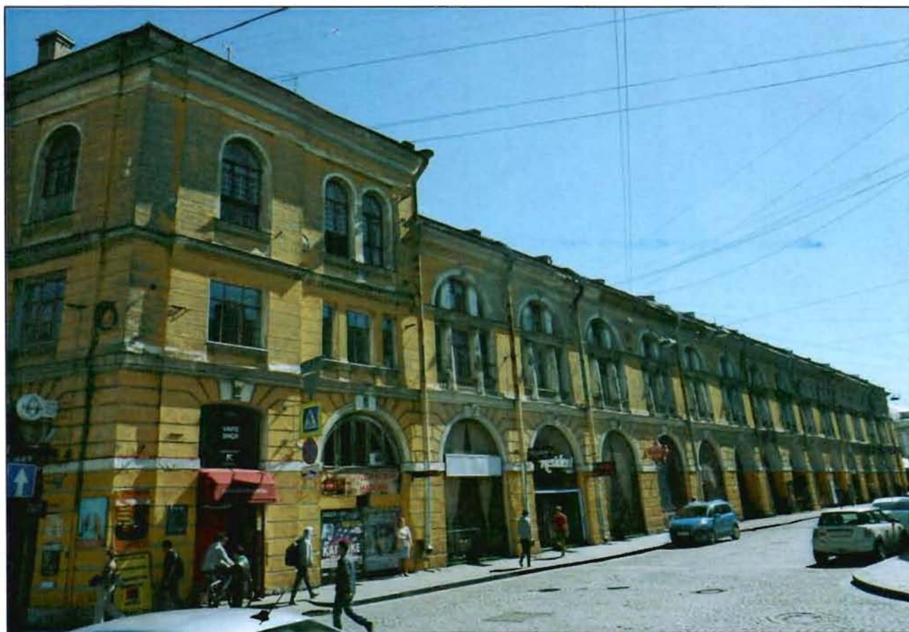
2. Южный фасад. Вид с запада.
