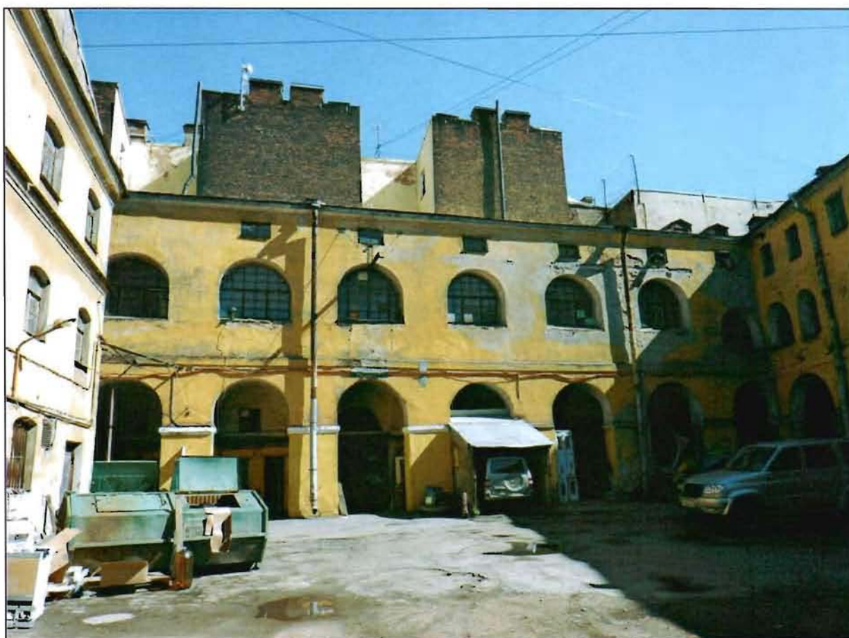
6. Дворовые фасады. Вид с юга.
