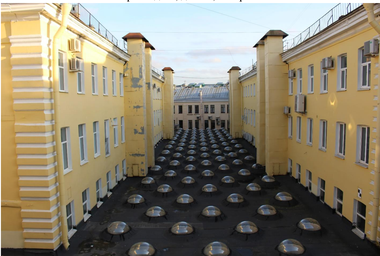
Фото 19. Вид на крышу атриума нежилого здания по адресу: набережная канала Грибоедова, дом 24, литера А.
