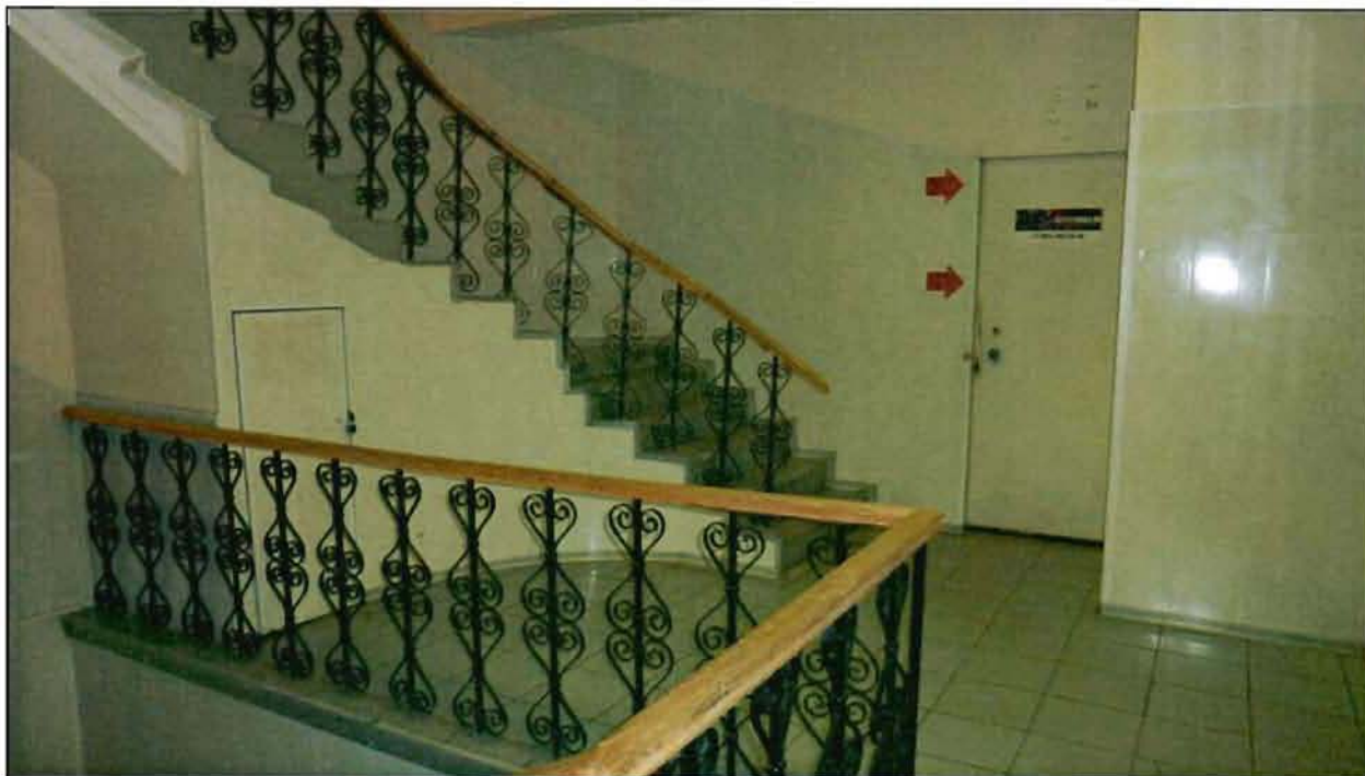
15. Лестница (пом. 1-Н).
