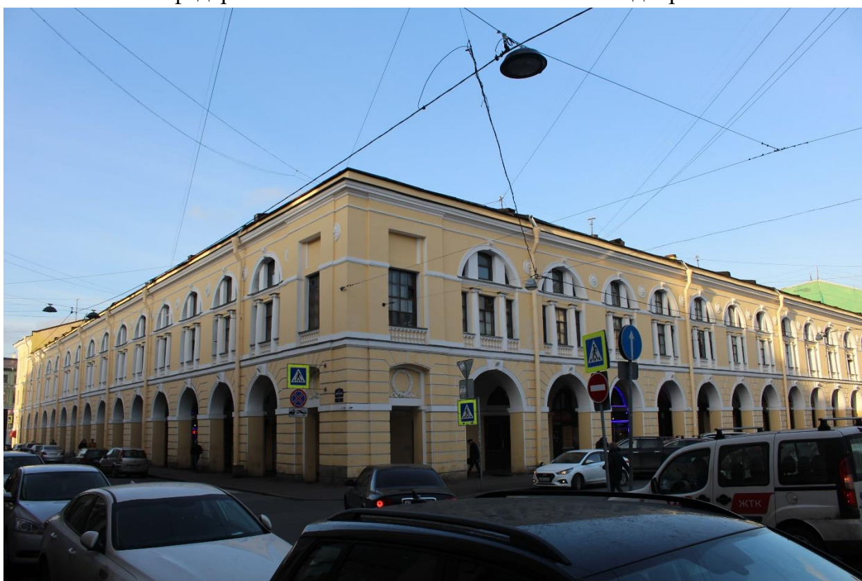
Фото 6. Вид на южный и восточный лицевые фасады объекта культурного наследия федерального значения «Малый Гостиный двор».
