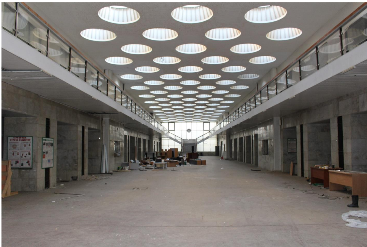
Фото 20. Вид на атриум нежилого здания по адресу: набережная канала Грибоедова, дом 24, литера А.
