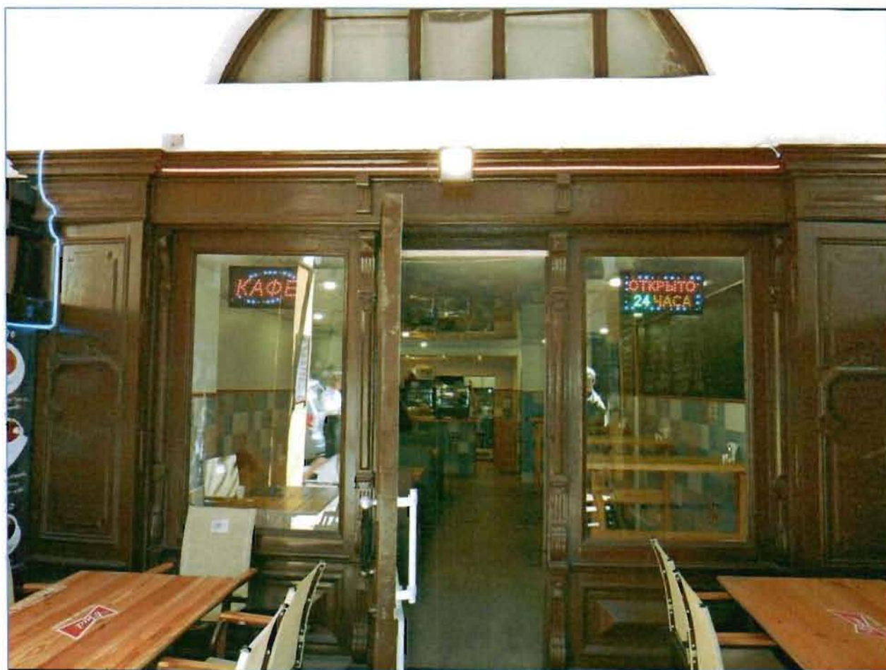
10. Исторические витринные заполнения (в уровне первого этажа со стороны ул. Ломоносова).
