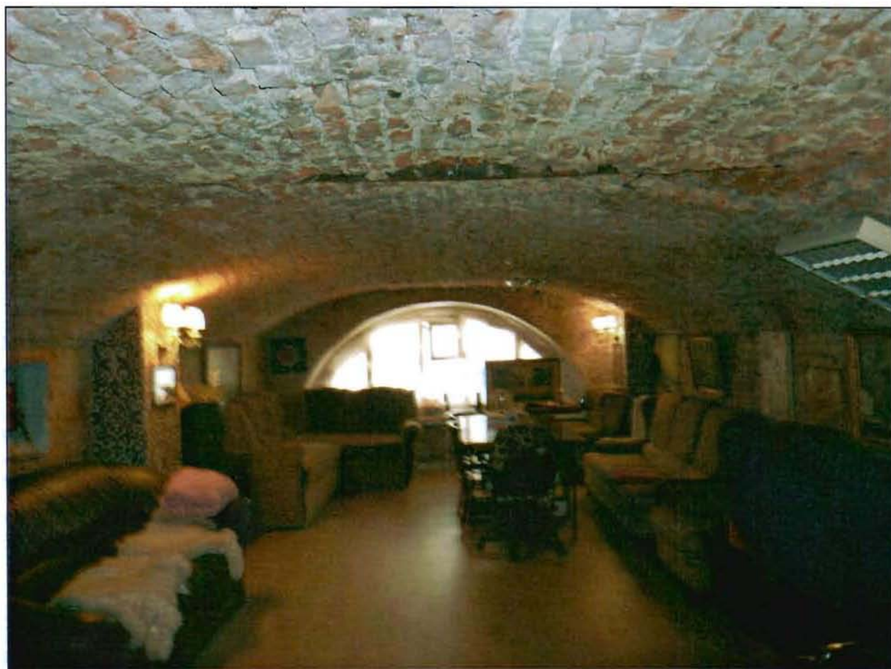
20. Сводчатые перекрытия (пом. 28-Н).
