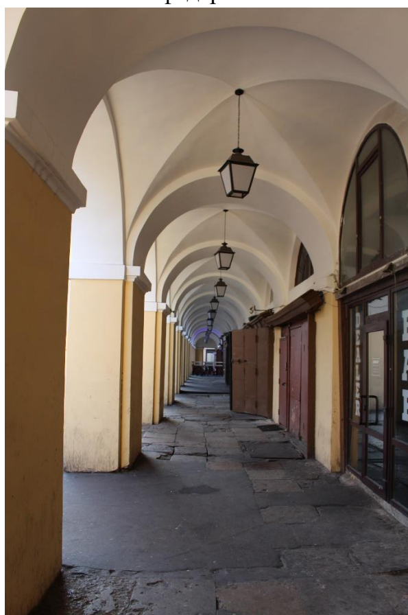
Фото 8. Восточная галерея, вид с севера.
