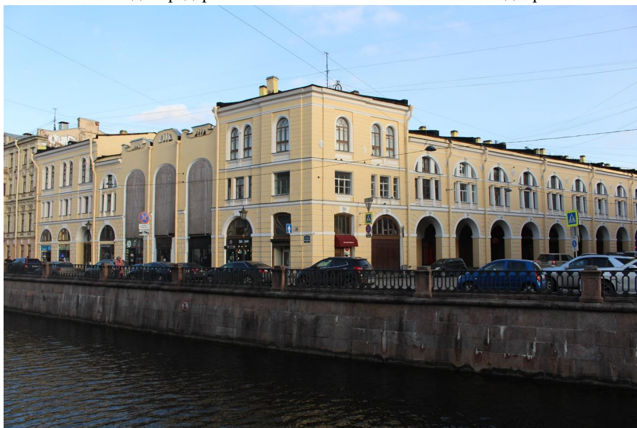
Фото 4. Вид на западный и южный лицевые фасады объекта культурного наследия федерального значения «Малый Гостиный двор».
