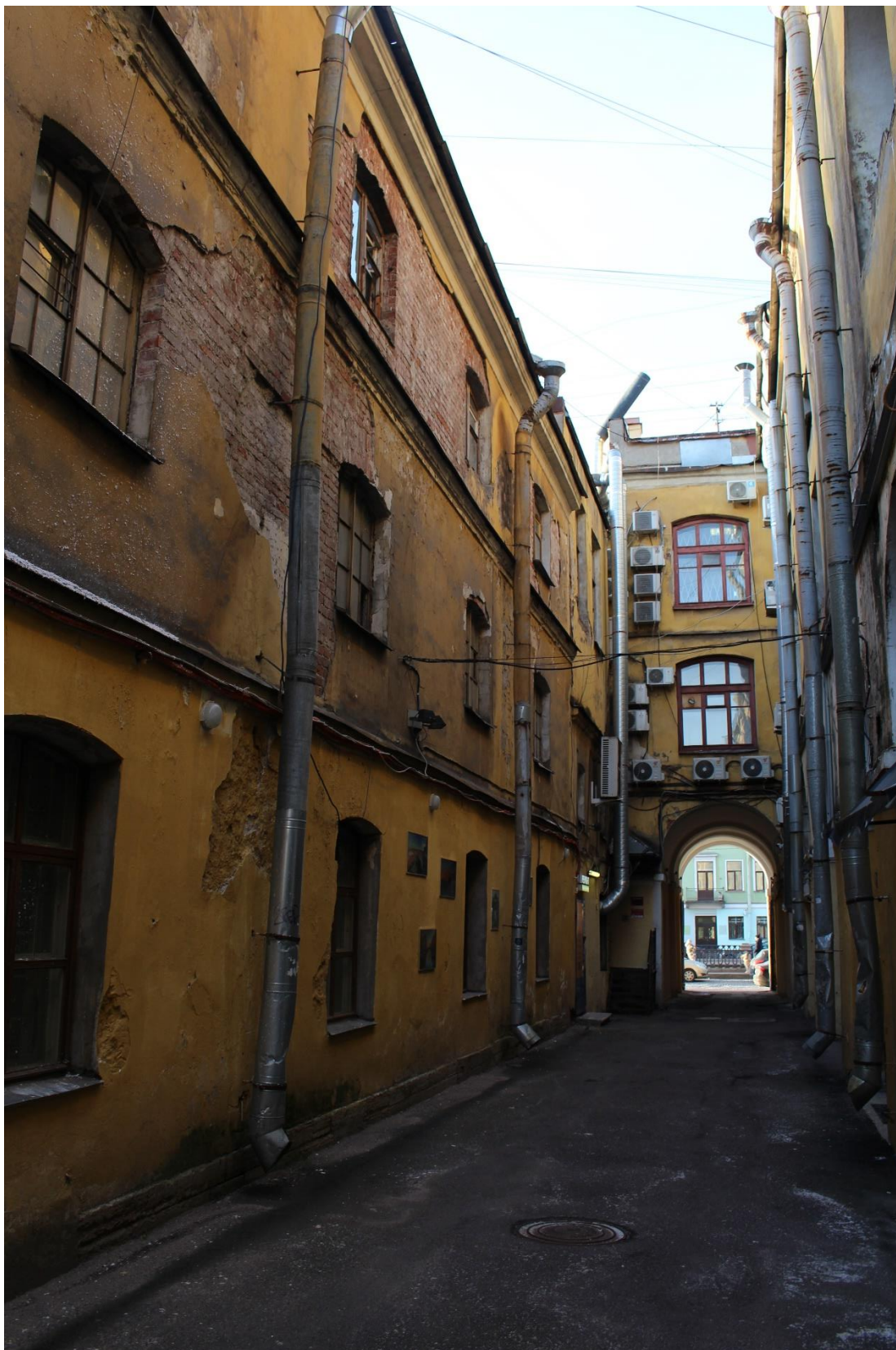
Фото 15. Вид на арку воротного проезда на набережной канала Грибоедова с востока.
