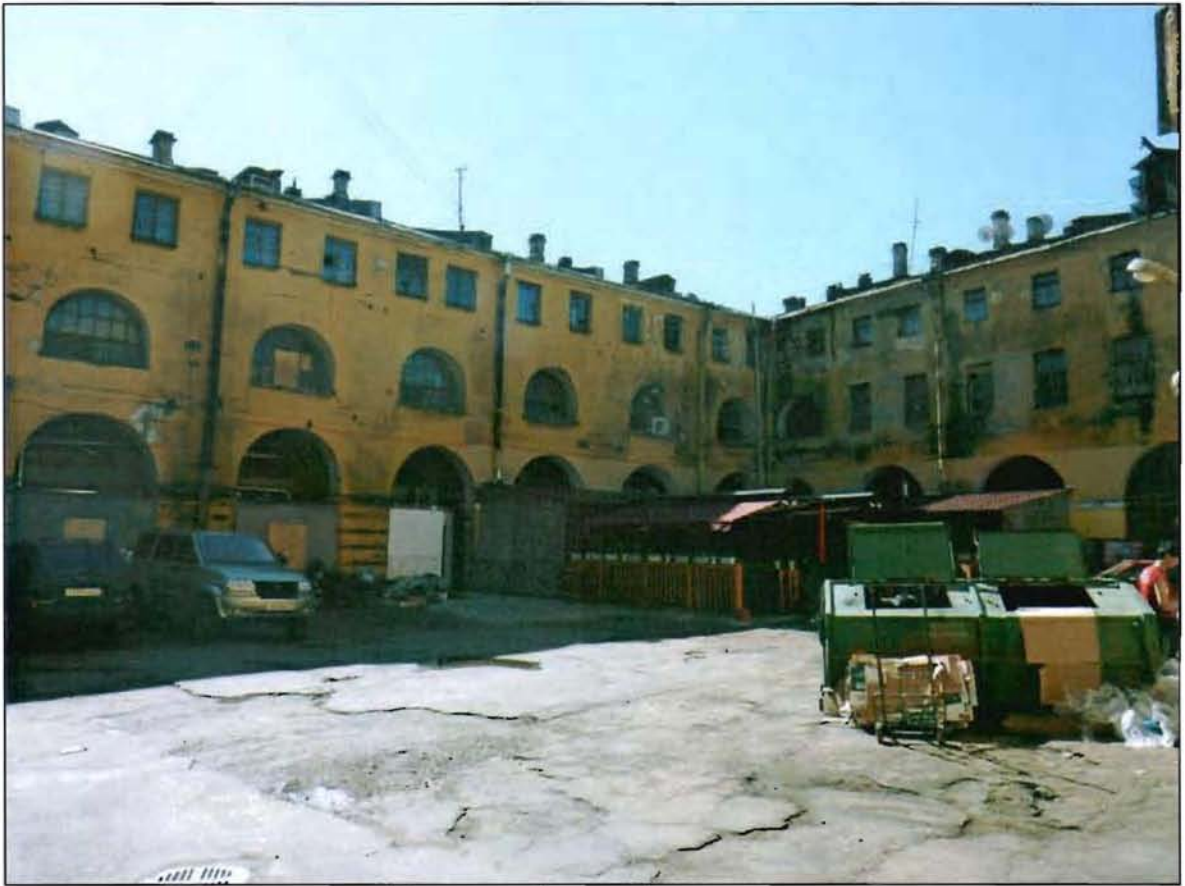
7. Дворовые фасады. Вид с севера.
