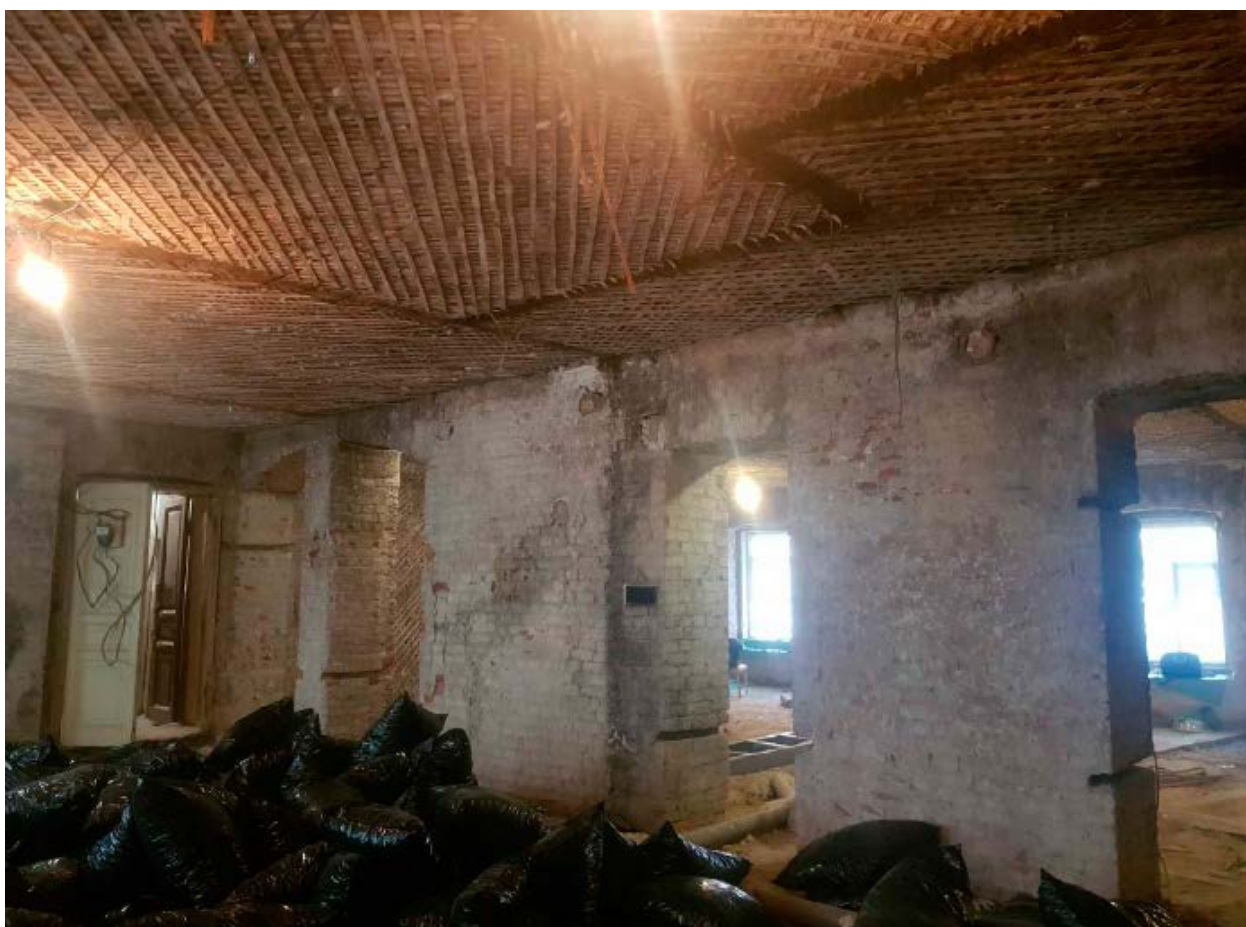
8. Помещение №5 квартиры №21 в уровне 3-го этажа выявленного объекта культурного наследия «Дом И.И. Антонова», расположенного по адресу: г. Санкт-Петербург, Литейный пр., д. 61, лит. А. 20.12.2020.
