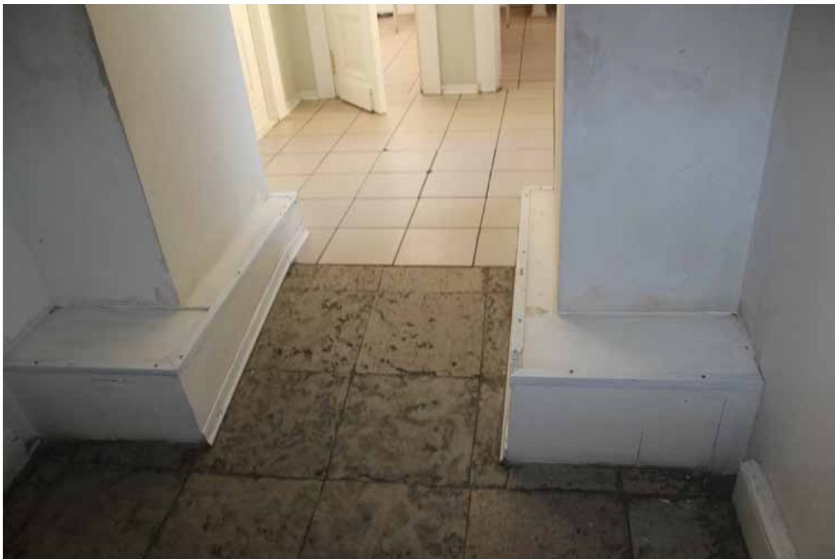
Фото №14. Общий вид на тамбур №6, проход
