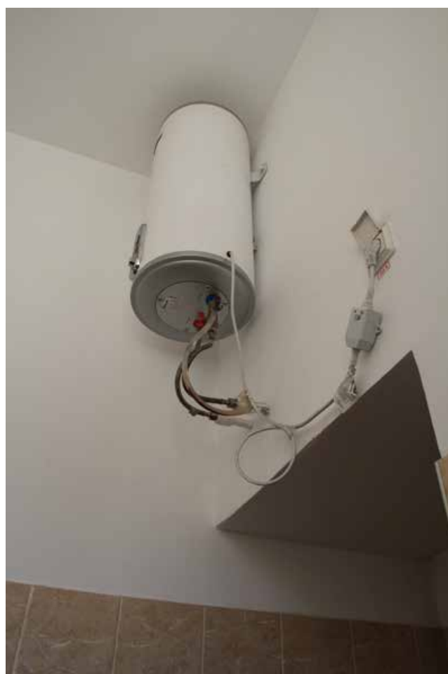
Фото №19. Общий вид санузла
