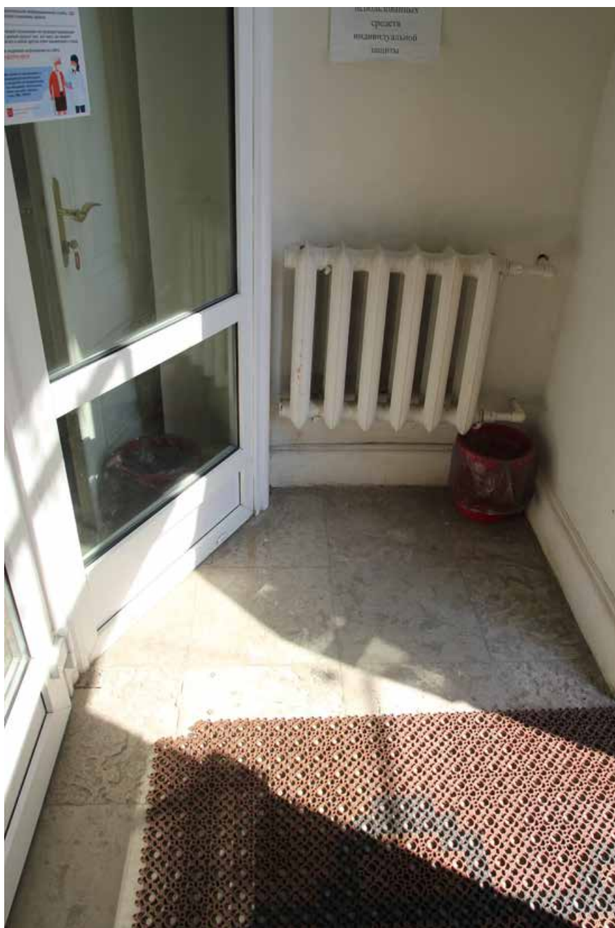
Фото №5. Тамбур внутри
