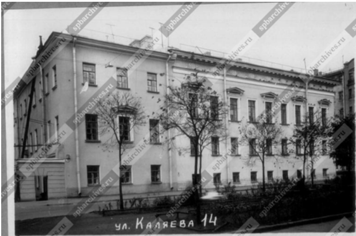
Илл. 21. Фасад дома №14 на улице Каляева. Дата съемки: 1960 г. Автор съемки: не установлен. // ЦГАКФФД СПб. Фотодокумент Гр 75171
