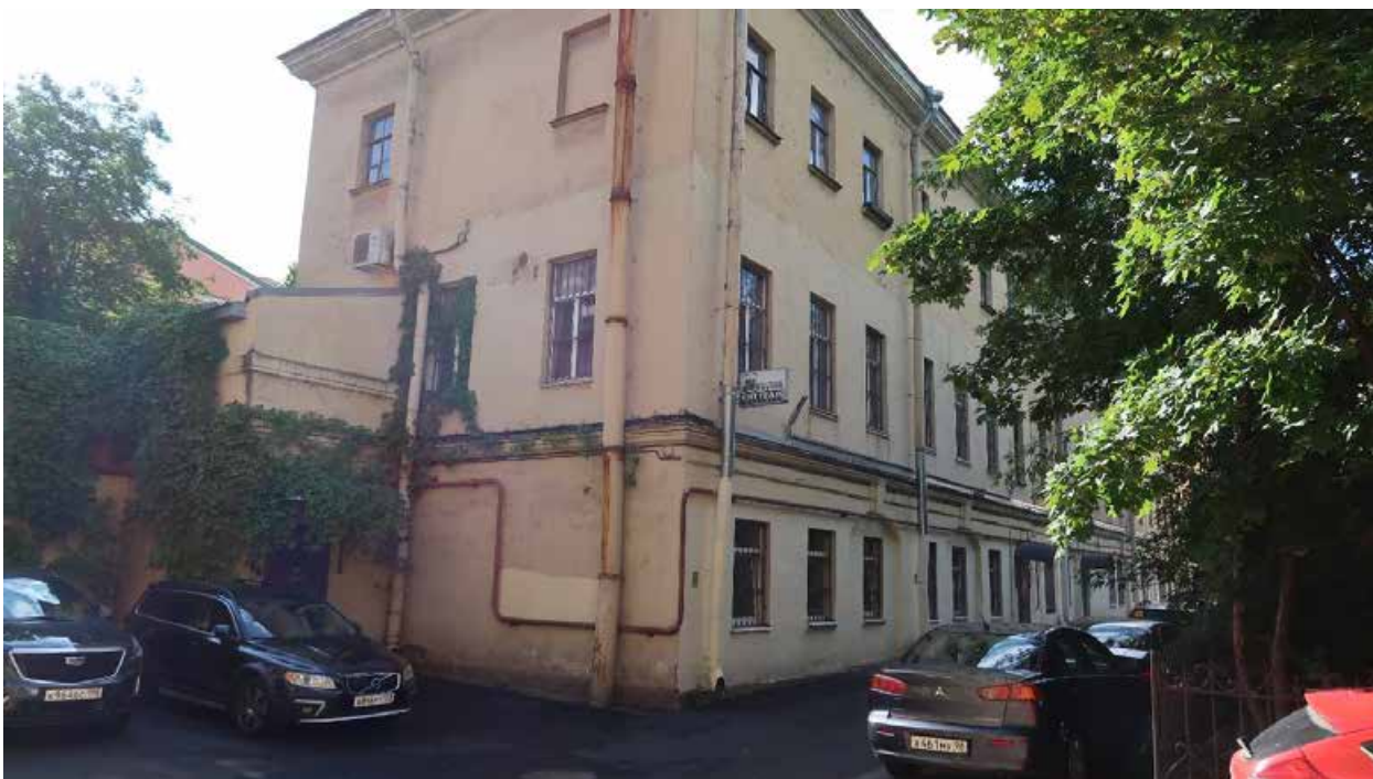
Фото 2. Торцевой и дворовой фасады здания.
