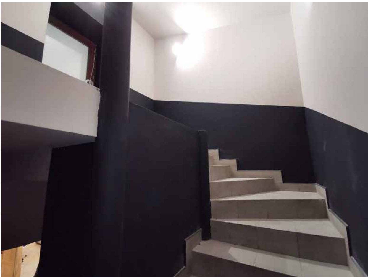
Фото 20. Лестница в пристройке.
