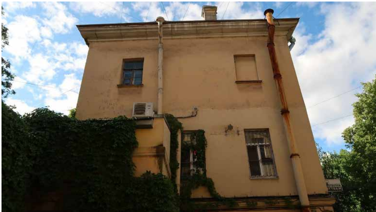
Фото 1. Торцевой фасад здания в уровне второго этажа.
