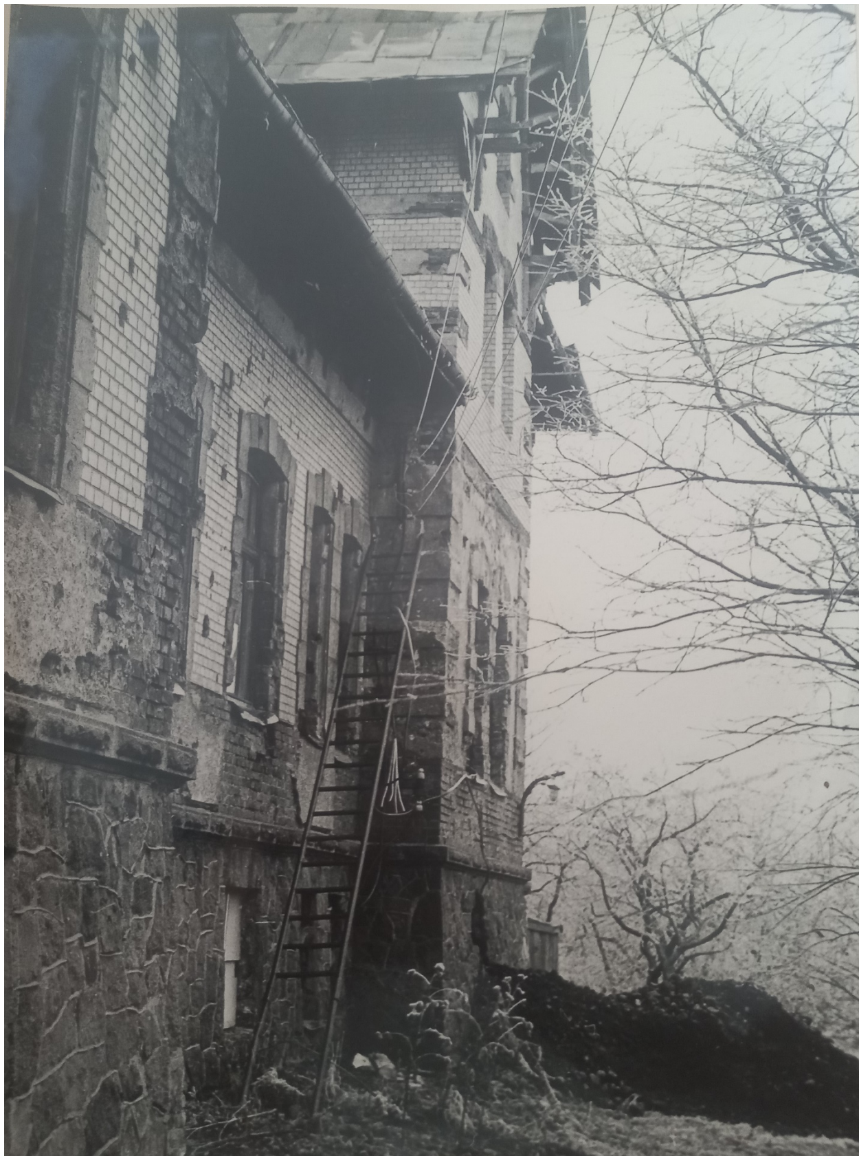
16.5 Южный фасад. Общий вид.
