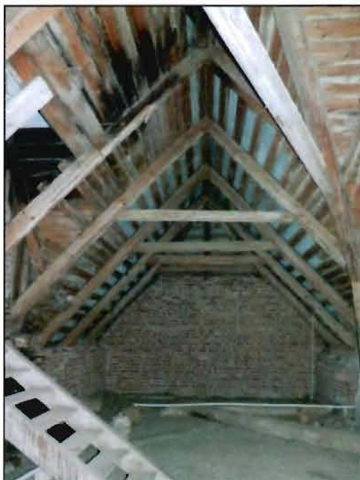
8. Стропильная система. Фрагмент.
