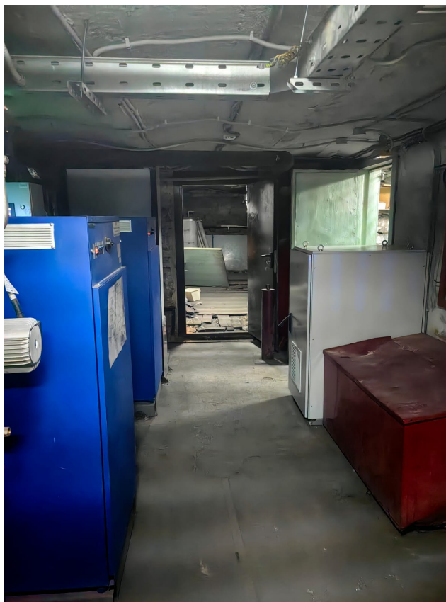
Фото 23. ОКН « Больница общины Святого Георгия» по адресу: г. Санкт-Петербург, г. Красное Село, пр. Двадцать Пятого Октября, д. 105, лит.А, помещение 1-Н. Дата съемки 09.01.2025
