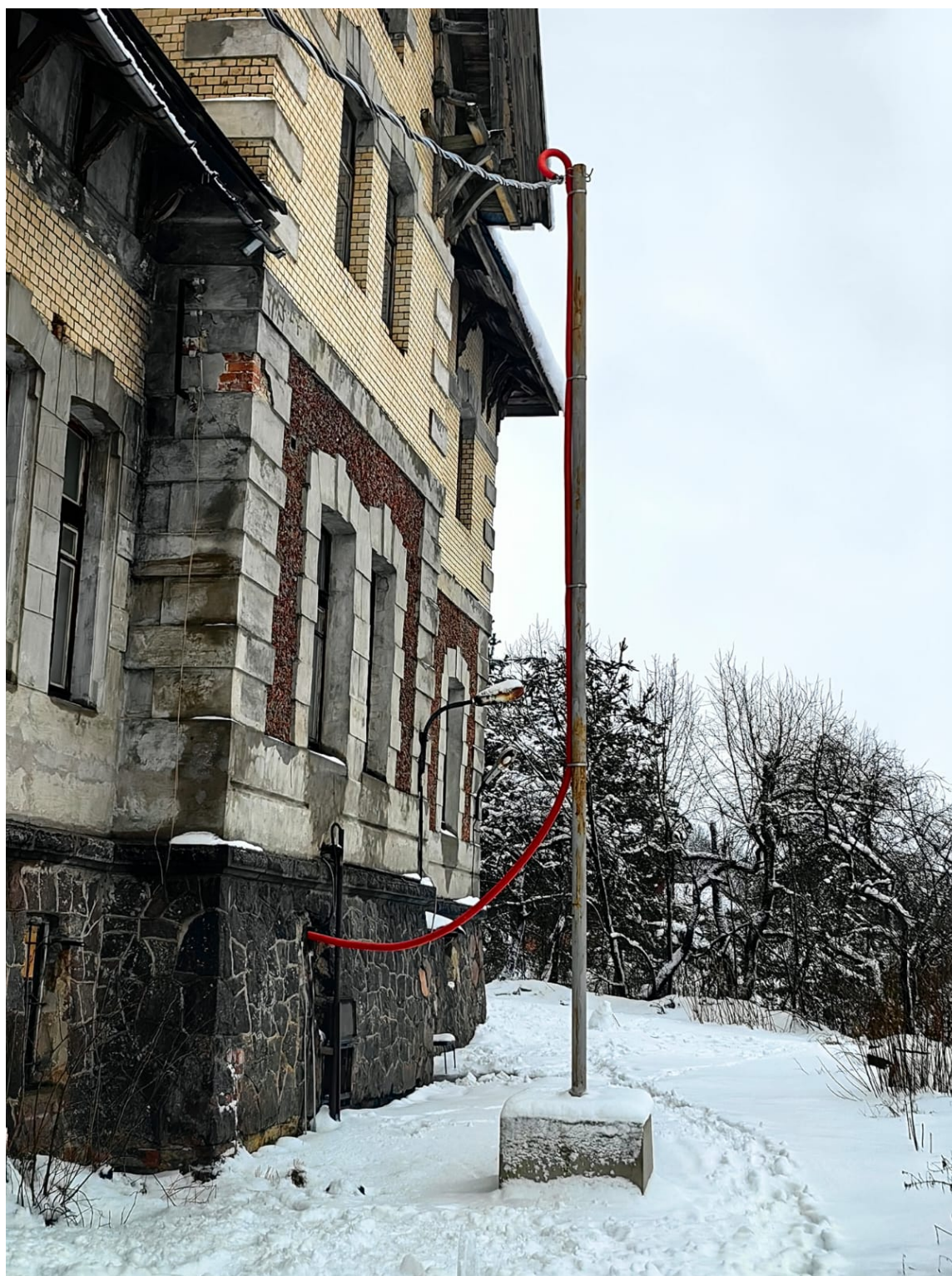
Фото 14. ОКН «Больница общины Святого Георгия» по адресу: г. Санкт-Петербург, г. Красное Село, пр. Двадцать Пятого Октября, д. 105, лит.А, Южный фасад. Дата съемки 09.01.2025
