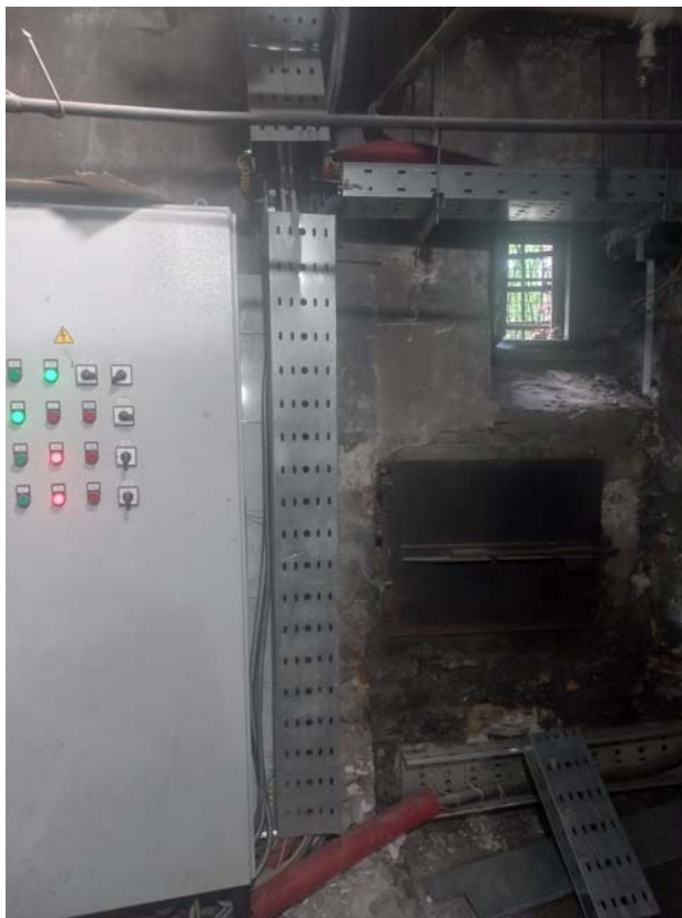
Фото 19. ОКН «Больница общины Святого Георгия» по адресу: г. Санкт-Петербург, г. Красное Село, пр. Двадцать Пятого Октября, д. 105, лит.А, Помещение 2-Н . Дата съемки 17.07.2024
