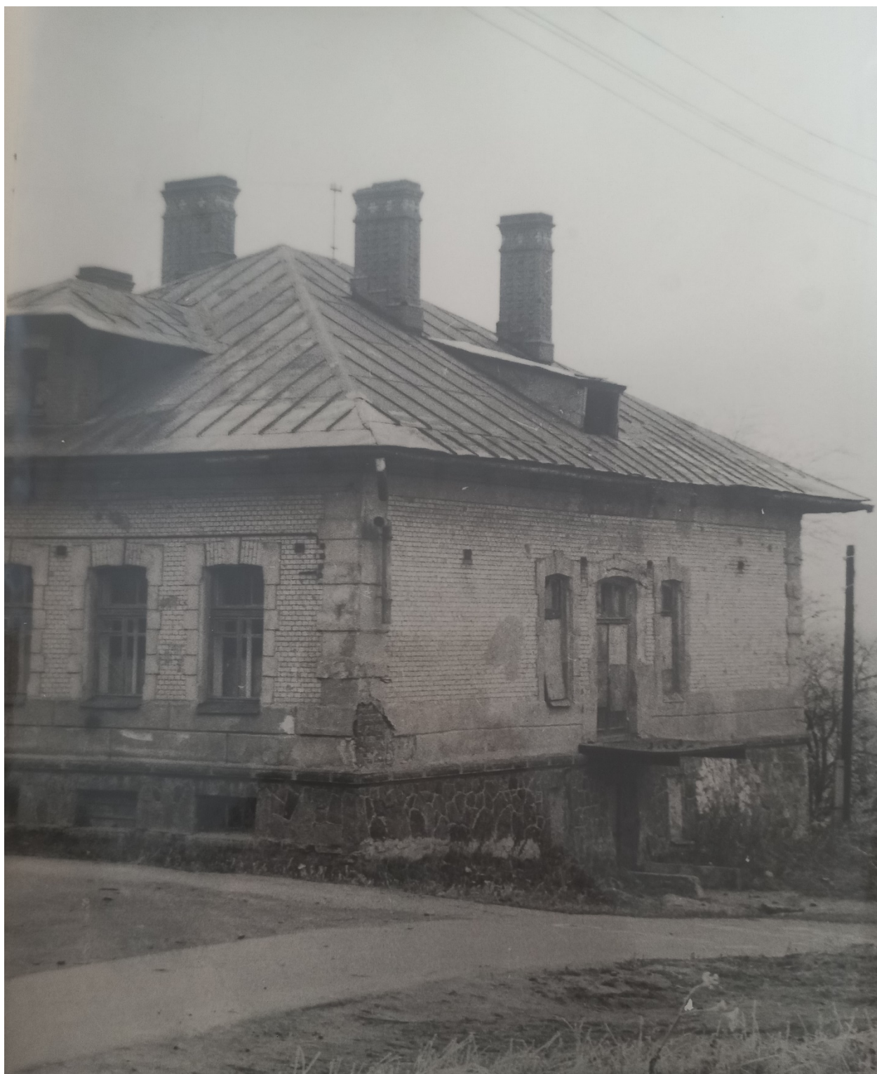
16.2 Общий вид северного фасада (продолжение)
