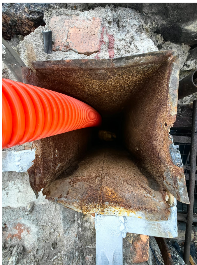
Фото 18. ОКН «Больница общины Святого Георгия» по адресу: г. Санкт-Петербург, г. Красное Село, пр. Двадцать Пятого Октября, д. 105, лит.А, Южный фасад. Дата съемки 09.01.2025
