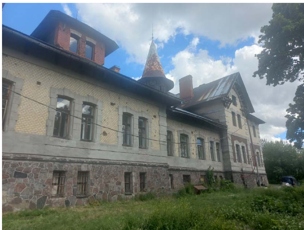
Фото 4. ОКН «Больница общины Святого Георгия» по адресу: г. Санкт-Петербург, г. Красное Село, пр. Двадцать Пятого Октября, д. 105, лит.А, Южный фасад. Дата съемки 10.09.2024
