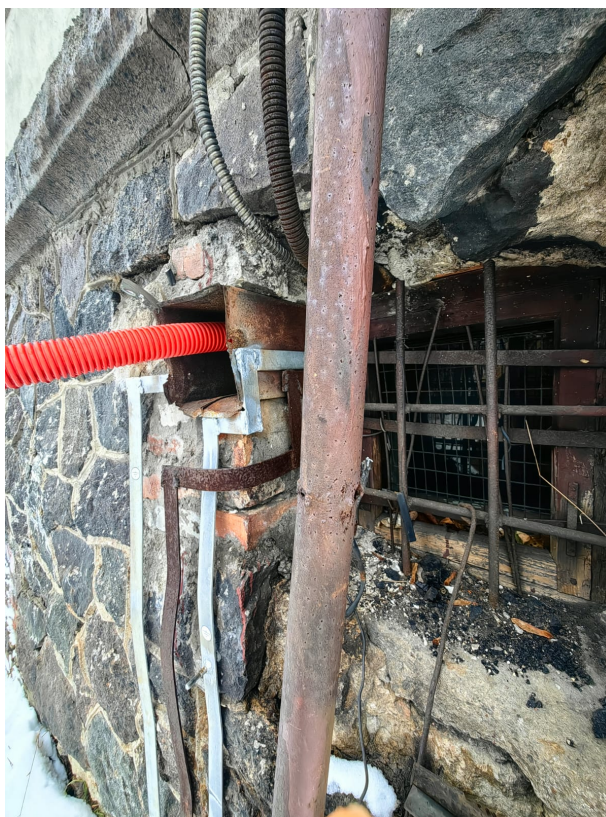
Фото 17. ОКН «Больница общины Святого Георгия» по адресу: г. Санкт-Петербург, г. Красное Село, пр. Двадцать Пятого Октября, д. 105, лит.А, Южный фасад. Дата съемки 09.01.2025
