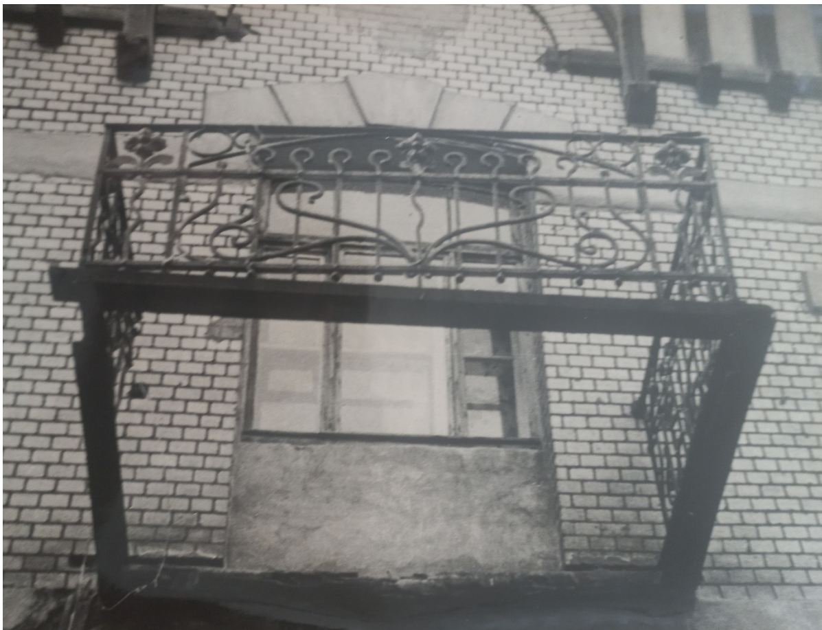
16.10 Решетка балкона Северного фасада.
