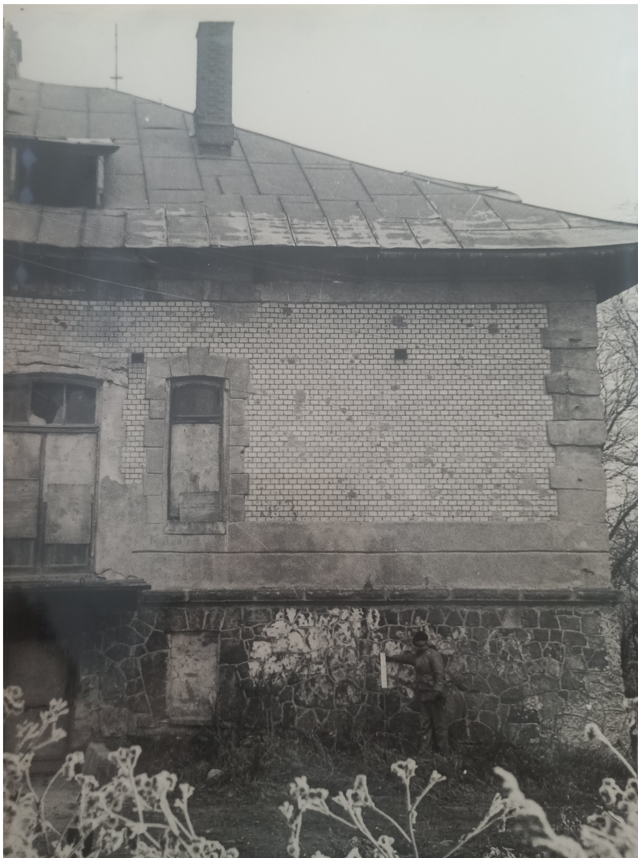
16.8 Западный фасад. Фрагмент.
