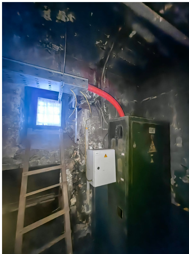
Фото 22. ОКН «Больница общины Святого Георгия» по адресу: г. Санкт-Петербург, г. Красное Село, пр. Двадцать Пятого Октября, д. 105, лит.А, помещение 1-Н. Дата съемки 09.01.2025
