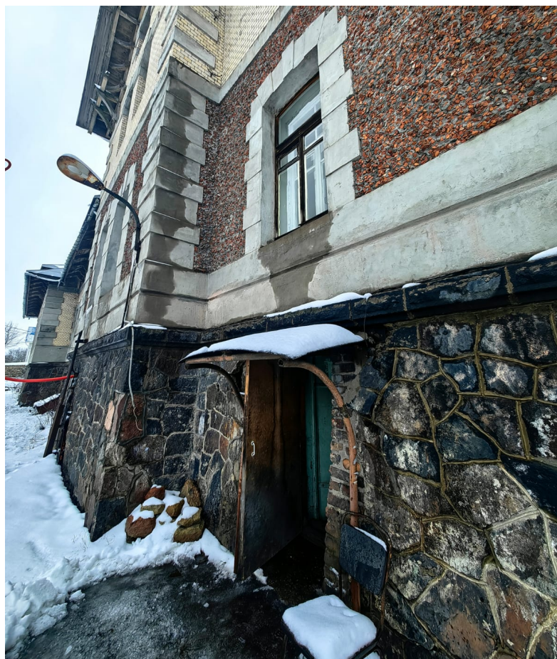
Фото 15. ОКН «Больница общины Святого Георгия» по адресу: г. Санкт-Петербург, г. Красное Село, пр. Двадцать Пятого Октября, д. 105, лит.А, Южный фасад. Дата съемки 09.01.2025
