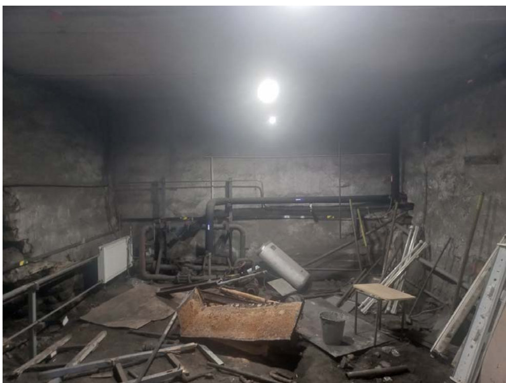
Фото 20. ОКН «Больница общины Святого Георгия» по адресу: г. Санкт-Петербург, г. Красное Село, пр. Двадцать Пятого Октября, д. 105, лит.А, Помещение 2-Н . Дата съемки 17.07.2024
