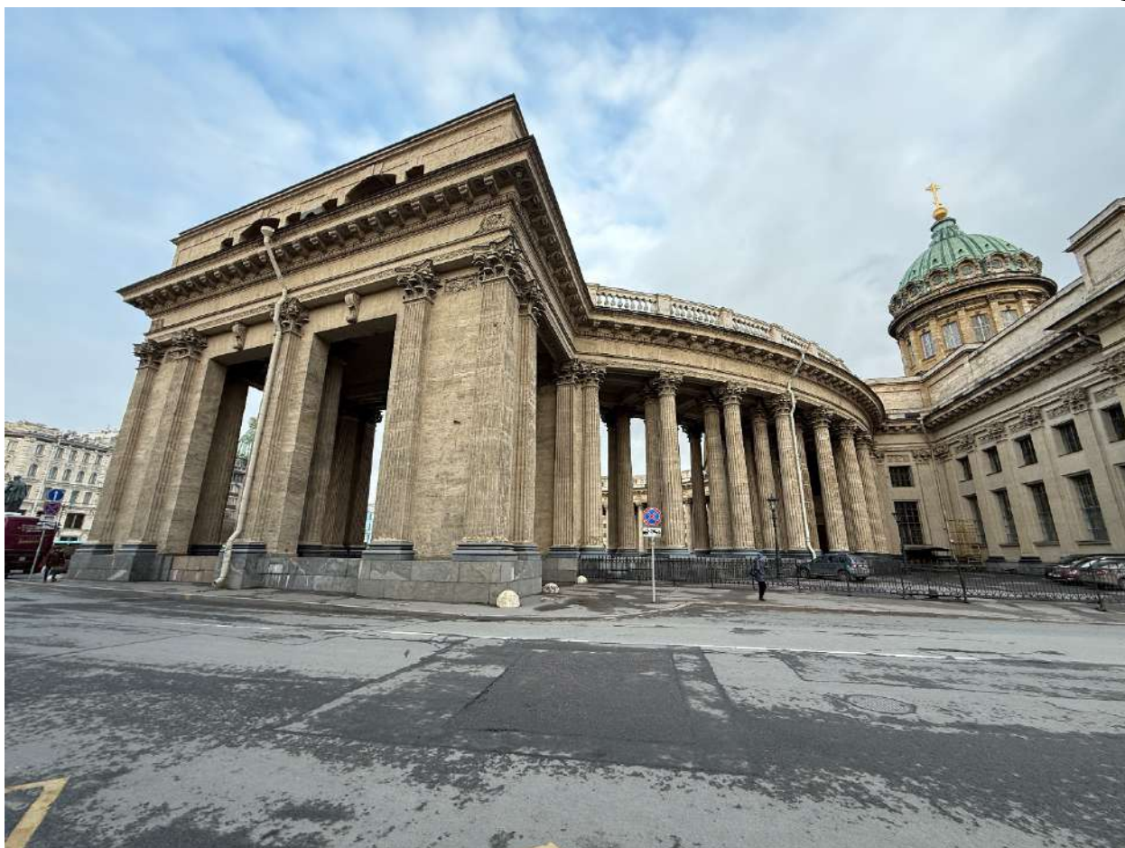
Фото 9. Общий вид на объект культурного наследия федерального значения «Собор Казанский». Дата фотофиксации: 09.04.2025г.
