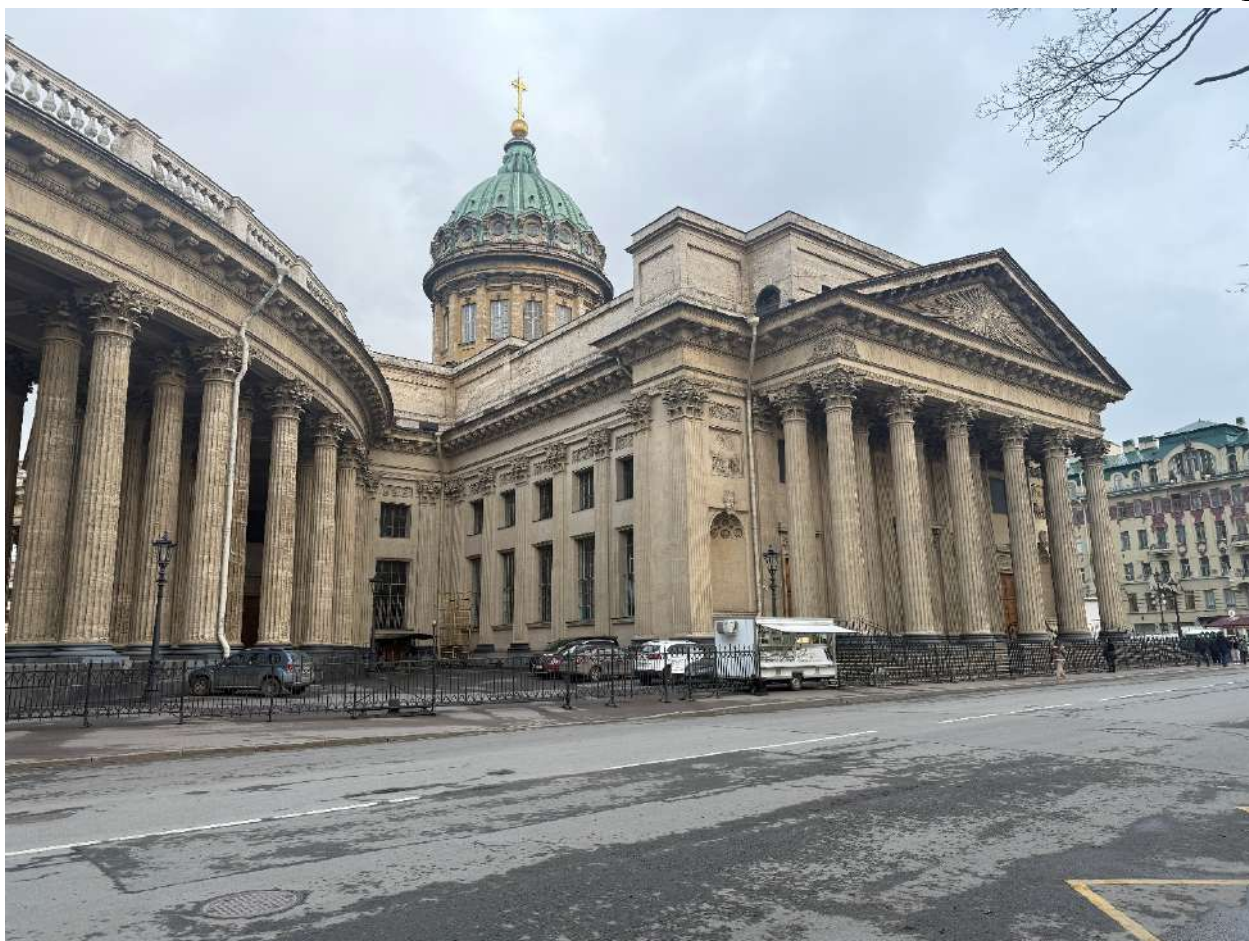
Фото 11. Общий вид на объект культурного наследия федерального значения «Собор Казанский». Дата фотофиксации: 09.04.2025г.
