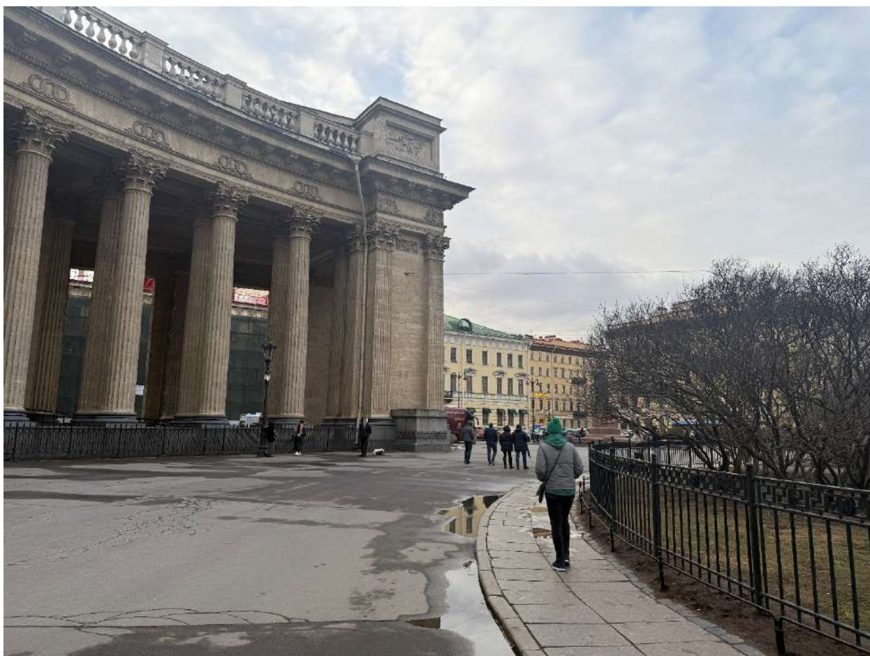
Фото 8. Общий вид на территорию проектирования. Дата фотофиксации: 09.04.2025г.
