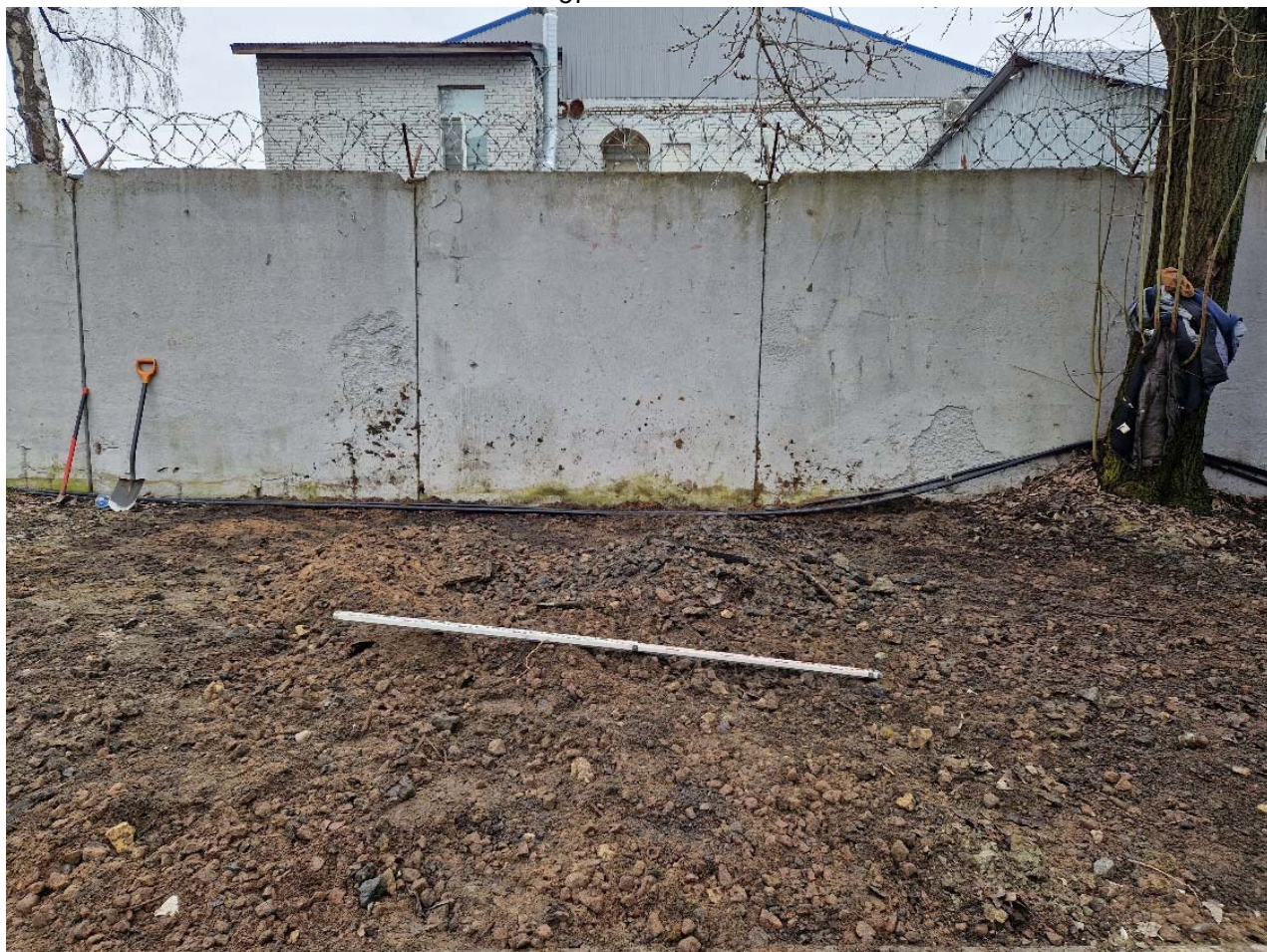
Рис. 21. СПб-2025. Выборгский район, Литовская ул. Шурф 1. Общий вид. Рекультивация. Вид с севера
