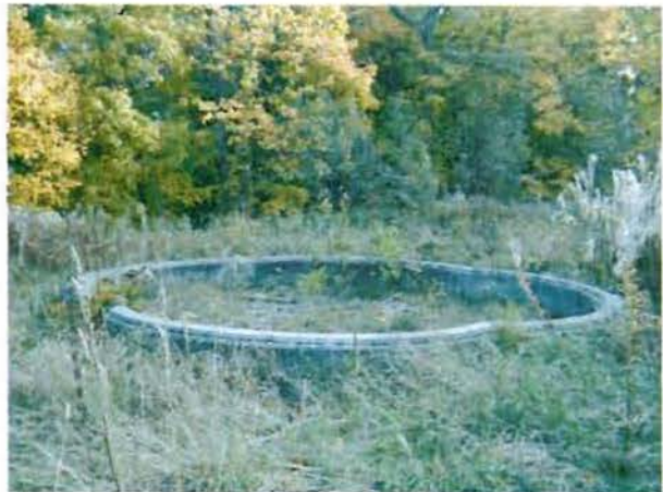
Бассейн фонтана. Фотография. 2015
