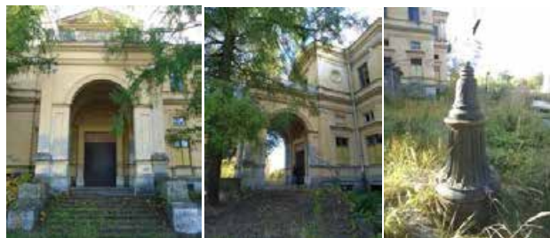
Главный подъезд Большого дворца. Тумба фонаря. Фотография. 2015
