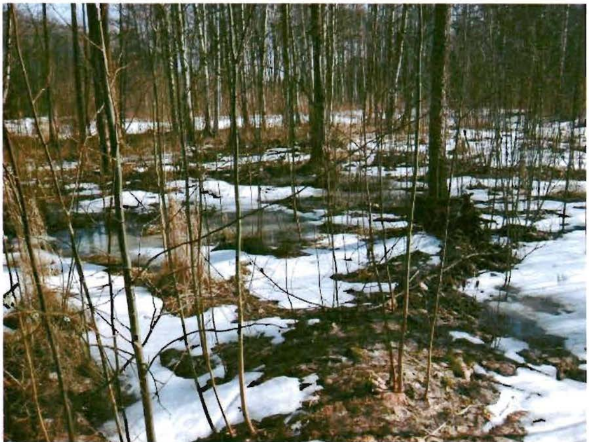
3,4. Юго-западная часть объекта культурного наследия федерального значения «Парк». Дренажно-мелиоративная сеть
