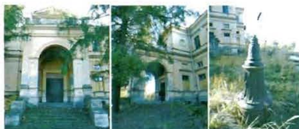
Главный подъезд Большого дворца. Тумба фонаря. Фотография. 2015
