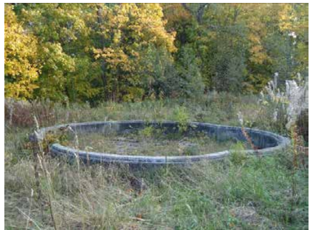
Бассейн фонтана. Фотография. 2015
