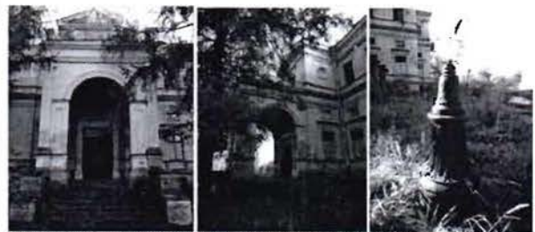
Главный подъезд Большого дворца. Тумба фонаря. Фотография. 2015
