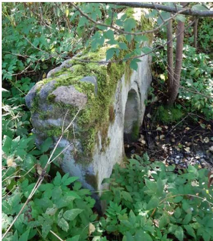
Фото 21. Вид на бетонный оголовок трубы.
