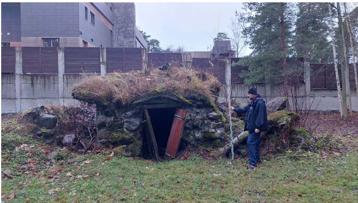
Илл. 25. Санкт-Петербург, Сестрорецк, ул. Андреева, д.12, лит. А. Точка фотофиксации № 9. Вид с востока. Для масштаба использована рейка длиной 2 м.
