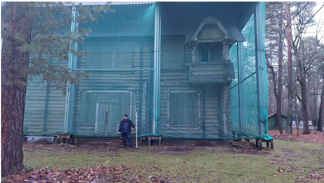
Илл. 30. Санкт-Петербург, Сестрорецк, ул. Андреева, д.12, лит. А. Точка фотофиксации № 14. Вид с юга. Для масштаба использована рейка длиной 2 м.
