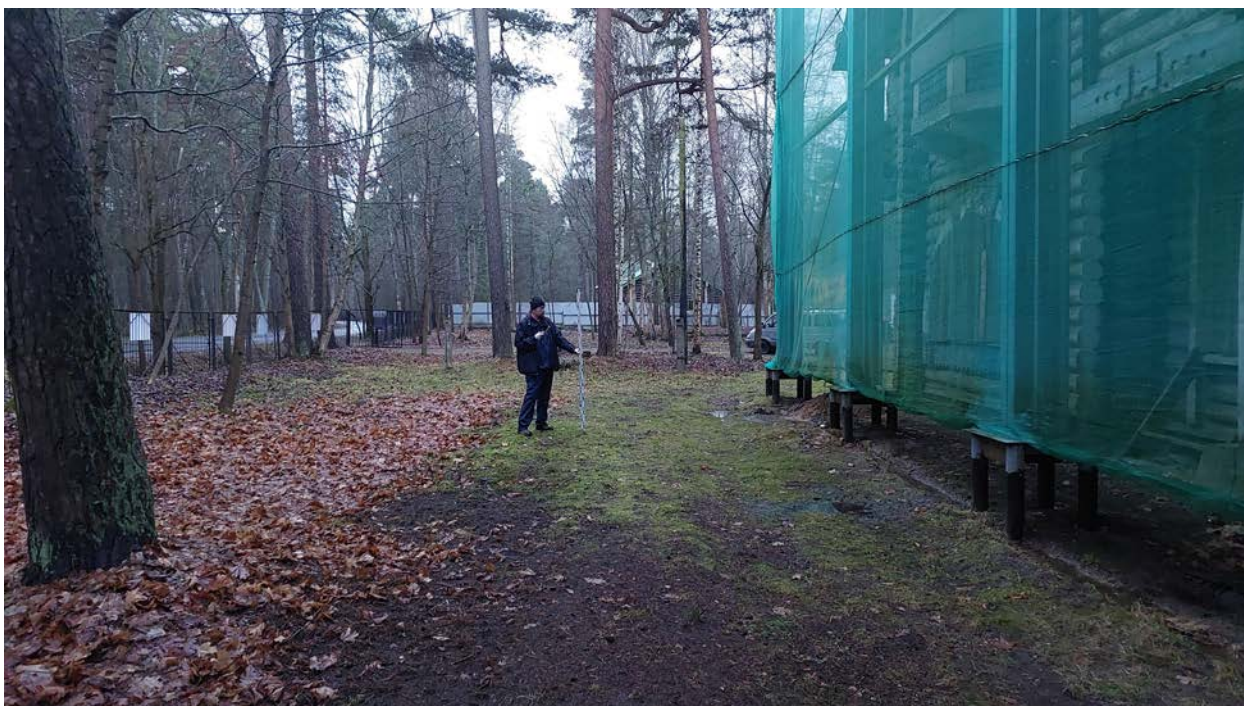
Илл. 29. Санкт-Петербург, Сестрорецк, ул. Андреева, д.12, лит. А. Точка фотофиксации № 13. Вид с севера. Для масштаба использована рейка длиной 2 м.
