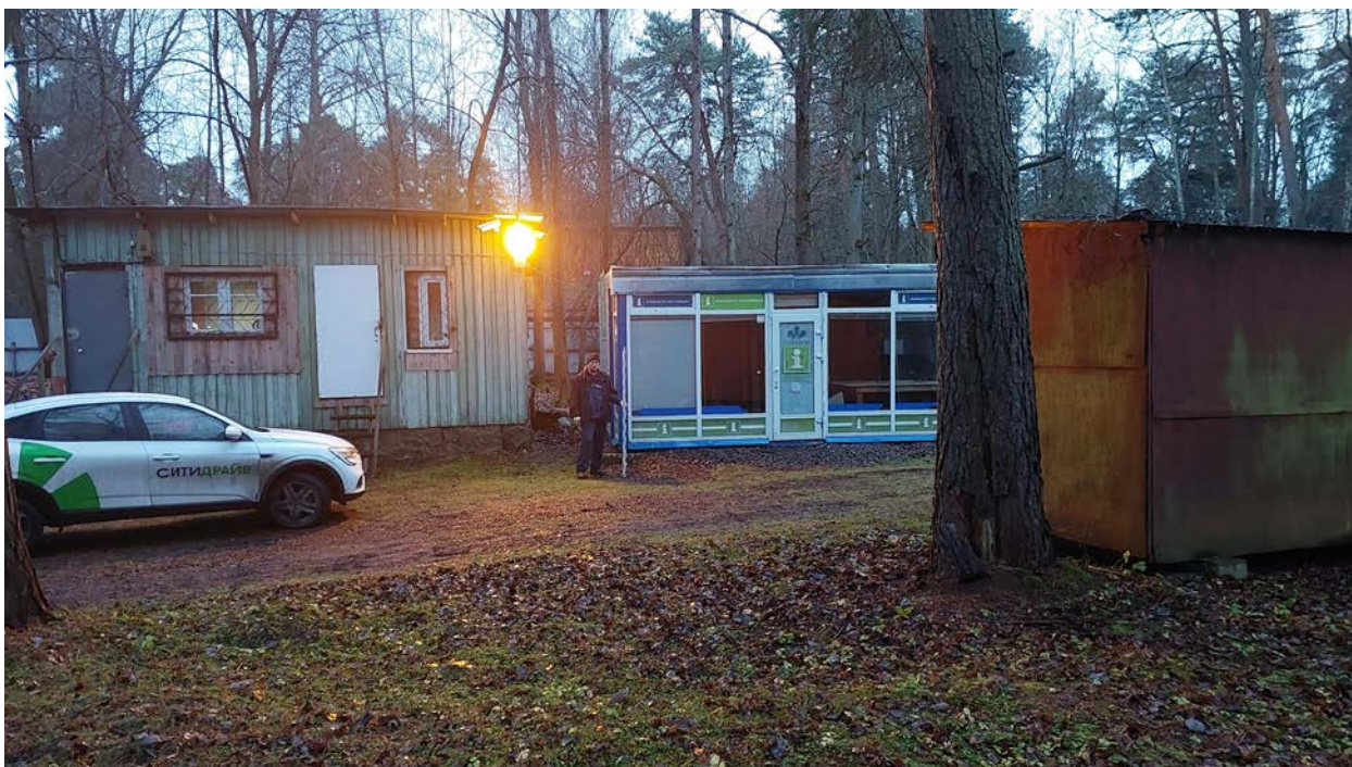
Илл. 31. Санкт-Петербург, Сестрорецк, ул. Андреева, д.12, лит. А. Точка фотофиксации № 15. Вид с севера. Для масштаба использована рейка длиной 2 м.
