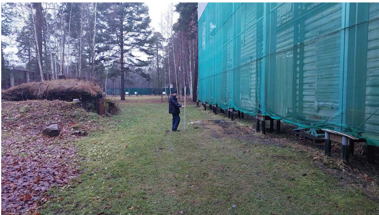
Илл. 24. Санкт-Петербург, Сестрорецк, ул. Андреева, д.12, лит. А. Точка фотофиксации № 8. Вид с юга. Для масштаба использована рейка длиной 2 м.
