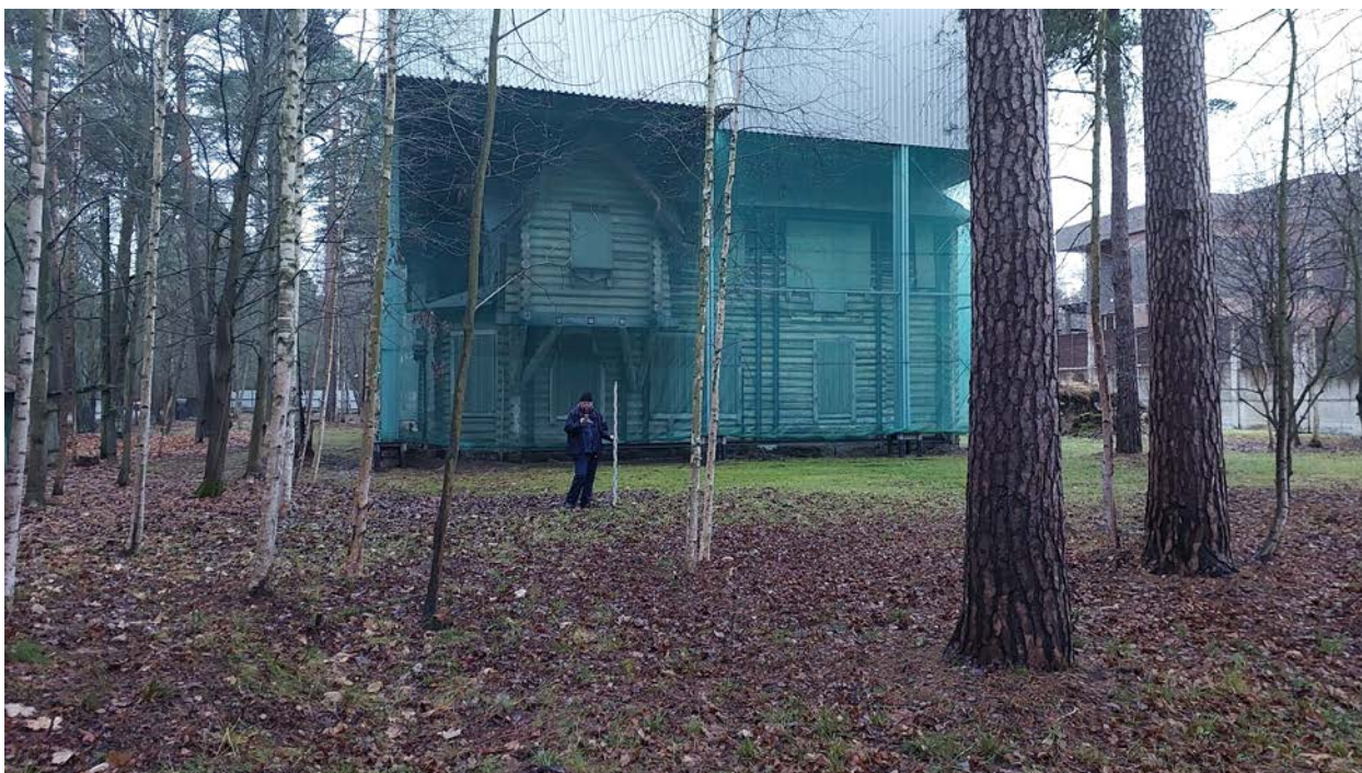
Илл. 28. Санкт-Петербург, Сестрорецк, ул. Андреева, д.12, лит. А. Точка фотофиксации № 12. Вид с севера. Для масштаба использована рейка длиной 2 м.
