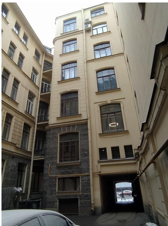
Фото 2. Северный фасад лицевого корпуса здания (со стороны двора). Вид на окно кв. №66 (окно в пом. 5)
