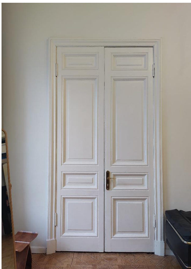
Фото 40. Дверь между помещениями № 13 и № 16.
