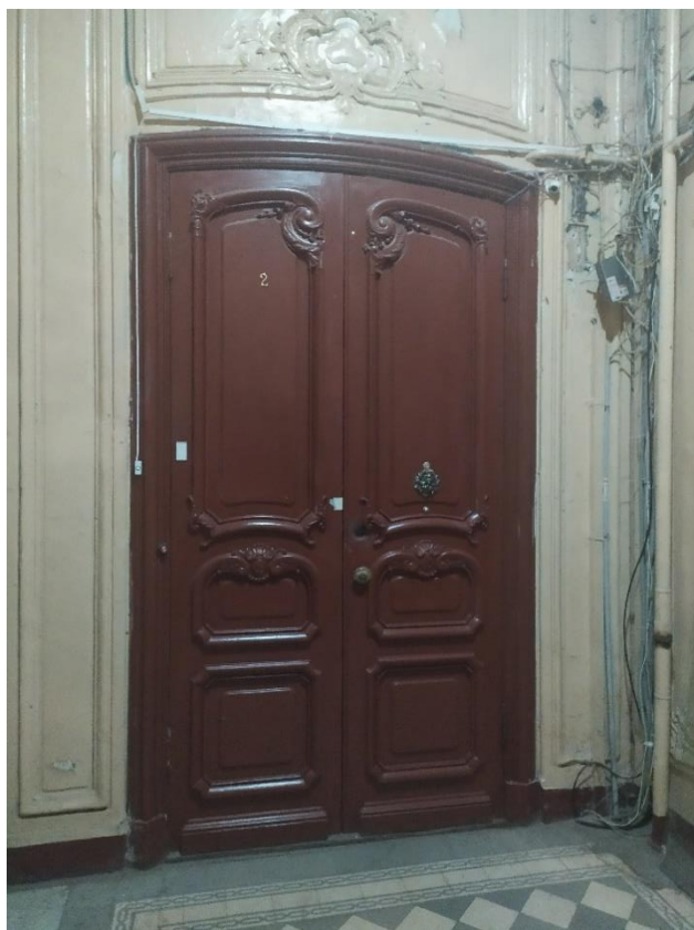
Фото 7. Входная дверь в кв. № 2.
