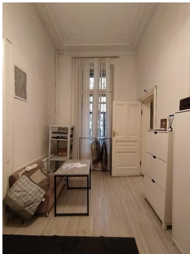
Фото 12. Вид на балконную дверь ДБ-3 в пом. № 1.
