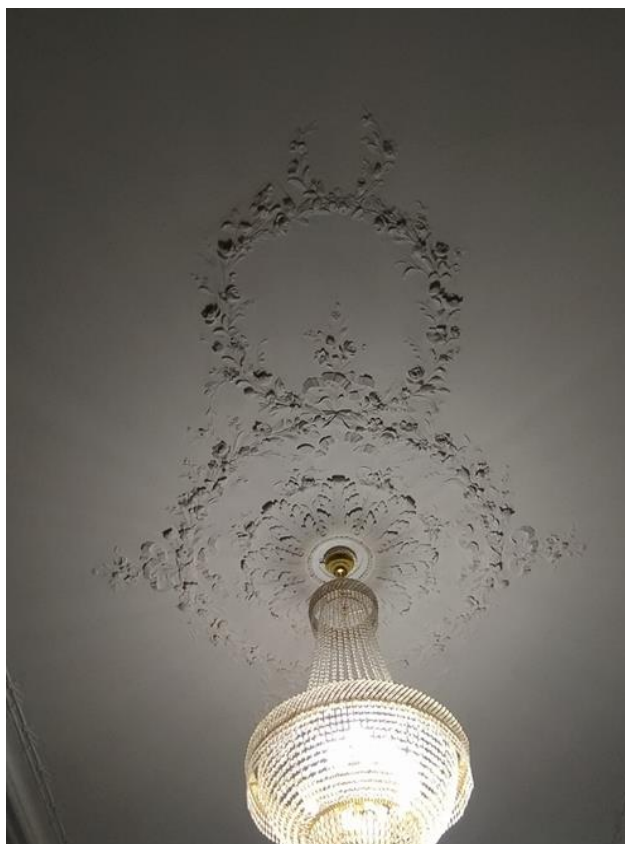
Фото 33. Потолочная розетка в пом. № 12, справа.
