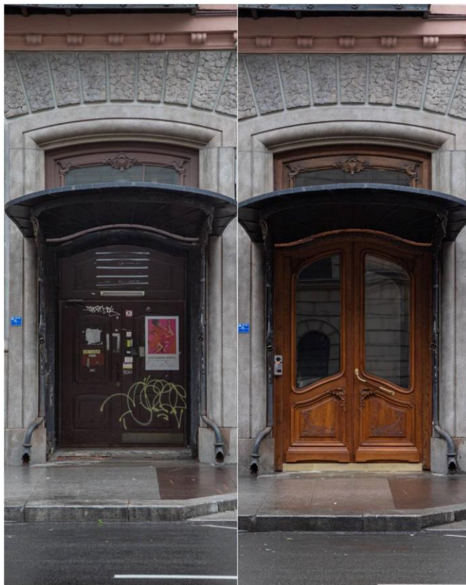
Илл. 40. Парадная дверь до и после реставрации. 2024 г. Источник: t.me/fondvnimanie .
