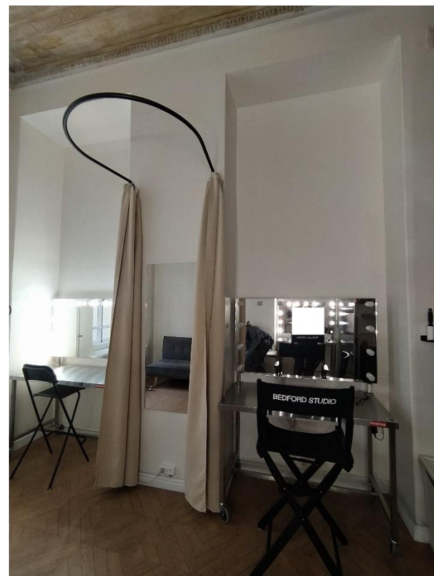
Фото 53. Вид на ниши в пом. № 19.
