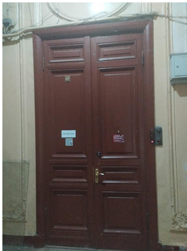
Фото 8. Входная дверь в кв. № 66.
