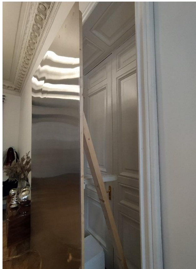
Фото 39. Дверь между помещениями № 12 и № 13.
