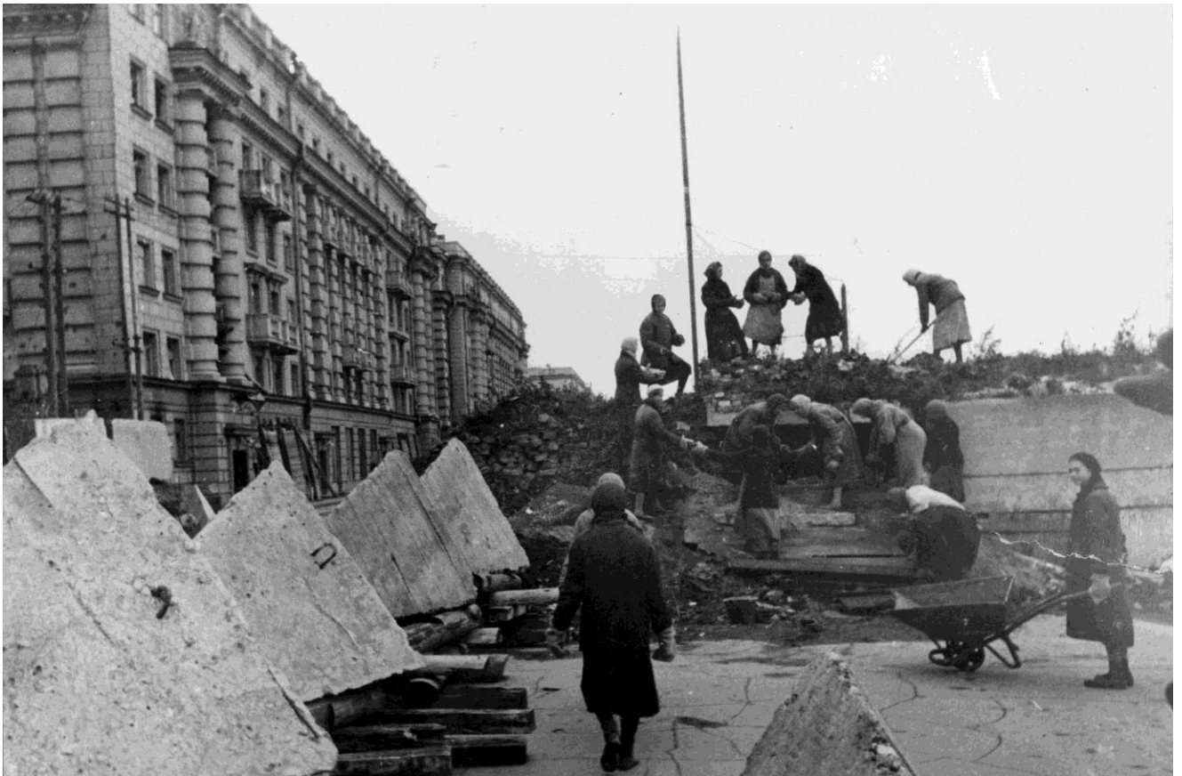
Илл. № 10. Фото 1942 г. Строительство оборонительных сооружений ленинградцами на Международном проспекте. ЦГАКФФД: Ар 209831 (1941-1942 гг., автор Кудояров Борис Павлович). Слева - дома №№ 163, 161 по Московскому пр. Интернет-ресурс https://pastvu.com .
