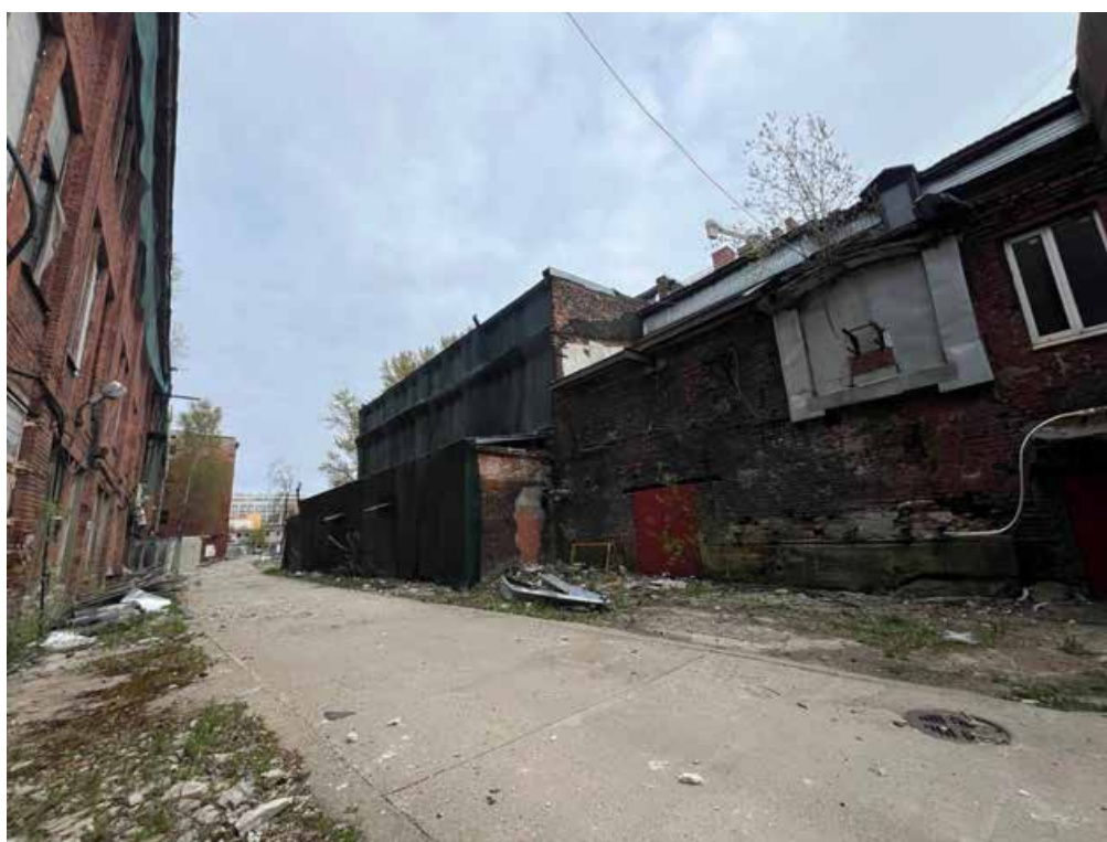
7. Вид на выявленный объект культурного наследия «Кожевенный завод А.А. Парамонова. Котельная», по адресу: г. Санкт-Петербург, Кожевенная линия, д. 1-3, литера Д, от зоны производства работ. 14.04.2025
