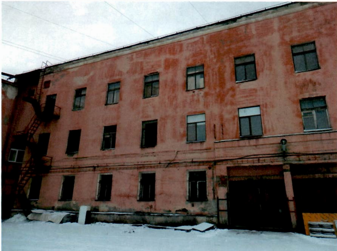
4. Восточный дворовый фасад
