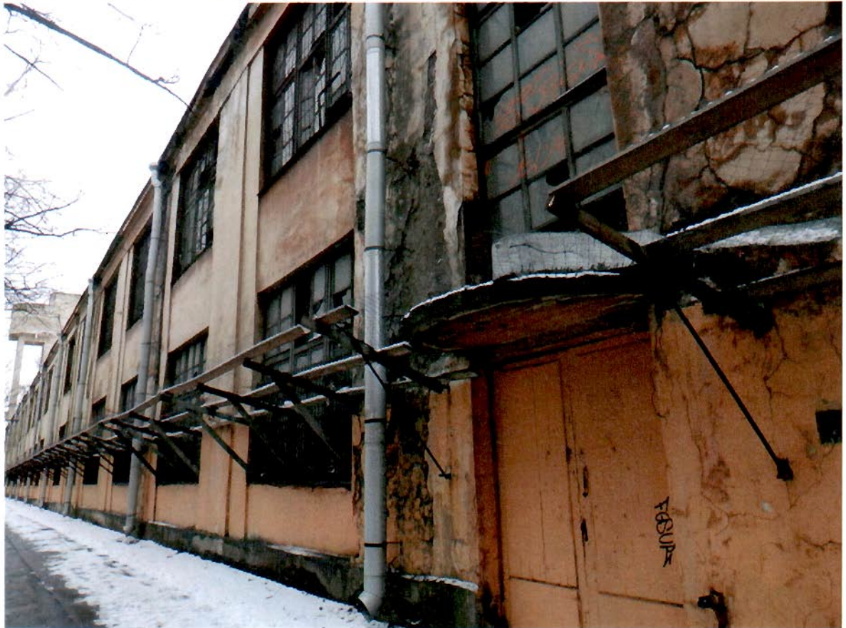
3. Лицевой фасад со стороны 25 линии В.О.
