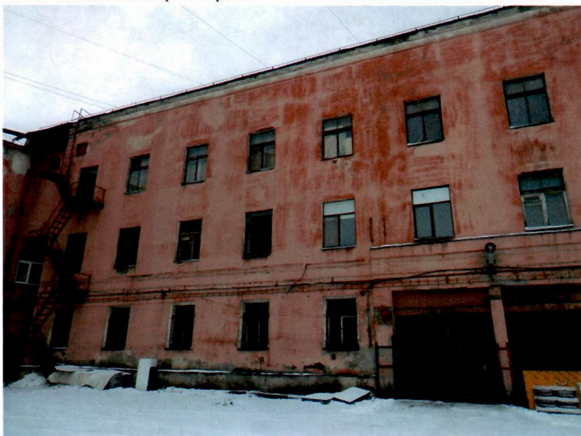
4. Восточный дворовый фасад
