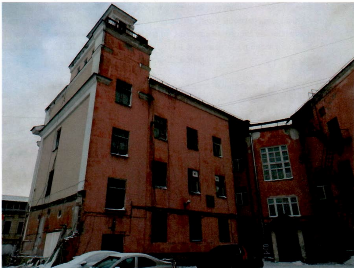
3. Северо-западный дворовый фасад
