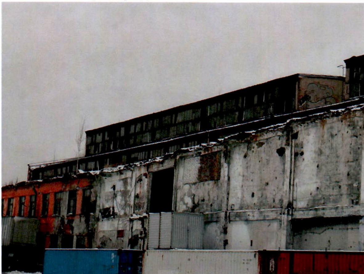
5. Западный дворовый фасад
