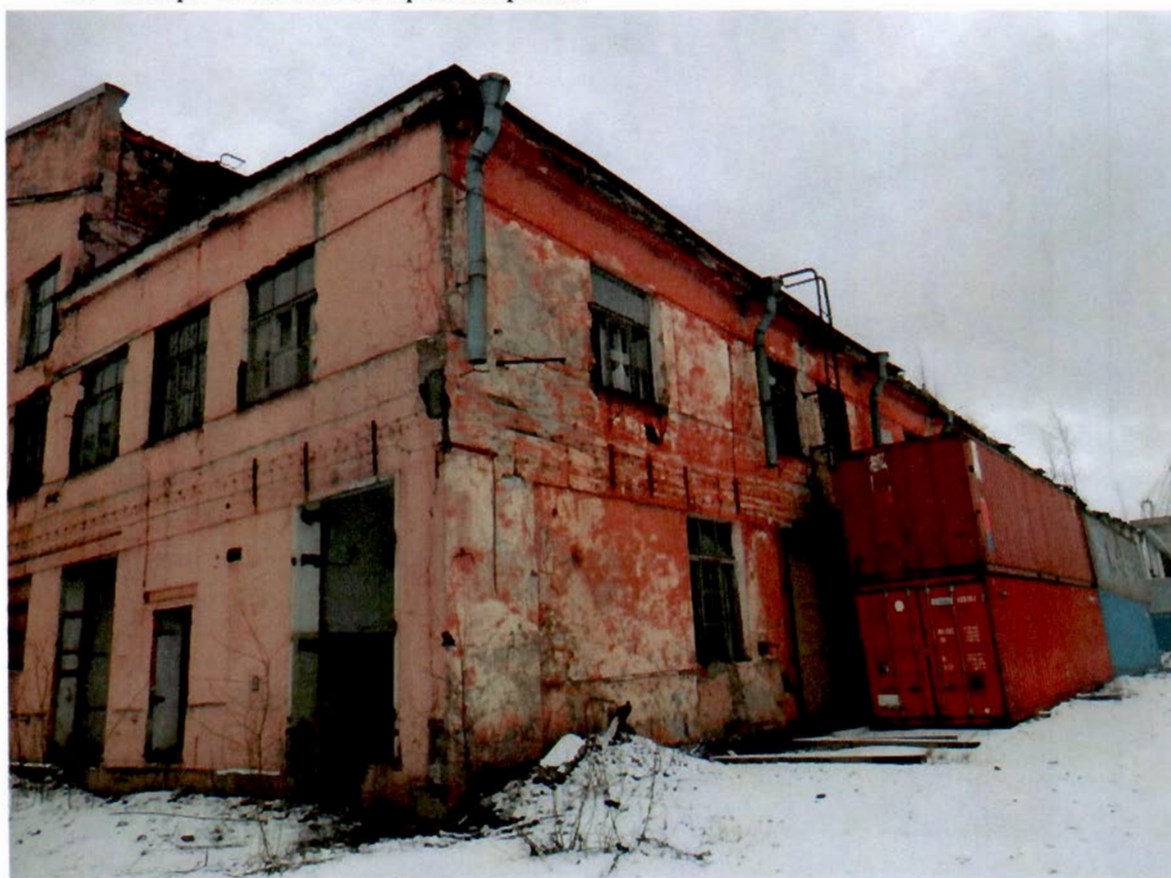
6. Северо-западный дворовый фасад
