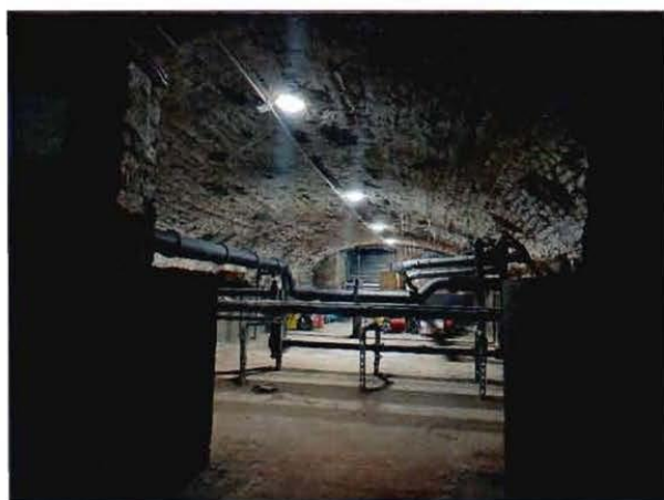
5. Подвалы объекта культурного наследия. Своды.
