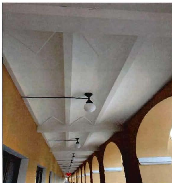
11. Фрагмент обходной галереи вдоль ул. Садовой. Своды
