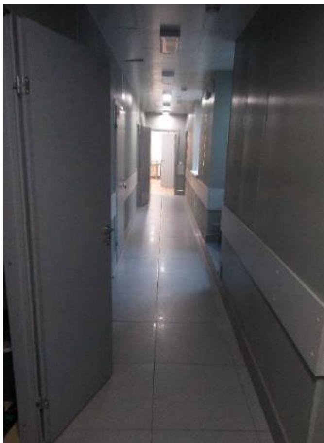
31. Помещение №3 (18-Н) в уровне 5-го этажа объекта культурного наследия регионального значения «Дом, где в ноябре 1895 г. была образована общегородская социал-демократическая организация «Союз борьбы за освобождение рабочего класса», расположенного по адресу: г. Санкт-Петербург, ул. Комсомола д. 12, литер Ж. 20.08.2024
