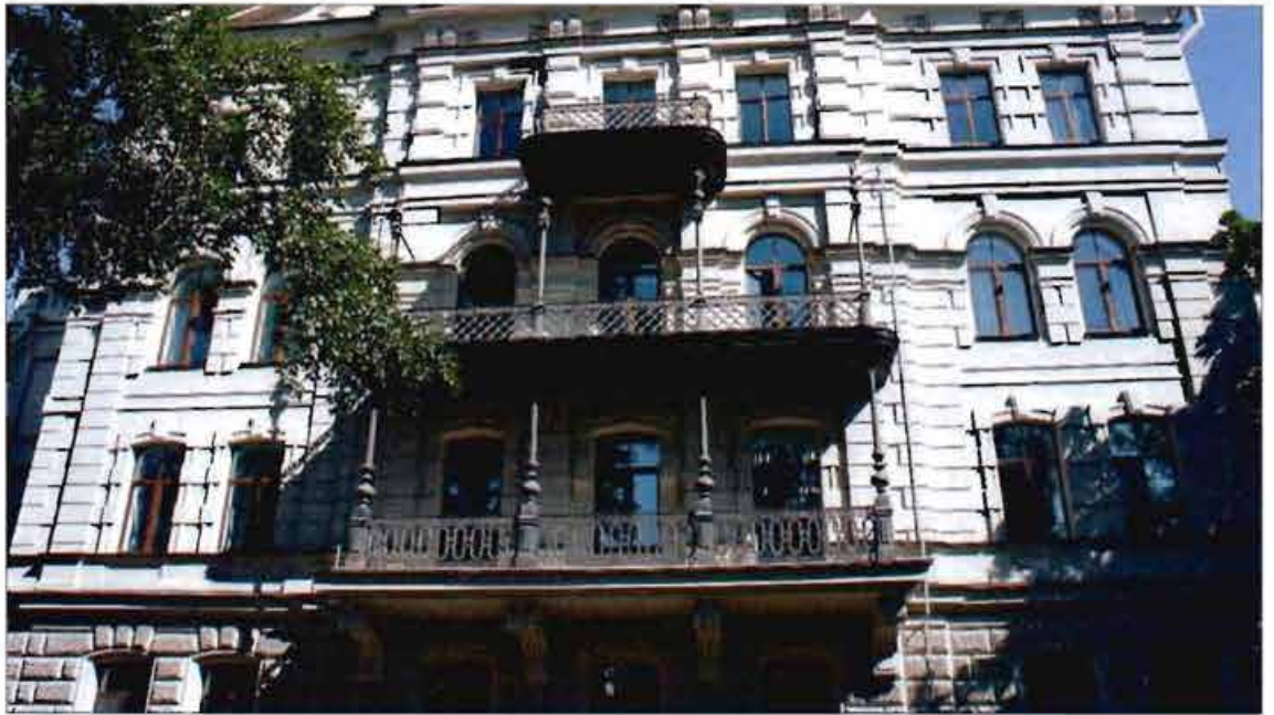
3. Южный фасад. Фрагмент. Трехъярусный балкон.
