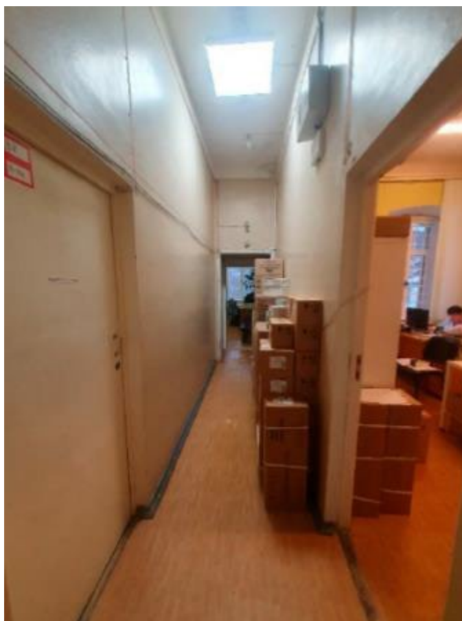
12. Помещение №13 (5-Н) в уровне 1-го этажа объекта культурного наследия регионального значения «Дом, где в ноябре 1895 г. была образована общегородская социал-демократическая организация «Союз борьбы за освобождение рабочего класса», расположенного по адресу: г. Санкт-Петербург, ул. Комсомола д. 12, литер Ж. 20.08.2024
