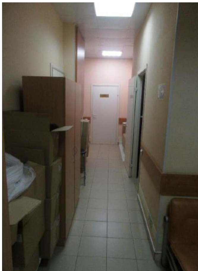
29. Помещение №12 (16-Н) в уровне 5-го этажа объекта культурного наследия регионального значения «Дом, где в ноябре 1895 г. была образована общегородская социал-демократическая организация «Союз борьбы за освобождение рабочего класса», расположенного по адресу: г. Санкт-Петербург, ул. Комсомола д. 12, литер Ж. 20.08.2024
