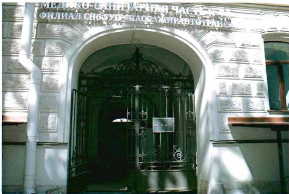
4. Воротный проезд со стороны восточного лицевого фасада.
