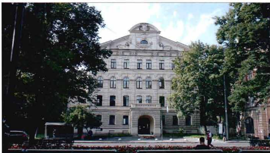
1. Лицевой фасад. Общий вид.
