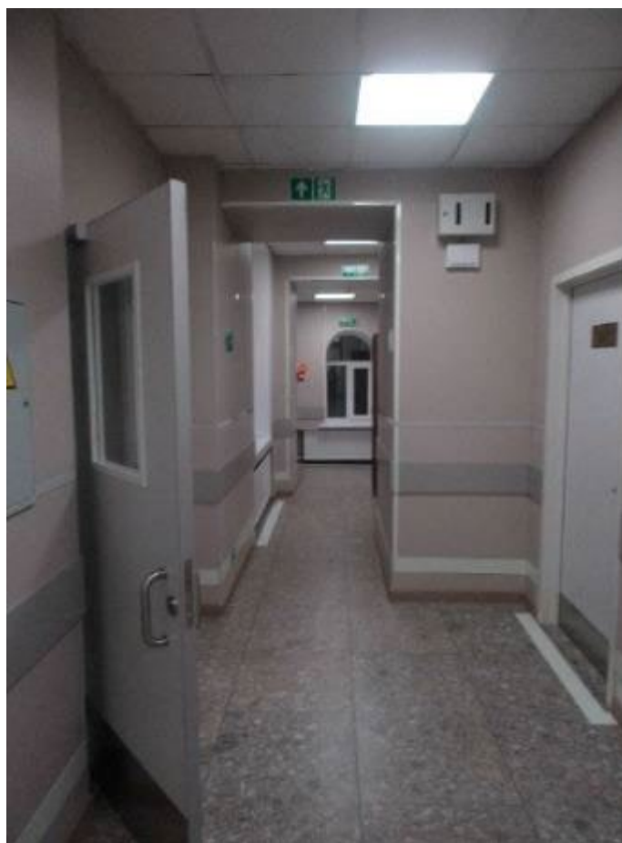
7. Помещение №4 (4-Н) в уровне 1-го этажа объекта культурного наследия регионального значения «Дом, где в ноябре 1895 г. была образована общегородская социал-демократическая организация «Союз борьбы за освобождение рабочего класса», расположенного по адресу: г. Санкт-Петербург, ул. Комсомола д. 12, литера Ж. 20.08.2024
