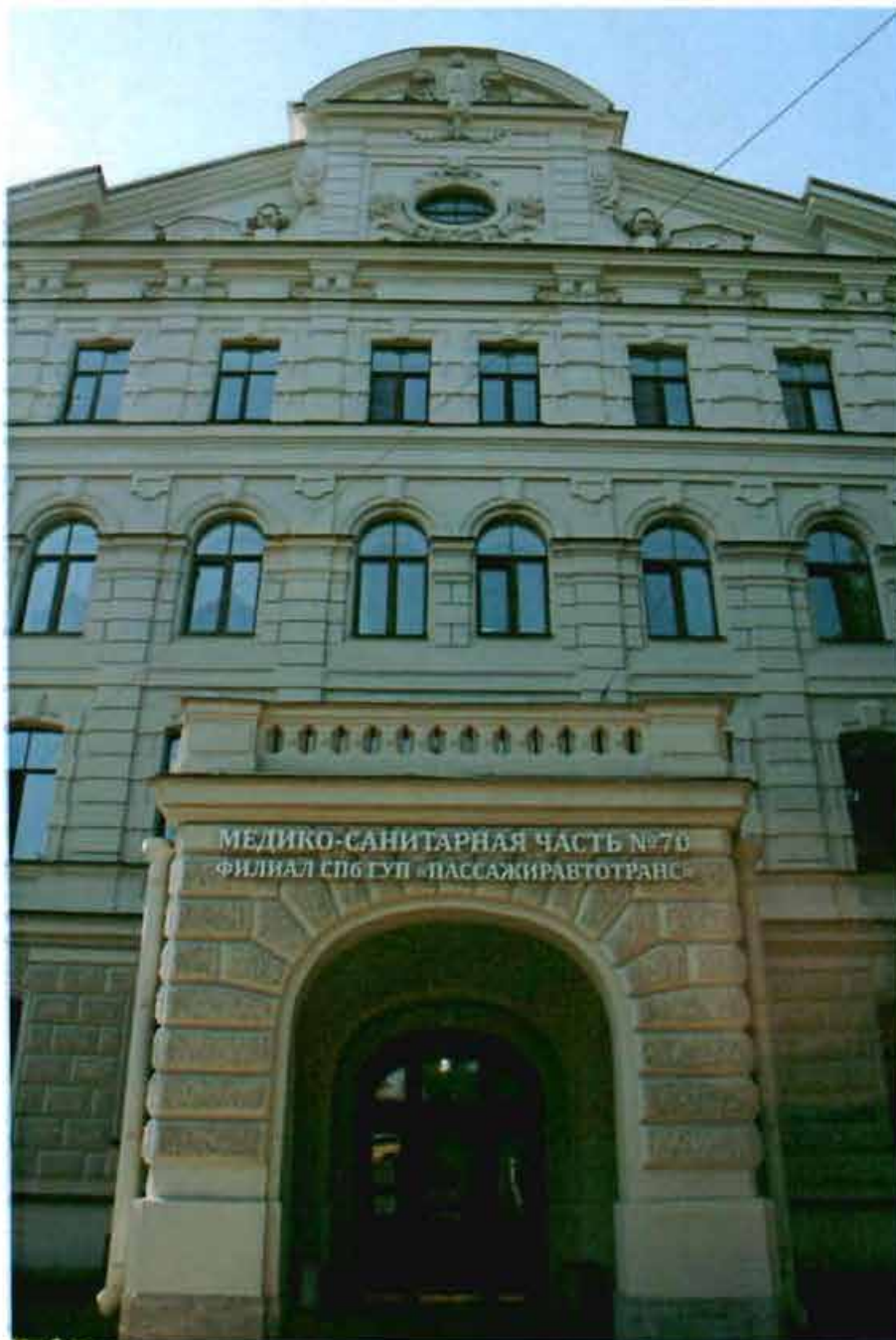
1. Крыльцо со стороны северного лицевого фасада.
