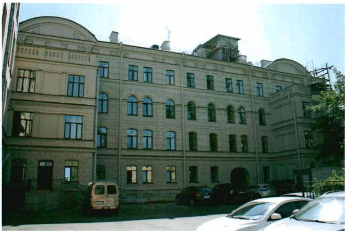
2. Западный лицевой фасад.
