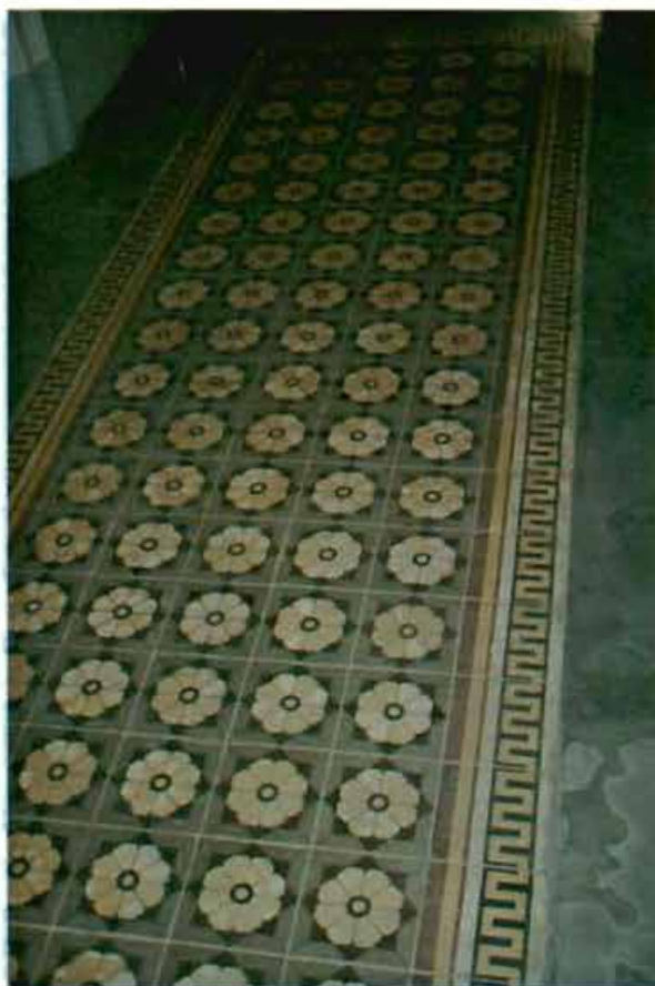
8. Метлахская плитка в парадном вестибюле.
