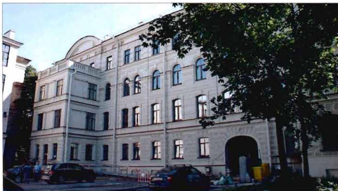
2. Западный фасад. Фрагмент.
