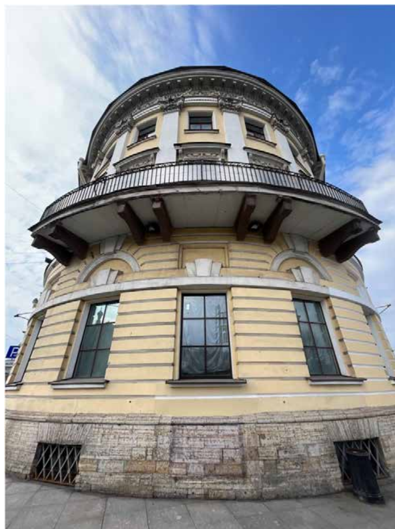
Фото №5. Угол северо-восточного и юго-западного лицевых фасадов, место устройства входа.
