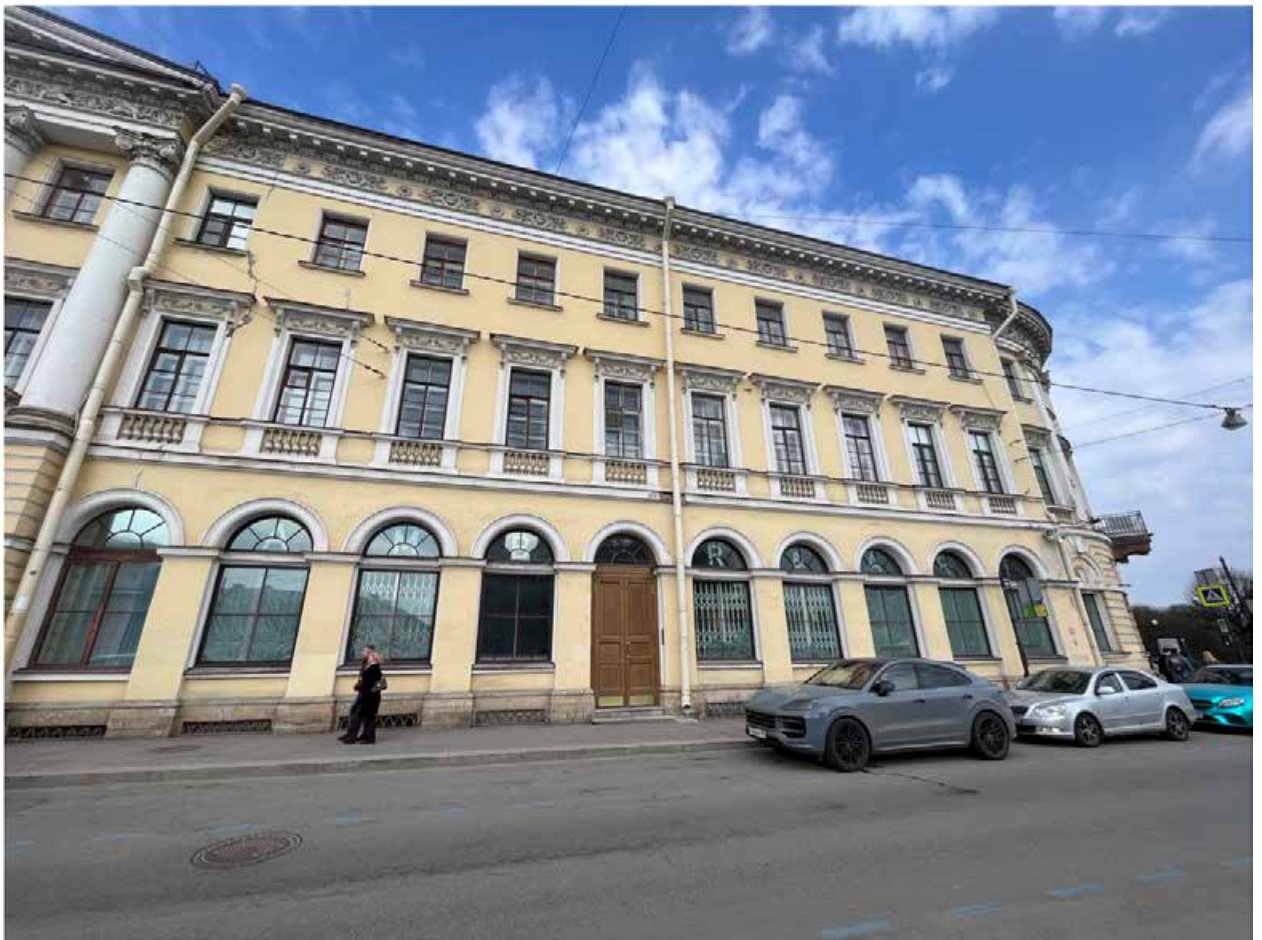
Фото №2. Юго-западный лицевой фасад.
