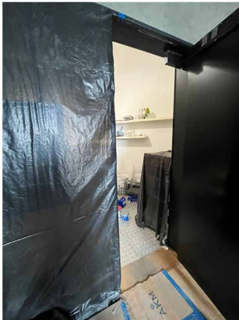
Фото №15. Вход в помещение 3.
