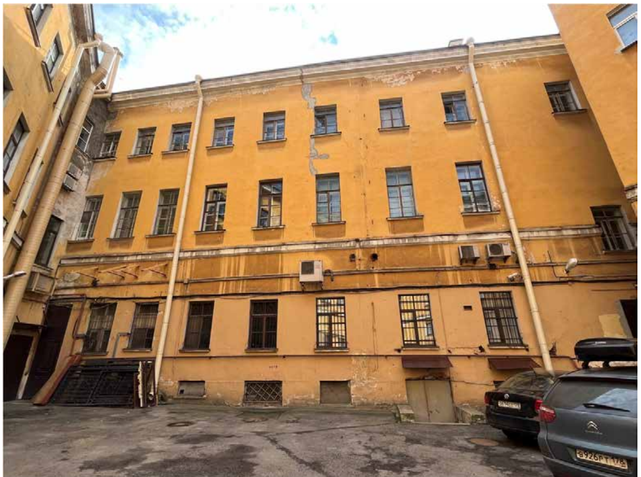
Фото №6. Северо-восточный дворовый фасад.
