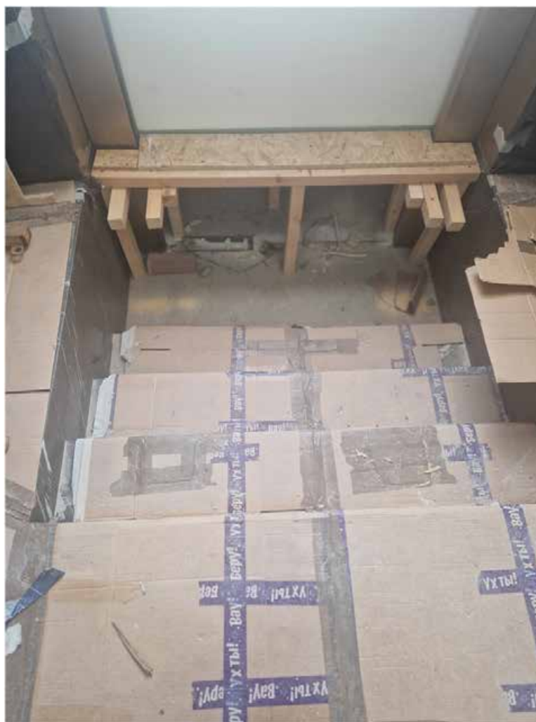
Фото №20. Помещение 5, ступени входа.
