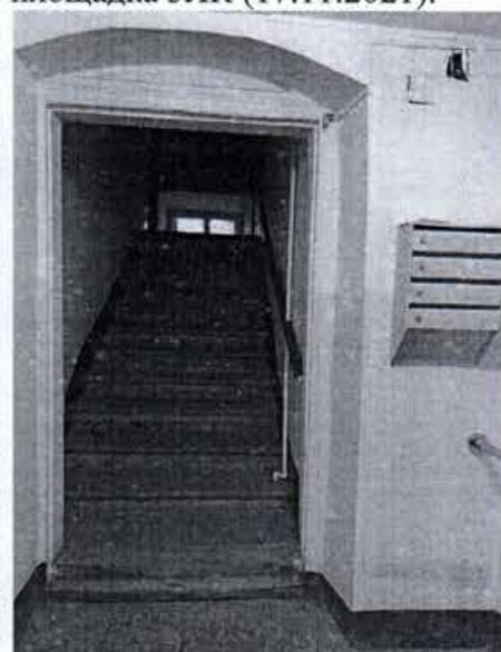
72. Промежуточная площадка 3ЛК (17.11.2021).
