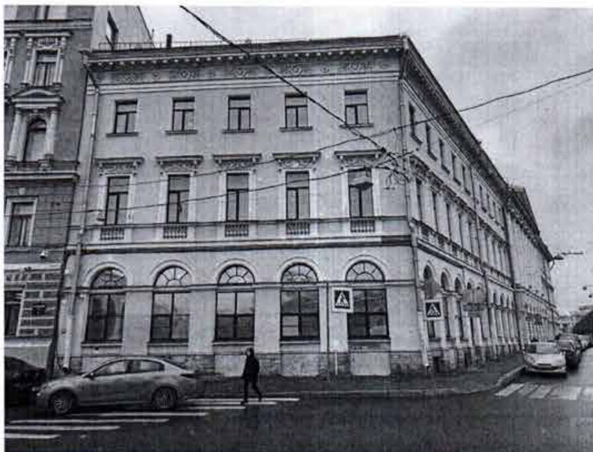
10. Западный лицевой фасад по Аптекарскому переулку (17.11.2021).
