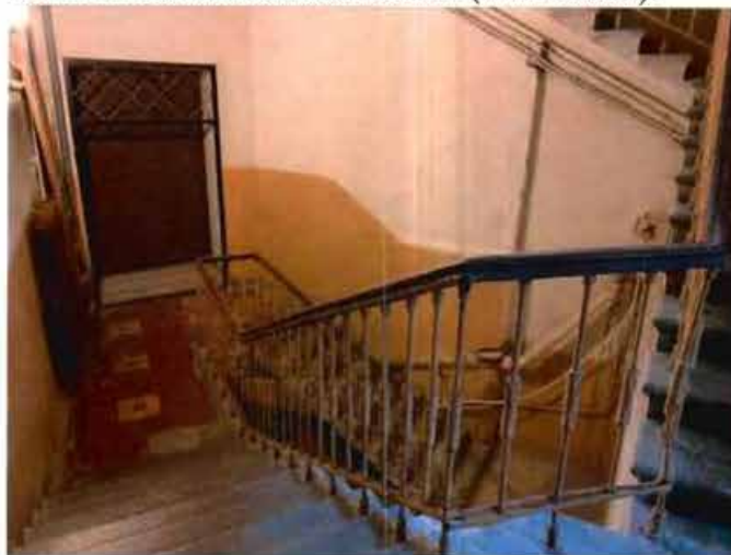
26-27. Лестничная клетка 2ЛК (17.11.2021).
