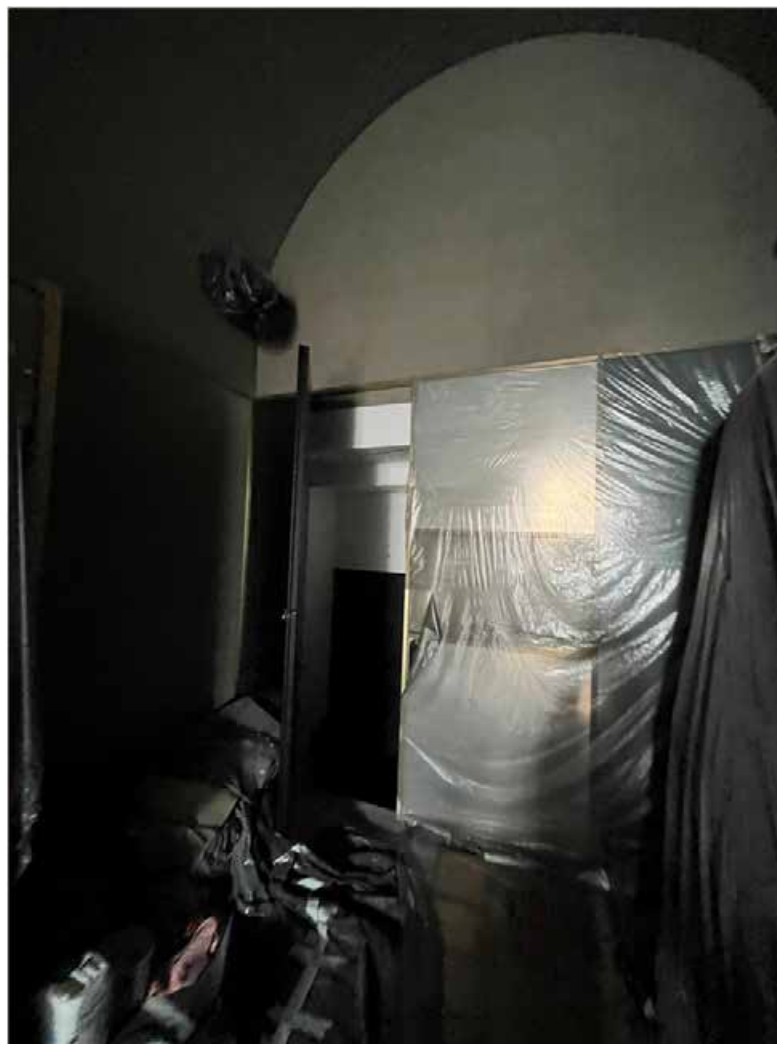
Фото №21. Помещение 1, вход.
