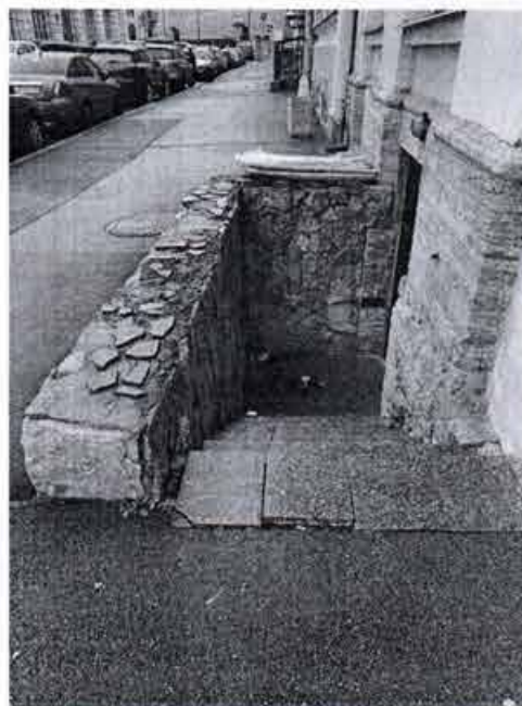
11. Прямок по западному лицевому фасаду (17.11.2021).
