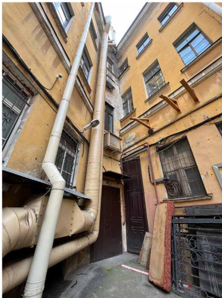
Фото №7. Северо-восточный дворовый фасад, фрагмент.
