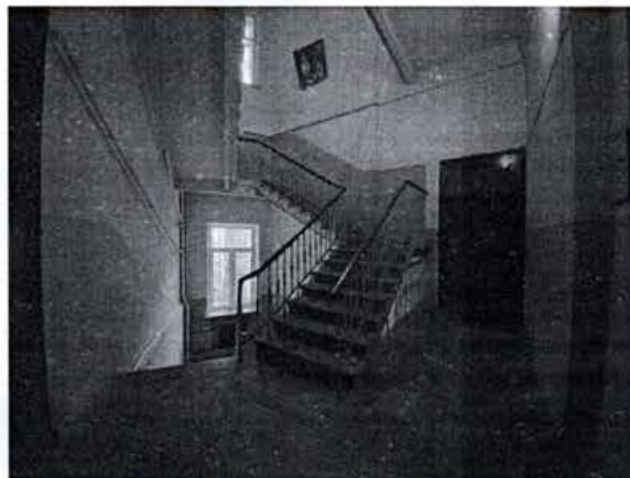
67-68. Лестничная клетка 2ЛК (17.11.2021).
