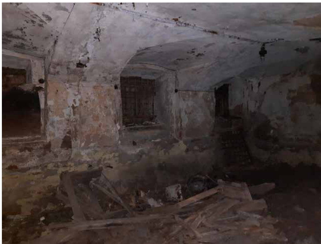
Фото №20. Помещение 0.6 ОКН РЗ «Дом С. Н. Завальевского-М.В. Северова», расположенный по адресу: Санкт-Петербург, муниципальный округ Коломна, пер. Пряильный, д. 12/163, литера А. Дата: 19.04.2025 г.
