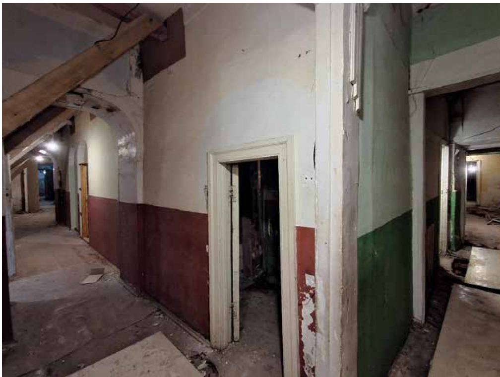
Фото №33. Помещения 1.37, 1.36 и 1.39 ОКН РЗ «Дом С. Н. Завальевского-М.В. Северова», расположенный по адресу: Санкт-Петербург, муниципальный округ Коломна, пер. Прядильный, д. 12/163, литера А. Дата: 19.04.2025 г.
