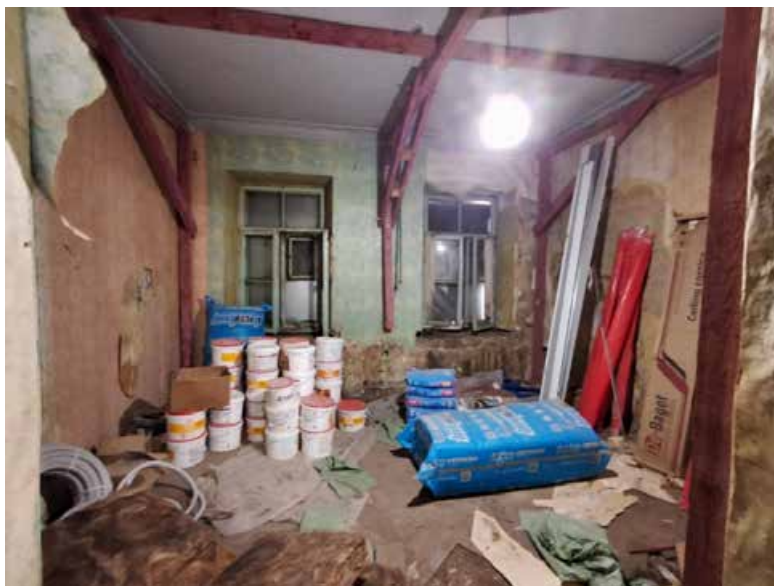
Фото №5. Помещение 1.20 ОКН РЗ «Дом С. Н. Завальевского-М.В. Северова», расположенный по адресу: Санкт-Петербург, муниципальный округ Коломна, пер. Пряильный, д. 12/163, литера А. Дата: 19.04.2025 г.
