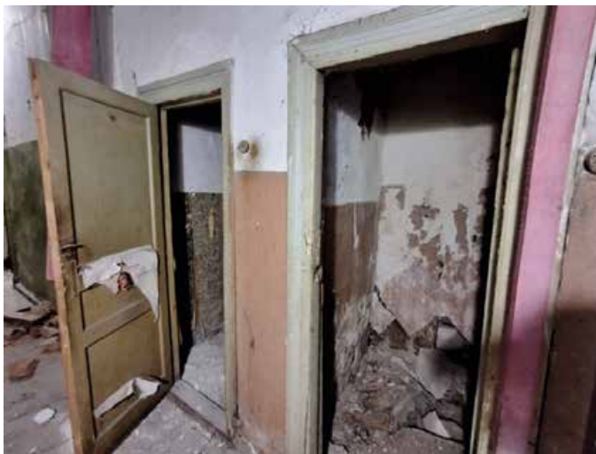
Фото №9. Помещения 2.36 и 2.37 ОКН РЗ «Дом С. Н. Завальевского-М.В. Северова», расположенный по адресу: Санкт-Петербург, муниципальный округ Коломна, пер. Прядильный, д. 12/163, литера А. Дата: 19.04.2025 г.
