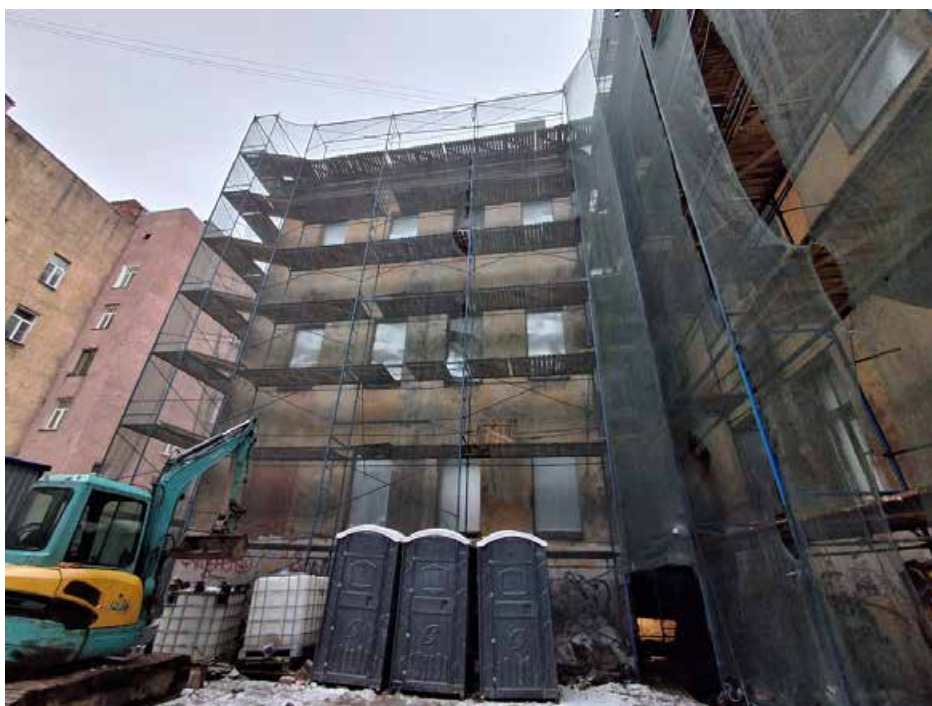
Фото №10. Дворовые фасады ОКН РЗ «Дом С. Н. Завальевского-М.В. Северова», расположенный по адресу: Санкт-Петербург, муниципальный округ Коломна, пер. Прядильный, д. 12/163, литера А. Дата: 19.04.2025 г.
