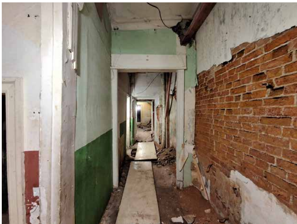
Фото №34. Помещения 1.39 и 1.41 ОКН РЗ «Дом С. Н. Завальевского-М.В. Северова», расположенный по адресу: Санкт-Петербург, муниципальный округ Коломна, пер. Прядильный, д. 12/163, литера А. Дата: 19.04.2025 г.
