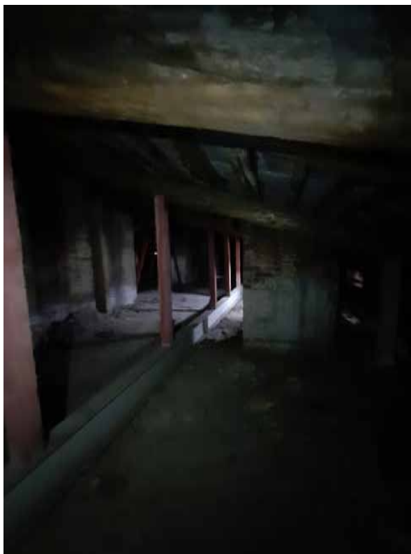
Фото №5. Помещение 4.2. ОКН РЗ «Дом С. Н. Завальевского-М.В. Северова», расположенный по адресу: Санкт-Петербург, муниципальный округ Коломна, пер. Прядильный, д. 12/163, литера А. 19.04.2025 г.
