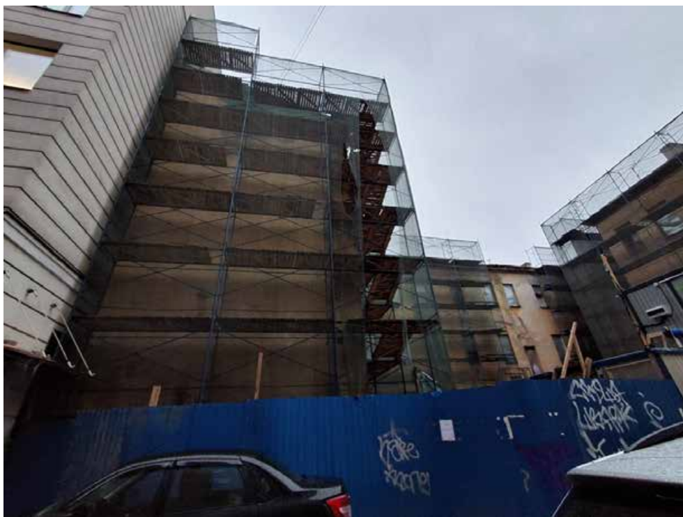
Фото №11. Дворовые фасады ОКН РЗ «Дом С. Н. Завальевского-М.В. Северова», расположенный по адресу: Санкт-Петербург, муниципальный округ Коломна, пер. Прядильный, д. 12/163, литера А. Дата: 19.04.2025 г.
