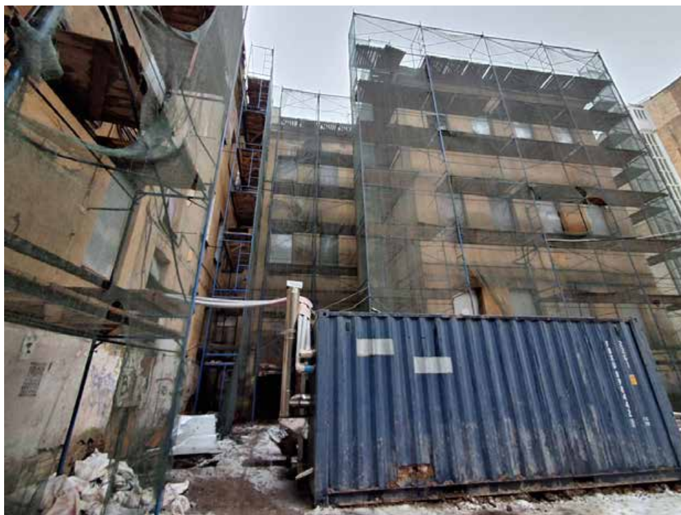
Фото №8. Дворовые фасады ОКН РЗ «Дом С. Н. Завальевского-М.В. Северова», расположенный по адресу: Санкт-Петербург, муниципальный округ Коломна, пер. Прядильный, д. 12/163, литера А. Дата: 19.04.2025 г.
