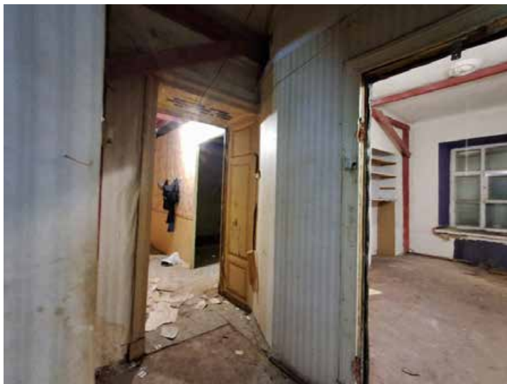
Фото №17. Помещения 1.30 и 1.31 ОКН РЗ «Дом С. Н. Завальевского-М.В. Северова», расположенный по адресу: Санкт-Петербург, муниципальный округ Коломна, пер. Прядильный, д. 12/163, литера А. Дата: 19.04.2025 г.
