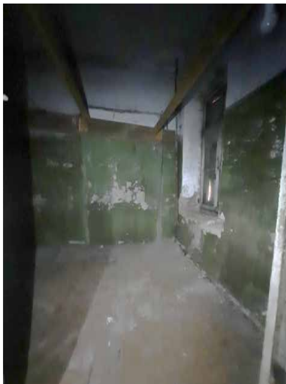
Фото №11. Помещения 3.30 и 3.34 ОКН РЗ «Дом С. Н. Завальевского-М.В. Северова», расположенный по адресу: Санкт-Петербург, муниципальный округ Коломна, пер. Прядильный, д. 12/163, литера А. Дата: 19.04.2025 г.
