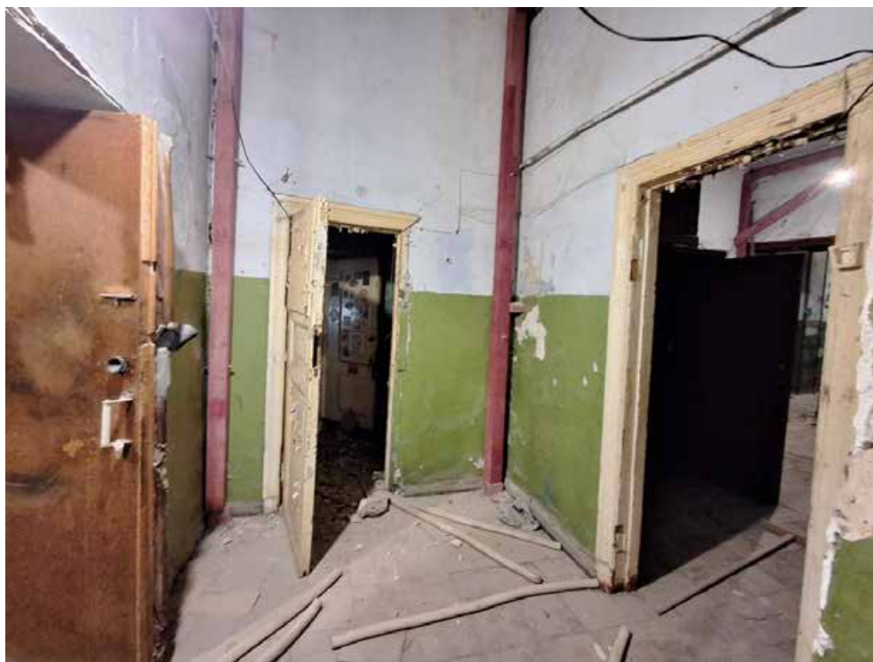
Фото №23. Помещения 2.4 и 2.5 ОКН РЗ «Дом С. Н. Завальевского-М.В. Северова», расположенный по адресу: Санкт-Петербург, муниципальный округ Коломна, пер. Прядильный, д. 12/163, литера А. Дата: 19.04.2025 г.
