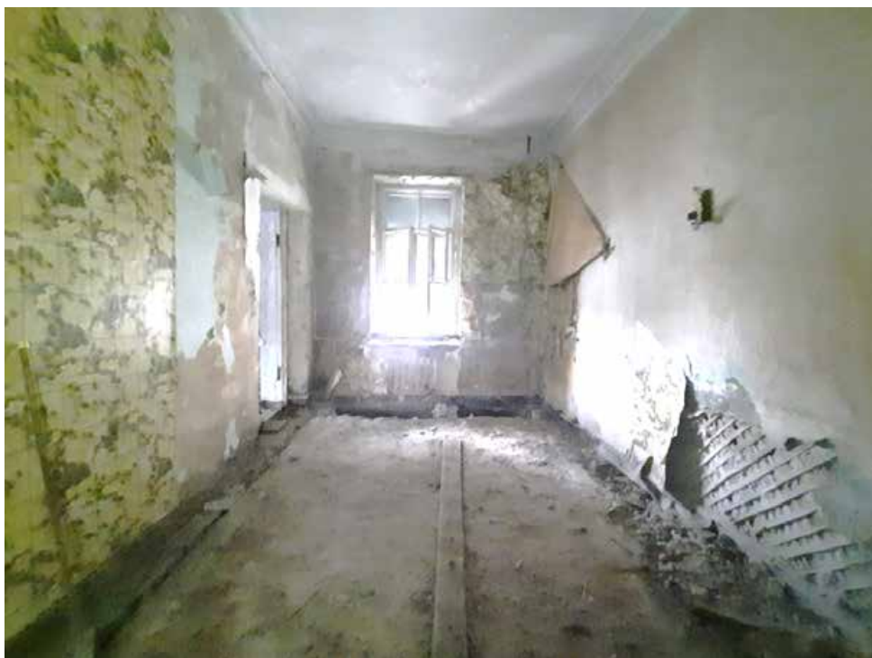
Фото №29. Помещение 3.18 ОКН РЗ «Дом С. Н. Завальевского-М.В. Северова», расположенный по адресу: Санкт-Петербург, муниципальный округ Коломна, пер. Пряильный, д. 12/163, литера А. Дата: 19.04.2025 г.
