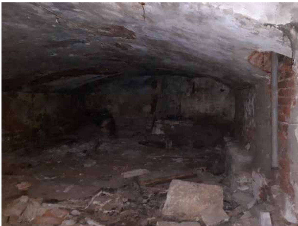
Фото №19. Помещение 0.14 ОКН РЗ «Дом С. Н. Завальевского-М.В. Северова», расположенный по адресу: Санкт-Петербург, муниципальный округ Коломна, пер. Пряильный, д. 12/163, литера А. Дата: 19.04.2025 г.
