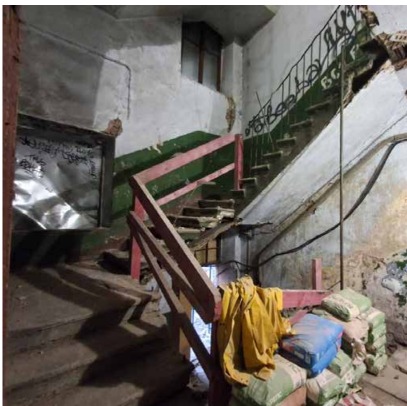
Фото №6. Помещение 1.12 ОКН РЗ «Дом С. Н. Завальевского-М.В. Северова», расположенный по адресу: Санкт-Петербург, муниципальный округ Коломна, пер. Пряильный, д. 12/163, литера А. Дата: 01.04.2025 г.
