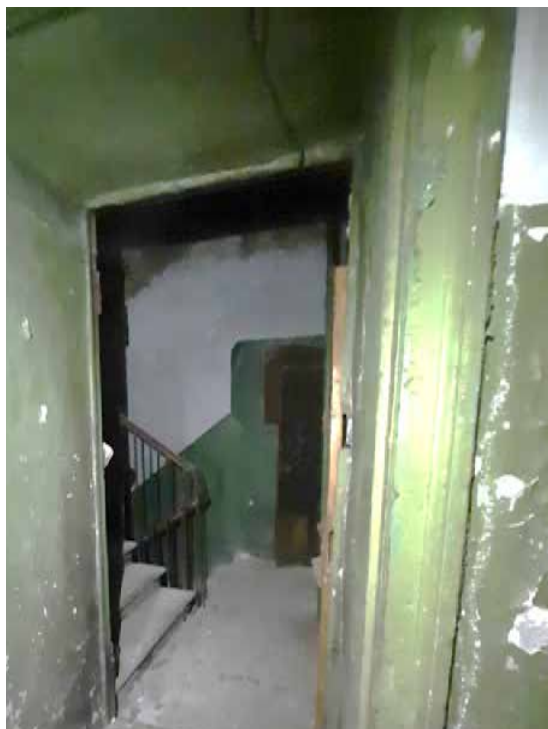
Фото №7. Помещения 3.39 и 3.36 ОКН РЗ «Дом С. Н. Завальевского-М.В. Северова», расположенный по адресу: Санкт-Петербург, муниципальный округ Коломна, пер. Прядильный, д. 12/163, литера А. Дата: 19.04.2025 г.
