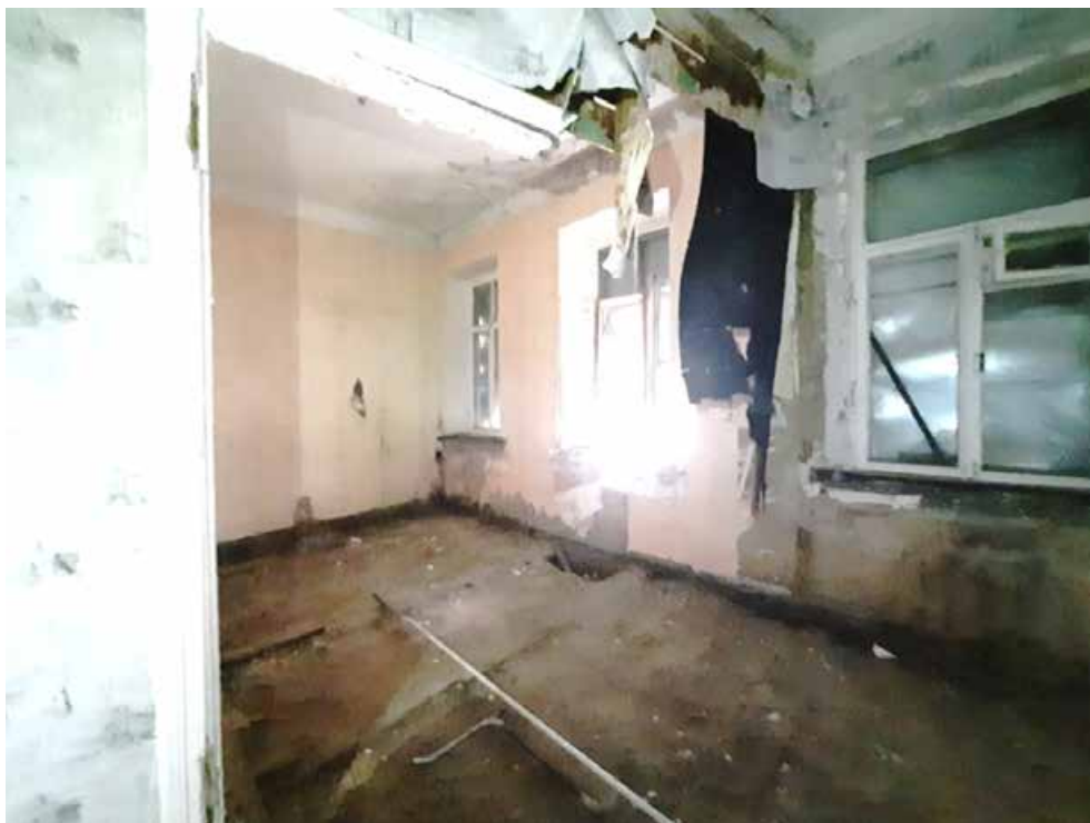
Фото №30. Помещение 3.17 ОКН РЗ «Дом С. Н. Завальевского-М.В. Северова», расположенный по адресу: Санкт-Петербург, муниципальный округ Коломна, пер. Пряильный, д. 12/163, литера А. Дата: 19.04.2025 г.
