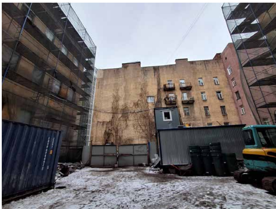
Фото №12. Дворовые фасады ОКН РЗ «Дом С. Н. Завальевского-М.В. Северова», расположенный по адресу: Санкт-Петербург, муниципальный округ Коломна, пер. Прядильный, д. 12/163, литера А. Дата: 19.04.2025 г.
