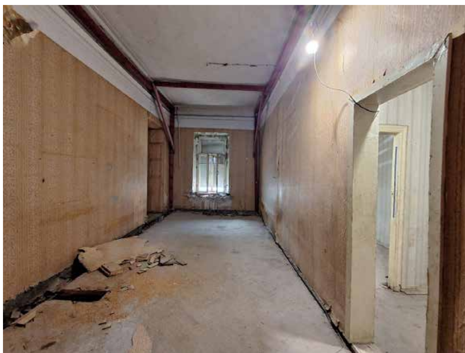
Фото №22. Помещения 2.27, 2.28 и 2.26 ОКН РЗ «Дом С. Н. Завальевского-М.В. Северова», расположенный по адресу: Санкт-Петербург, муниципальный округ Коломна, пер. Прядильный, д. 12/163, литера А. Дата: 19.04.2025 г.
