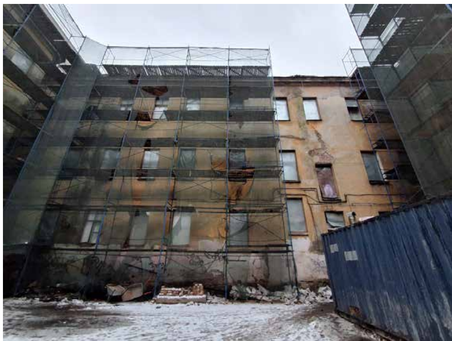
Фото №9. Дворовые фасады ОКН РЗ «Дом С. Н. Завальевского-М.В. Северова», расположенный по адресу: Санкт-Петербург, муниципальный округ Коломна, пер. Прядильный, д. 12/163, литера А. Дата: 19.04.2025 г.
