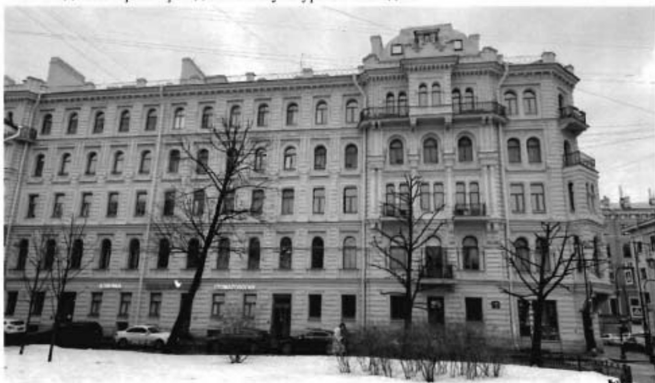
3. Вид на северный фасад объекта культурного наследия.
