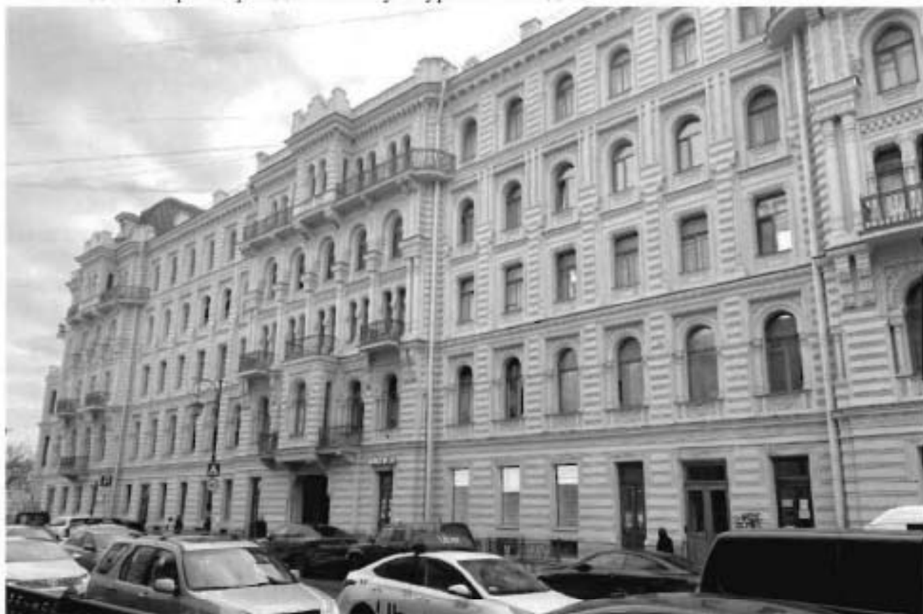
2. Вид на северный фасад объекта культурного наследия.
