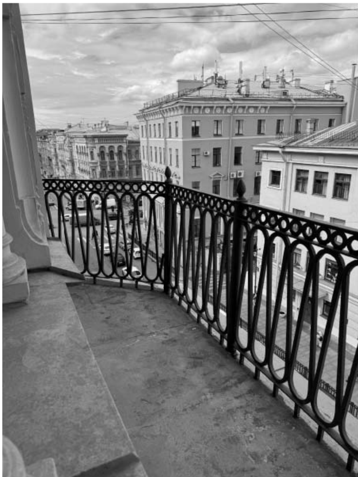
Фото 25. Восточный балкон квартиры № 34 объекта культурного наследия.
