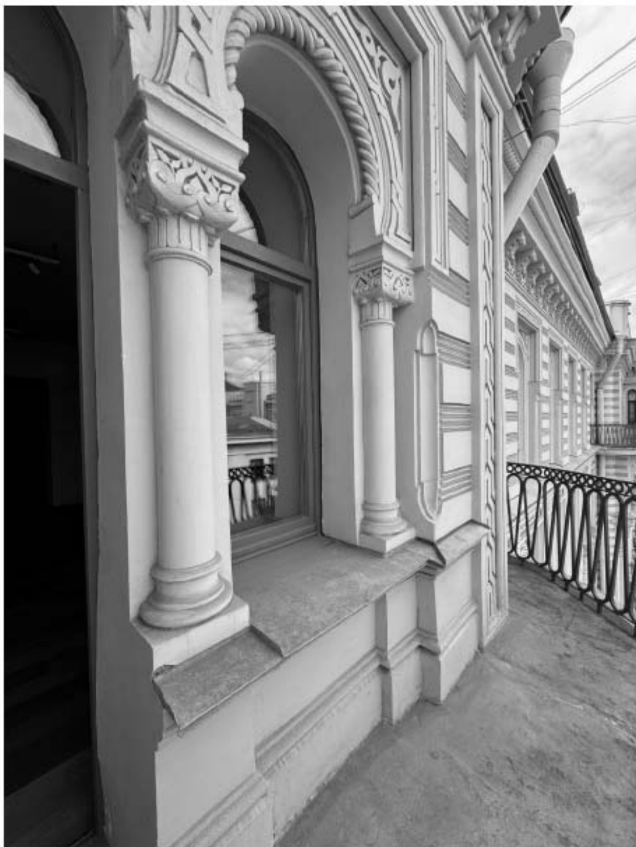
Фото 27. Восточный балкон квартиры № 34 объекта культурного наследия.
