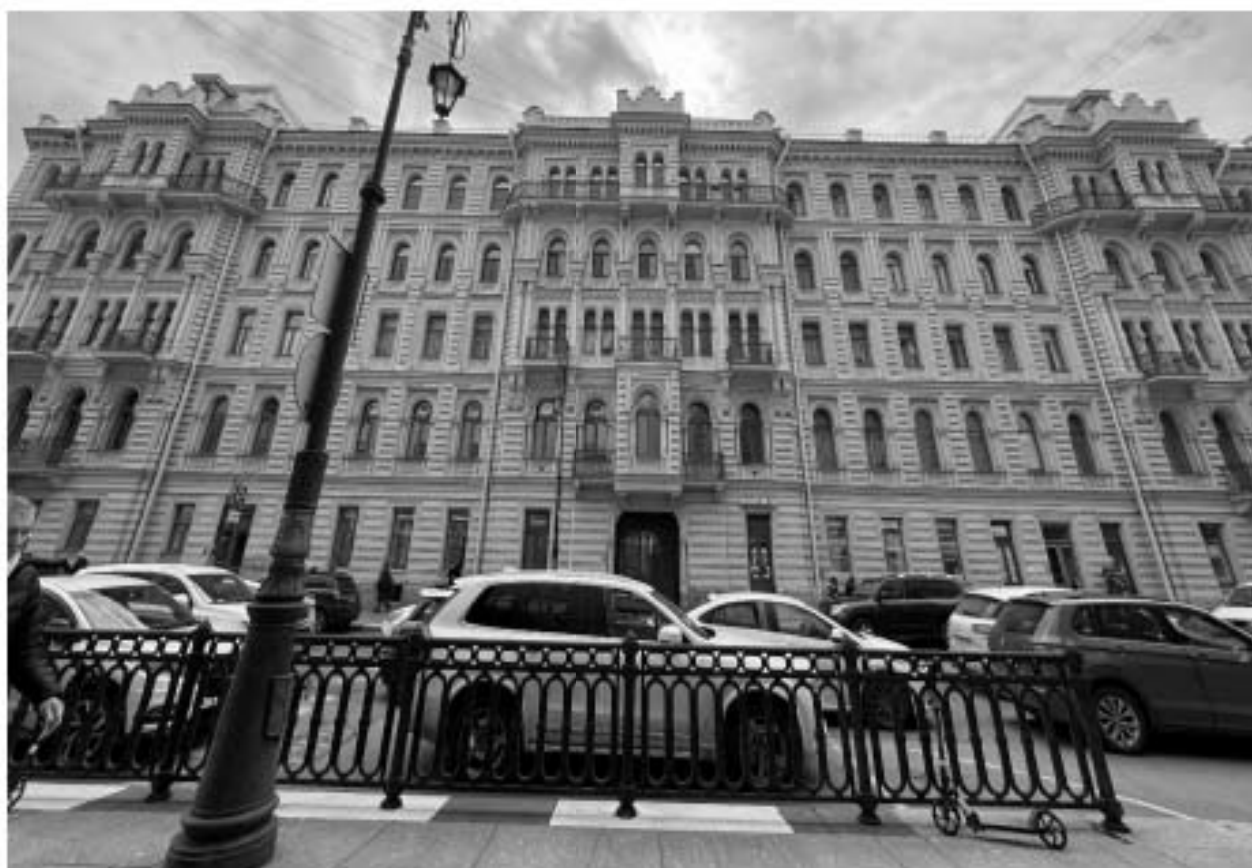
Фото 3. Фасад объекта культурного наследия по улице Пестеля.
