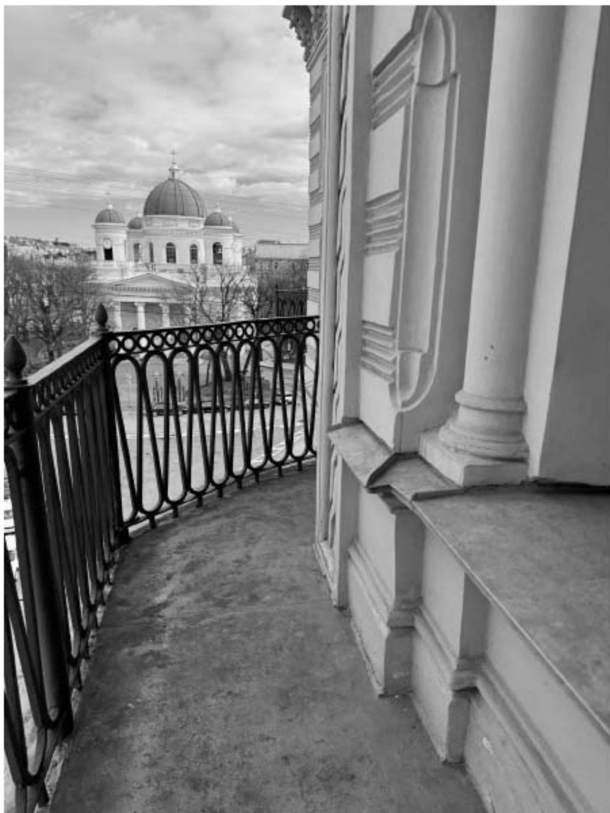
Фото 29. Западный балкон квартиры № 34 объекта культурного наследия.
