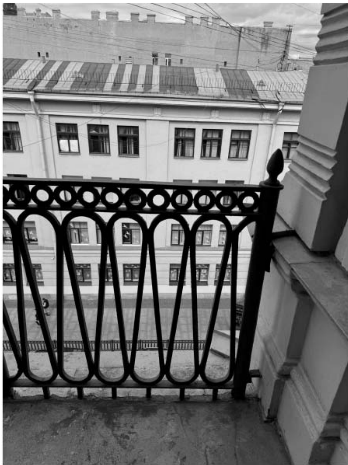
Фото 26. Восточный балкон квартиры № 34 объекта культурного наследия.
