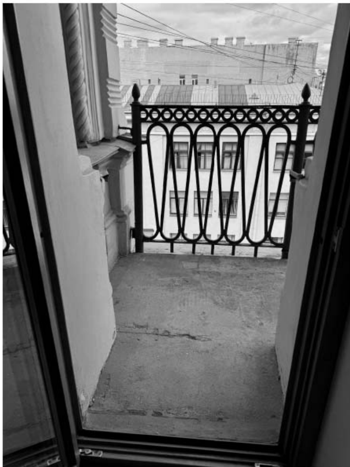
Фото 28. Западный балкон квартиры № 34 объекта культурного наследия.
