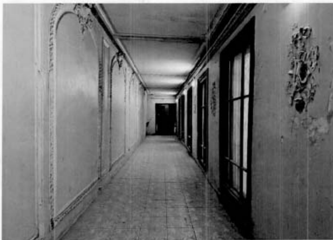
7. Помещение 2ЛК. Крытая галерея в уровне 2 этажа.
