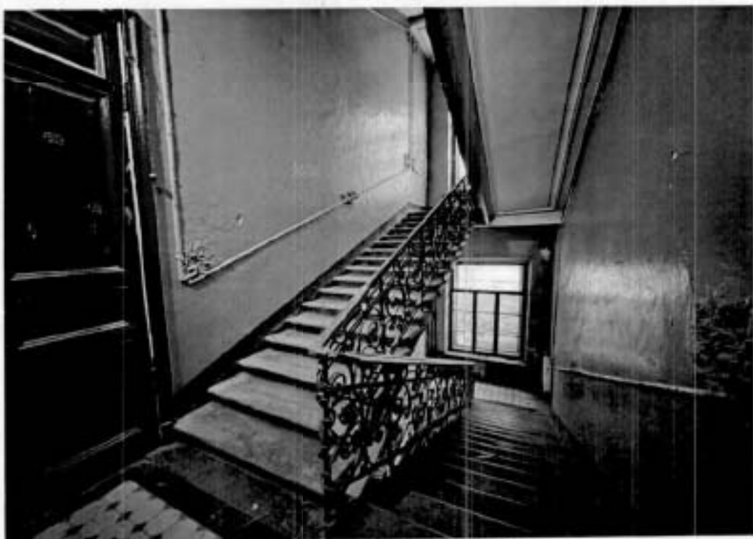
8. Межэтажная лестница 6ЛК.
