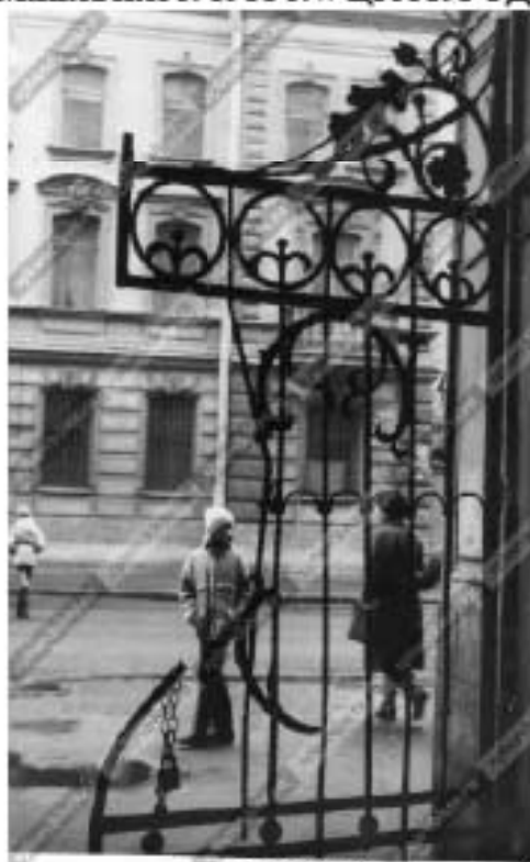
28. Вид решетки ворот арочного проезда дома № 36-38 по улице Маяковского. 1988 г. // ЦГА КФФД СПб. Шифр: Ар 215571.
