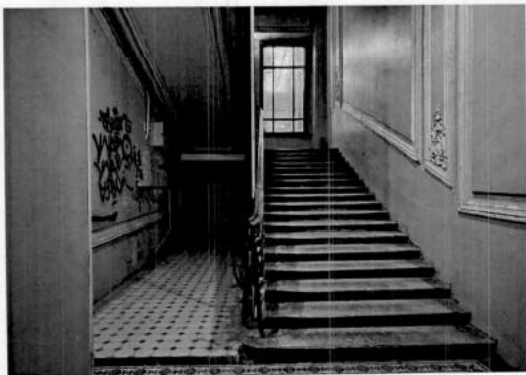
6. Межэтажная лестница 2ЛК.
