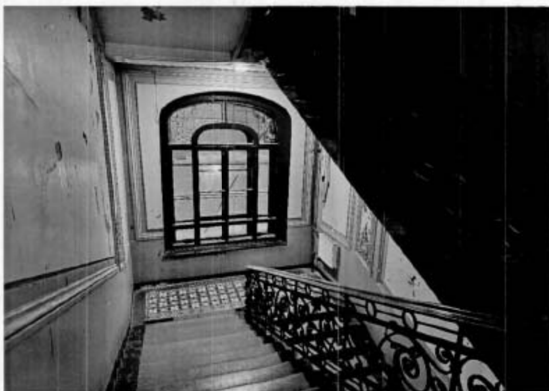
4. Межэтажная лестница 1ЛК.
