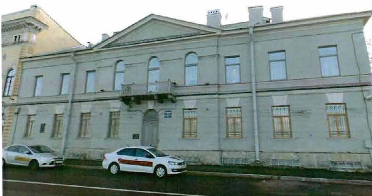
2. Фасад по Английской набережной
