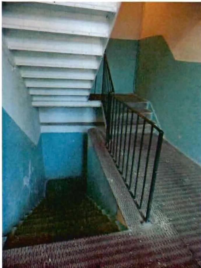
12. Лестница Л-3 (восточный корпус)
