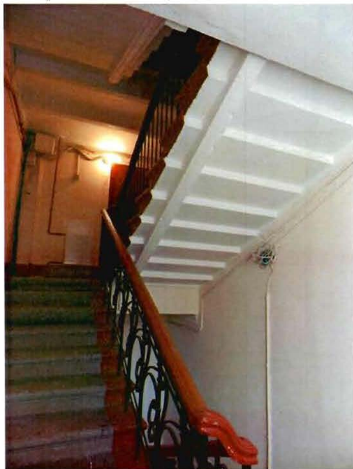
10. Лестница Л-2 (западный корпус)
