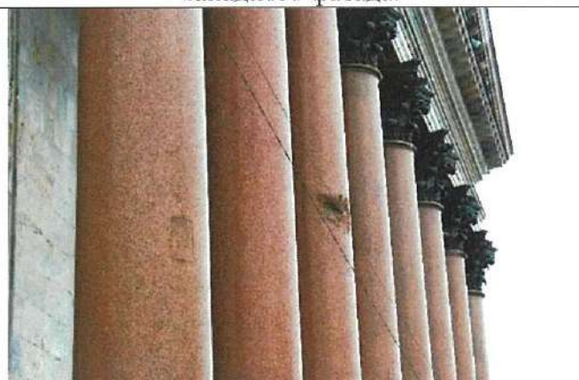
Фрагмент юго-западного фасада.
