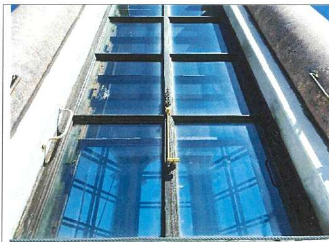
Оконное заполнение в уровне фонаря.
