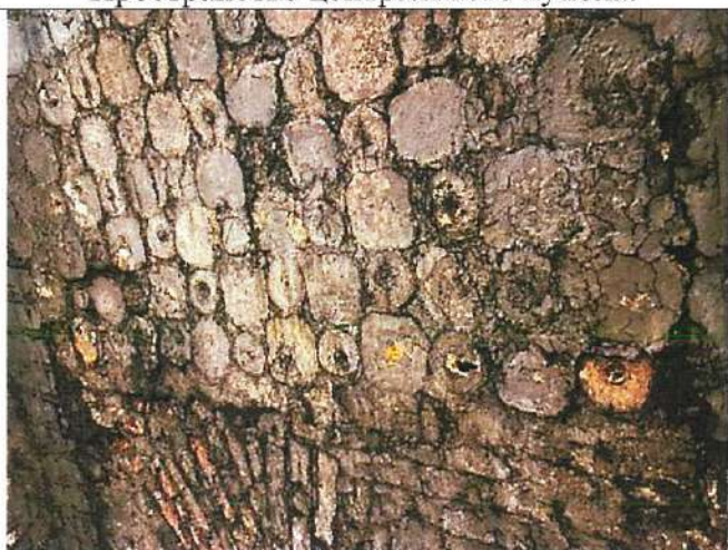
Заполнение конической части купола.
