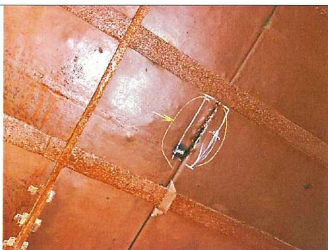
Мезонин-надстройка. Фрагмент конструкции крыши.
