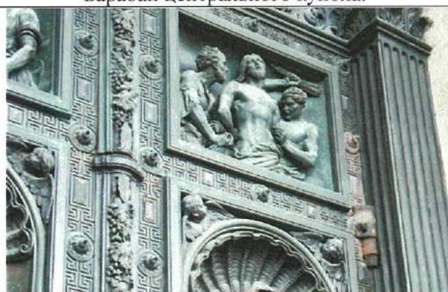
Дверное заполнение со стороны северо-западного фасада.
