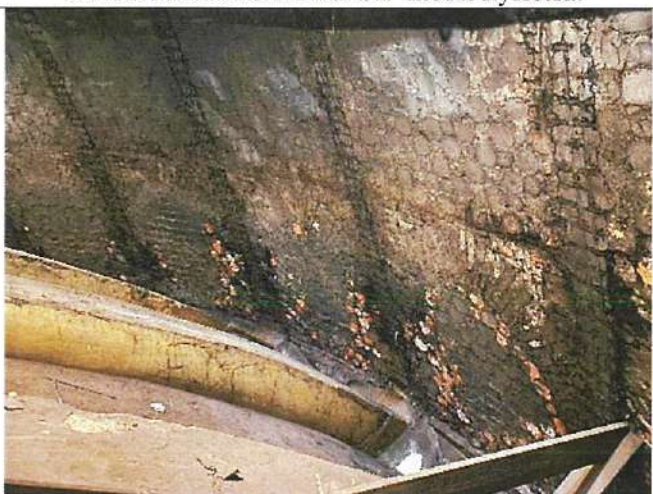
Заполнение конической части купола.
