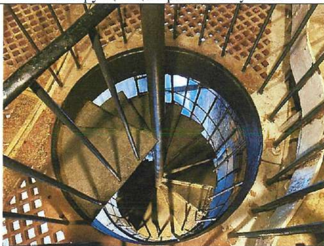
Винтовая металлическая лестница. Центральный купол.
