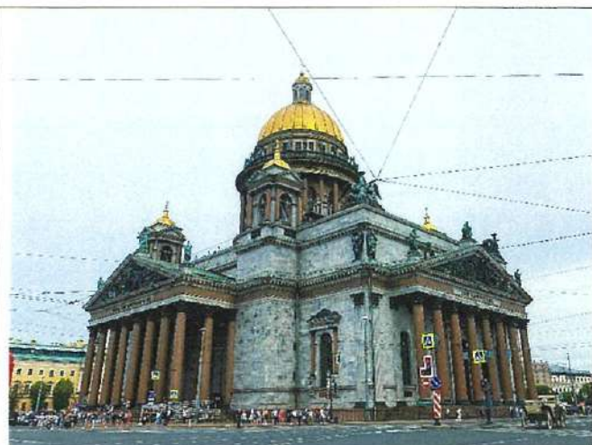
Вид на объект с запада.
