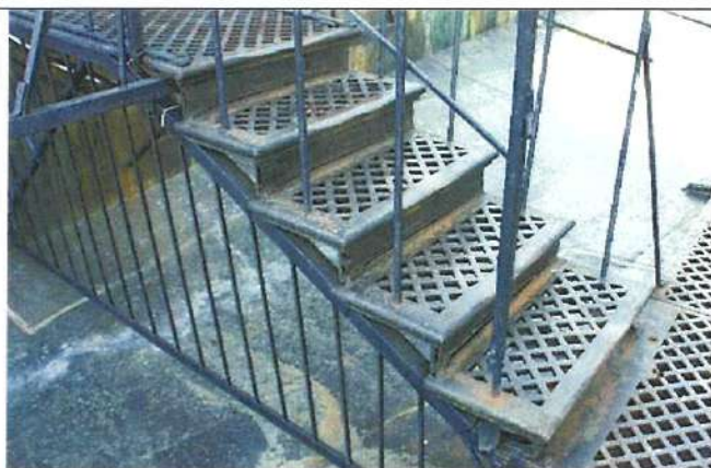
Кровля. Металлическая лестница восхода.
