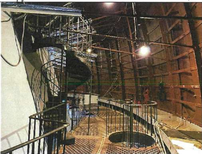
Конструкция центрального купола. Винтовые металлические лестницы.
