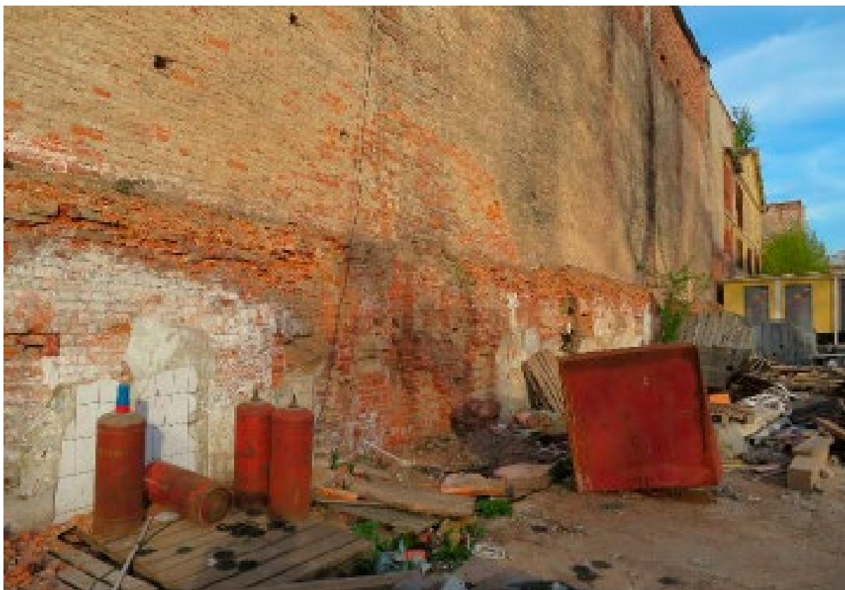
Фото 4. Главный фасад, примыкающий к соседнему зданию.
