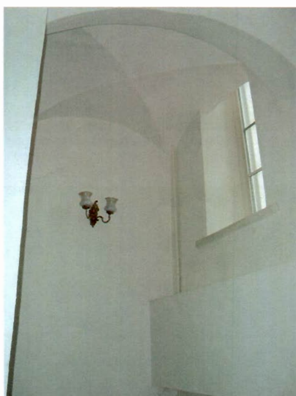
Фото 13. Своды центральной лестницы.
