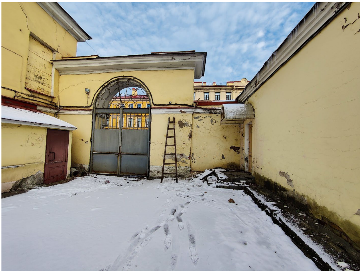
Фото 11. Дворовый фасад. Ограда.
