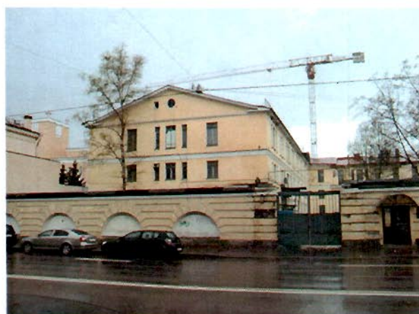
Фото 3. Ограда со стороны 9-ой линии В.О.
