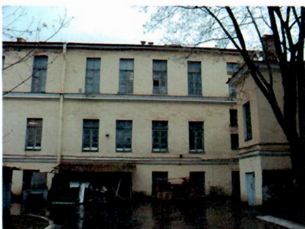
Фото 8. Дворовой фасад и территория.
