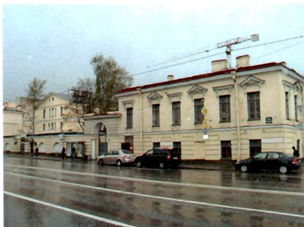
Фото 2. Лицевой фасад и ограда по 9-ой линии В.О.
