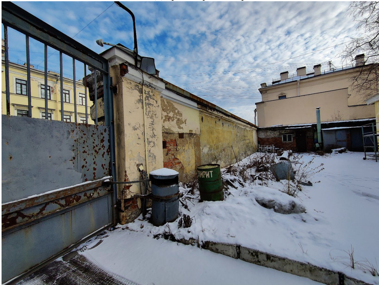
Фото 10. Дворовый фасад. Ограда.
