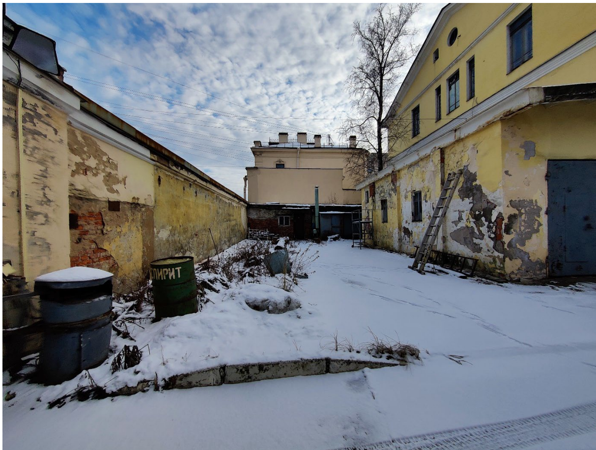
Фото 9. Дворовый фасад. Ограда.
