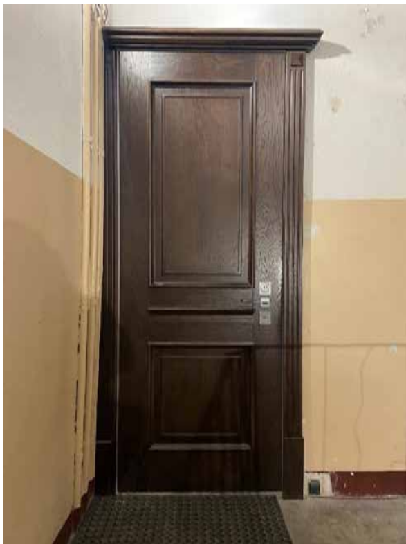
Фото 1. Вид на входную дверь.
