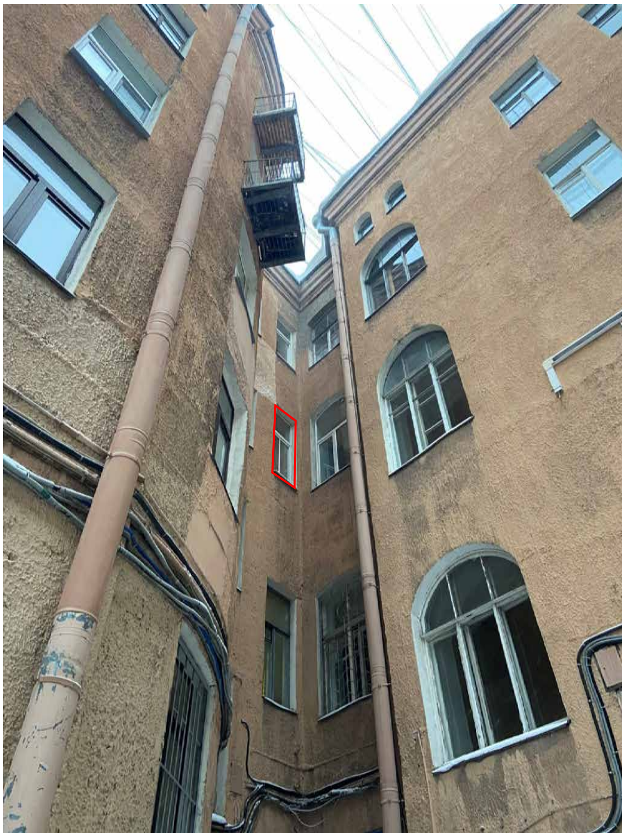
Фото 4. Вид на дворовый фасад.
