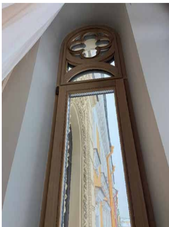
Фото 9. Заполнение оконного проема.
