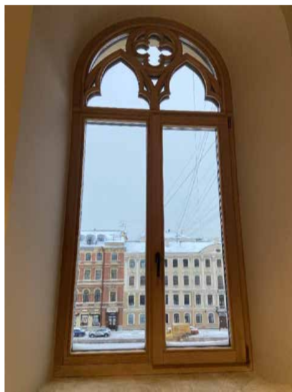
Фото 10. Заполнение оконного проема.
