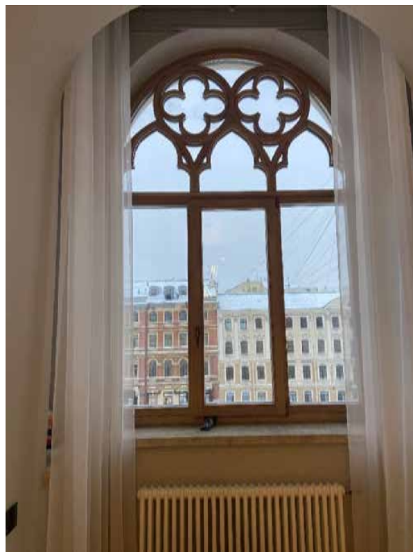
Фото 8. Заполнение оконного проема.
