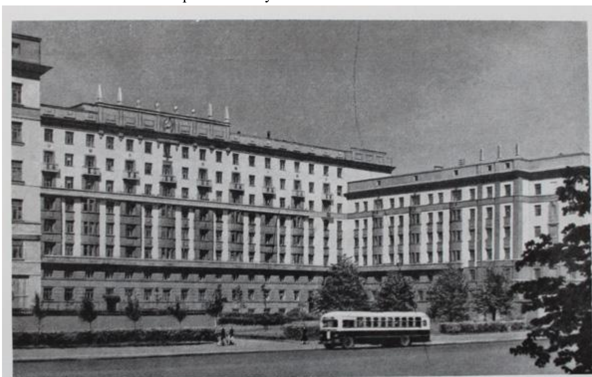
Центральная часть главного фасада
