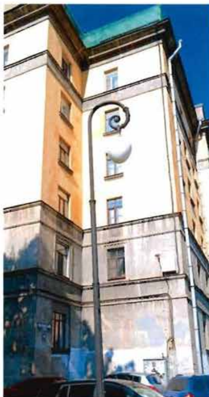
7. Фрагмент. Северный фасад южного флигеля.
