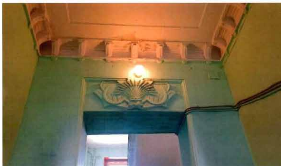
14. Интерьер. Пространство ЛК-1.
