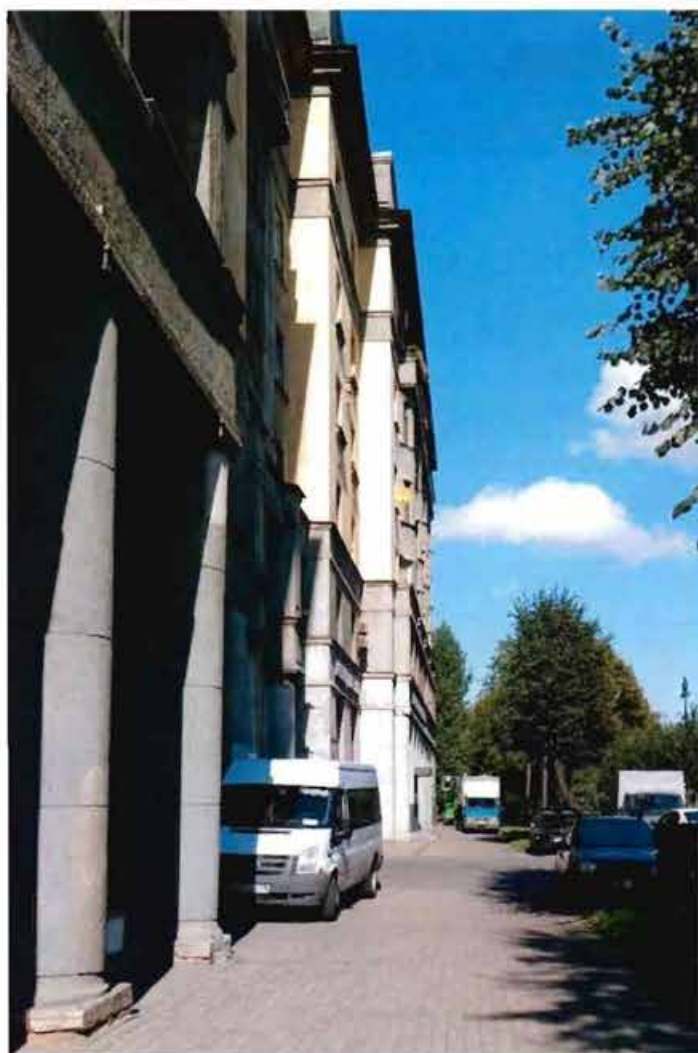
6. Фрагмент. Восточный фасад южного флигеля.
