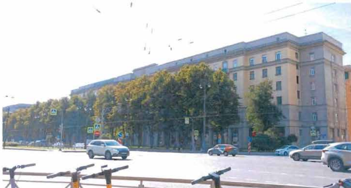
1. Общий вид. Восточный фасад северного флигеля.
