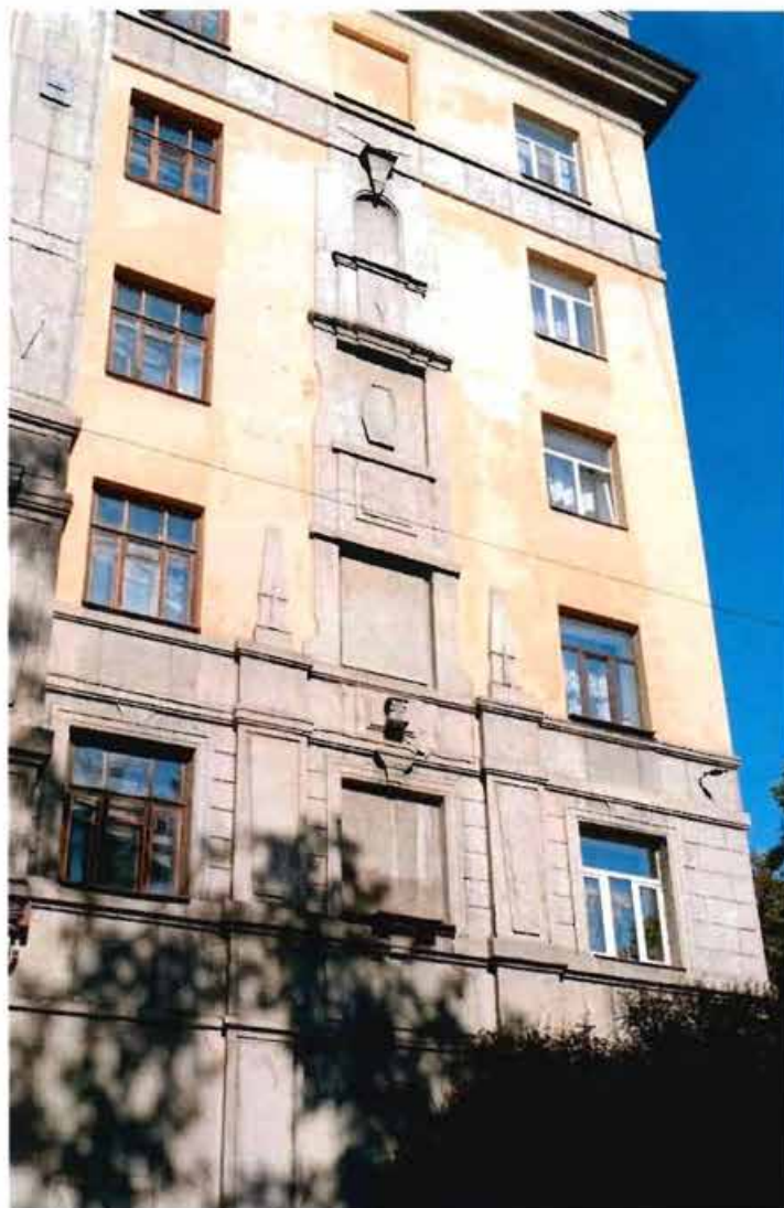
13. Фрагмент. Северный фасад северного флигеля.
