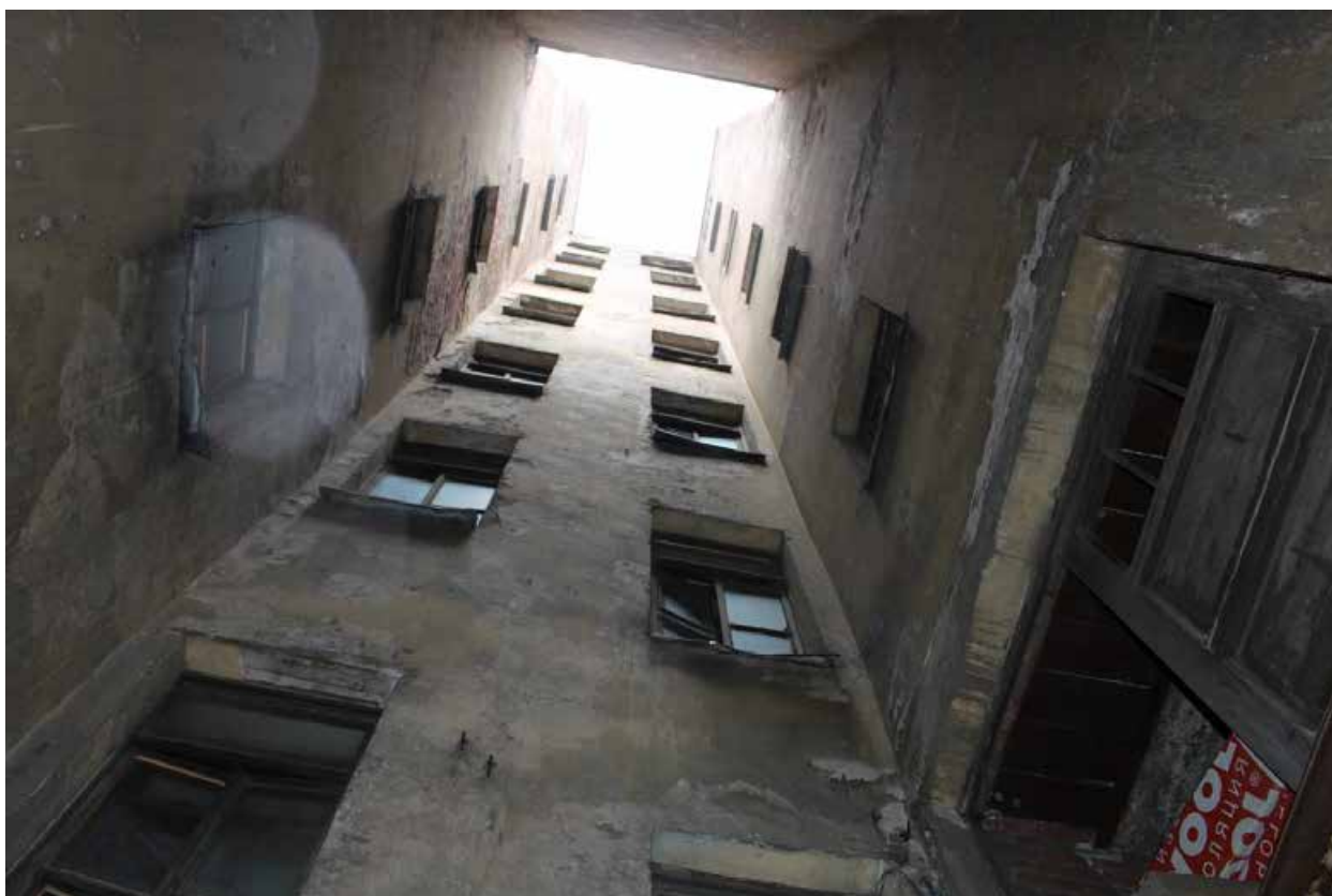
Фото 14. Вид на северный двор-колодец юго-западного дворового корпуса объекта культурного наследия регионального значения «Дом И.А. Ильина».
