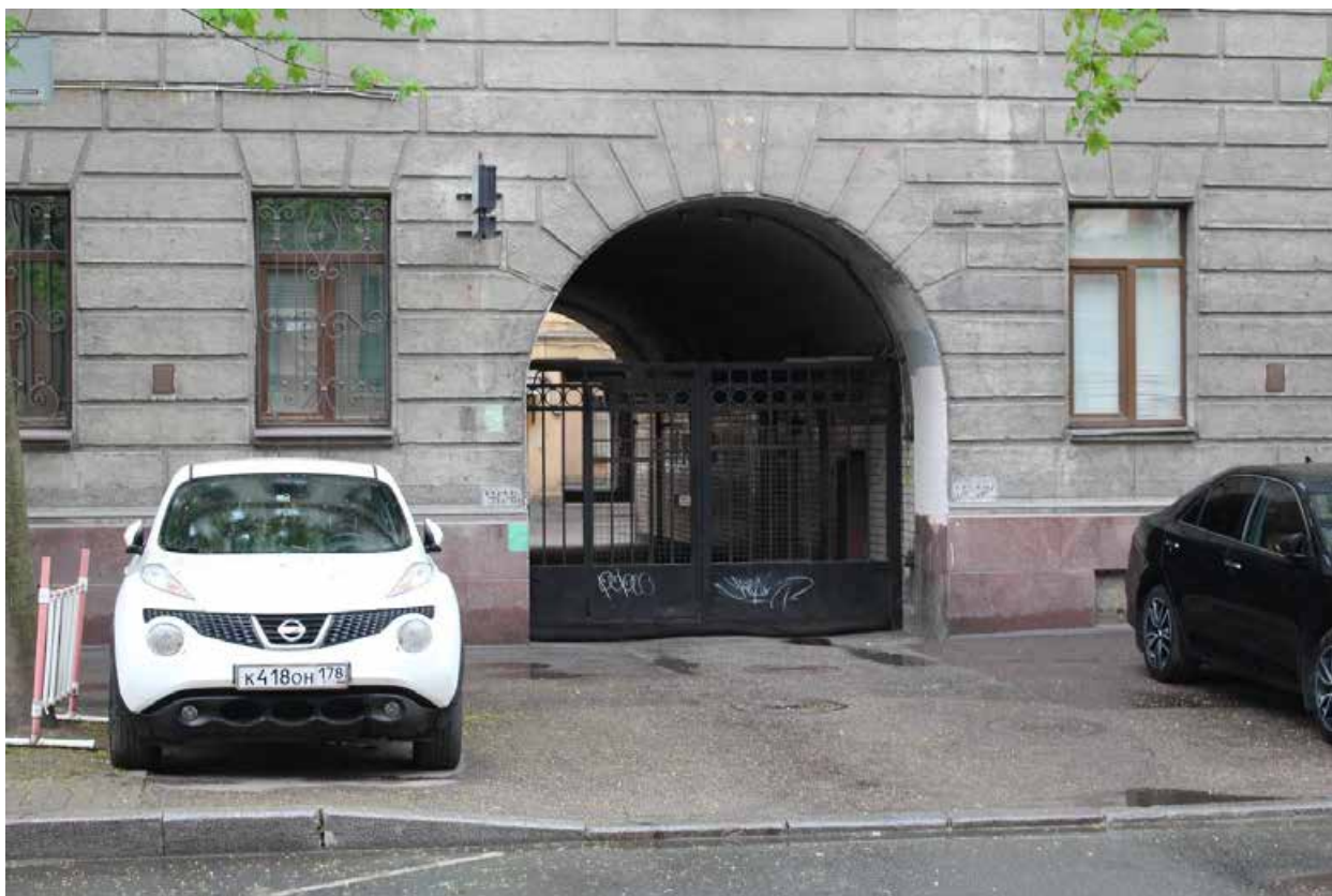
Фото 3. Воротный проезд лицевого корпуса объекта культурного наследия регионального значения «Дом И.А. Ильина».
