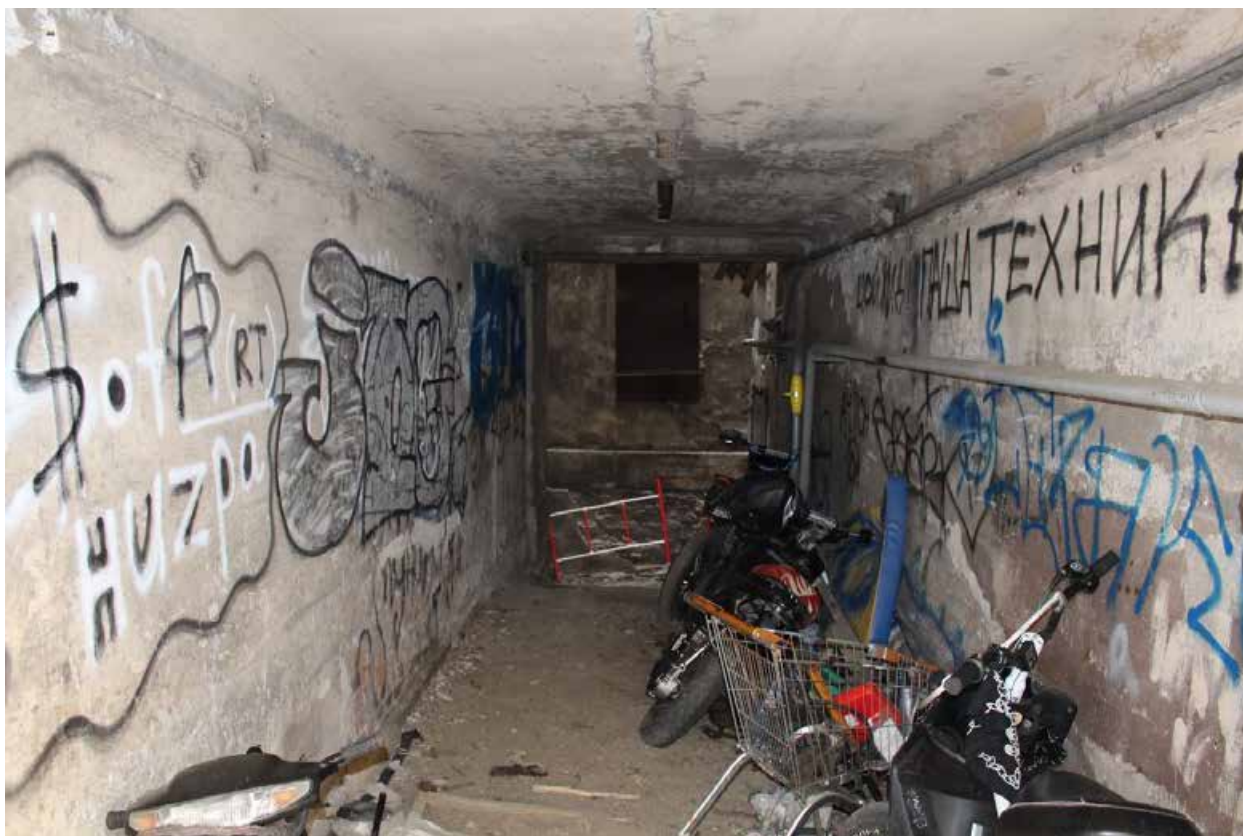
Фото 13. Вид на воротный проезд в северной части юго-западного дворового корпуса объекта культурного наследия регионального значения «Дом И.А. Ильина».
