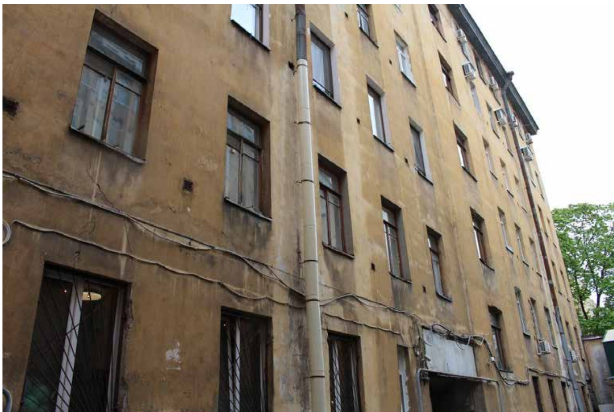
Фото 11. Вид на юго-западный фасад юго-западного дворового корпуса объекта культурного наследия регионального значения «Дом И.А. Ильина».
