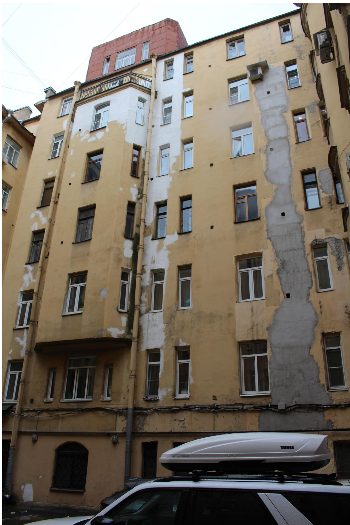
Фото 6. Вид на фасад юго-восточного дворового корпуса объекта культурного наследия регионального значения «Дом И.А. Ильина».
