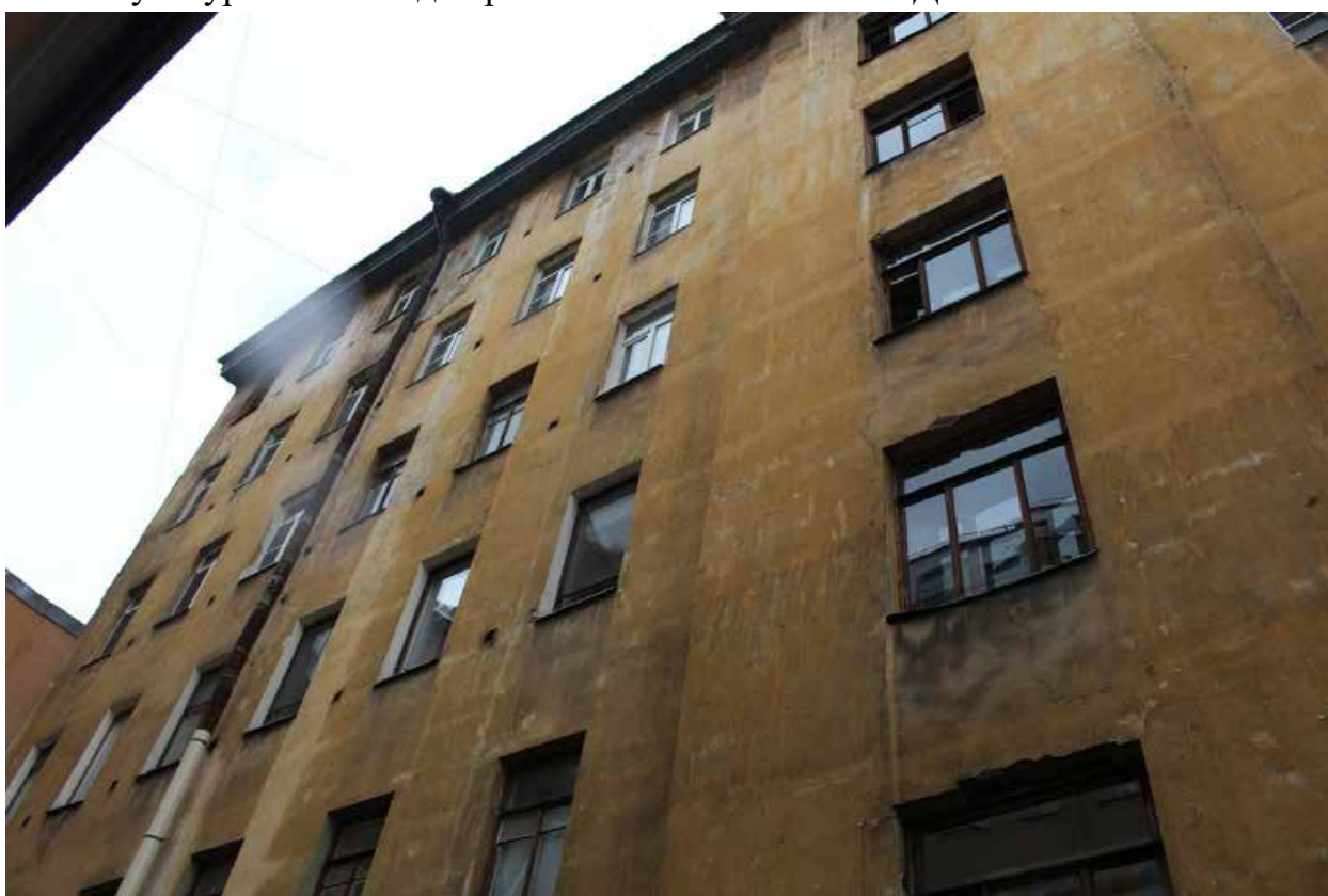
Фото 10. Вид на юго-западный фасад юго-западного дворового корпуса объекта культурного наследия регионального значения «Дом И.А. Ильина».
