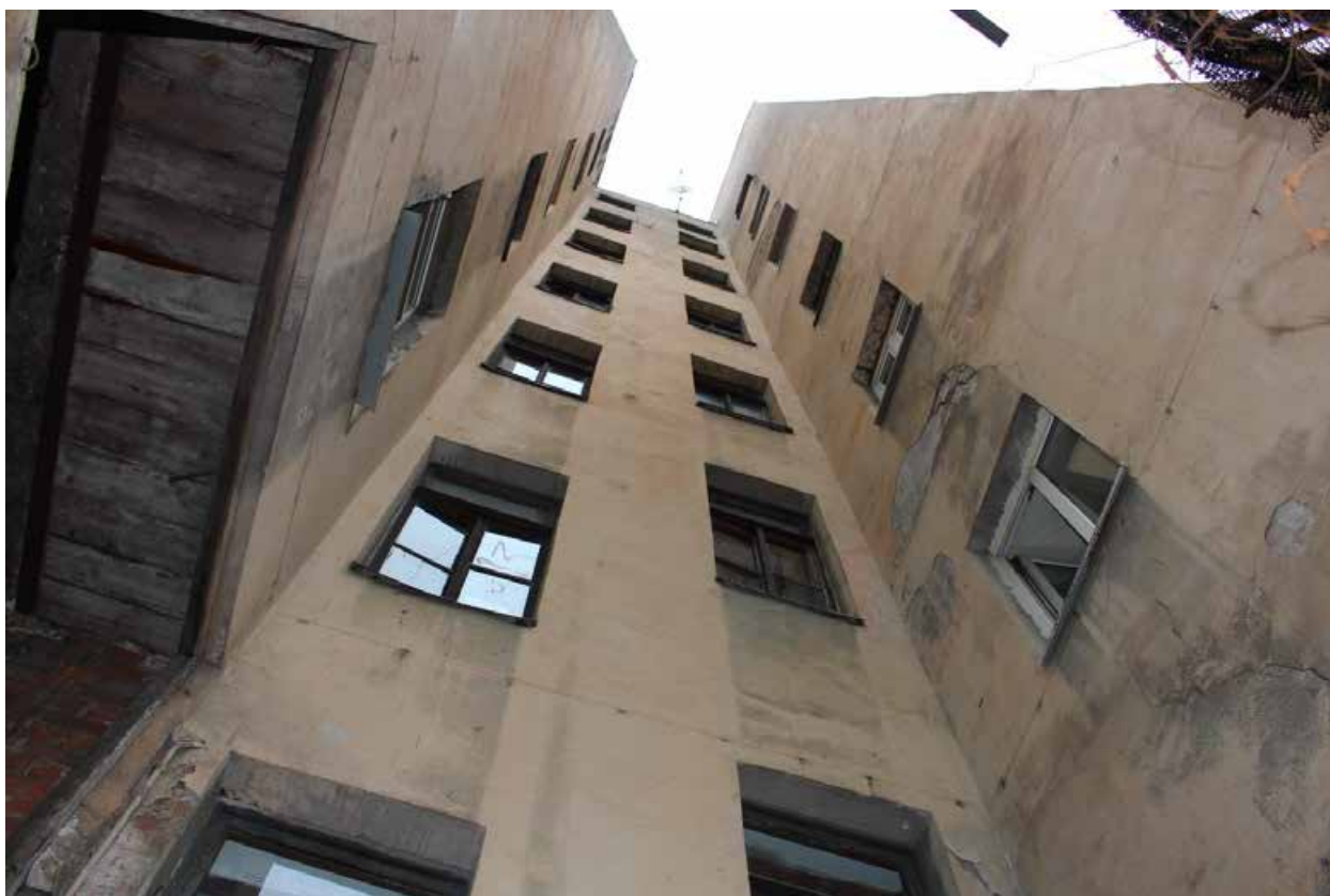
Фото 16. Вид на южный двор-колодец юго-западного дворового корпуса объекта культурного наследия регионального значения «Дом И.А. Ильина».
