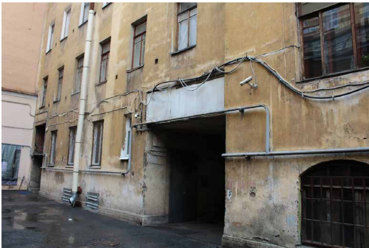
Фото 9. Вид на юго-западный фасад юго-западного дворового корпуса объекта культурного наследия регионального значения «Дом И.А. Ильина».
