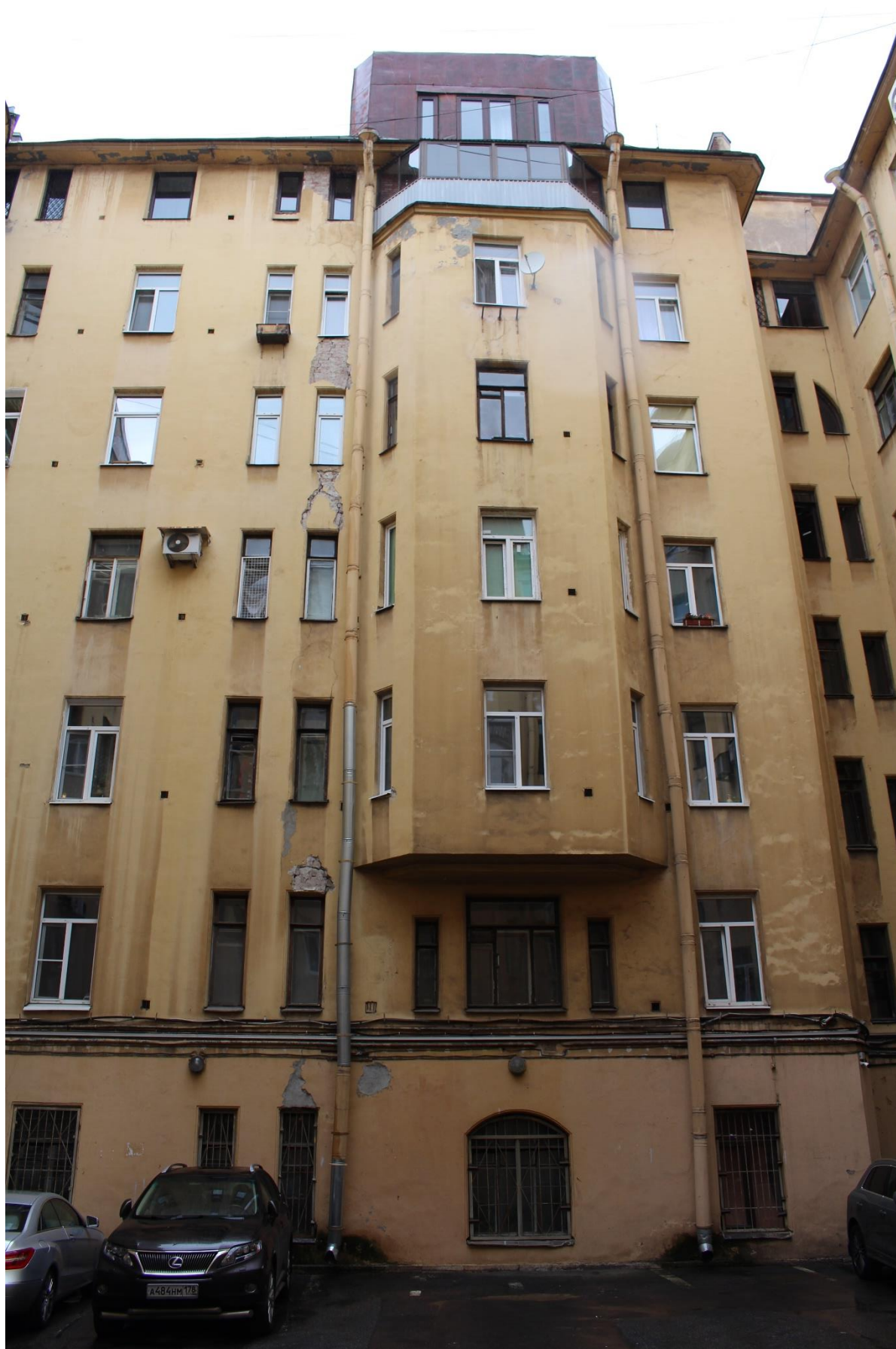
Фото 7. Вид на фасад северо-западного дворового корпуса объекта культурного наследия регионального значения «Дом И.А. Ильина».
