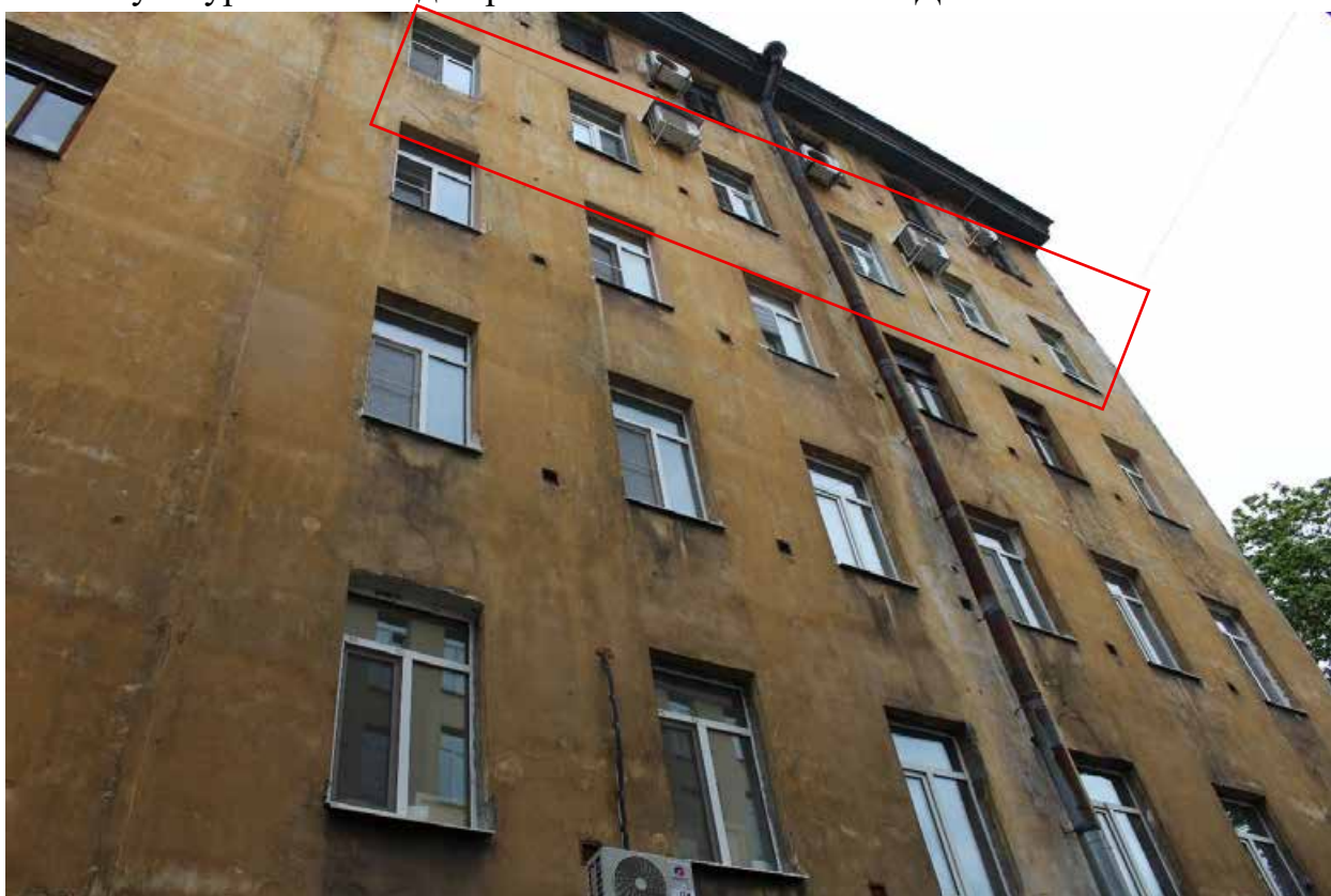
Фото 12. Вид на юго-западный фасад юго-западного дворового корпуса объекта культурного наследия регионального значения «Дом И.А. Ильина». Красным отмечены оконные проемы квартиры № 45.
