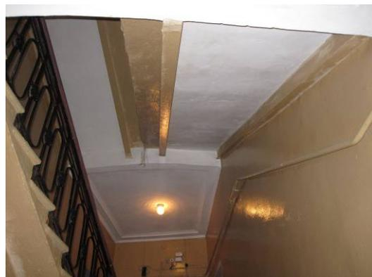
лестница парадная № 3 по юго-восточному фасаду - местоположение и габариты лестничных маршей; конструкция (лестничные марши на косоурах), ступени из лещадной плиты, ограждение лестничных маршей – материал (металл), техника исполнения (ковка), рисунок ( в виде рамочной конструкции из овалов и розеток);
