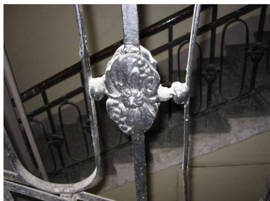
лестница парадная № 4 по юго-восточному фасаду - местоположение и габариты лестничных маршей; конструкция (лестничные марши на косоурах), ступени из лещадной плиты, ограждение лестничных маршей - материал (металл), техника исполнения (ковка), рисунок ( в виде рамочной конструкции из овалов и розеток);
