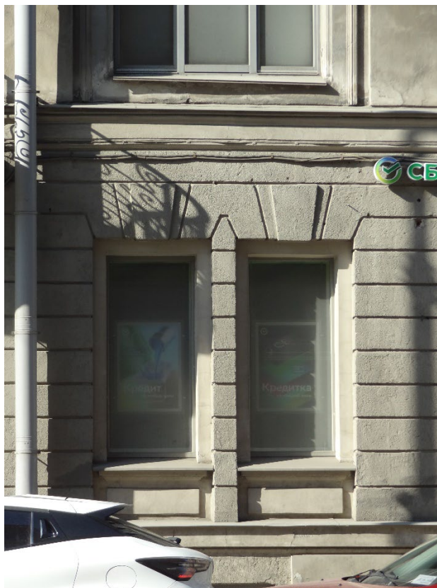
Фото 4. Оконные проемы лицевого фасада. Дата фотофиксации: 09.04.25
