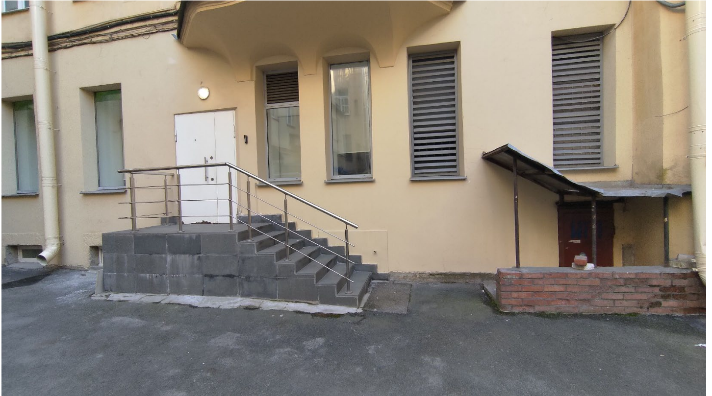
Фото 5. Дворовый фасад, фрагмент. Дата фотофиксации: 09.04.25
