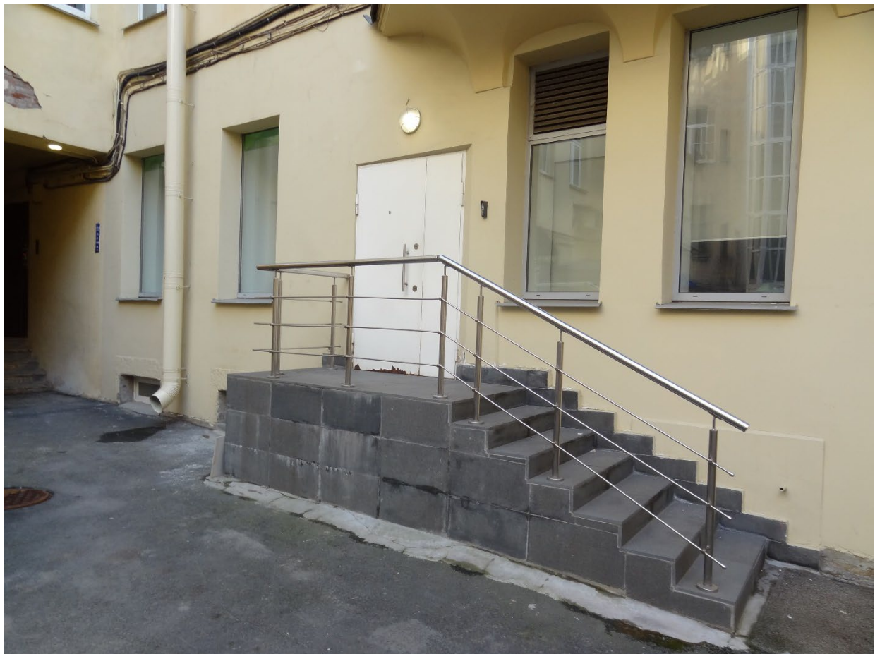
Фото 6. Крыльцо дворового фасада. Общий вид. Дата фотофиксации: 09.04.25
