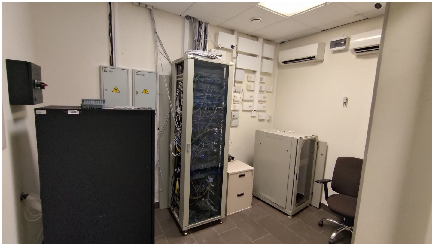
Фото 19. Пространство помещений 21-22. Общий вид. Дата фотофиксации: 09.04.25
