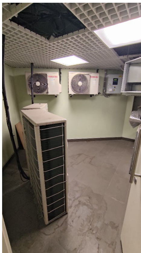
Фото 18. Помещение 23. Общий вид. Дата фотофиксации: 09.04.25
