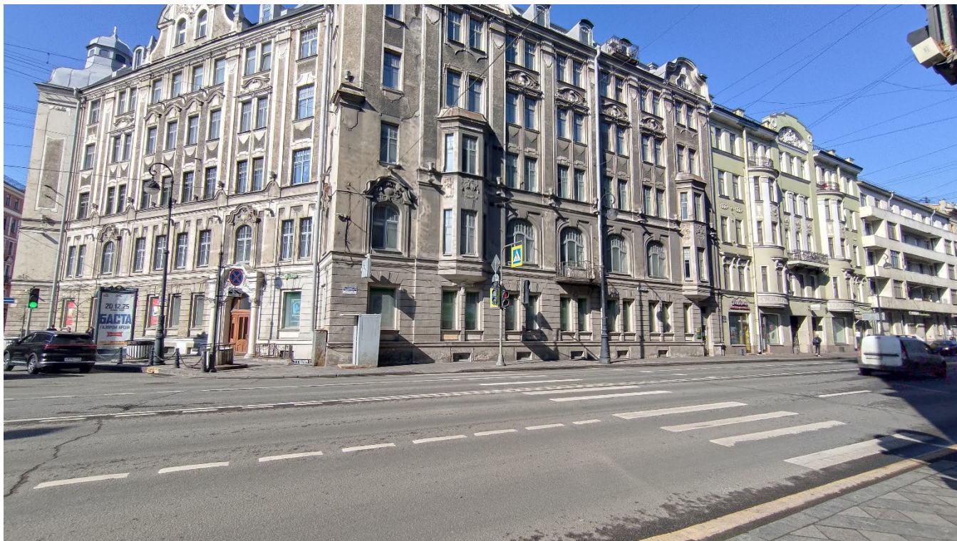
Фото 1. Дом М.М. Горбова, общий вид уровня первого этажа. Дата фотофиксации: 09.04.25
