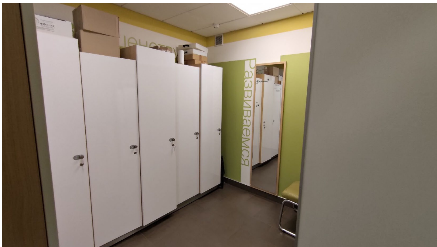
Фото 22. Помещение 19. Общий вид. Дата фотофиксации: 09.04.25
