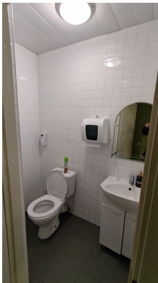
Фото 14. Помещение 31, санузел. Общий вид. Дата фотофиксации: 09.04.25
