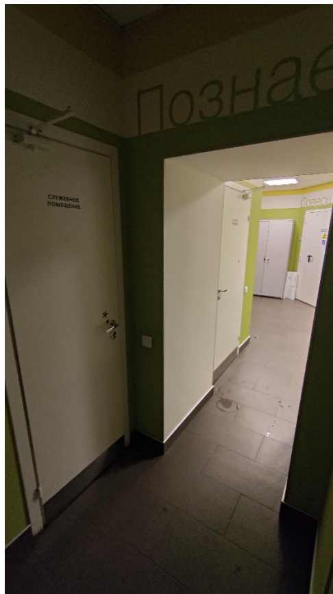
Фото 13. Пространство между помещениями 30 и 20. Общий вид. Дата фотофиксации: 09.04.25
