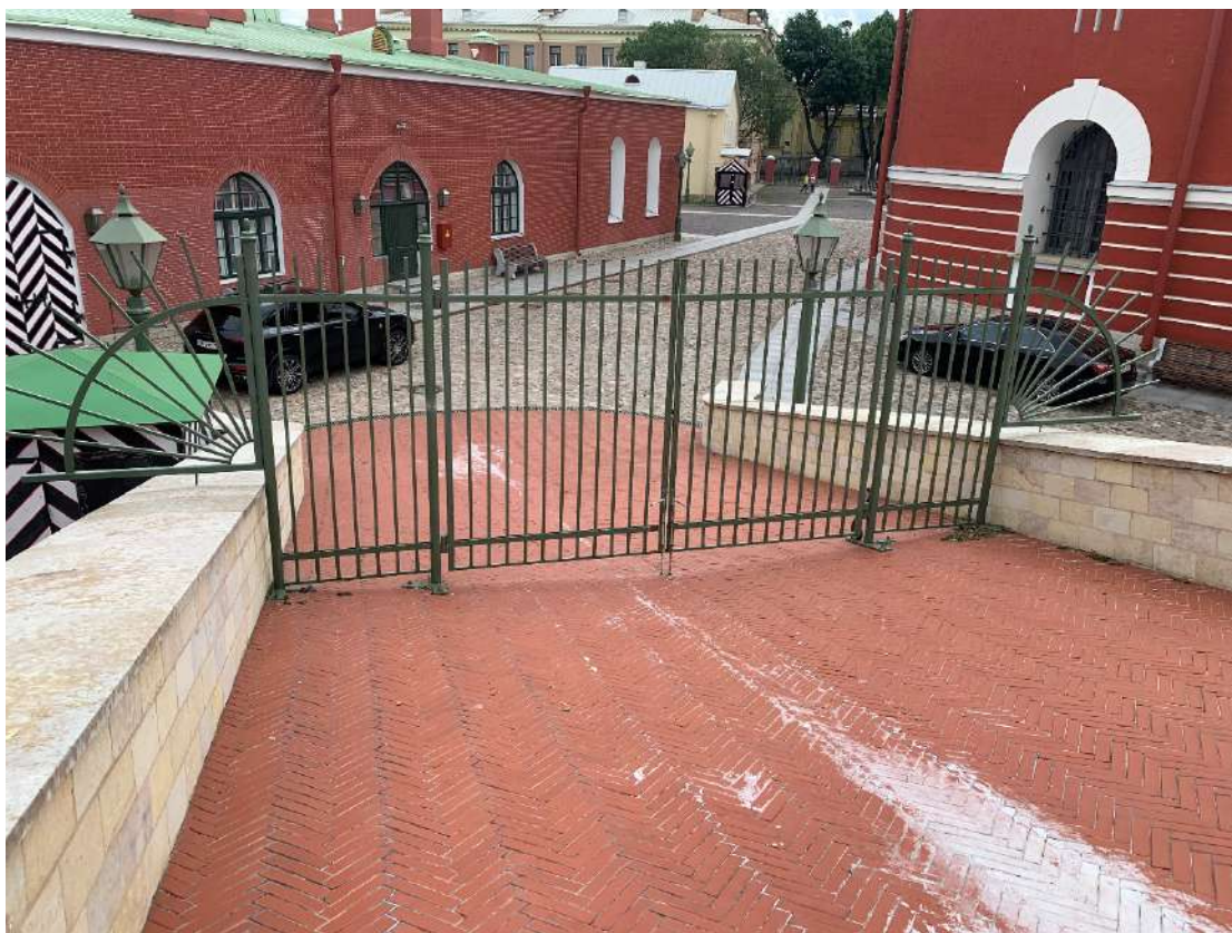
Фото 13. Ограждение аппарели на крепостную стену. 29 ноября 2024г.
