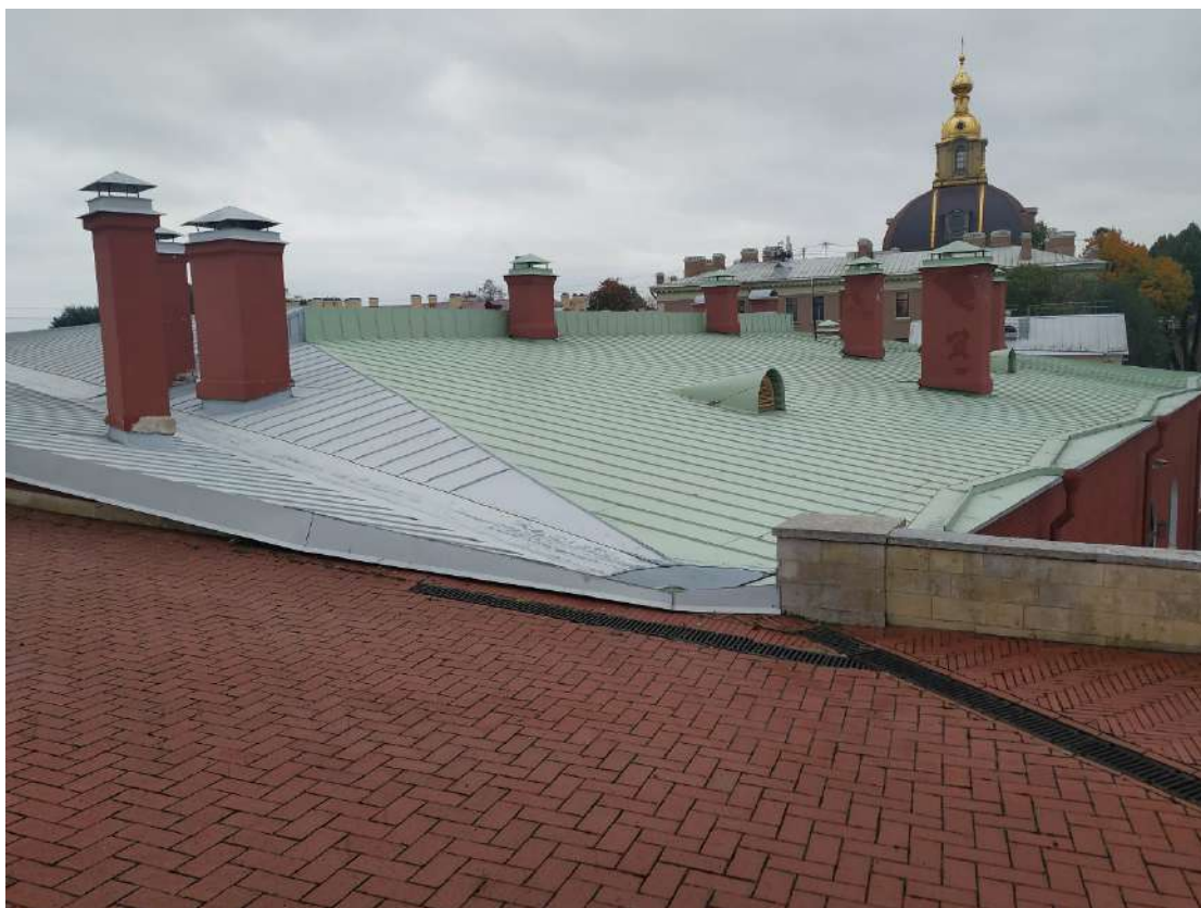
Фото 23. Кровля над левым фланком. 29 ноября 2024г.
