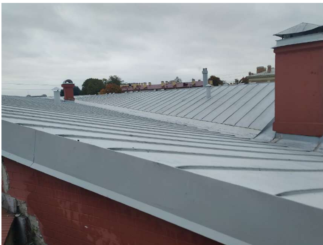
Фото 24. Кровля над орильоном левого фаса. 29 ноября 2024г.
