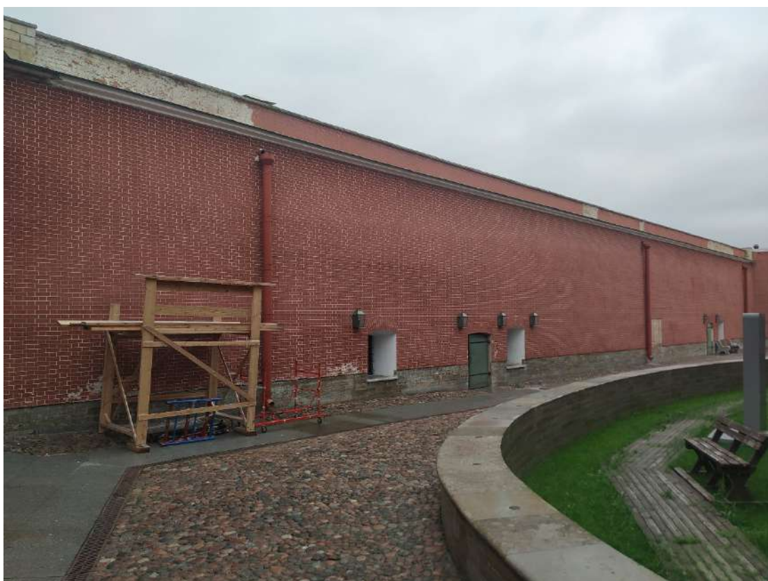
Фото 16. Валганговая стена правого фаса Головкина бастиона. 29 ноября 2024г.
