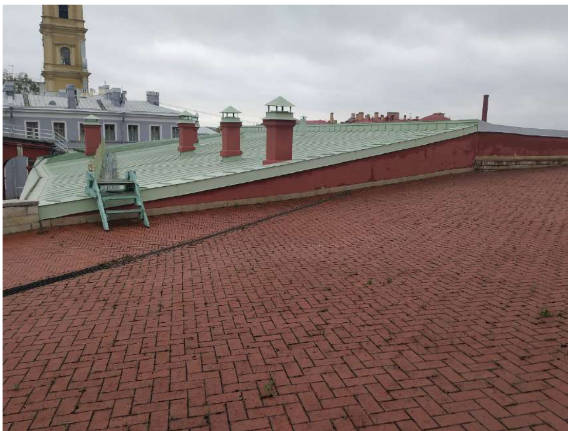
Фото 20. Кровля над правым фланком. 29 ноября 2024г.
