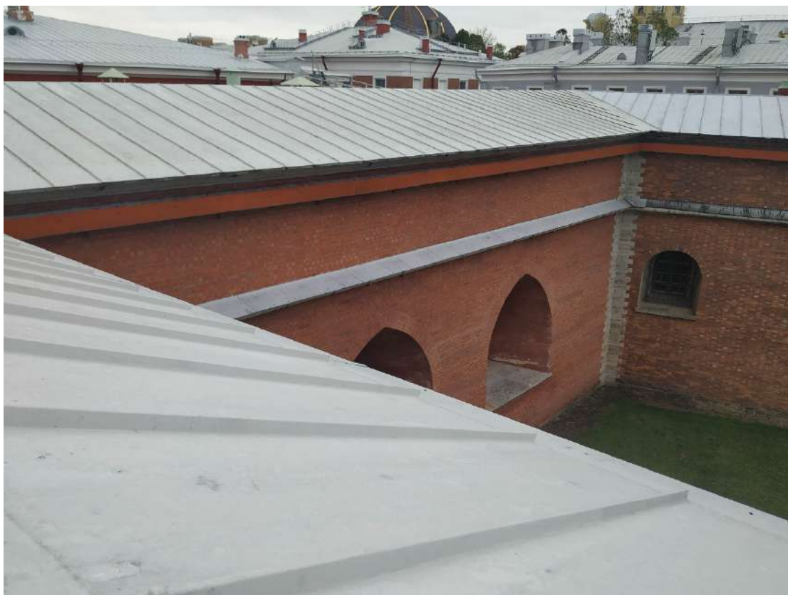
Фото 21. Кровля над правым фланком. 29 ноября 2024г.
