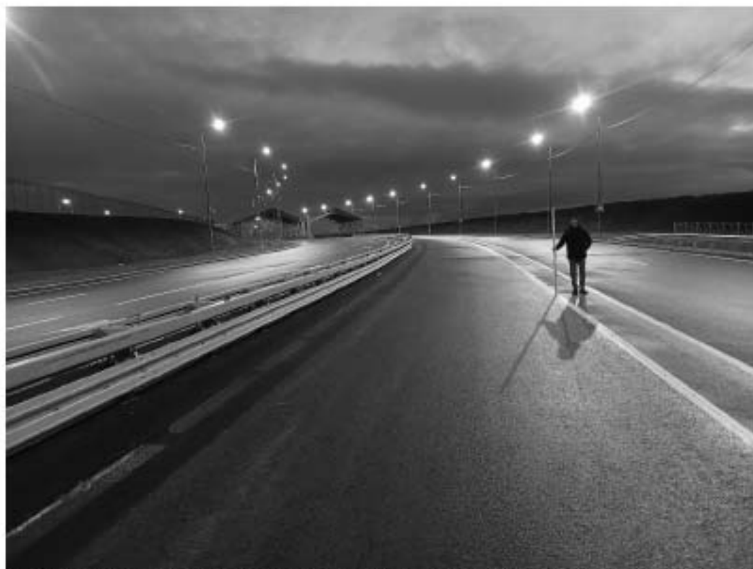
Рис. 41. Санкт-Петербург, ул. Соколиная, участок от КВЦ «Экспофорум» до северо-западной границы квартала №1. Общий вид участка обследования. Точка съемки 10. Вид на юго-запад.
