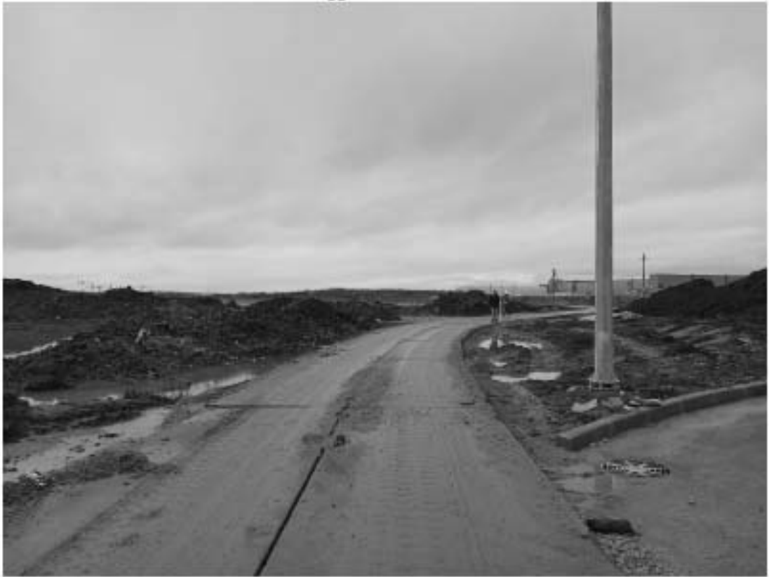
Рис. 26. Санкт-Петербург, ул. Соколиная, участок от КВЦ «Экспофорум» до северо-западной границы квартала №1. Общий вид участка обследования. Точка съемки 4. Вид на северо-запад.
