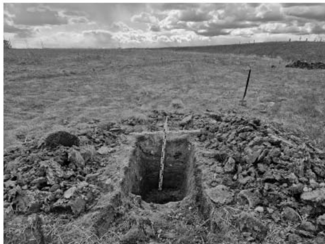
Рис. 61. Санкт-Петербург, ул. Соколиная, участок от КВЦ «Экспофорум» до северо-западной границы квартала №1. Доп. шурф 3. Общий вид. Уровень прекращения работ. Вид на восток.
