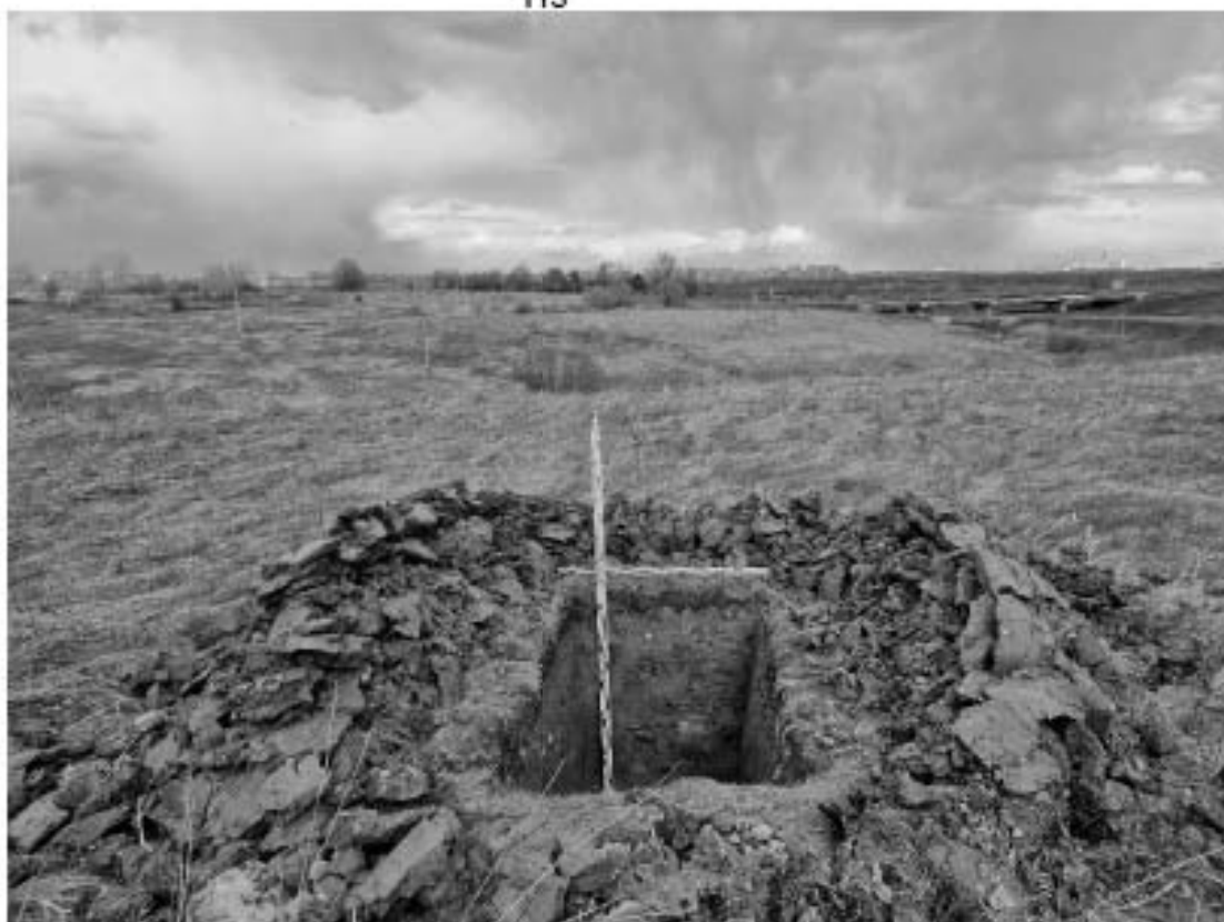
Рис. 58. Санкт-Петербург, ул. Соколиная, участок от КВЦ «Экспофорум» до северо-западной границы квартала №1. Доп. шурф 2. Общий вид Уровень прекращения работ. Вид на восток.
