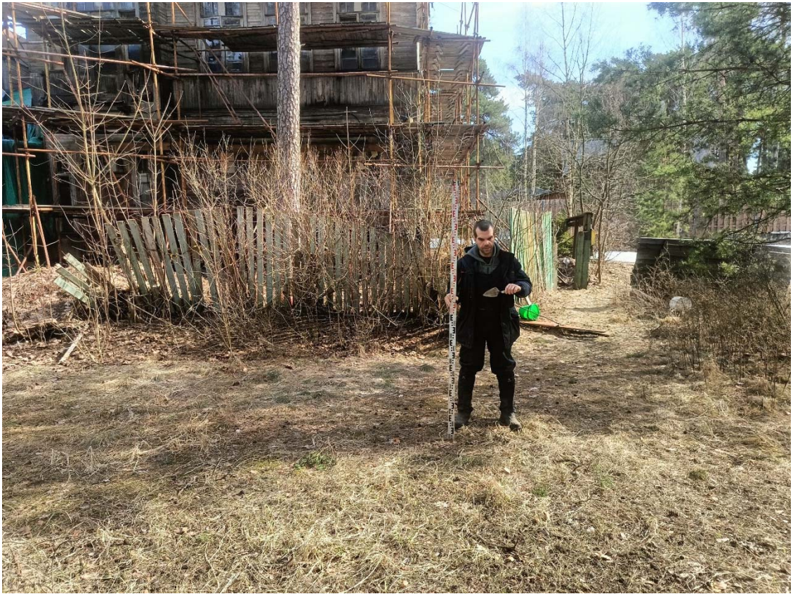
Рис. 26. СПБ-2025. Сестрорецк, Ул. Садовая 8/16, лит. А. Местоположение шурфа 1, вид на с запад.
