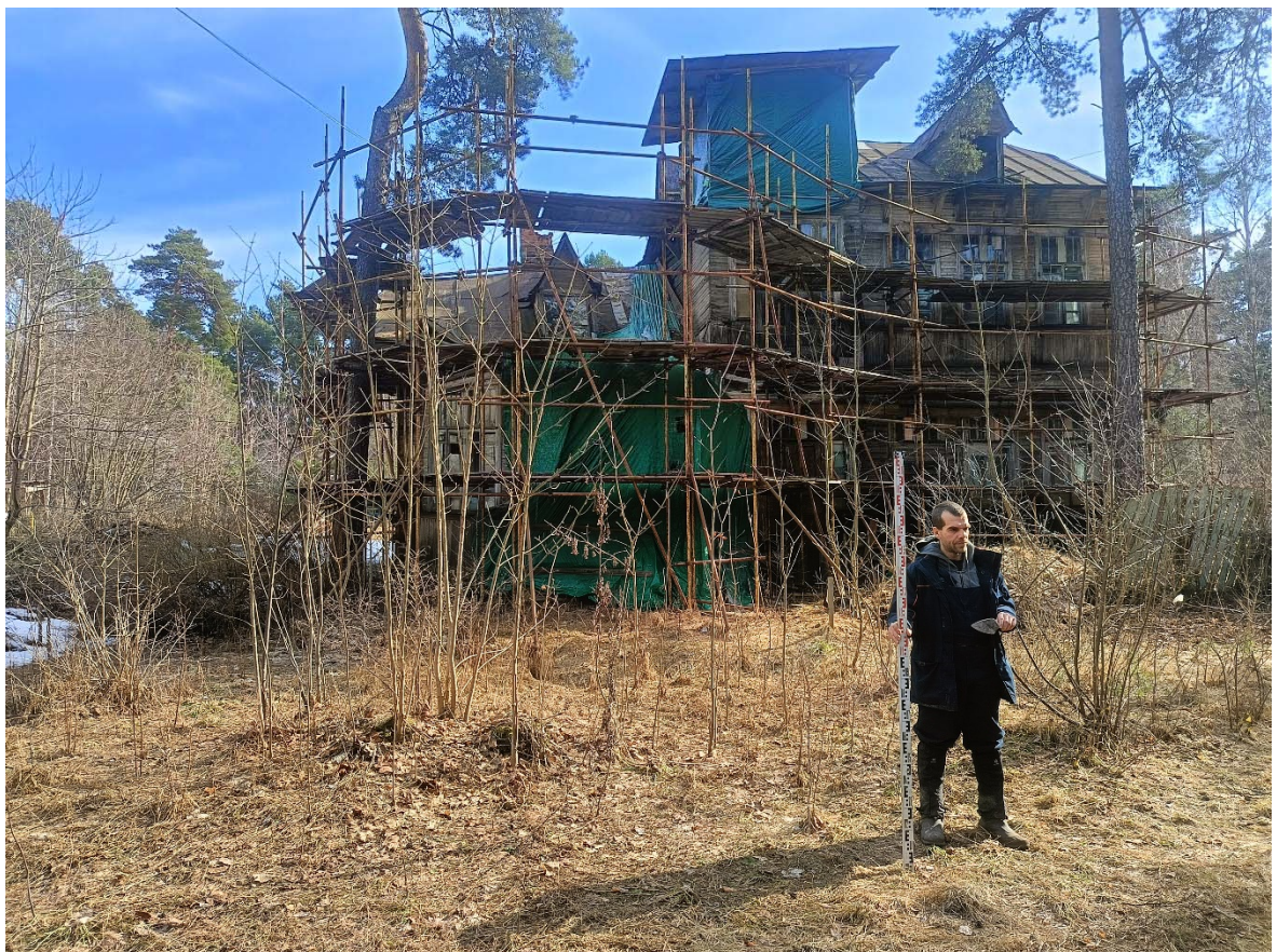
Рис. 17. СПб-2025. Сестрорецк, Ул. Садовая 8/16, лит. А. Точка фотофиксации 2, вид с запада.
