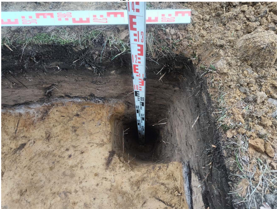
Рис. 48. СПБ-2025. Сестрорецк, Ул. Садовая 8/16, лит. А. Шурф 2, южная стенка.
