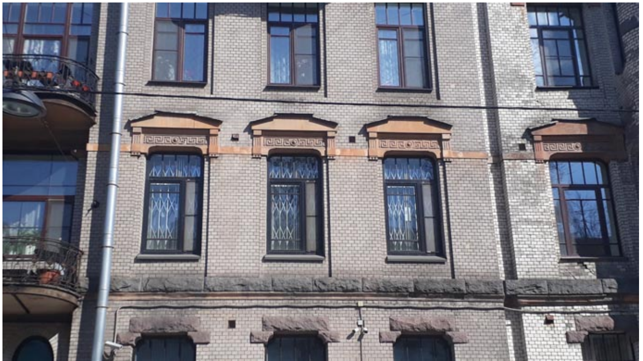
Фото 10. Объект культурного наследия регионального значения "Доходный дом И.Ф.Хреновой" по адресу: ул. Таврическая 7.
