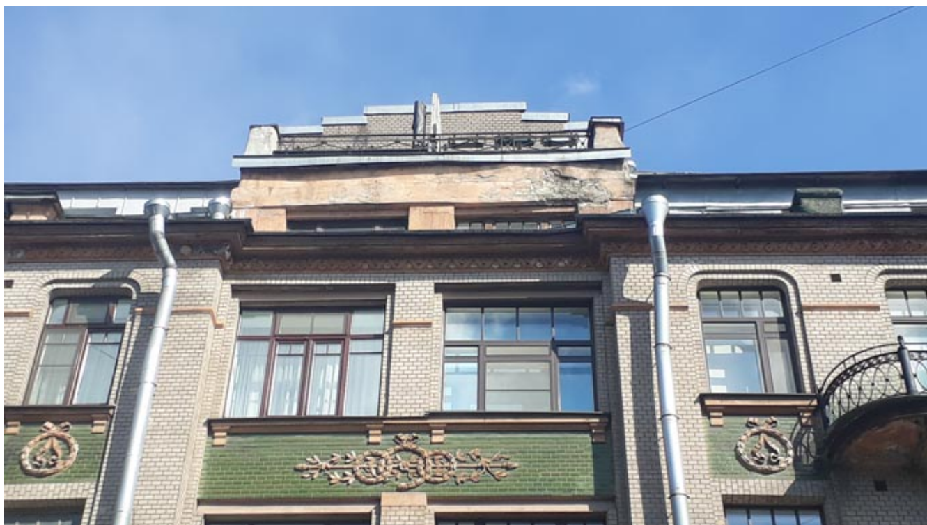
Фото 5. Объект культурного наследия регионального значения "Доходный дом И.Ф.Хреновой" по адресу: ул. Таврическая 7.
