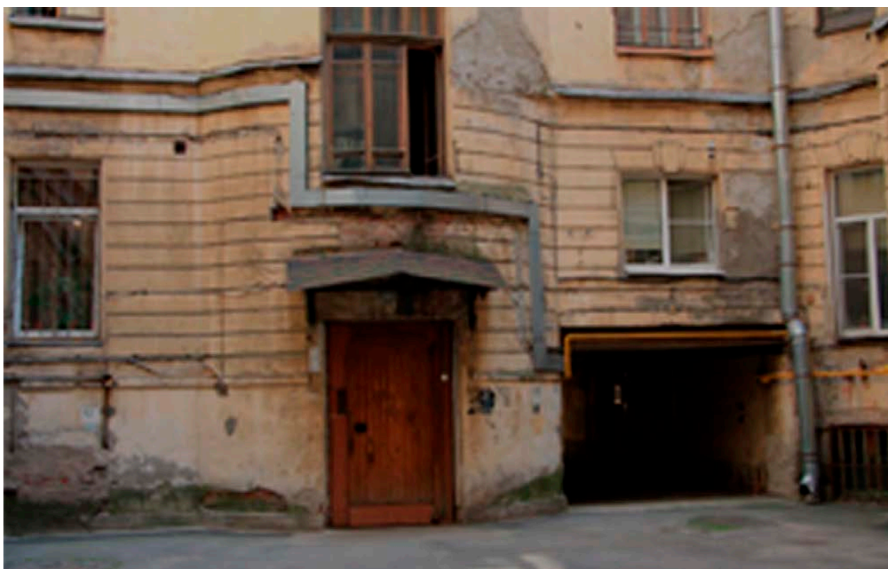
Фото 17. Объект культурного наследия регионального значения "Доходный дом И.Ф.Хреновой" по адресу: ул. Таврическая 7.
