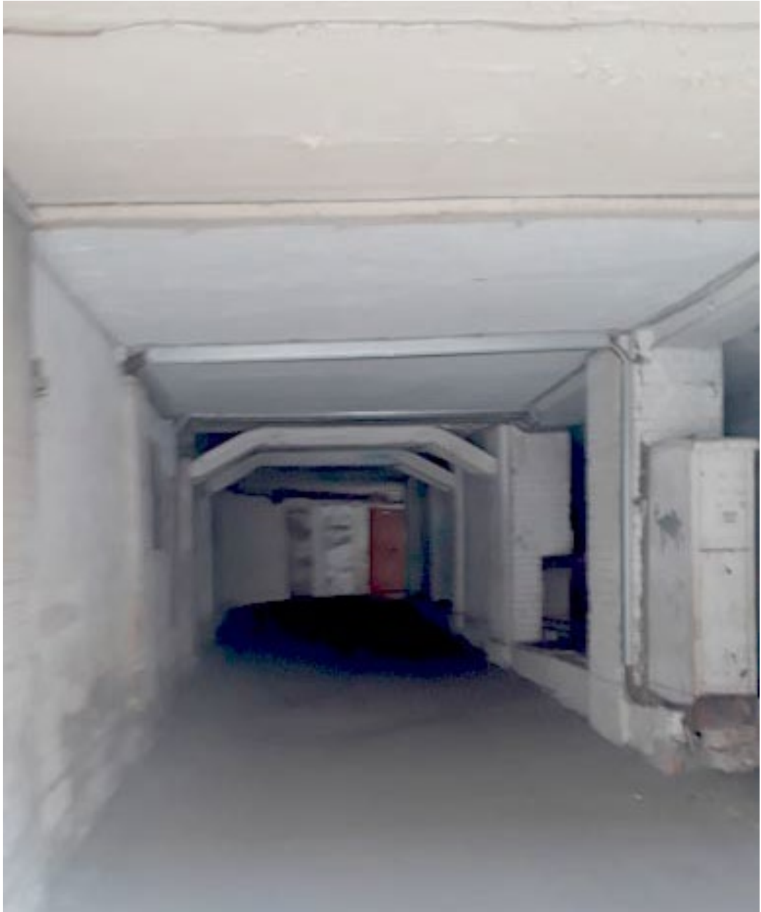
Фото 15. Объект культурного наследия регионального значения "Доходный дом И.Ф.Хреновой" по адресу: ул. Таврическая 7.
