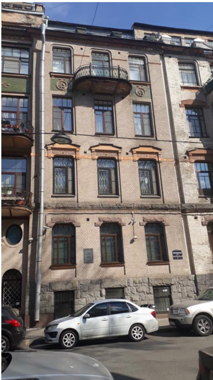
Фото 4. Объект культурного наследия регионального значения "Доходный дом И.Ф.Хреновой" по адресу: ул. Таврическая 7.
