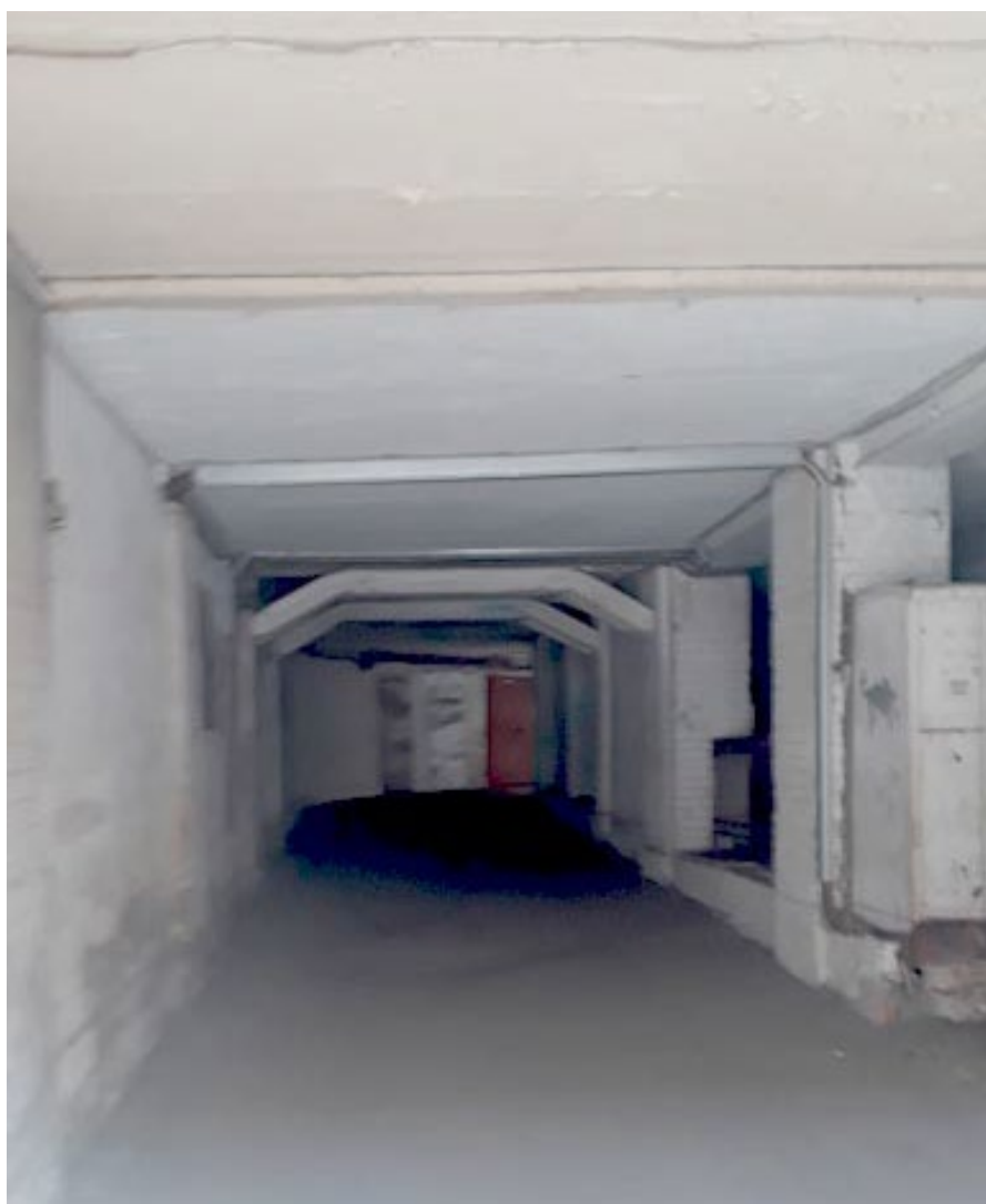
Фото 16. Объект культурного наследия регионального значения "Доходный дом И.Ф.Хреновой" по адресу: ул. Таврическая 7.
