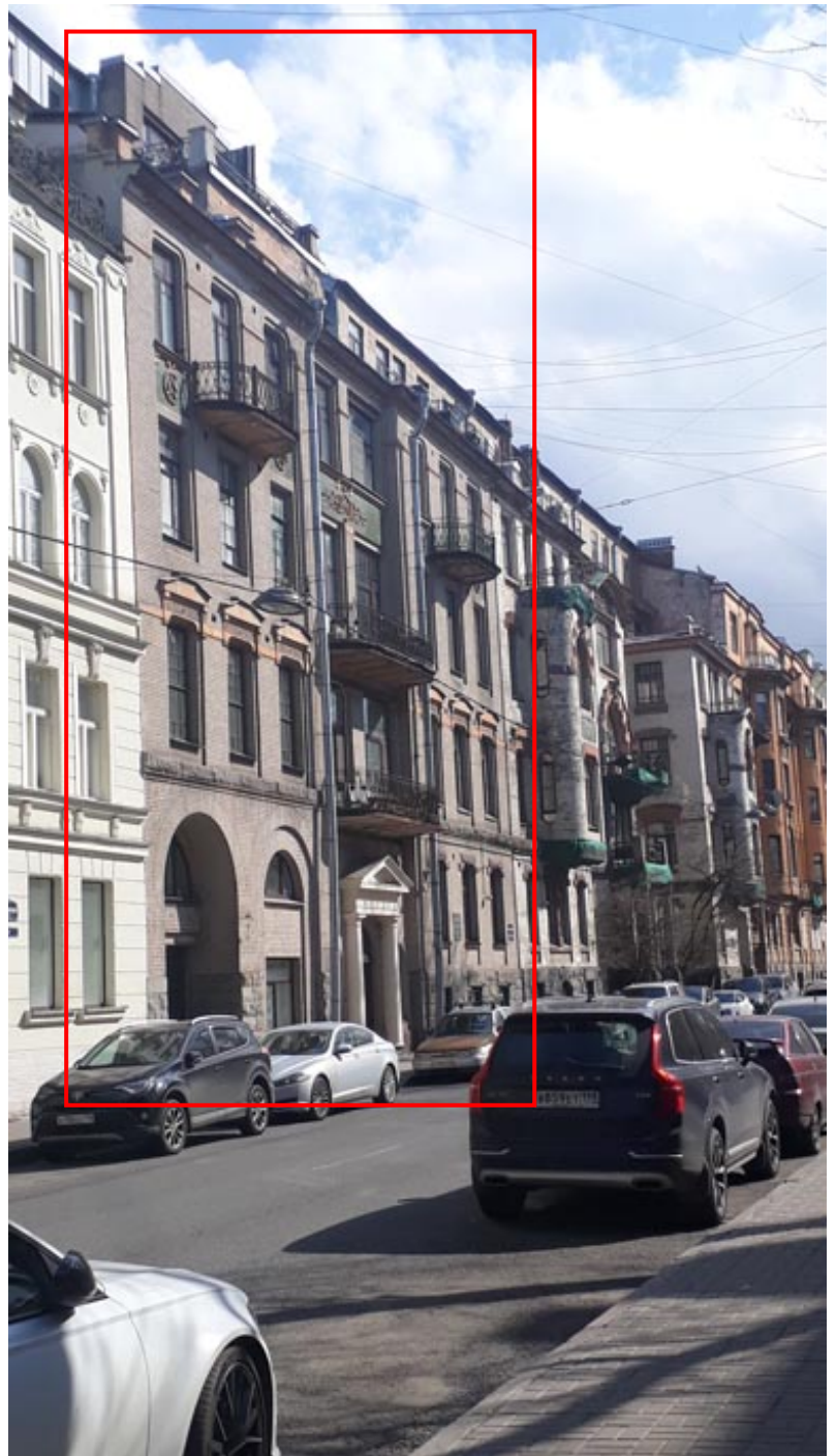
Фото 1. Объект культурного наследия регионального значения "Доходный дом И.Ф.Хреновой" по адресу: ул. Таврическая 7.
