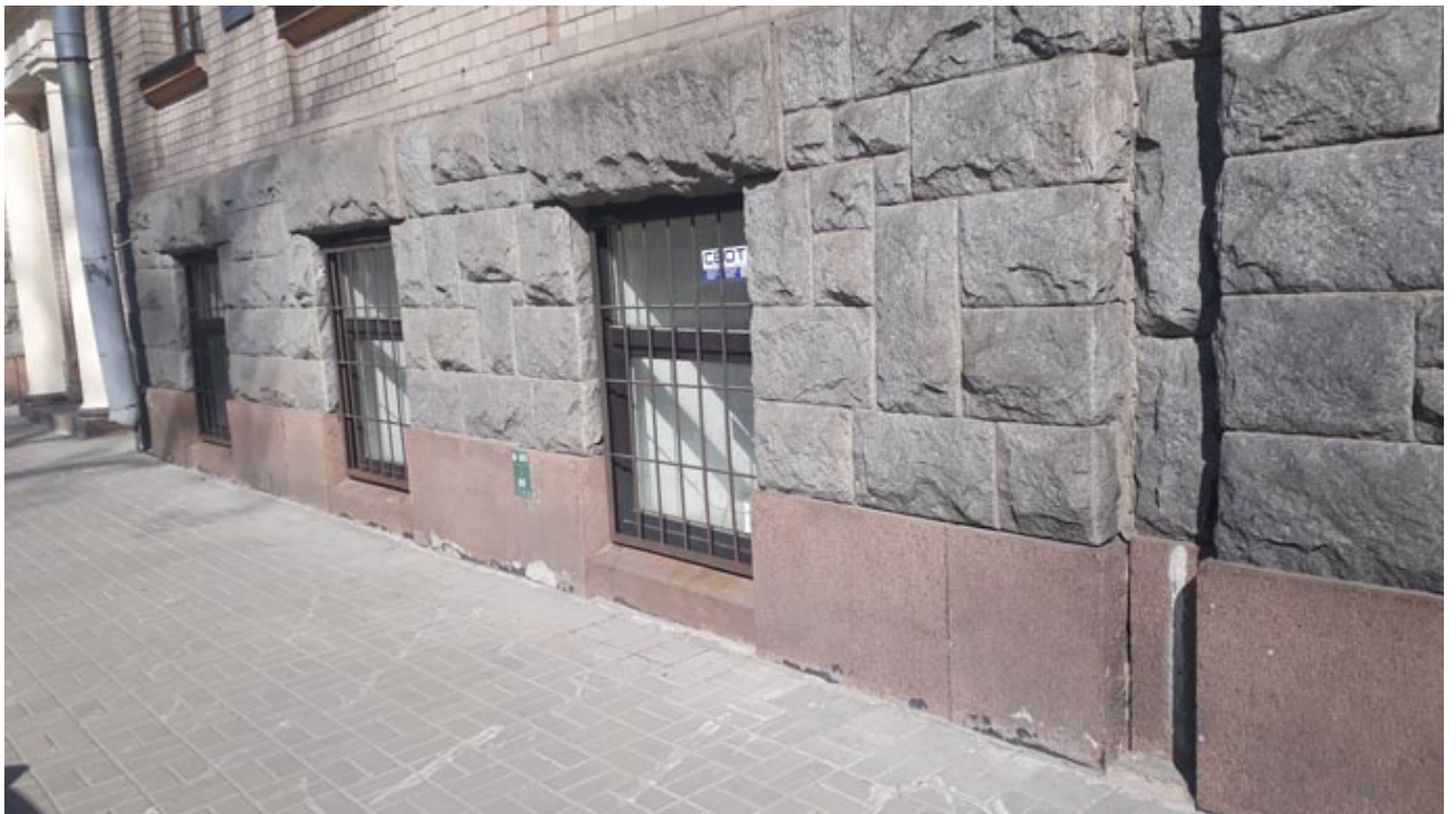
Фото 12. Объект культурного наследия регионального значения "Доходный дом И.Ф.Хреновой" по адресу: ул. Таврическая 7.
