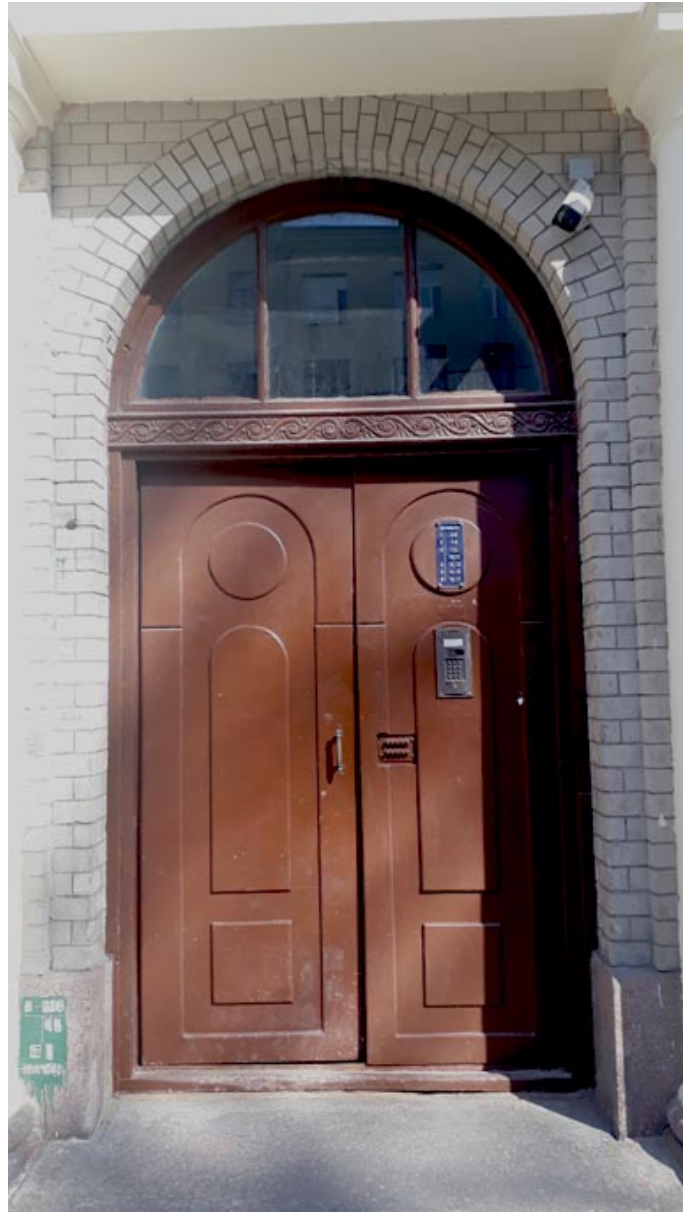
Фото 8. Объект культурного наследия регионального значения "Доходный дом И.Ф.Хреновой" по адресу: ул. Таврическая 7.
