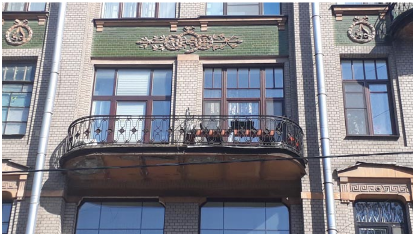
Фото 6. Объект культурного наследия регионального значения "Доходный дом И.Ф.Хреновой" по адресу: ул. Таврическая 7.
