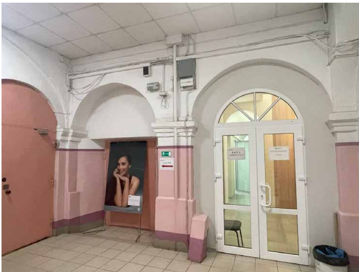
Фото 37. Вестибюль центрального входа.
