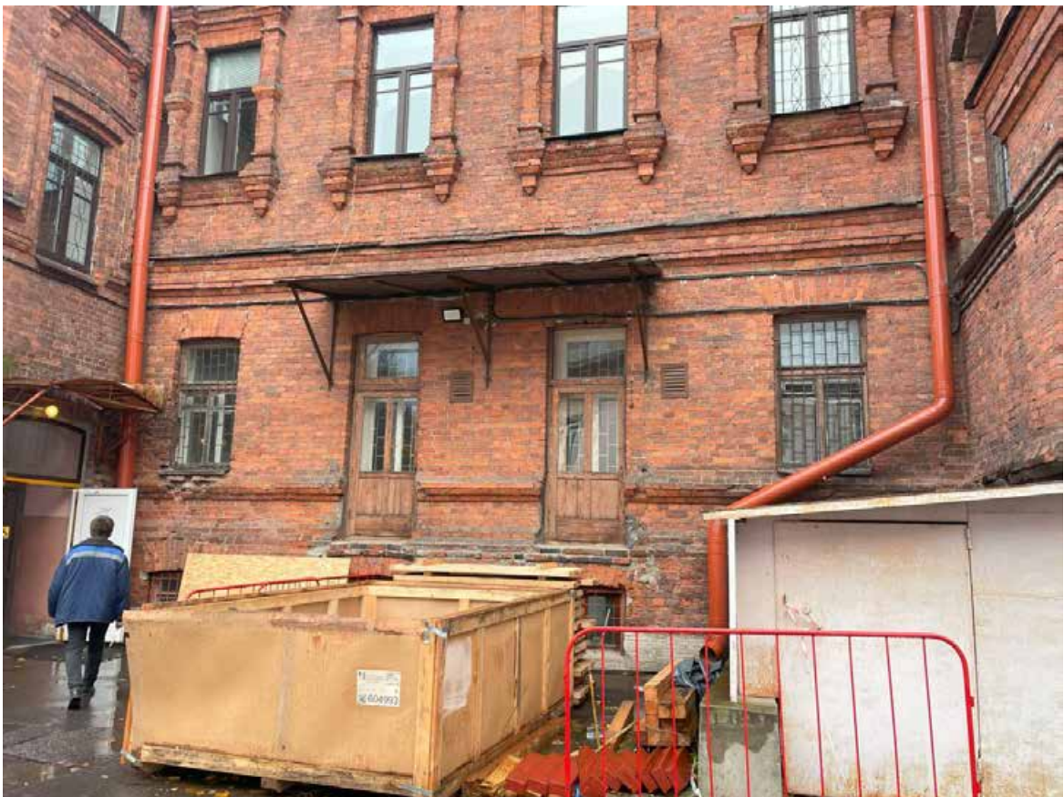
Фото 6. Дворовой фасад, фрагмент.
