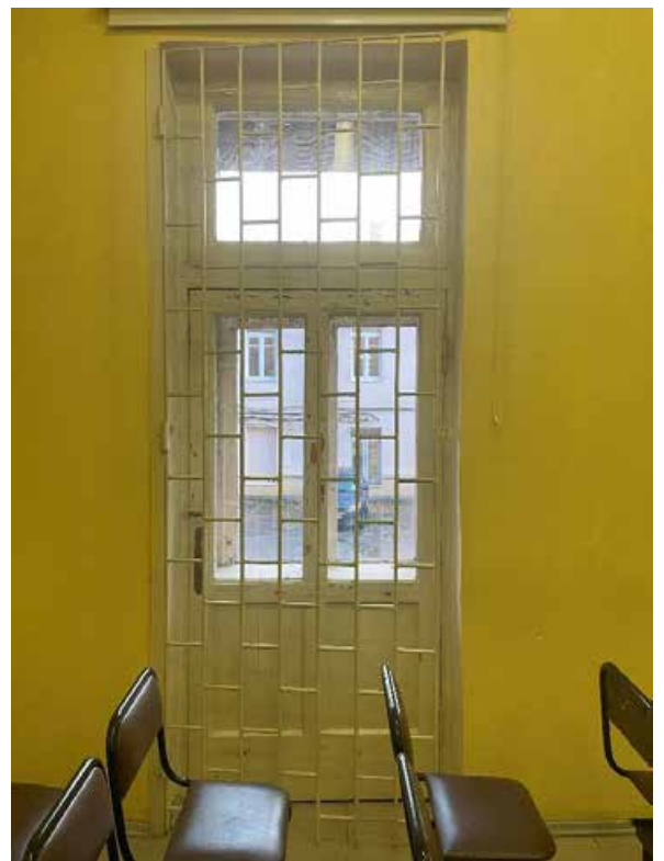
Фото 16. Дверной проем в помещении 1 этажа.
