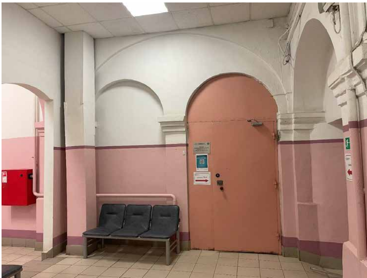
Фото 36. Вестибюль центрального входа.
