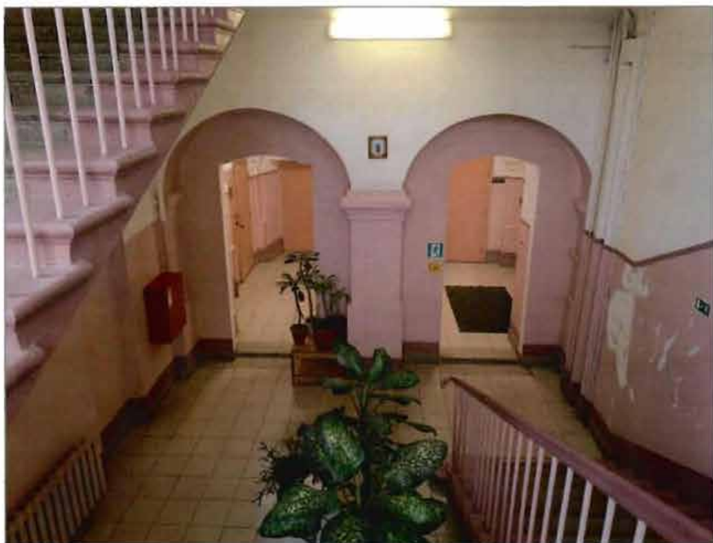
4. Трехцентровые арки на импостах.
