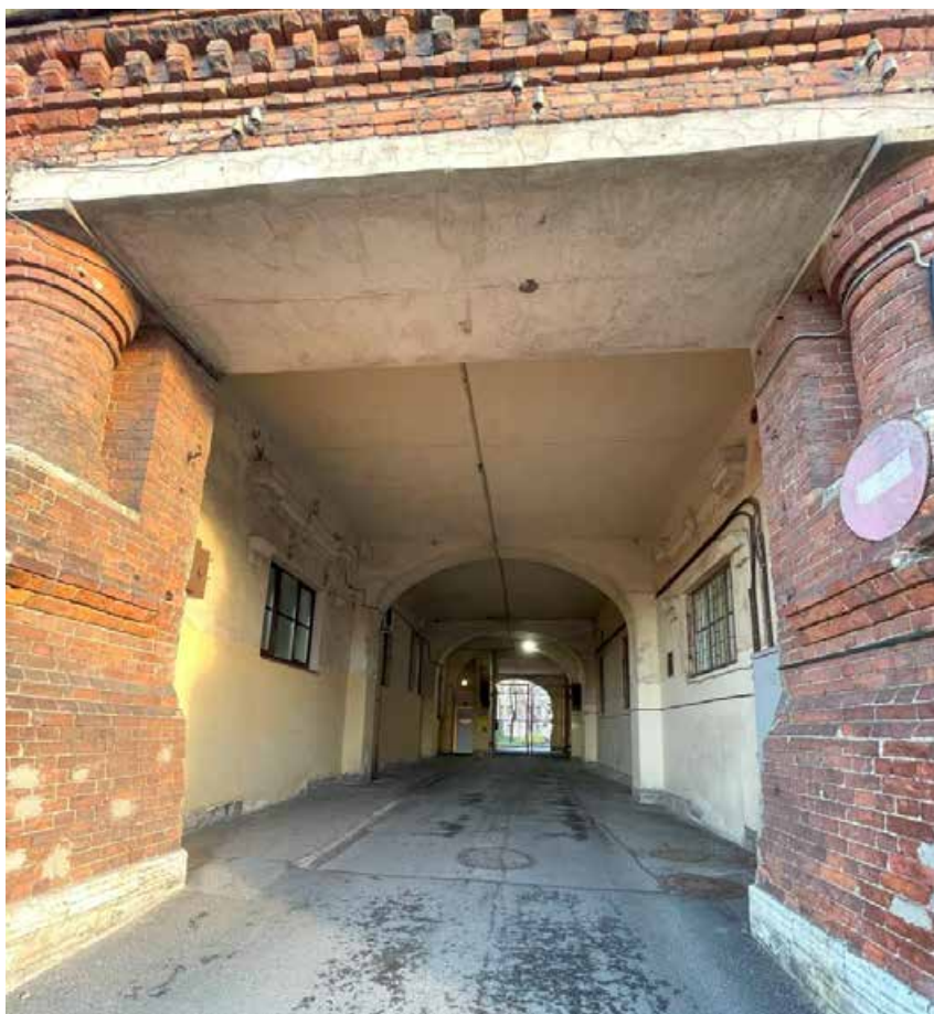
Фото 3. Арка въезда со стороны лицевого фасада.
