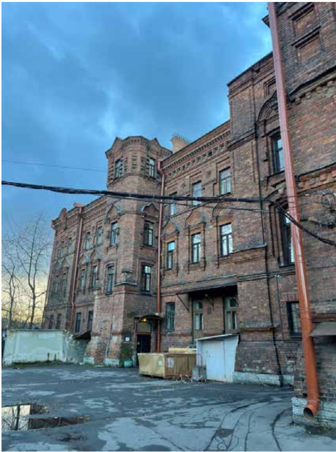
Фото 5. Дворовой фасад, фрагмент.
