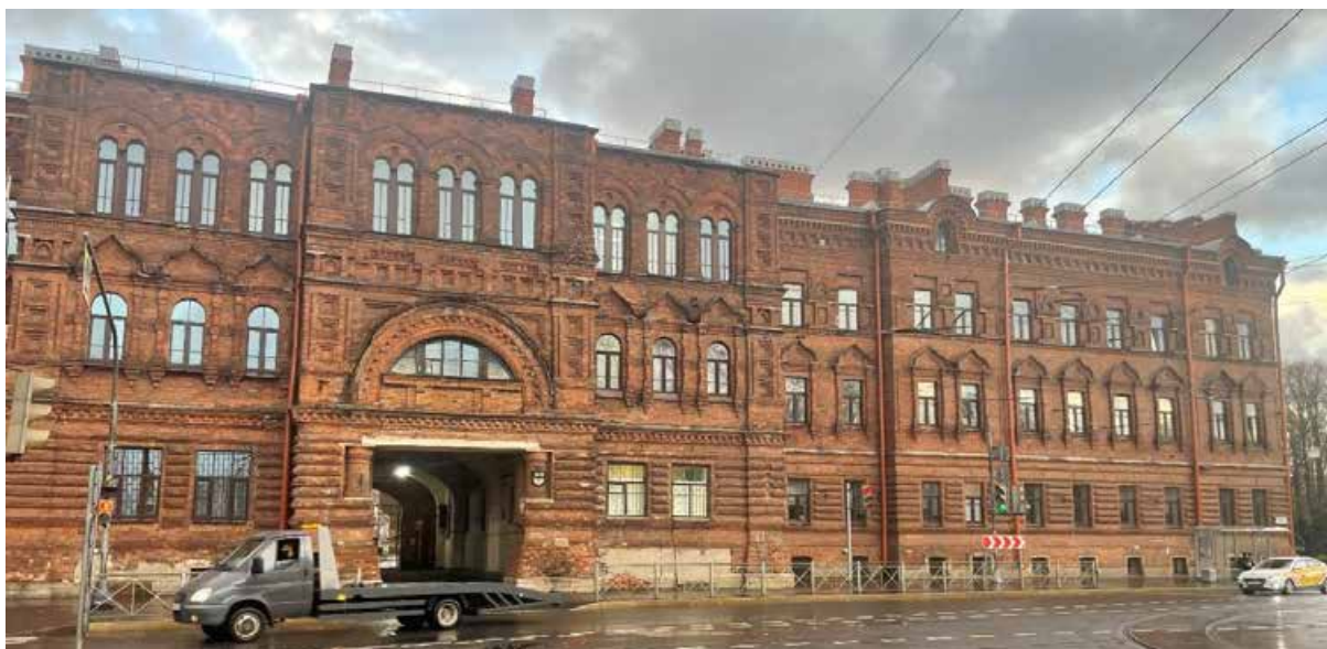
Фото 1. Общий вид лицевого фасада.
